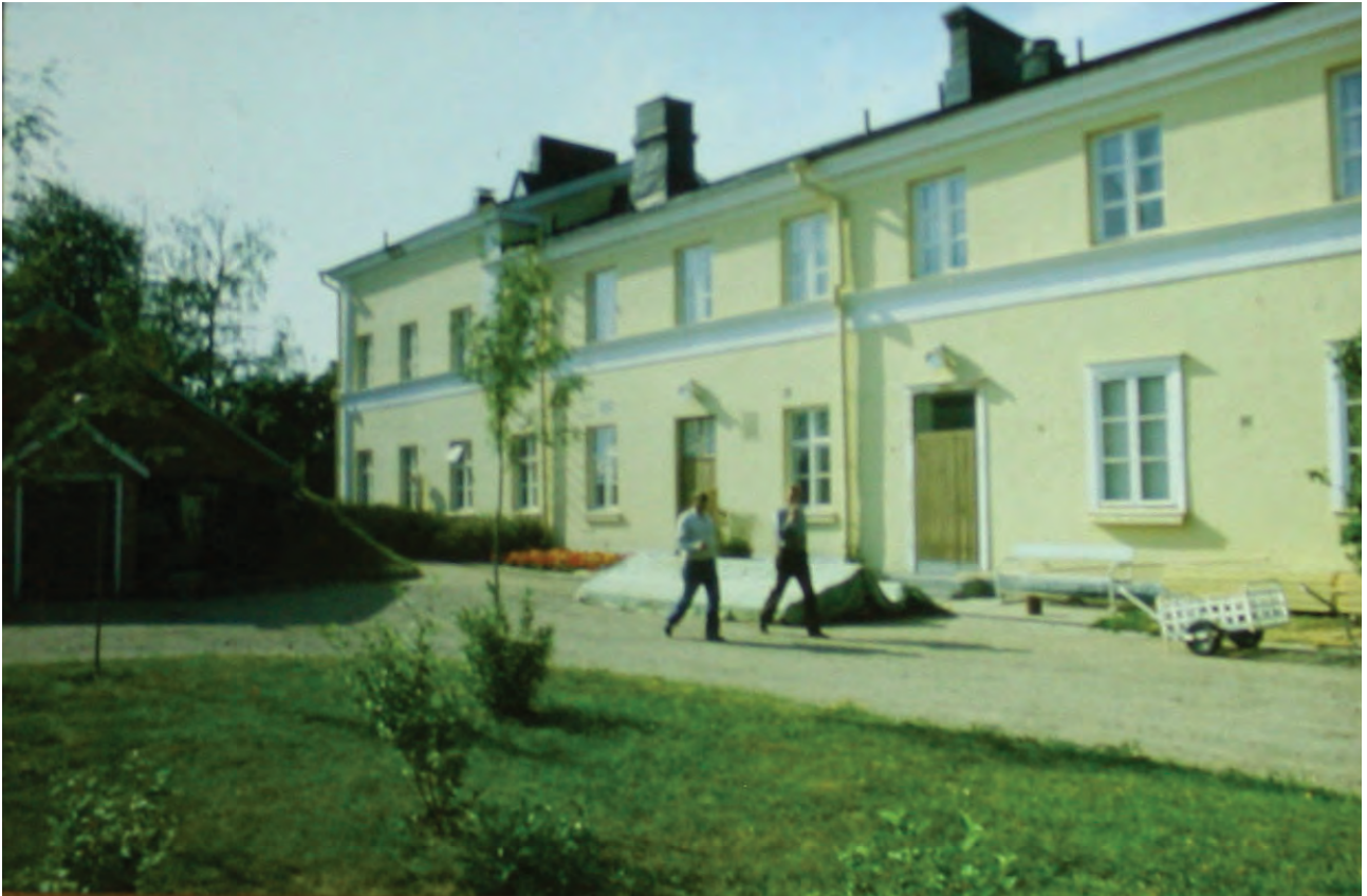
T-rakennus julkisivu etelään, vuosi ei tiedossa. Lähde: VVS arkisto
