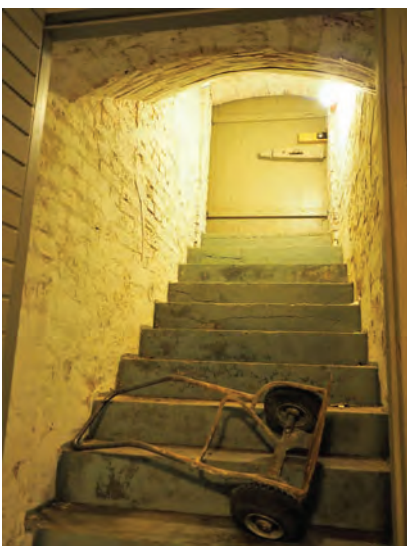
Kellarin betoniporras. Kuva v. 2020
