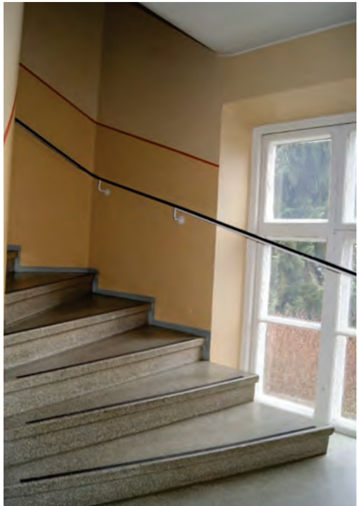
Rakennuksen portaitko. Kuva v. 2020
