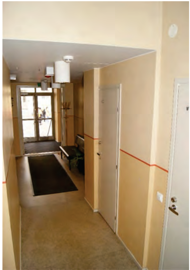
1.krs käytävä ja pääsisäänkäynti. Kuva v.2020
