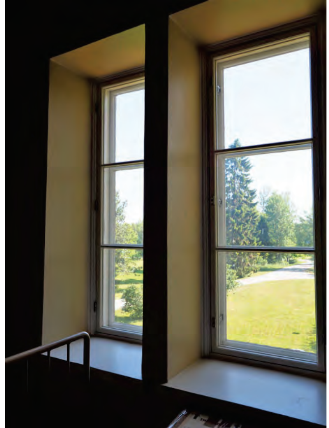
Pohjoispäädyn porrashuoneen Ikkuna, 2. krs
