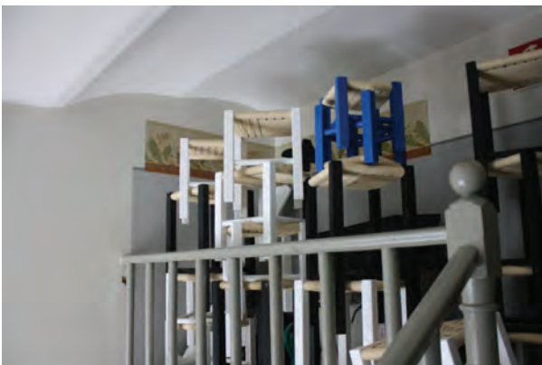
Pääportaan tasanne 2. kerroksessa, käytetään varastotilana, maalauskoriste tuolien takana. Kuva v.2020
