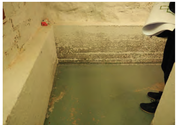
Kellarin lattia ja seinän valettu jatko-osa
