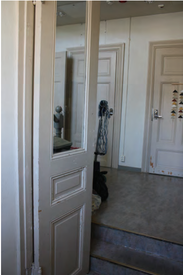
Pääsisäänkäynnin tuulikaapin ja aulan väliovia. Kuva v. 2020
