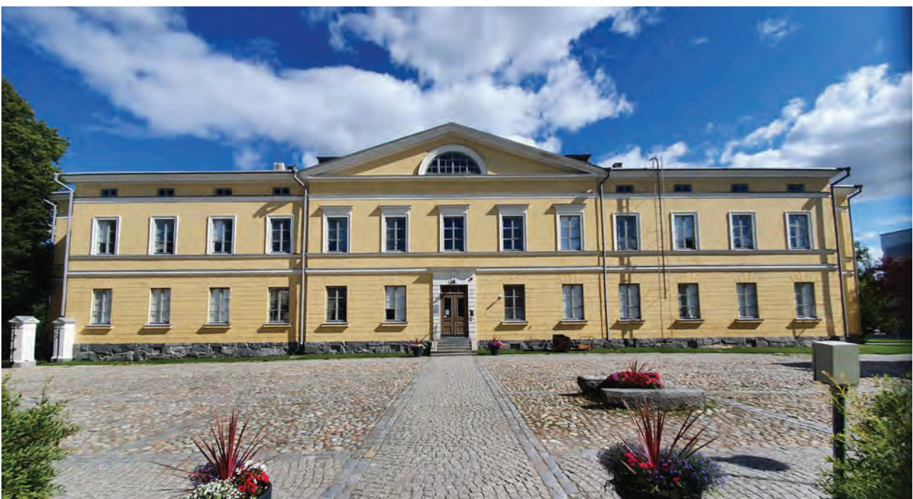
F-rakennuksen pääjulkisivu länteen. Kuva v. 2020.
