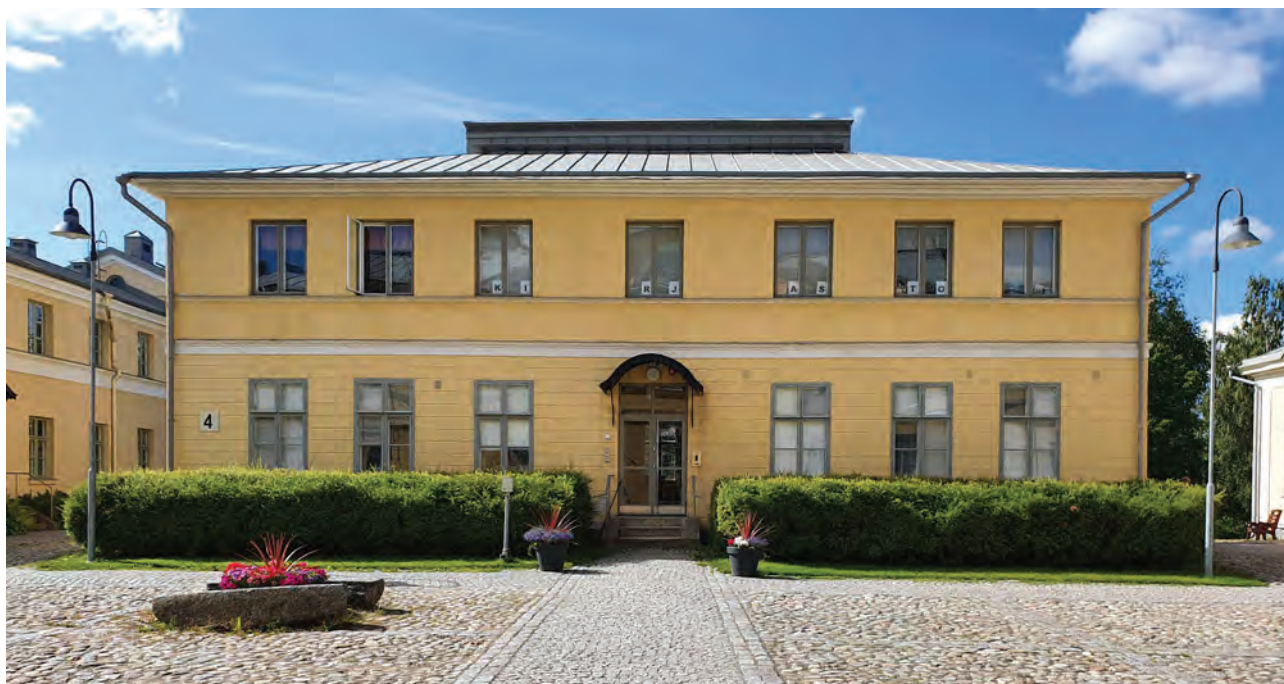
Pääjulkisivu alkuperäisen pihan suunnasta kuvattuna v. 2020
