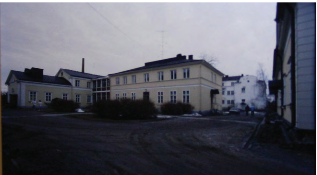
T-rakennus, Ukkola ja lasinen yhdyskäytävä. Vuosi ei tiedossa, kuitenkin väliltä 1975-1993. Lähde: VVS arkisto
