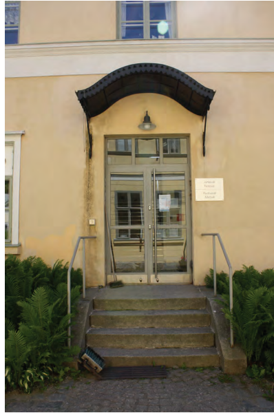
Pääportaikon ulko-ovi. Kuva v.2020
