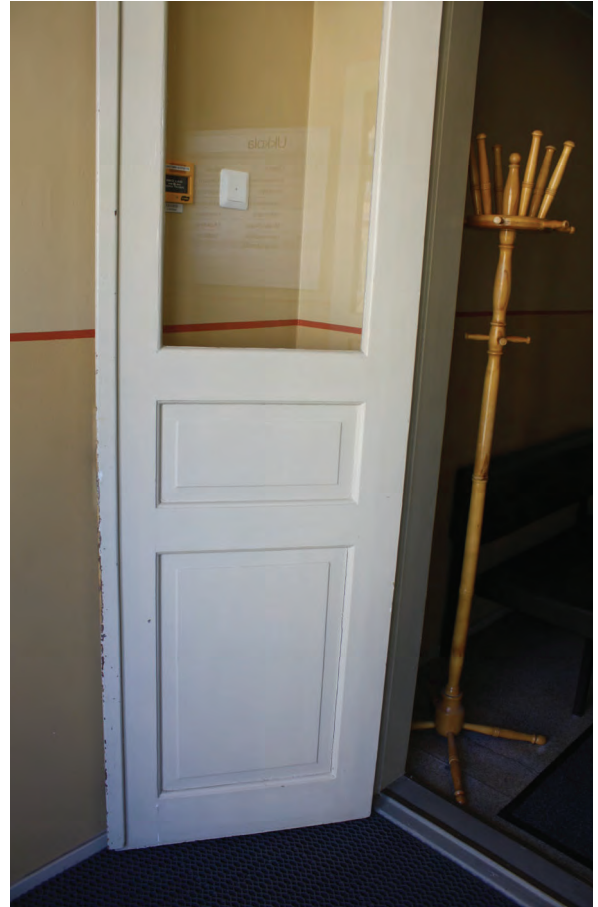
Pääsisäänkäynnin tuulikaapin ovi, kuva v. 2020
