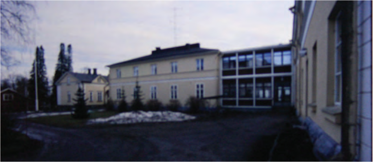
T-rakennus, Ukkola ja lasinen yhdyskäytävä. Vuosi ei tiedossa, kuitenkin vv. 1975-1993 väliltä. Lähde: VVS arkisto
