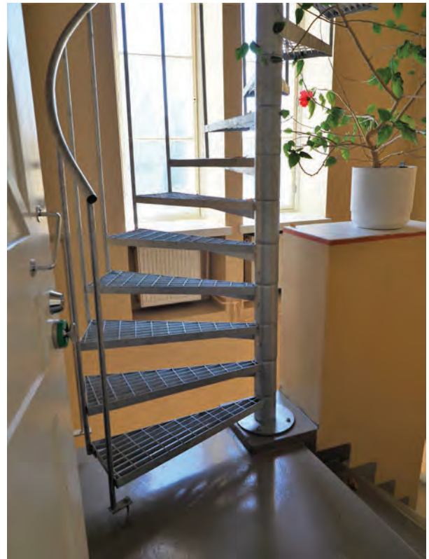
Ullakon kokoustilan poistumistieporras eteläpäädyssä.
