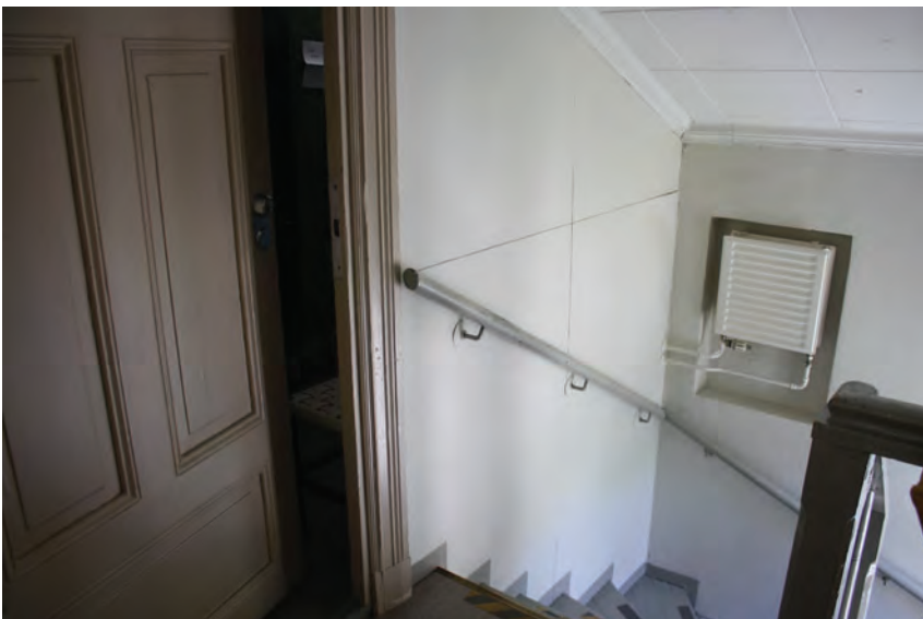
Itäinen porrashuone, jossa todennäköisesti alkuperäinen ovi ja listat. Kuva v. 2020
