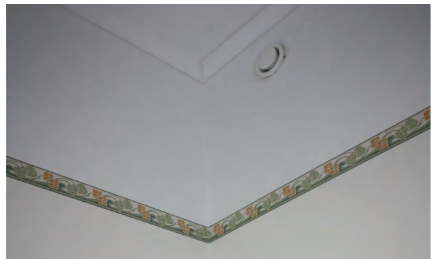
Potilashuoneen ilmettä v. 1992 tehdyn remontin jälkeen, kuva v.2020
