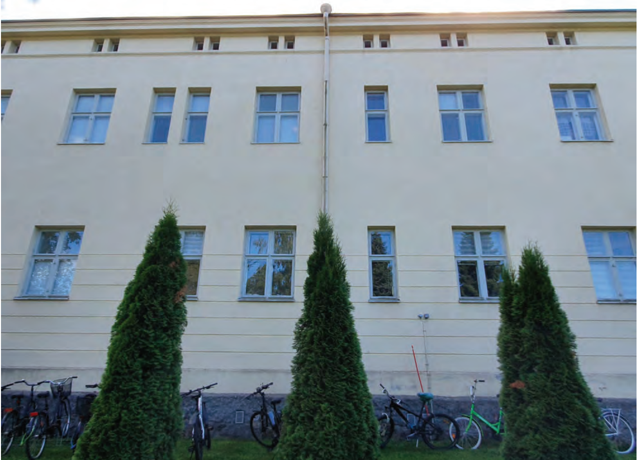
Pohjoispuolen julkisivu, kapeammat ikkunat 1900-luvun alkupuolelta v. 2020
