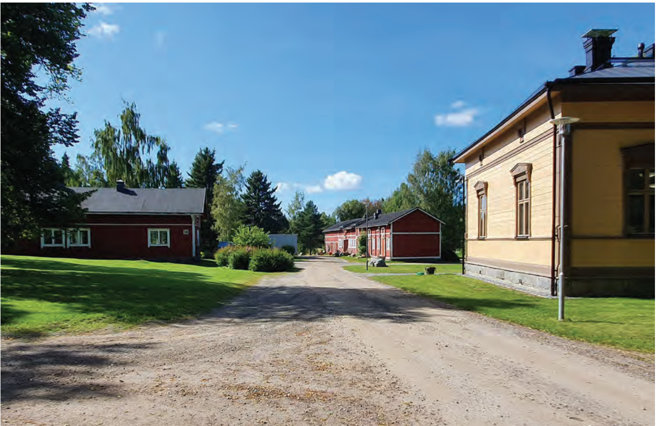
Sairaalan tukirakennuksia. Etualalla Terapiarakennus, joka on alkuperäinen lääkärin asuintalo. Kuva v. 2020
