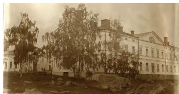
F- ja T-rakennus vuosi epäselvä. Päätty ikkuna ja ovi näkyvissä. Lähde: Helsingin kaupunginmuseo
