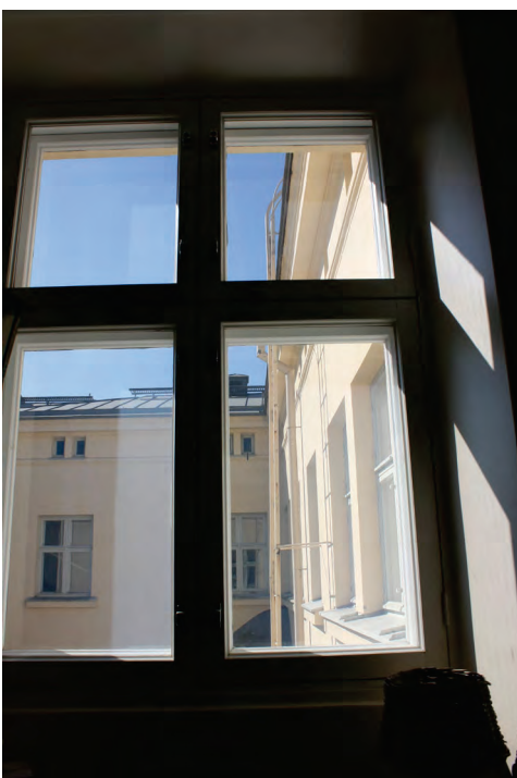
Sisään-ulosaukeva puuikkuna, kuva v. 2020
