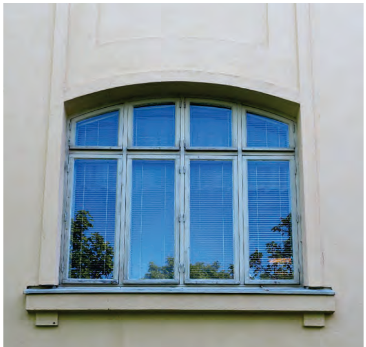
Länsijulkisivun 1. krs:n kaareva ikkuna. Kuva v. 2020
