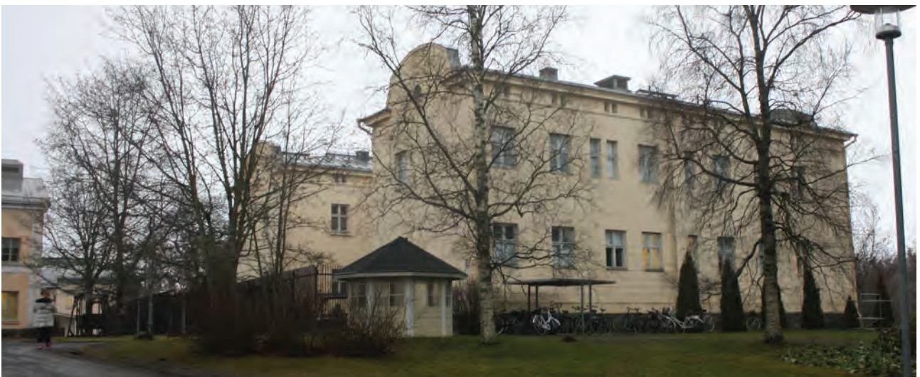
A-rakennus kuvattuna pohjoispuolen puistoalueelta. Kuva v. 2020
