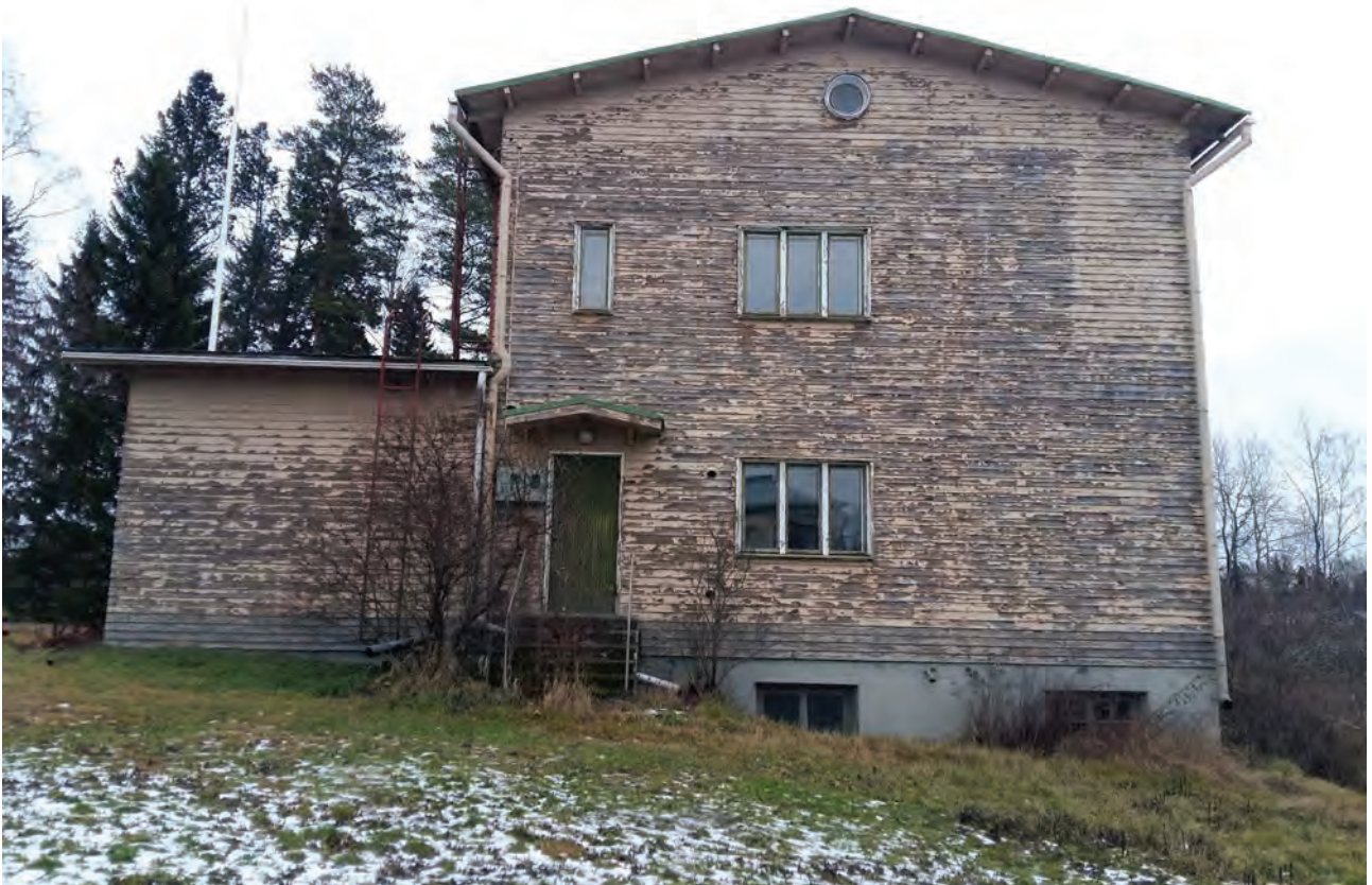
Länsijulkisivu. Näkyvissä kellarikerroksen saunan ja askartelutilan ikkunat sekä 1. kerroksen keittiön ovi. kuva v. 2020
