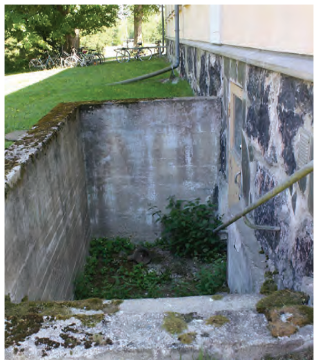
Kellarin ulkoporras pohjoissivulla. Kuva v.2020
