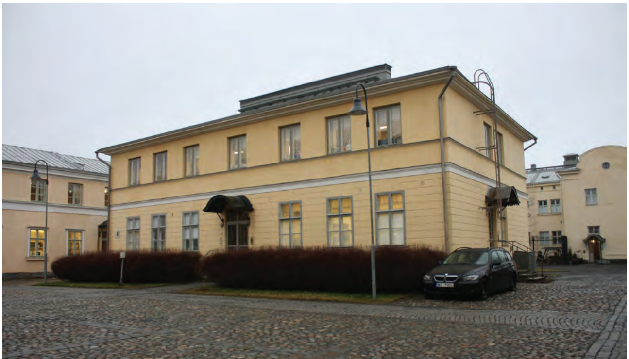
Pääjulkisivu piha-alueelta koillisesta päin, vasemmalla T-rakennus ja taustalla A-rakennus. Kuva v. 2020
