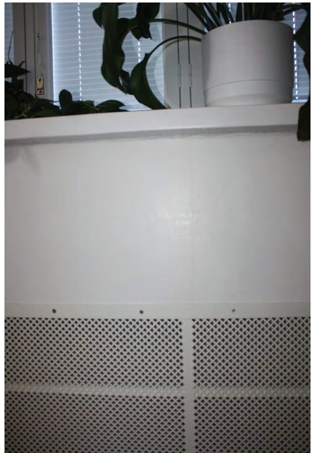
Päättyikkunoiden alla olevat pattereiden suojaverkot, kuva v. 2020
