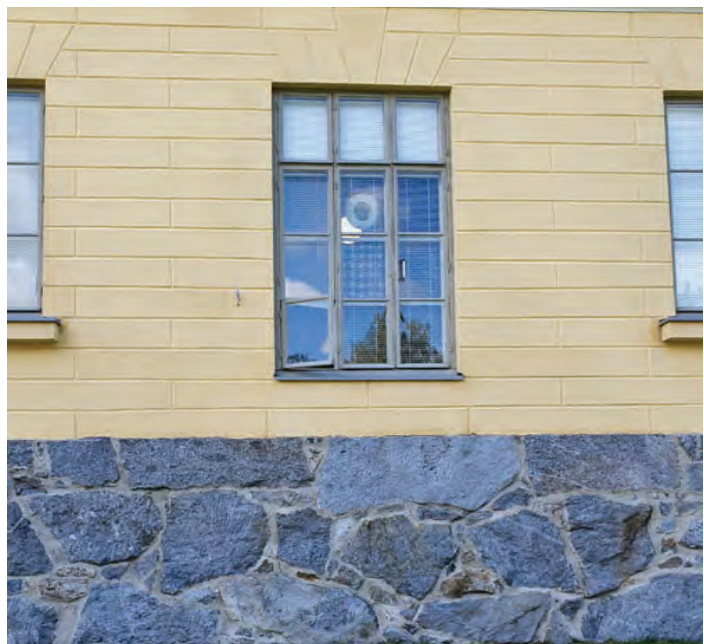
Ranskalainen parveke muutettuna ikkunaksi. Kuva v. 2020
