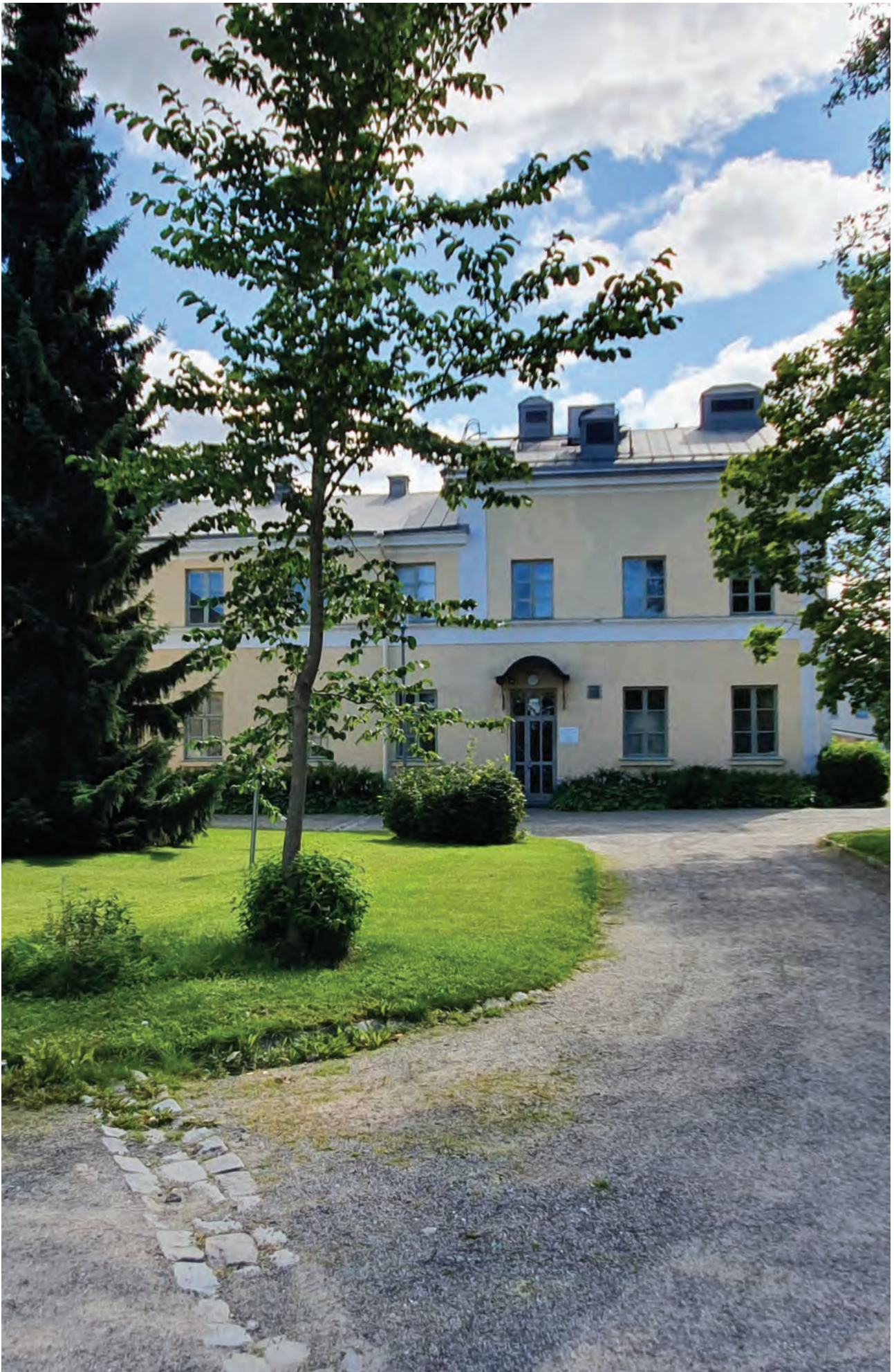
T-rakennuksen länsipään porrashuoneen sisäänkäynti kuvattuna pohjoisesta. Kuva v.2020
