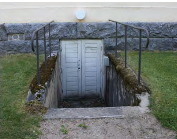
Kellarin ulkoporras. Kuva v. 2020
