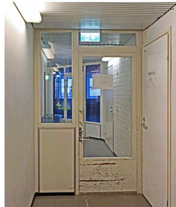
kuva 5.359 Poliisitalon kerrossalaan johtava käytävän ovi. Osa väliseinistä on puhtaaksimuurat- tuja ja maalattuja.
