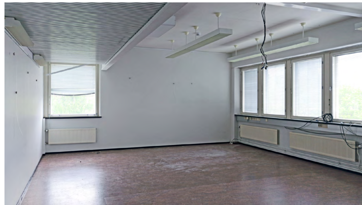
kuva 5.358 Isompi toimistotyöhuone poliisitalon päädyssä.
