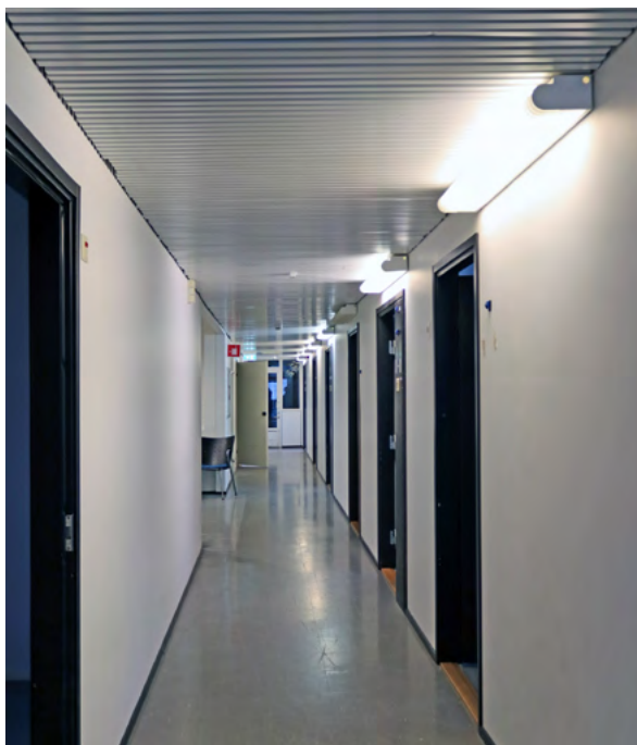
kuva 5.356 Poliisitalon pitkää kaksoiskäytävää, jonka oikealla puolella sijaitsevat ikkunalliset toimistohuoneet ja vasemmalla ikkunattomat keskiosan tilat.
