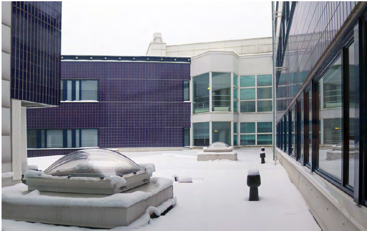
kuva 5.12 Näkymä Oikeustalon O-siivestä arkisto-osan katon yli kohti 2000-luvulla rakennettua T-siipeä
