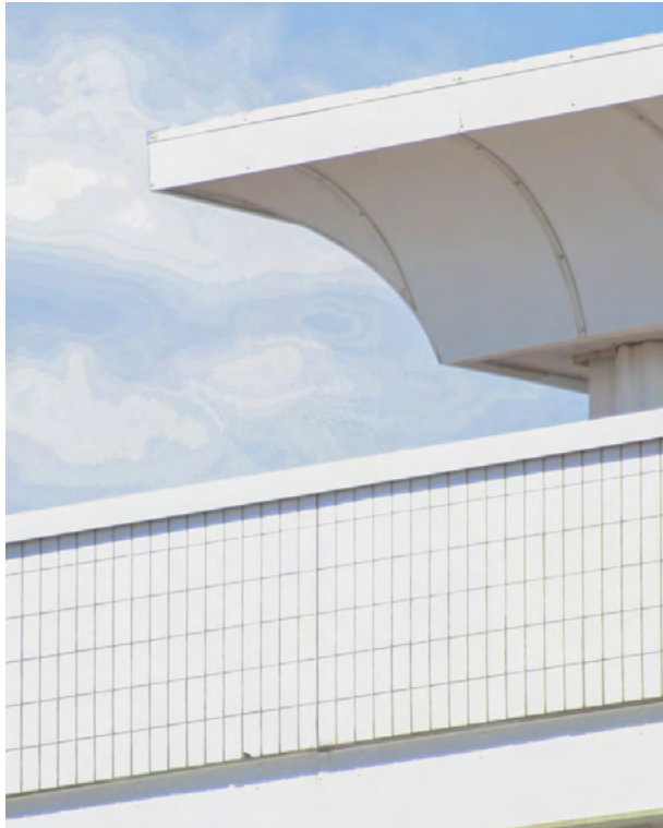
kuva 5.13 Poliisitalon kattokerroksen räystääs
