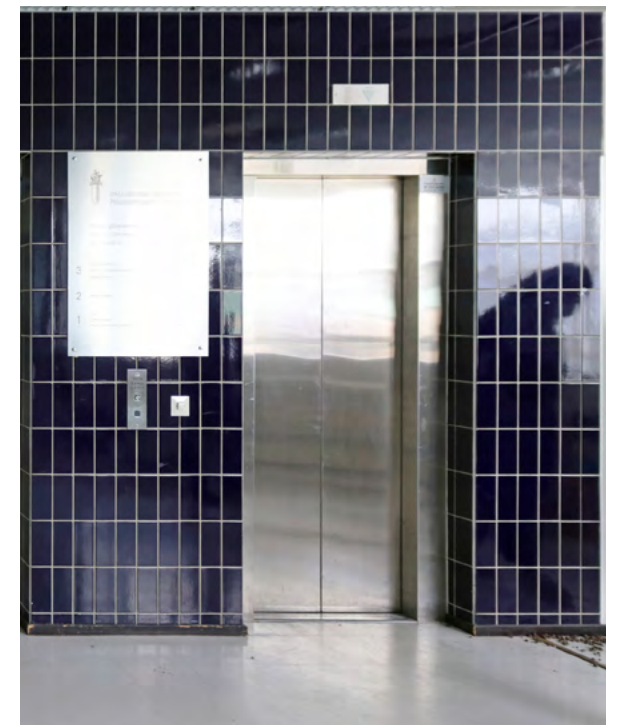
kuva 5.353 Poliisitalon kerrosauloissa sijaitsevat poliisitalon puolen hissit. Niiden etuseinä on päällystetty samoilla sinisillä klinkkereillä kuin oikeustalon julkisivut.
