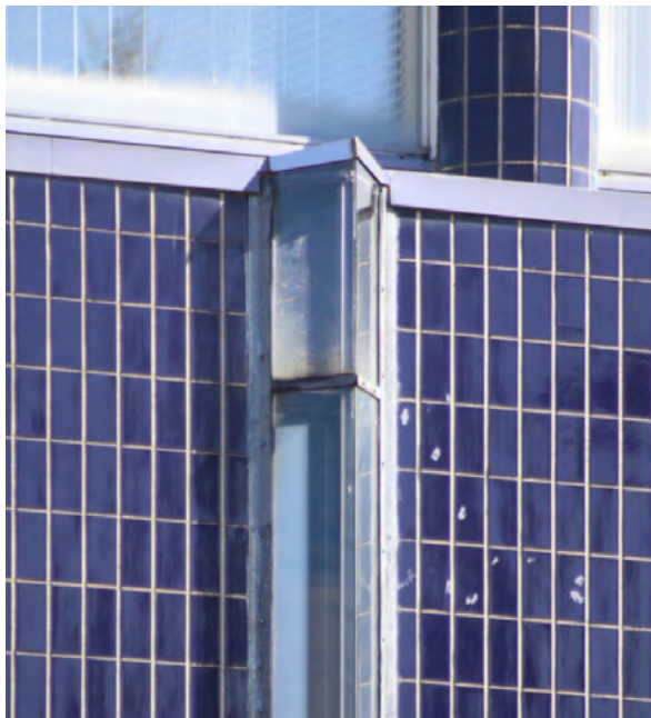
kuva 5.26 Kielotien julkisivun prisman muotoinen ikkuna, joka tarjoaa kurkistusaukon oikeussalien takakäytävästä ulos
