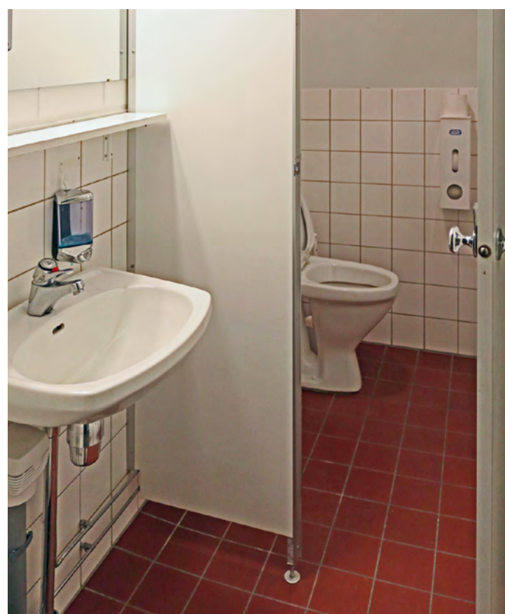
kuva 5.325 WC-tila oikeustalon 2. kerroksessa. Laattapinnat ovat todennäköisesti alkuperäisiä.
