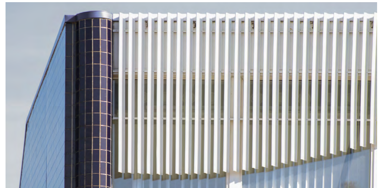
kuva 3.4 Oikeustalon yläikkunaa peittävä aaltoreunainen säleikkö
