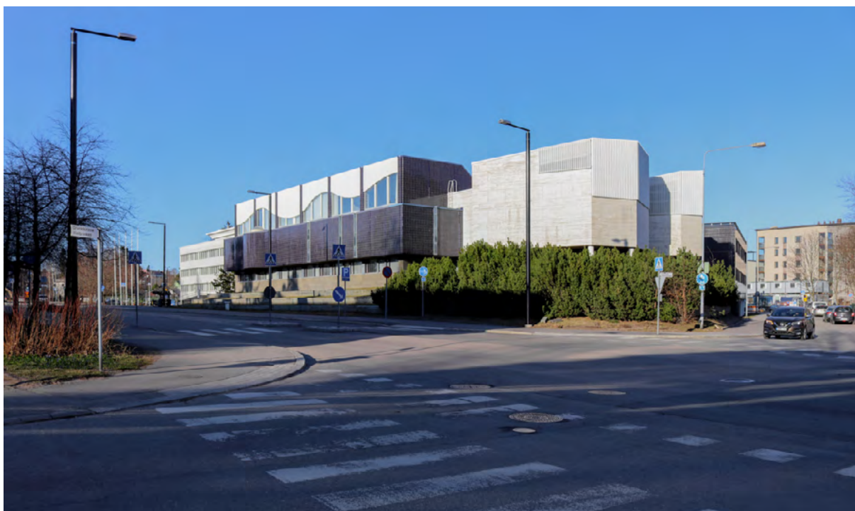
kuva 5.56 Oikeustalo Kielotien ja Orvokkirinteen risteyksestä. Vanhan oikeustalon jatkeena oleva vaalea laajennusosa (osa K) on rakennettu v. 2004, suunnittelijana arkkitehti Kari Leppänen. Muoto tulee istuntosaleista.
