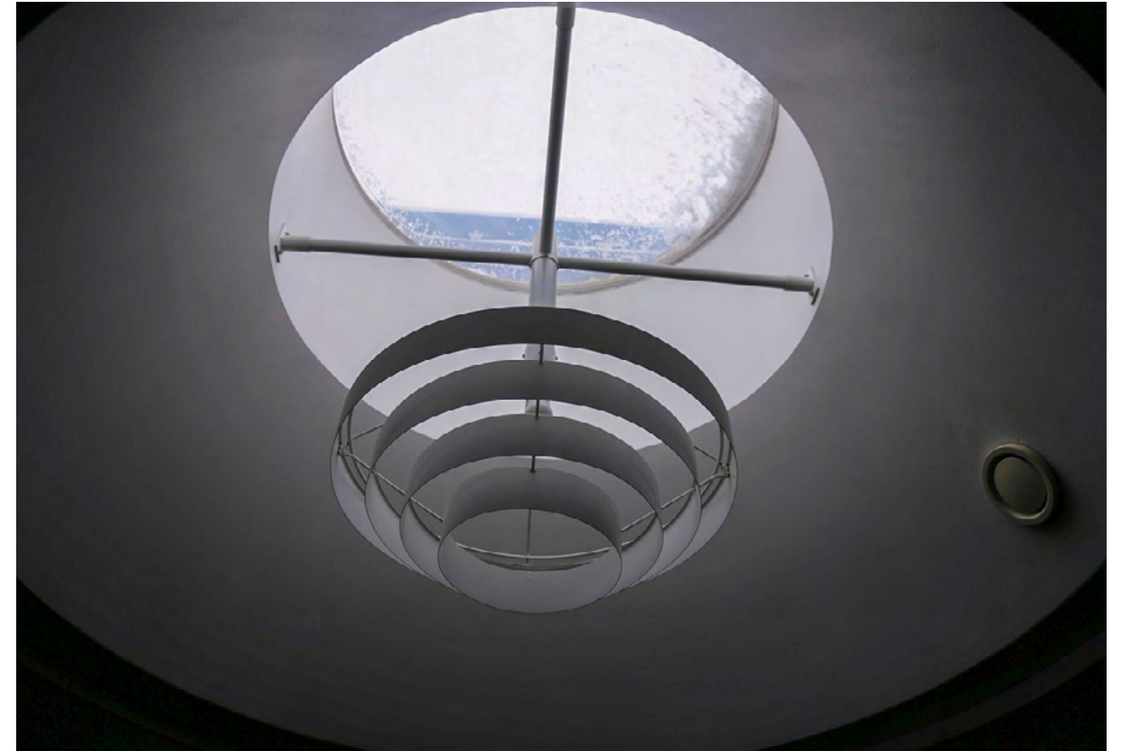
kuva 5.32 Kattoikkuna ja siihen liittyvä valaisin oikeus- ja poliisitalojen nivelosassa, sisääntuloon palveluhallissa
