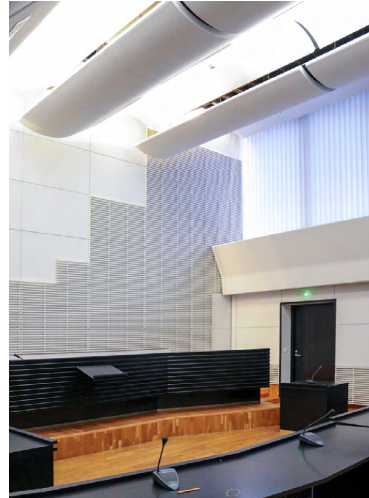
kuva 5.312 Vanha istuntosali nykyisin. Seinä- ja alakattopinnat ovat säilyneet alkuperäisinä. Alakatto-paneelien taakse jäävät valaisimet piiloon. Ilmanvaihtoritilät on integroitu alakattoelementteihin.
