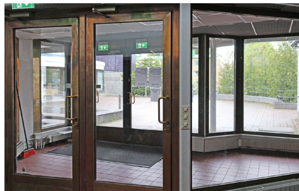
kuva 5.327 Poliisitalon sisäänkäynnin tuulikaappi. Poliisitalon sisäänkäynnissä on alkuperäinen punainen laattalattia.
