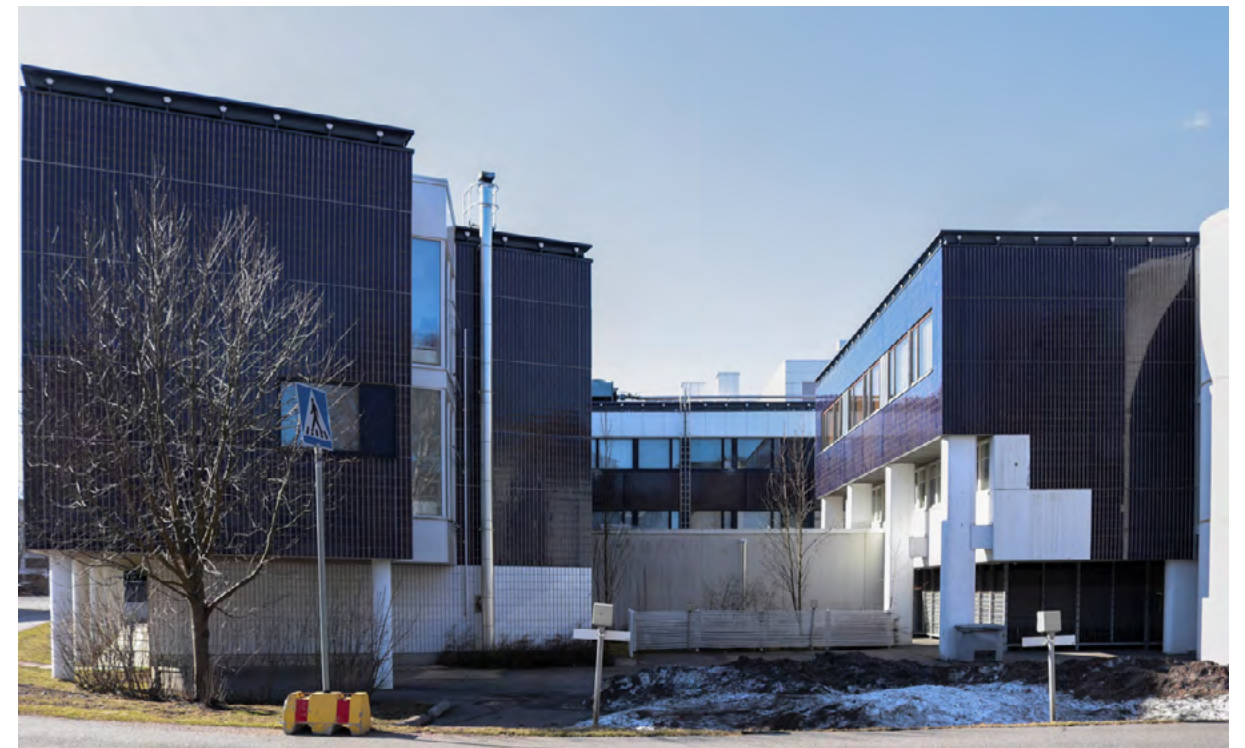
kuva 5.28 Oikeustalon julkisivu Esikkotien puolella. Laajennusosat etualalla ovat näkyvimät.
