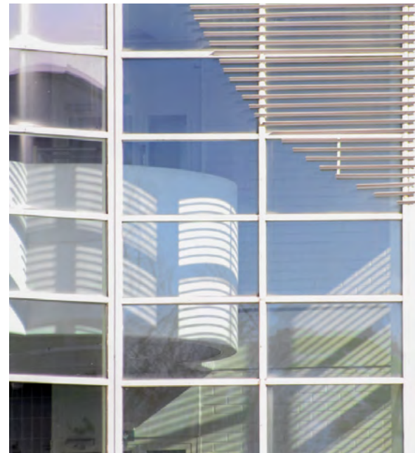
kuva 5.27 Poliisitalon pääsisäänkäynnin kohdalla on korkeat ikkunat, joita osittain peittää säleikkö.
