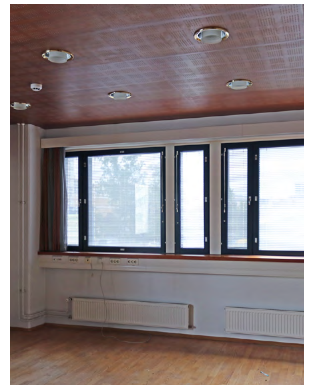
kuva 5.345 Oikeustalon T-siiven pintamateriaalit poikkeavat alkuperäisestä. Kuvassa neuvotteluhuone, jonka lattiassa on parketti ja alakatto on puuviilupintaista levyä. Myös toimistohuoneiden ovet ovat punasävyistä puuviilua.
