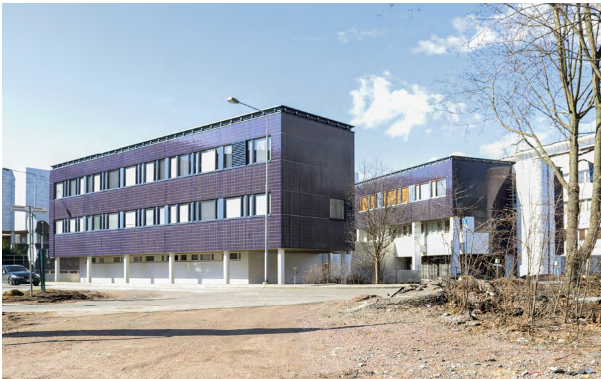
kuva 6.31 Oikeustalon Esikkotien puoli on takapihanomainen. Viereisellä tontilla on purettu vanhat asuinrakennukset ja uudet kuusikerroksiset asuinkerrostalot ovat rakenteilla. Esikkopolku (kuvassa vasemmalla) on lyhyin kevyen liikenteen reitti Tikkurilan asemalta kohteeseen.
