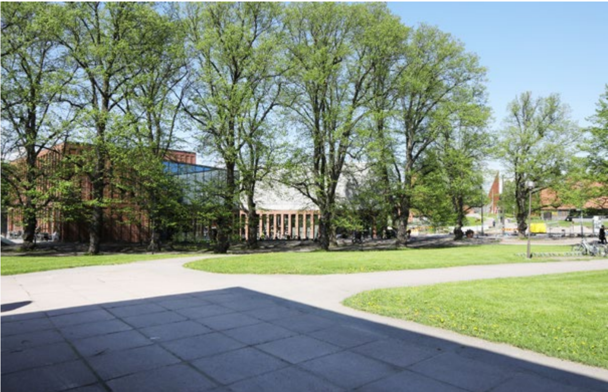
↑↑ Vuorimiehentie 2 Kemistintieltä kuvattuna. Etualalla vuonna 2002 liisäetty ruokalalaaajennus. Taka-alalla näkyy vuoden 1974 rakennusosa ja sen katolle vuonna 2020 valmistunut IV-konehuone.
