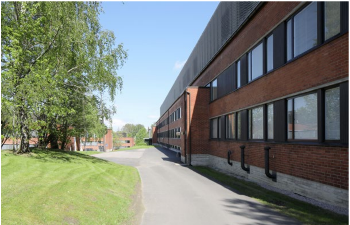
↑↑ Vuorimiehentie 2:n isompi piha-alue, joka toimii huoltopihana ja pysäköintialueena. Vasemmalla kuvassa on 1974 rakennettu rakennusosa ja oikealla näkyy vuonna 1964 rakennetun osan pääty.
