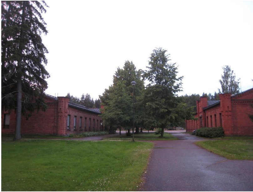
Kuva 4-2. Passiividetektorin sijoituspaikka oli vasemmalla näkyvän rakennuksen seinustalla.
