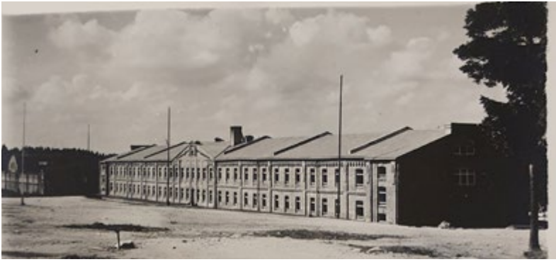
← Rakennuksen 18 vierusta tasoitettiin ja kunnostettiin 1950-luvulla varuskunnan keskuspaikaksi. MM.
