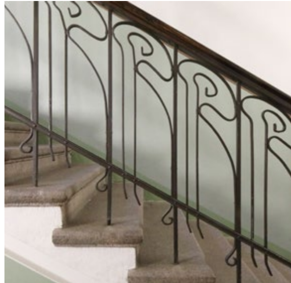
↑ Graniittiportaassa on säilynyt kaunis, alkuperäinen jugend-vaikutteinen rautakaide, johon on kiinnitetty puinen käsijohde.
