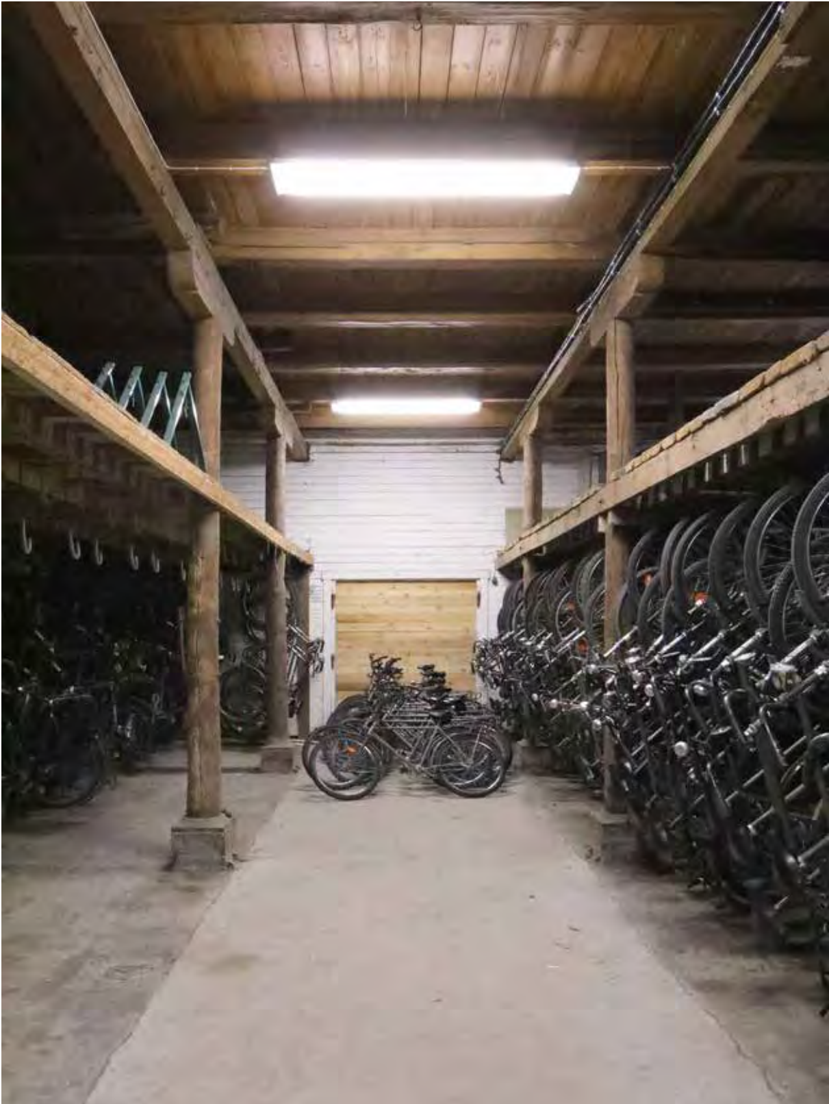
↑ Osa vanhasta tallirakennuksesta toimii polkupyörävarastona. Alkuperäinen puinen pilttuu- ja heinäparvirakenne on hyvin säilynyt.
