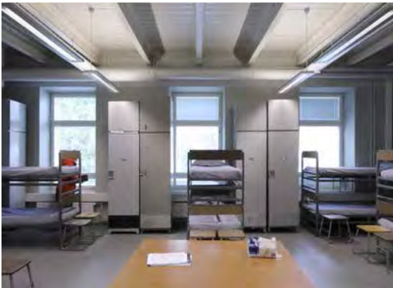
← Varusmiestupa ja näkyvissä oleva alkupe- räinen I-palkkien kannattama puurakentei- nen välipohja.
