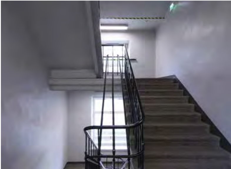
← Pieni porrashuone rakennuksen päädyssä.
