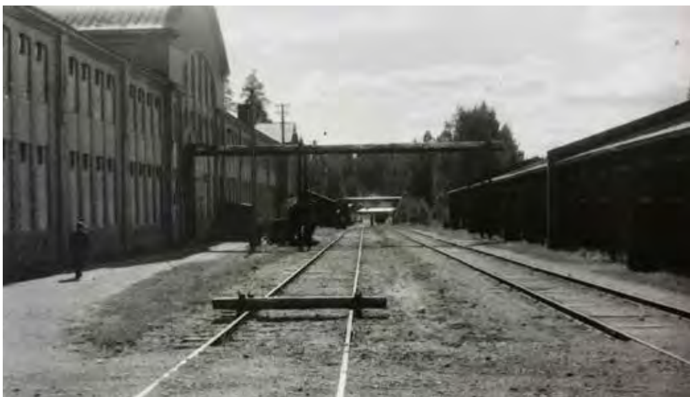
↓ Viestikeskuskor- jaamon rakennus ennen 1960-lu- vun alun korja- ustöitä. Raken- nuksen edustalla kulkee junaraide. Viestikeskuskor- jaamon osastoilta 1960-luvulta. MM.
