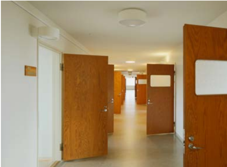
← Tyypillinen keskikäytävä, 4. kerros. Toimistohuoneiden ovet ovat tyypillisesti ikkunallisia itäseinällä ja umpinaisia länsiseinällä, mutta vaihtelua esiintyy kerroksittain. Röpelöläsi saattaa olla alkuperäinen ratkaisu.
