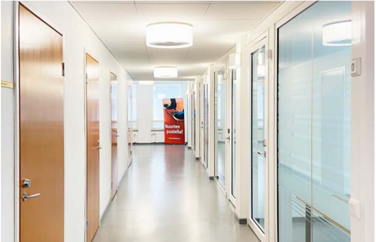
↑ B-siiven 1. kerros uusittiin täysin 2012 peruskorjauksen yhteydessä. Neuvotteluhuoneet erotettiin käytävästä lasiseinän ja käytävän päähän muodostettiin pieni aulatilaa.
