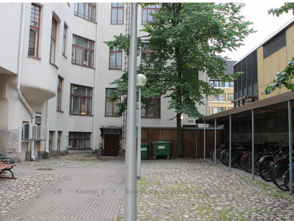
Kirkkokatu 14:n pihaa ennen nelikerroksisen kerrostalon rakentamista. Björn Cederhvarf 1905, Museovirasto HK10000:7156. Matalien piharakennusten tilalla on nykyään pyörä- ja roskakatokset.
