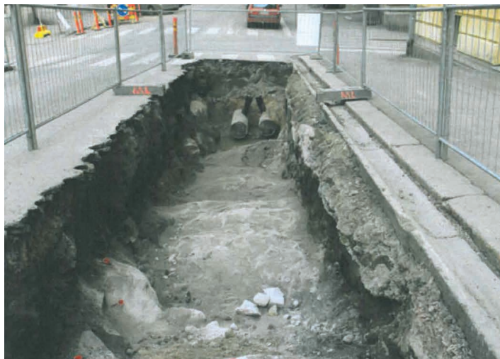
Hallituskatu 4:n kohdalla kallio nousi lähelle maanpintaa. Markku Heikkinen 13.4.2010, HKM Hallituskatu 03.
