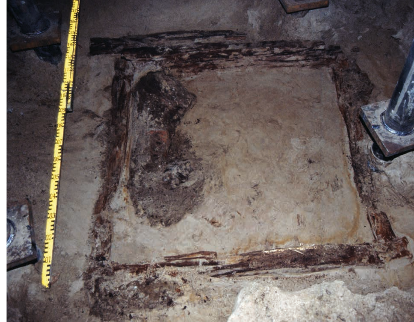
Länsisiivestä löytyi lautarakenteen läheltä toinen hirsikaivo. Markku Heikkinen 1996, Valtioneuvoston linna 65.
