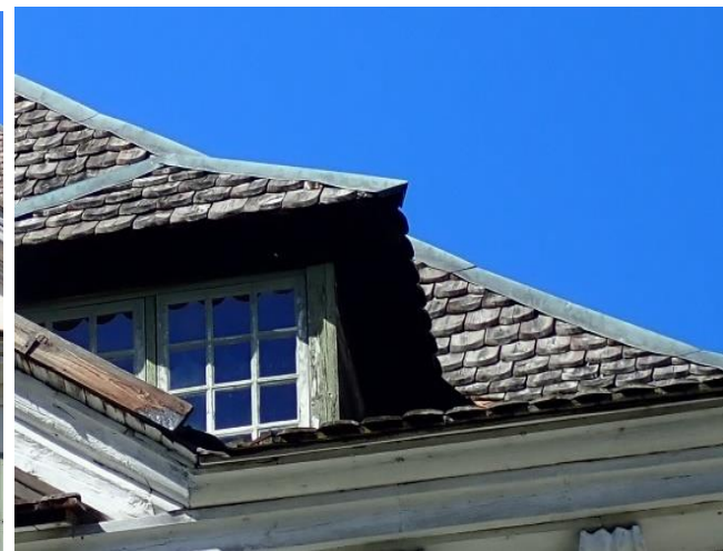
Kuva 26. Itälaipan puoleinen paanukate. Paanujen pinta vaikuttaa haristuneelta sekä harmaantuneelta.
