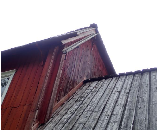
Kuva 33. Länsiläpään puoleista lautakatetta. Katteen pinta haristunut. Puinen räystäskouru osittain irronnut.
