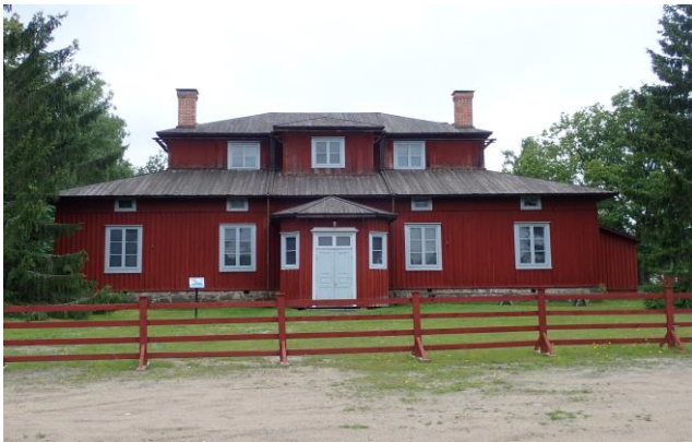
Kuva 51. Ylipytin lautakatetta. Julkisivu koilliseen.
