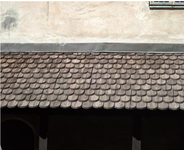
Kuva 11. Päälinnan pohjoisiven puoli. Paanukatossa suuria, paanujen välisiä halkeamia. Paanussa haristunut pinta.
