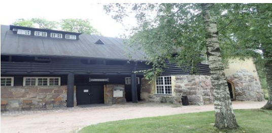
Kuva 41. Pikkuhuvilan hirsiseinien tervaus hyvä. Kuvan hirsiseinä tervattu viimeksi 2016 kahteen kertaan. 4
