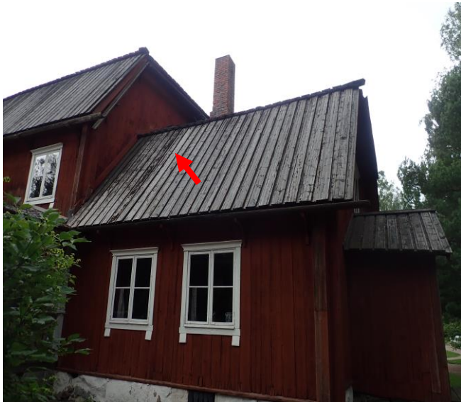
Kuva 30. Kartanon itäläpään lautakatetta. Katossa tummentunut kaistale, joka on mahdollisesti kokkaroitunutta/kasaantunutta tervaa.
