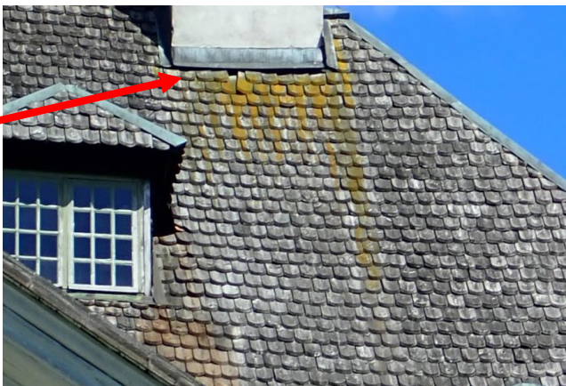
Kuva 24. Oikean puoleisen savupiipun pellityksen alapuolella yksi paanu näyttää irrooneen ja paanuissa sammal-/leväkasvustoa. Kattolyhdyn kohdalla paanuissa ruskeaa väriä.
