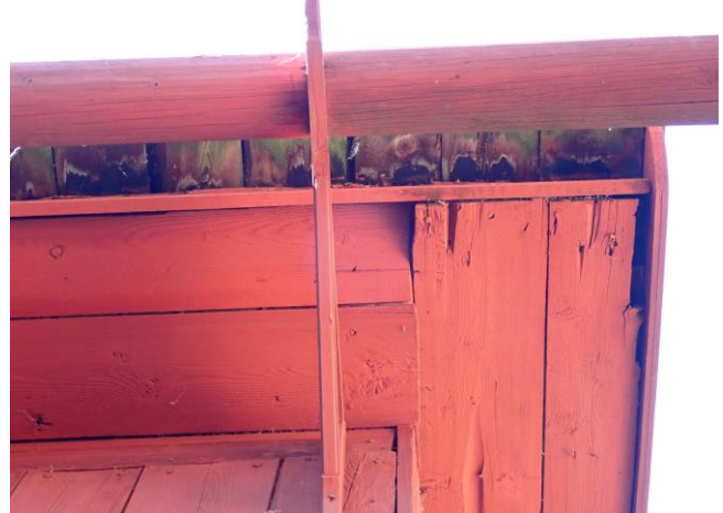
Kuva 18. Räystäään lautojen päiden alapintaa sisäänkäynnin lähetyvillä.
