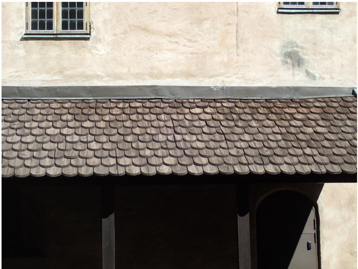
Kuva 10. Turun linnan solakäytävän paanukatteen haljenneita paanuja. (Insinööritoimisto Lauri Mehto Oy, 23.6.2020)
