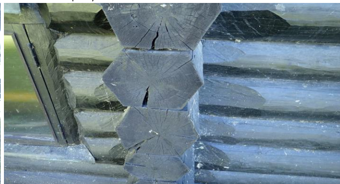
Kuva 49. Pohjoisseinän salvouksen hirsien päädyissä halkeamia. Kuva otettu 21.8.2020
