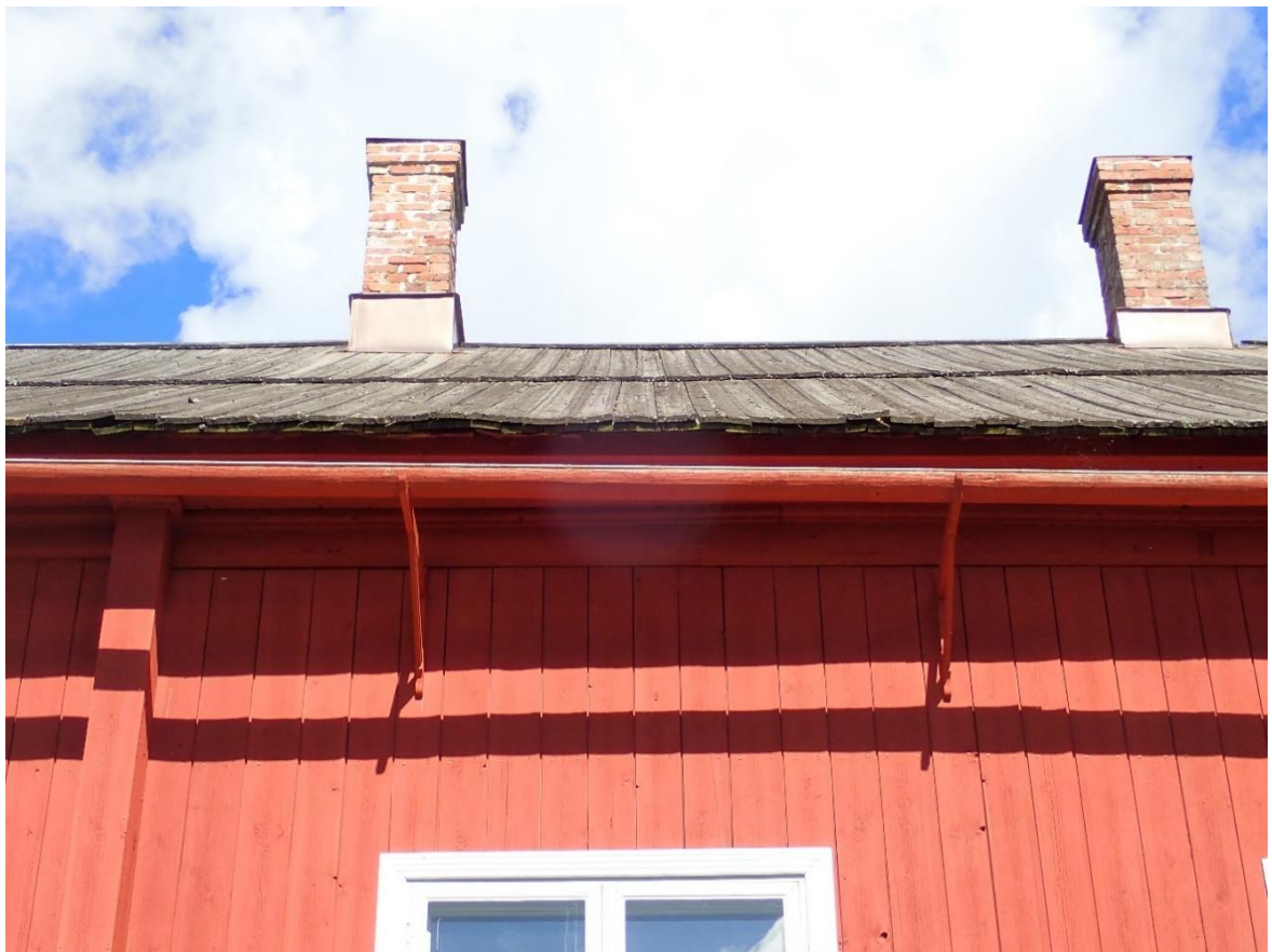
Kuva 5. Kuusiston kartanon etelälapissa laudat alkaneet "lainehtimaan". (Insinööritoimisto Lauri Mehto Oy, 5.8.2020)
