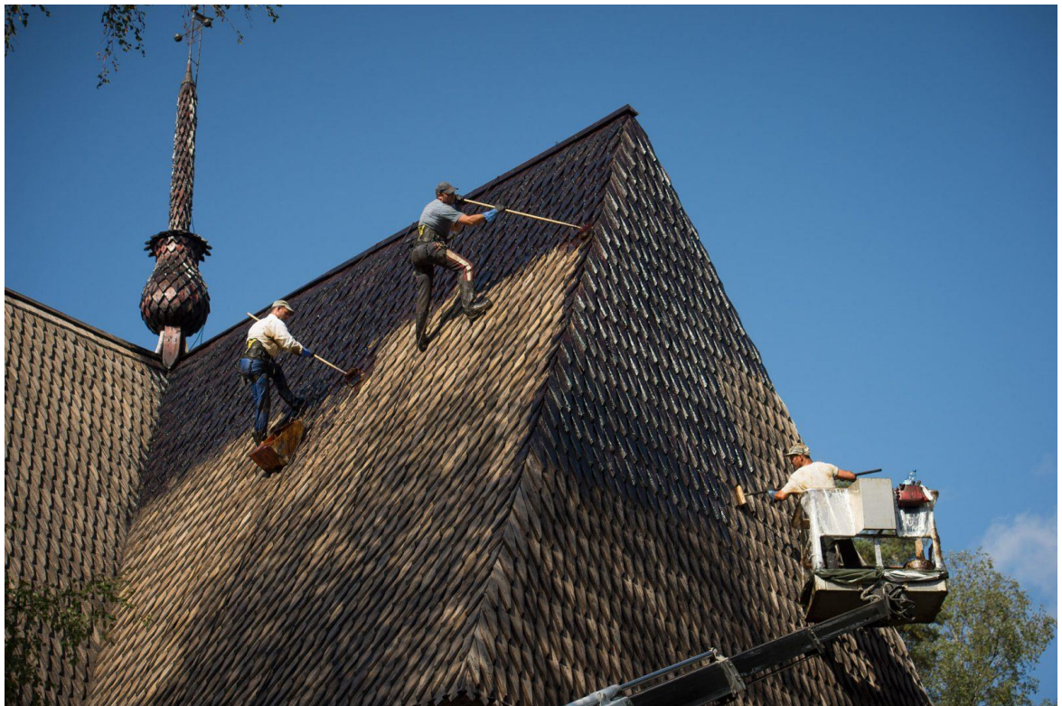
Kuva 17. Tervaa harjataan kattoon. (Kuva: Spåntak, Nykarleby)
