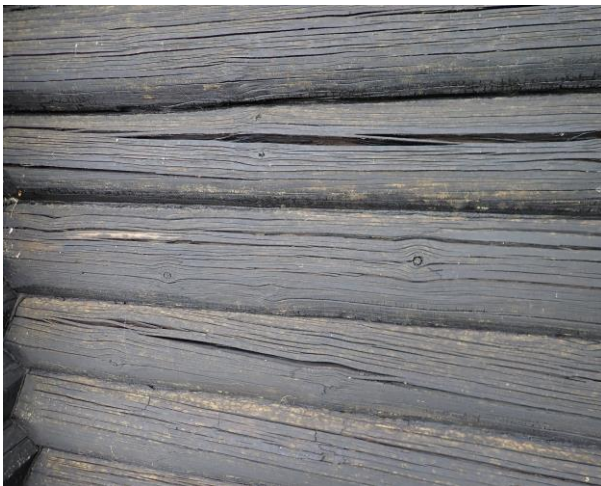
Kuva 46. Etelän puoleisen hirsien säilytymistä.
