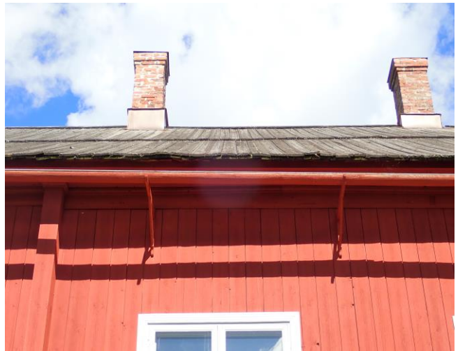
Kuva 16. Osa etelälappen laudoista ja nauloista noussut irit.
