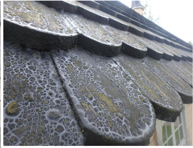
Kuva 5. Pohjoislappen paanuihin muodostunut sammal-/leväkasvustoa. 2 25.8.2020
