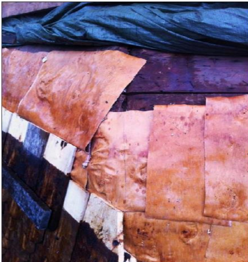
Kuva 9. Limitetyt tuohet paanukaton aluskatteena. Kuva: (Kiminki, 2012)
