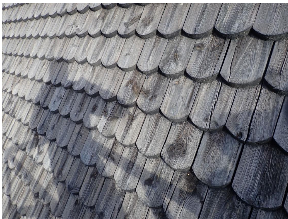
Kuva 24. Eteläpuolen paanuja. Paanut pinnastaan harmaantuneita ja haristuneita. Eteläpuolen paanussa esiintyy jonkin verran halkeilua. (Insinööritoimisto Lauri Mehto Oy, 25.8.2020)
