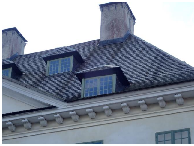
Kuva 22. Tervavalumat kohdistuvat pellitysten yhteyteen.
