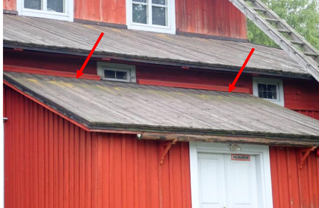
Kuva 56. Pohjoislapteen puoleisessa lautakatteessa sammal-/leväkasvustoa.
