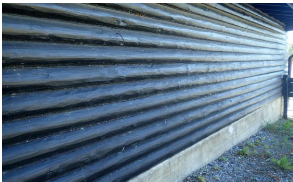
Kuva 48. Pohjoisjulkisivun Pinotexilla käsitellyjä hirsisiä. Pinta selvästi kiiltävämpi verrattuna etelän puoleiseen hirsiseinään. Käsittely pysynyt hyvin hirsien pinnassa. Kuva otettu 21.8.2020
