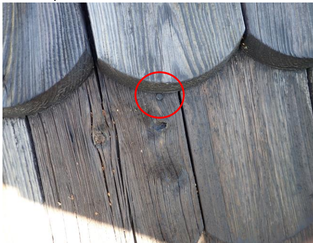
Kuva 6. Etelälappen oksainen paanu, joka alkanut haljeta keskeltä. Paanussa mahdollisesti lisänaulaus. 2 25.8.2020
