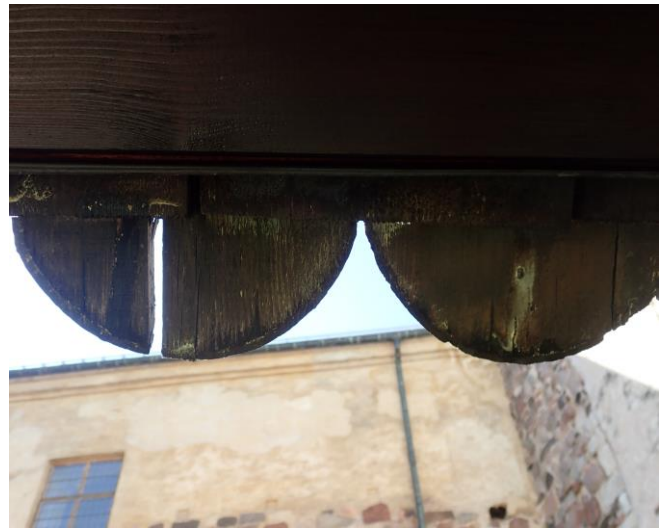
Kuva 12. Halkeama ulottuu läpi paanun.
