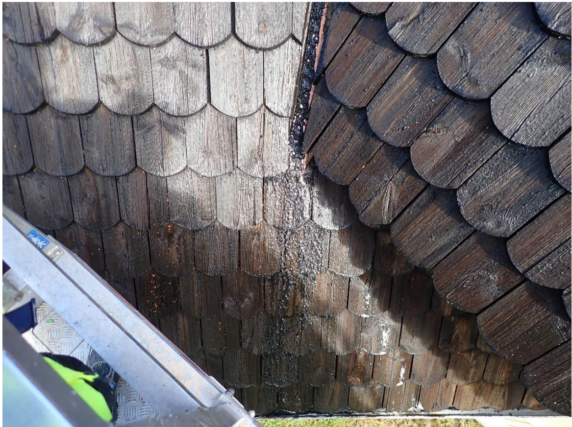
Kuva 26. Tervaa kasaantunut katon jiirin väliseen pellitykseen sekä sen alapuolisiin paanuihin. Kuva otettu sateen jälkeen. (Insinööritoimisto Lauri Mehto Oy, 25.8.2020)
