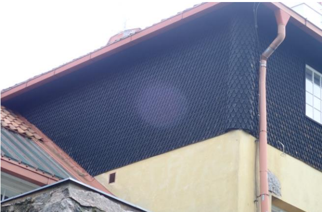
Kuva 39. Päärakennuksen itä- ja pohjoisjulkisivun tervaus näyttää pysyneen hyvin. Tervattu viimeksi 2014 kahteen kertaan. 4
