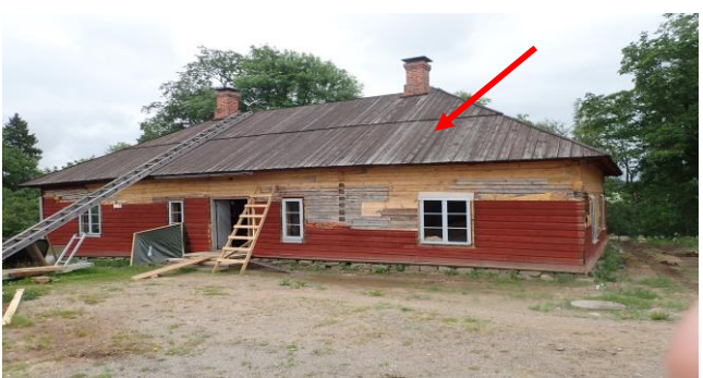
Kuva 58. Alipyntiki kunnostustöiden alla. Katteesta erottuu vaaleampia kaistaleita.
