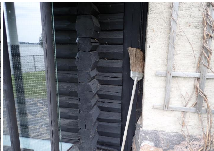
Kuva 47. Eteläpäädyn hirsiseinän salvousnurkka. Väri on selvästi tummempi kuin muissa eteläpäädyn hirsissä
