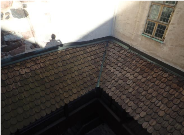
Kuva 9. Yleiskuva solakäytän paanukatosta. (Kuva: Insinööri-toimisto Lauri Mehto Oy. 7.5.2020)
