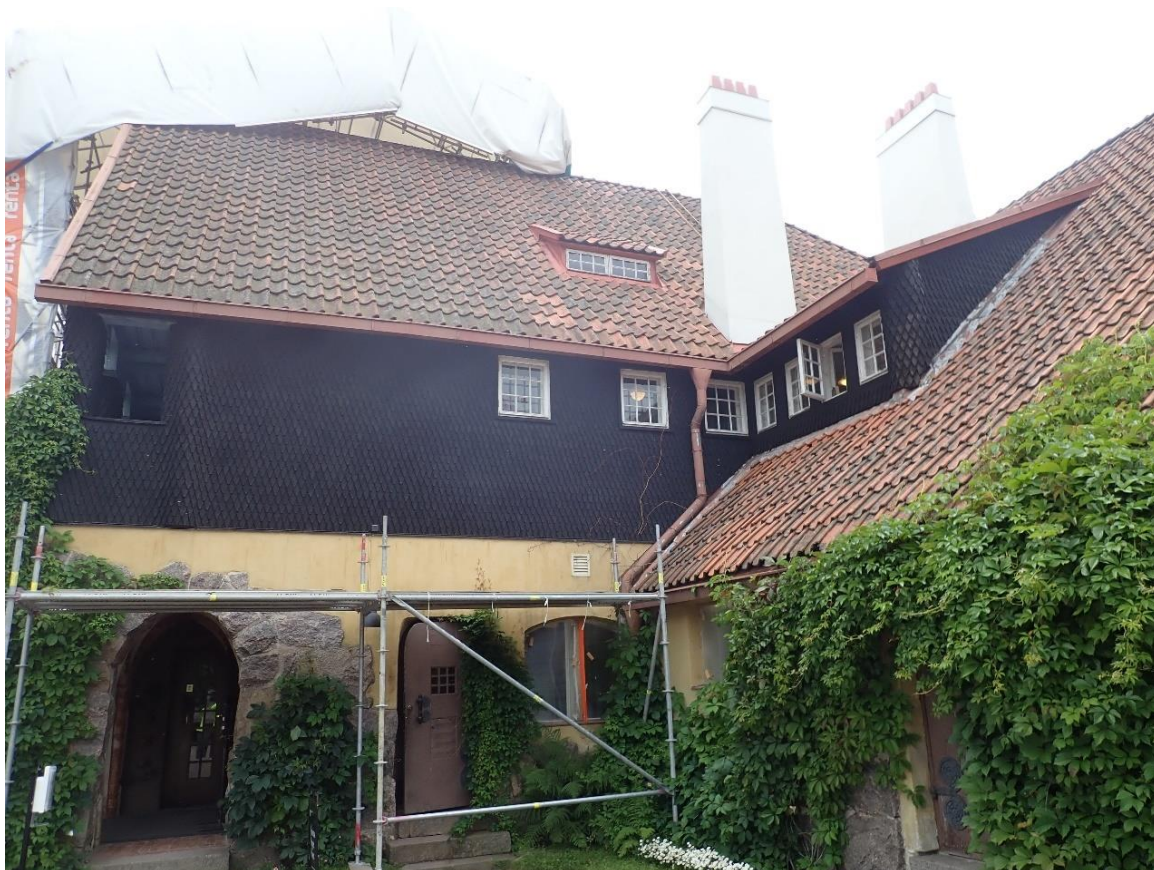
Kuva 30. Päärakennuksen pohjoisjulkisivun paanuverhoitua seinää. Tervapinta hyvässä kunnossa. (Insinööritoimisto Lauri Mehto Oy, 6.8.2020)
