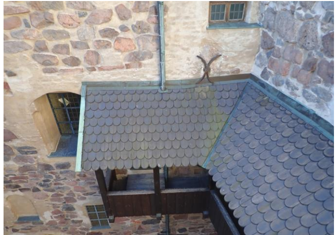
Kuva 10. Paanujen pinnoissa sammal-/leväkasvustoa. (Kuva: Insinööri-toimisto Lauri Mehto Oy. 7.5.2020)
