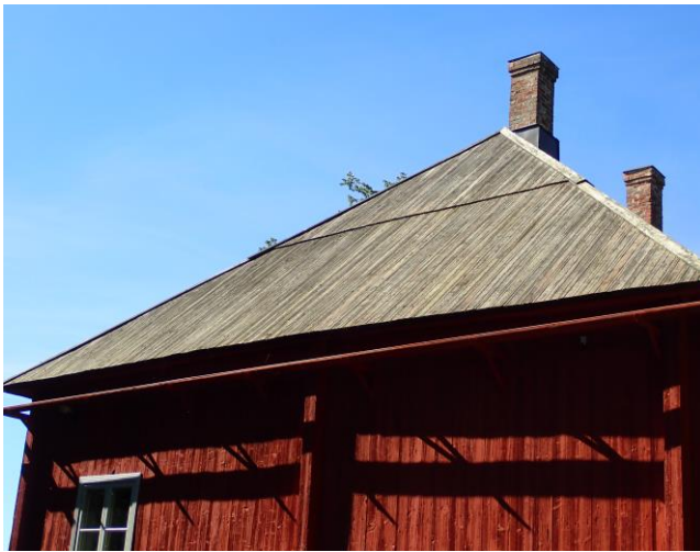
Kuva 15. Koillis-/itälappen lautakate.
