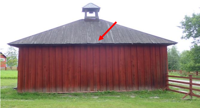
Kuva 57. Alikartanon puodin julkisivu kaakkoon. Puodin katossa muutamia lautoja nousnut/vääntynyt räystään kohdalla.
