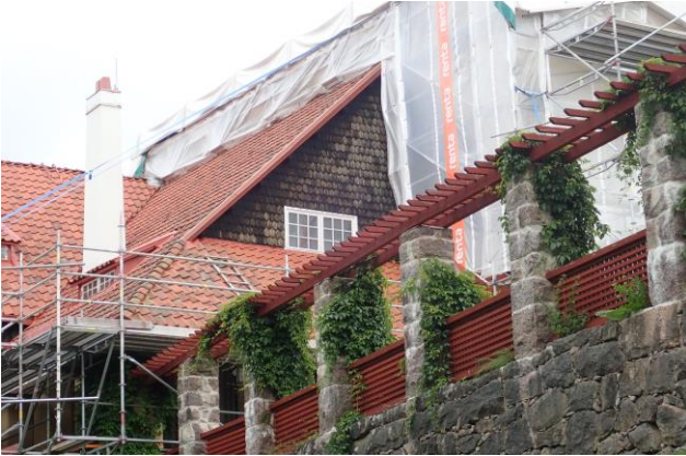
Kuva 35. Päärakennuksen eteläjulkisivun paanuja. Tervattu viimeksi 2018 kahteen kertaan. 4 Eteläpuoli yleisesti kovemalla rasituksella.
