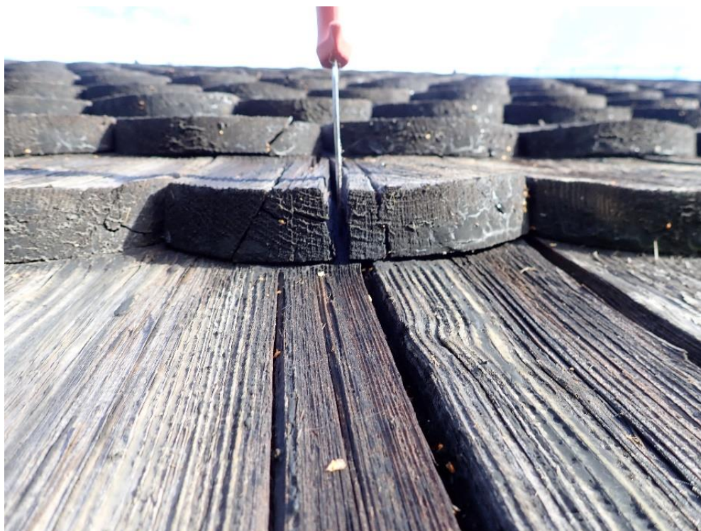
Kuva 24. Eteläpuolen paanuja. Paanut pinnastaan harmaantuneita ja haristuneita. Eteläpuolen paanussa esiintyy jonkin verran halkeilua. (Insinööritoimisto Lauri Mehto Oy, 25.8.2020)
