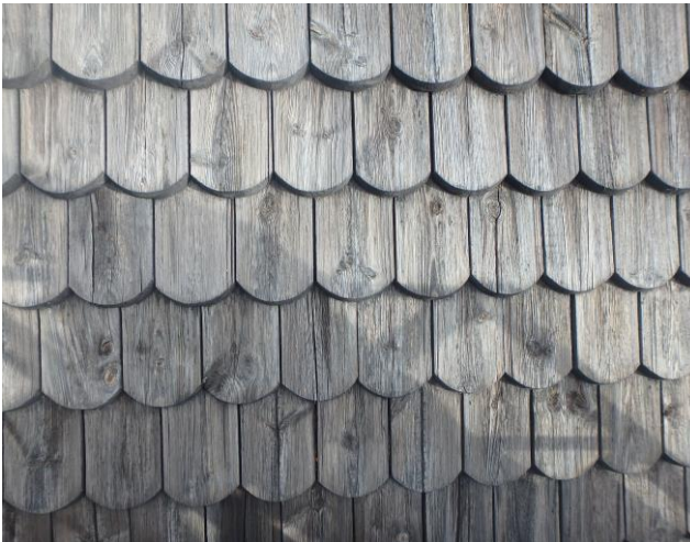
Kuva 4. Etelälappen paanussa esiintyy yleisesti halkeamia. Paanujen pinta haristunutta ja harmaantunutta. 2 25.8.2020
