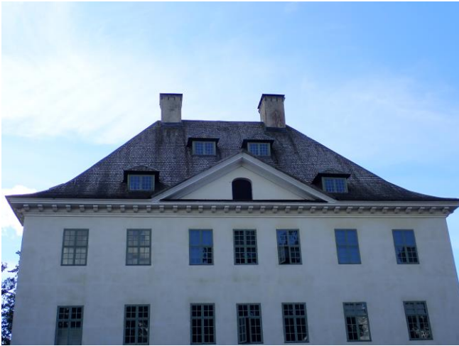
Kuva 21. Pohjoislaipan puoleinen paanukate. Katon tervavalumat/kasaantumukset erottuvat tummempina kaistaleina. Paanujen pinta yleisesti harmaantunut.
