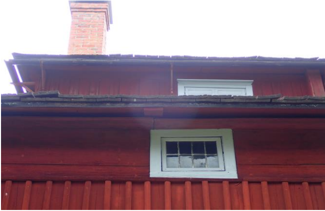
Kuva 54. Länsi-/lounaislappeen osittain nousseita ja vääntyneitä lautoja.
