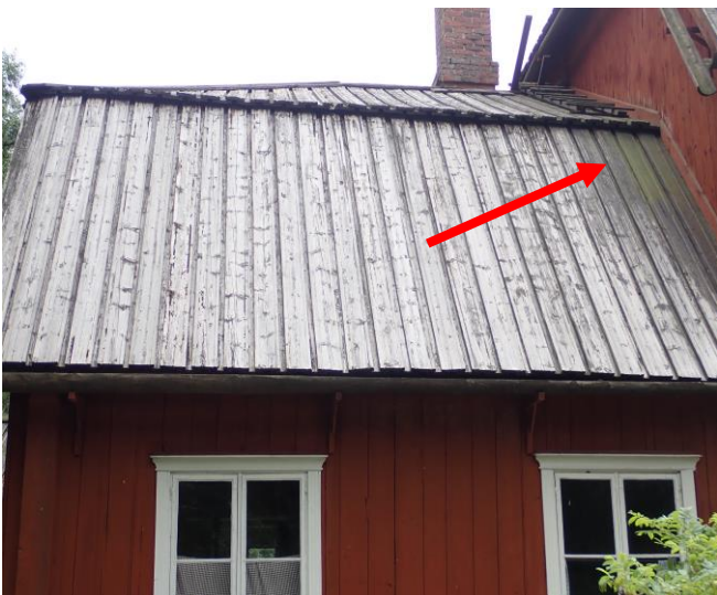
Kuva 32. Katossa sammal-/leväkasvustoon viittaava kaistale.
