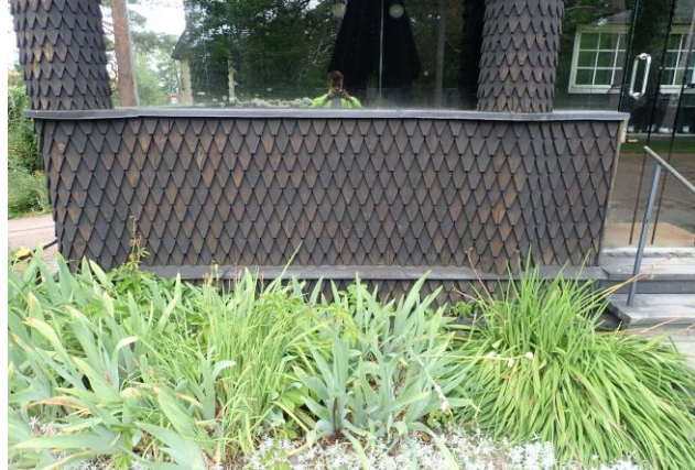
Kuva 38. Pikkuhuvilan itäjulkisivun paanuja sisäänkäynnillä. Värierot johtunevat osittain uusituista paanuksista. Tervattu viimeksi 2018-2019 kahteen kertaan. 4
