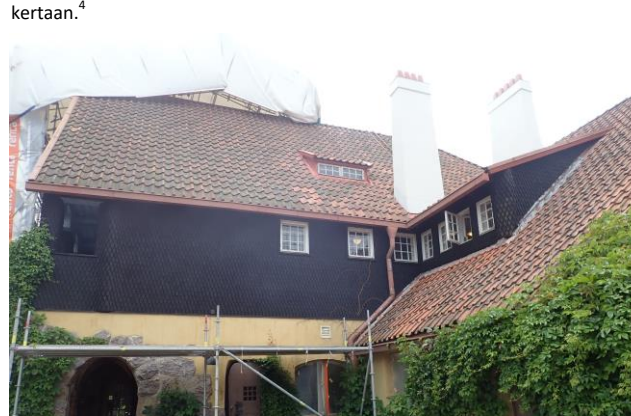
Kuva 40. Pohjois puolen tervaus näyttää pysyneen hyvin. Tervattu viimeksi 2018-2019 kahteen kertaan. 4
