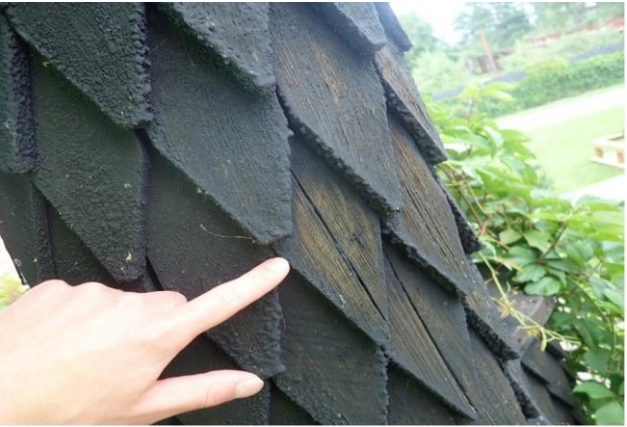
Kuva 37. Päärakennuksen parvekkeen pilarin paanuja. Haljenneissa paanuissa värieroa. Tervattu viimeksi 2018 kahteen kertaan. 4
