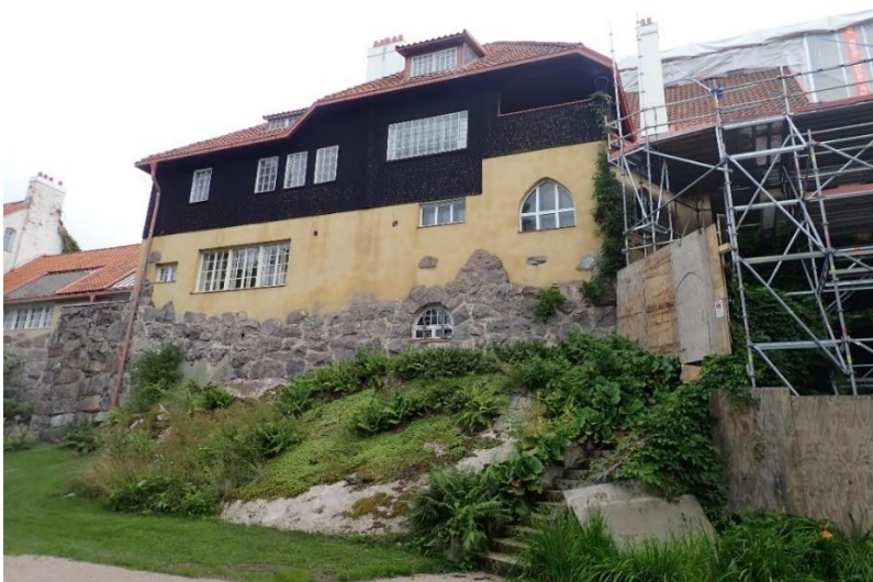
Kuva 34. Päärakennuksen länsiseinää 6.8.2020. (Insinööritoimisto Lauri Mehto Oy, 6.8.2020)
