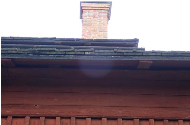
Kuva 55. Koillislapteen laudat nousseet ja vääntyneet räystään linjalta. Lautojen päissä sammal-/leväkasvustoa.
