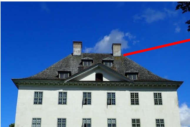
Kuva 23. Etelälaipan puolen paanukate. Vasemman savupiipun kohdalla paanujen pinta harmaampi/vaaleampi.
