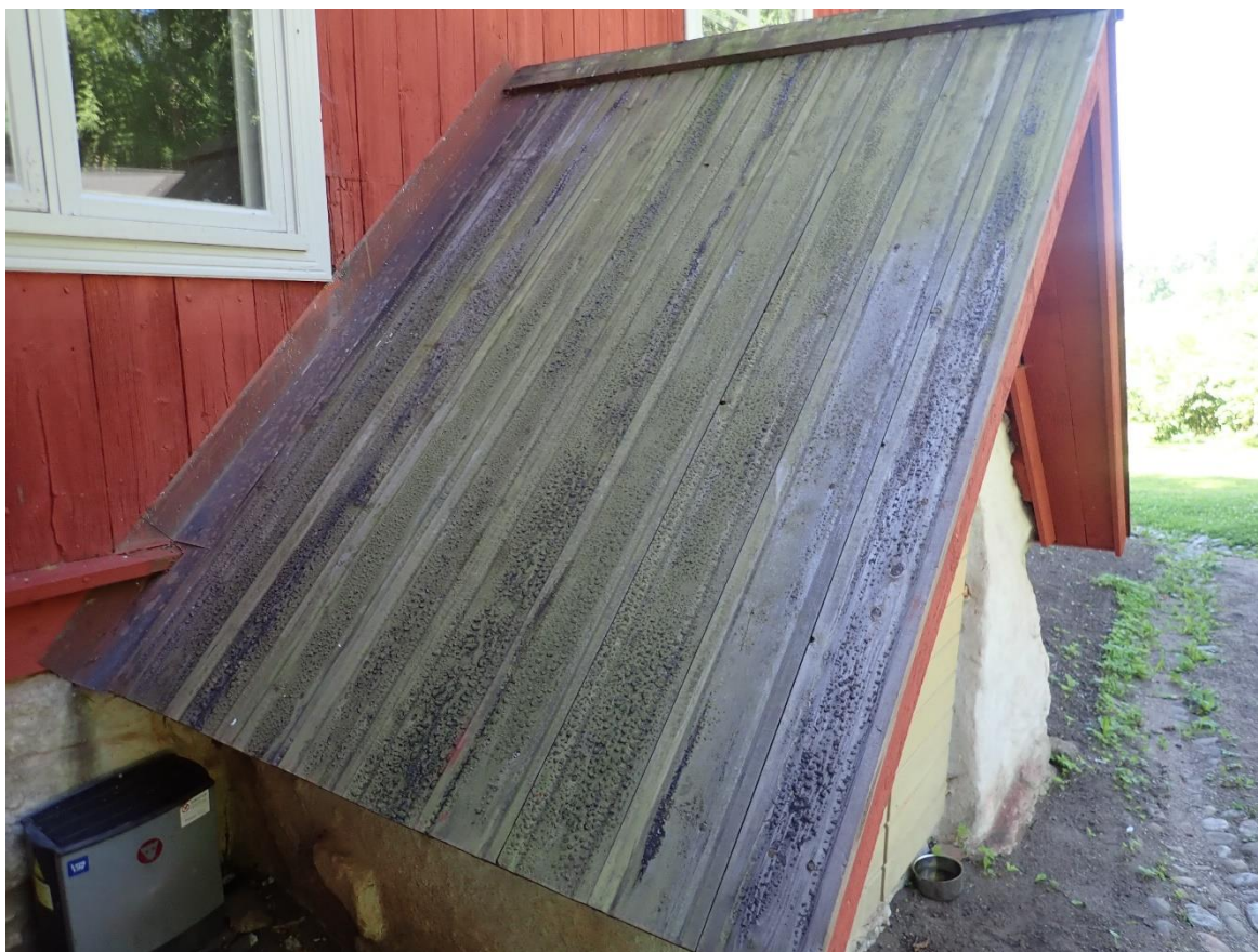
Kuva 29. Tervaustesti jättänyt kellarin sisäänkäynnin kreosootikyllästettyyn uralautakatteeseen suomumaisen pinnan. (Insinööritoimisto Lauri Mehto Oy, 5.8.2020)
