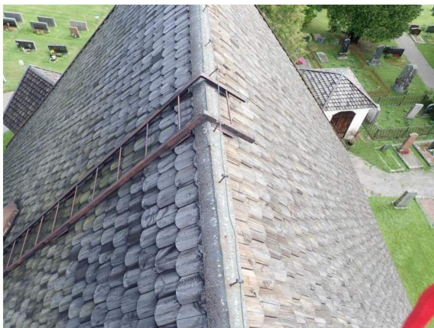
Kuva 23. Pohjois- ja etelälappeen paanuja. Pohjoispuolella leväkas-vustoa. (Insinööri-toimisto Lauri Mehto Oy, 25.8.2020)
