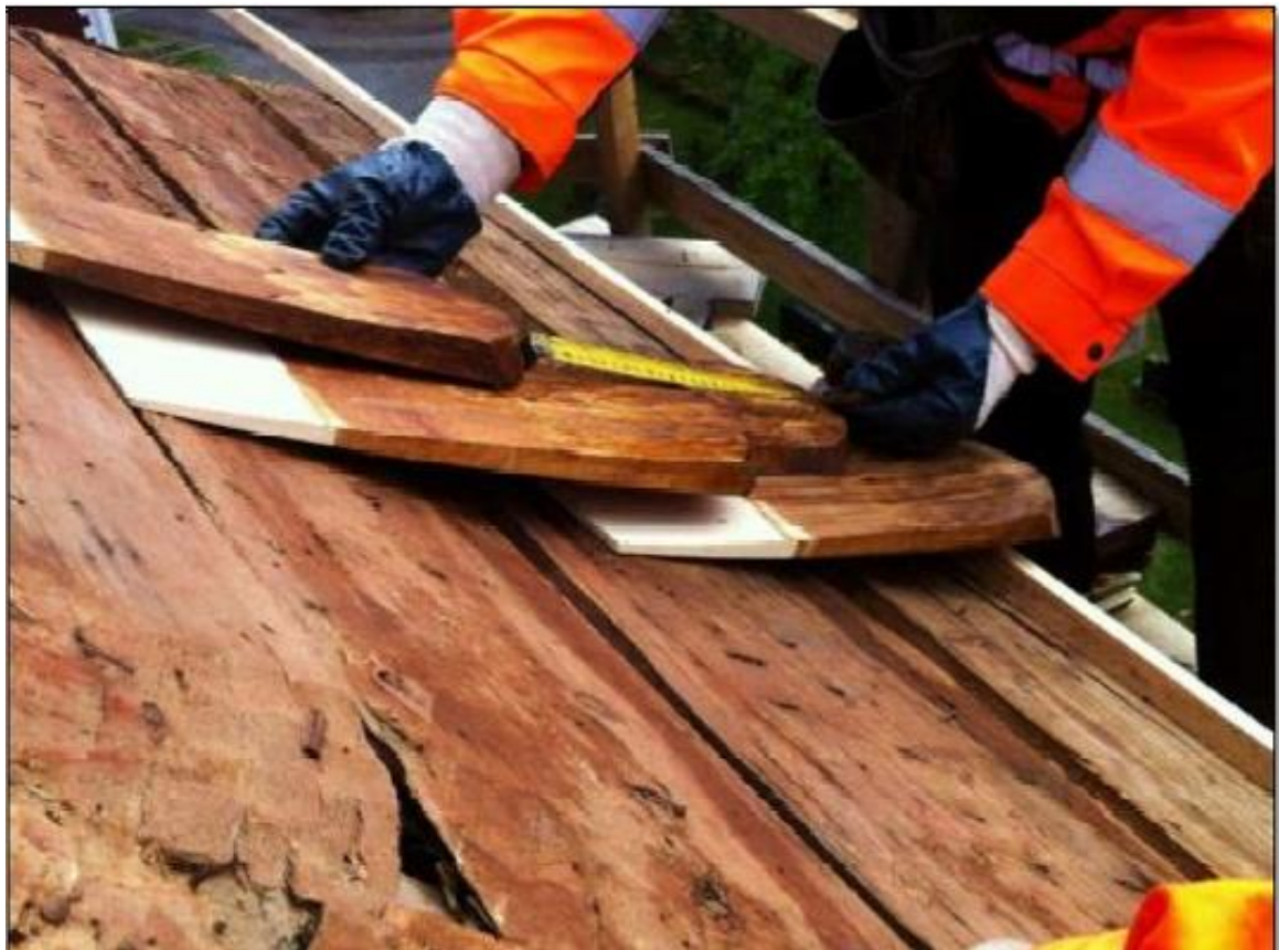
Kuva 11. Paanukatteen valmistus alkaa räystäältä. Paanujen piiloon jäävä pää on veistetty ja se jätetään sahapintaiseksi. Muotoiltu pää jää näkyviin. Kuva: (Kiminki, 2012)
