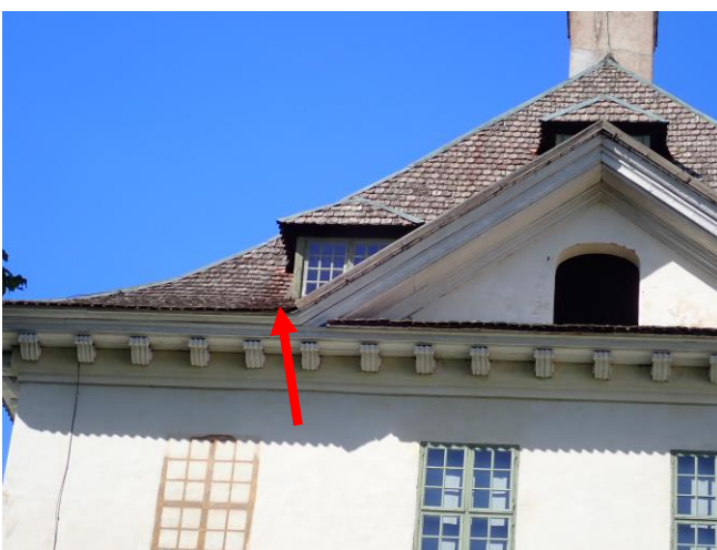
Kuva 25. Itälaipan puolen paanukate. Kattolyhdyn kohdalla näkyy ruskeampi kaistale. Terva mahdollisesti kasaantunut tai pysynyt tässä paremmin.
