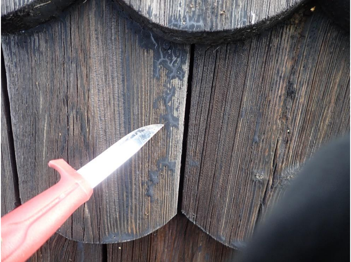
Kuva 27. Terva-ainesta paanun pinnassa. (Insinööritoimisto Lauri Mehto Oy, 25.8.2020)
