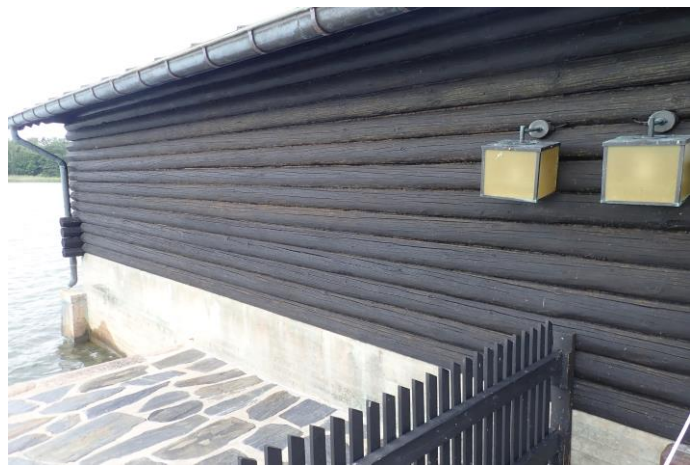
Kuva 45. Rantasaunan etelän puoleista hirsiseinää. Eteläpuolen terveys hieman haalentunut.
