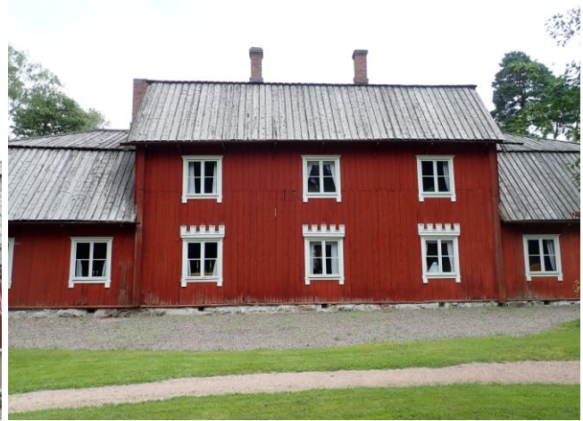
Kuva 29. Kartanon länsiläpään uralautakate rakennuksen takaa. Katteessa harmaitava sävy.
