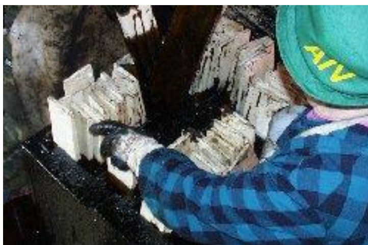
Kuva 16. Kärsämäen kirkon paanuja upotetaan terva-astiaan. (Kuva: Väyrynen, 2000)
