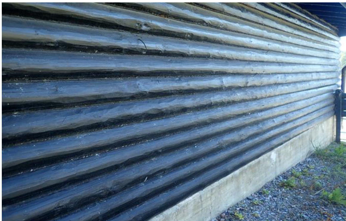
Kuva 20. Urho Kekkosen museon rantasaunan pohjoisjulkisivun hirsiseinä. Hirsiseinän 2018 uusit- tuja riveyksiä käsiteltiin Pinotexilla. (Kuva: Insinööritoimisto Lauri Mehto Oy, 21.8.2020)
