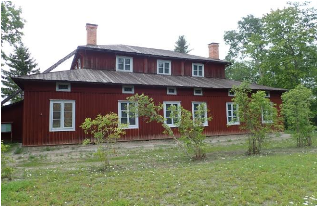
Kuva 53. Länsi-/lounais puolen lautakate. Katteessa värvaihtelua.
