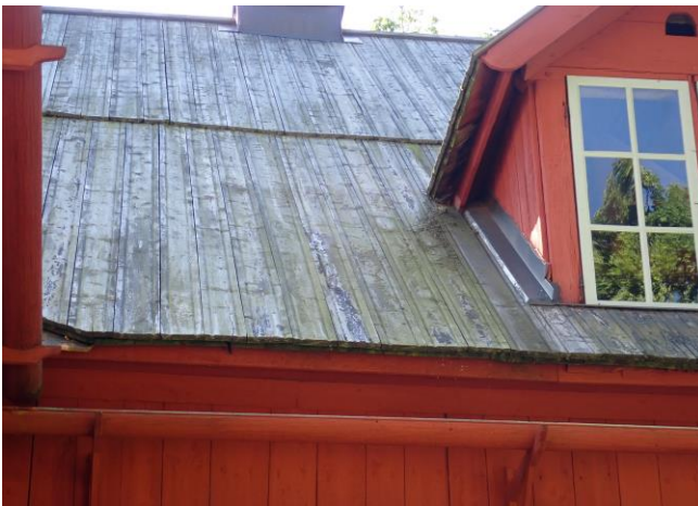
Kuva 17. Sammal-/leväkasvustoon viittaavaa vihreyttä. Terva kasaantunutta paikoittain.
