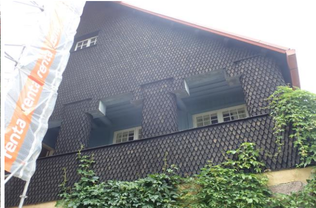
Kuva 36. Päärakennuksen itä-/kaakkoisjulkisivun paanuja. Tervattu viimeksi 2018 kahteen kertaan. 4
