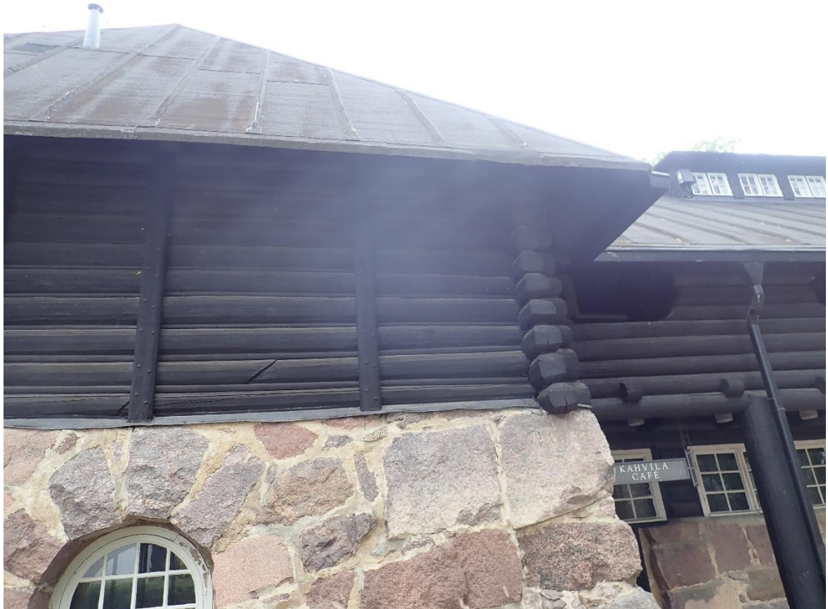
Kuva 31. Pikkuhuivilan hirsiseinää. Tervauspinta tasainen ja hyvännäköinen. (Insinööritoimisto Lauri Mehto Oy, 6.8.2020)
