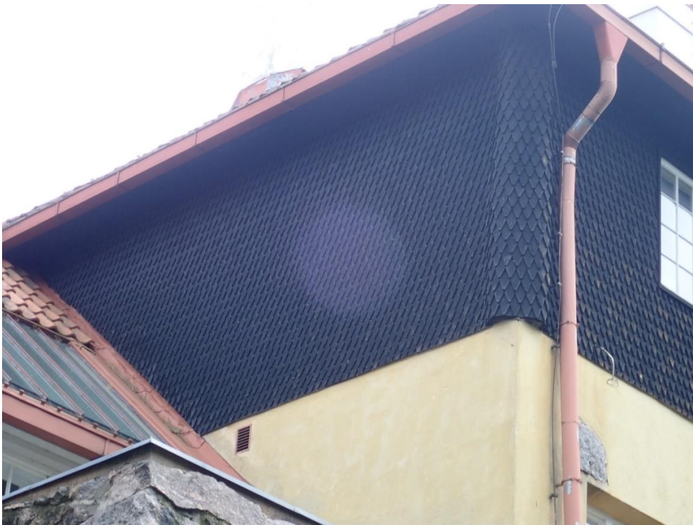
Kuva 7. Hvitträskin päärakennuksen paanuverhoiltua seinää. (Insinööritoimisto Lauri Mehto Oy. 6.8.2020)
