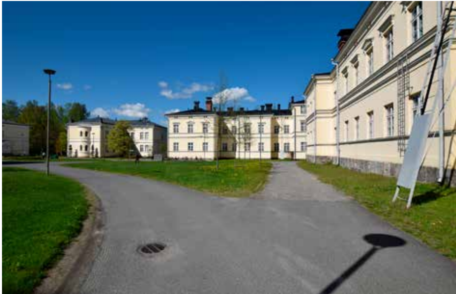
Sisäpihan luoteisosaa. Vasemmalla päärakennus. Kuva länteen päin.
