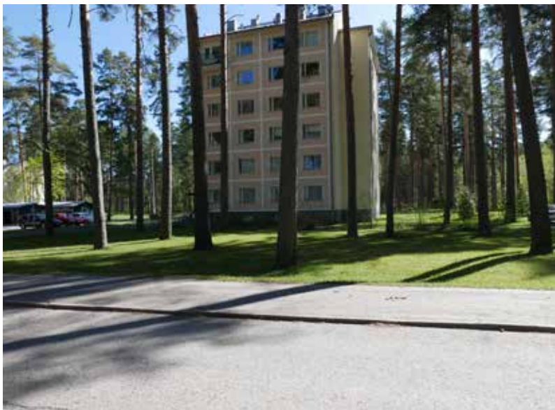
Alueen etelänpuoleinen asuinkerrostalo on rakennettu 1950 -luvun lopulla. Kuva itään päin.
