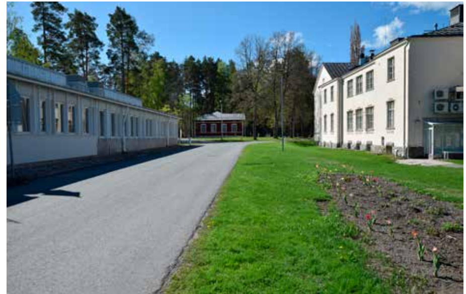
Alueen kaakkoisreunaa. Vasemmalla itäpuiston uudempaa rakennuskantaa. Kukkaistuksilla on ollut aiemmin nykyistä suurempi merkitys sisäpihalla. Kuva etelään päin
