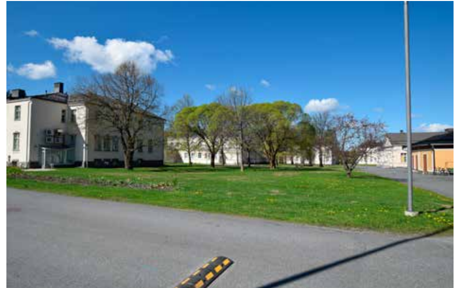
Sisäpihan kaakkoisosalla kasvaa rakennuksen edessä hyväkuntoinen isolehtilehmus. Kuva lounaaseen päin.
