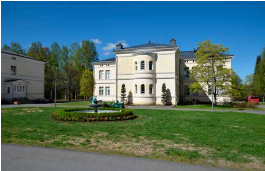
Päärakennus ja suihkulähde. Kuva lounaaseen päin.
