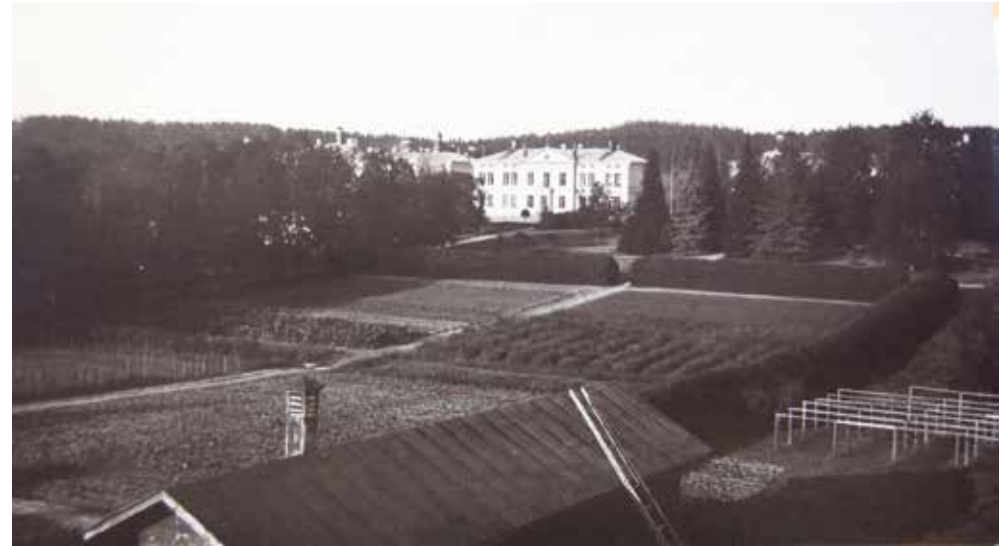
Puutarha joskus 1900 -luvun alkupuolella nähtynä pesularakennuksen yläkerrasta tai katolta. Taustalla näkyy hallintorakennus. Lähde: NIUSK.
