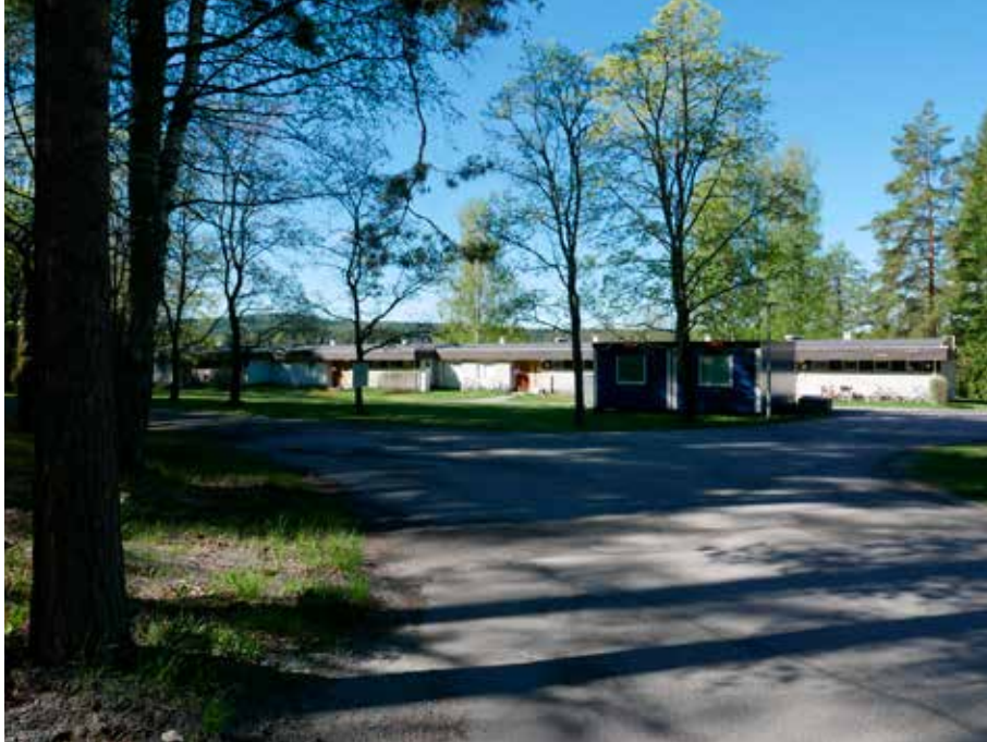
Tällä paikalla sijaitsi ylilääkärin asuintalo. Rivitalossa asui viimeksi henkilökuntaa ja tällä hetkellä rakennus toimii väistötiloina. Vaahterarivi lienee rivitalon rakentamisen ajalta. Kuva lounaaseen päin.
