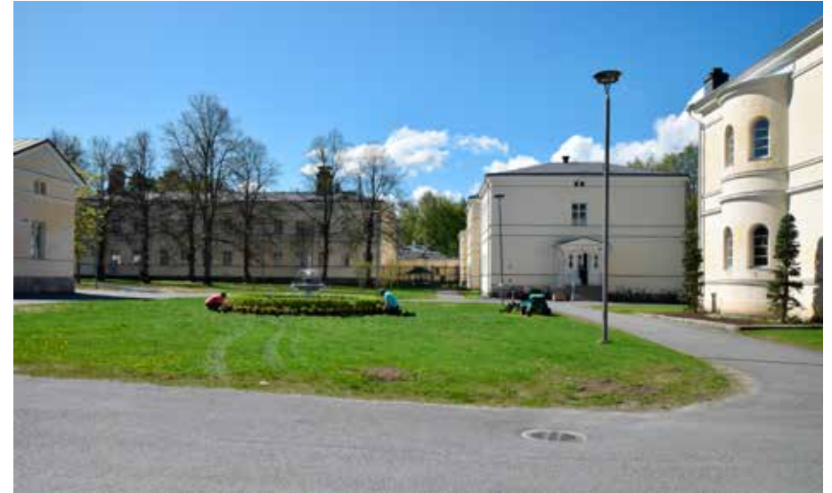
Päärakennuksen edustalla on nähtävästi 1940-50 -lukujen vaihteessa rakennettu kukkaistutuksin ja kultaherukoin ympäröity suihkulähde, joka on sijoitettu alueelle keskeisakselille päärakennuksen eteen. Suihkuallas on sisäpihan puiston tärkeä osa. Kuva etelään päin.
