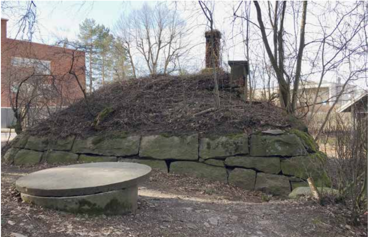
↑ Idänpuolella on nähtävissä kookas kiviladonta. Rakennus maastoutuu osittain maapinnan ja kasvillisuuden alle.
