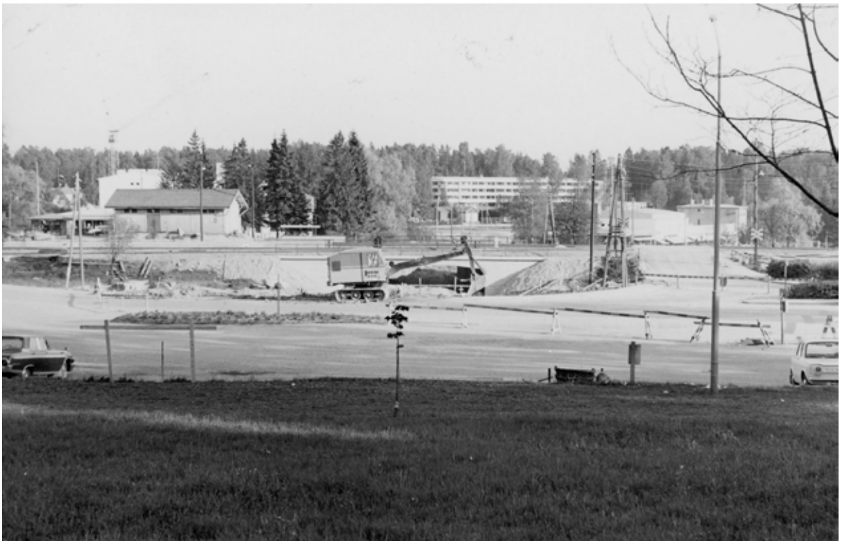
↑↑ Kauniaisten aseman alue ennen alikulkutunnelin rakentamista 1965. Kuvassa on vielä nähtävissä vanha tonttijako ennen Meurmanin kaavan toteuttamista, vanhaa rakennuskantaa puretaan kuitenkin jo pois aseman ympäristöstä. Myös aseman alue muuttuu, kun alikulkutunneli rakennetaan aseman vasemmalla puolella näkyvän makasiinirakennuksen ja radan yli kulkevan hiekkatien väliin. Kauniaisten paikallishistoriallinen arkisto.
