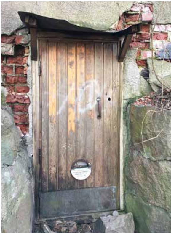
↑ Ulko-ovi lienee uusittu 1950-60-luvulla. Sitä suojaava metallikatos on vääntynyt. Kellarin seinät ovat osittain tiilestä muuratut.
