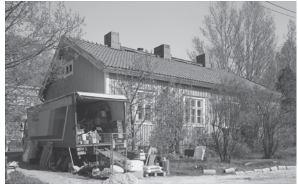
↑ Paritalossa oli pystysuuntainen julkisivulau- doitus ja tiilikate. GLHA.
