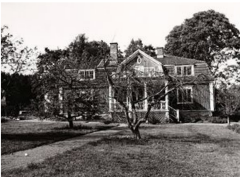
← Kuva paikalta puretusta rakennuksesta. Nykyinen johtajan talo rakennettiin paikalta puretun 1820-luvulla valmistuneen hirsitalon paikalle. Vanha päärakennus oli korjattu 1930-luvun alussa koeaseman johtajan asunnoksi ja siinä oli alakerrassa neljä huonetta: tupa, sali ja kaksi kammaria eteisen ja verannan lisäksi. Toisessa kerroksessa oli kaksi huonetta ja avokuisti eli altaani. (Museoviraston inventointikortti 1996). Kaarinan kunta. Kuvälähde LUKE Piikkiö.
