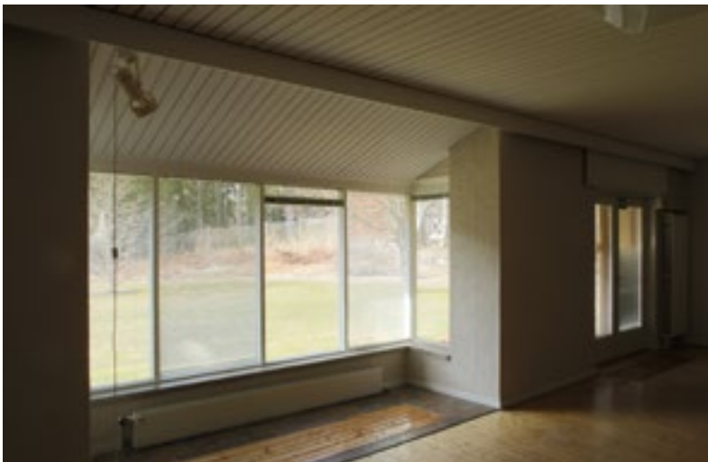
← Olohuoneen katto on uusittu, kun taloon on asennettu koneellinen ilmanvaihto. Alkuperäinen kattopinta on korkeammalla. Kulmaerikkeen kasvikaikalo on peitetty.
