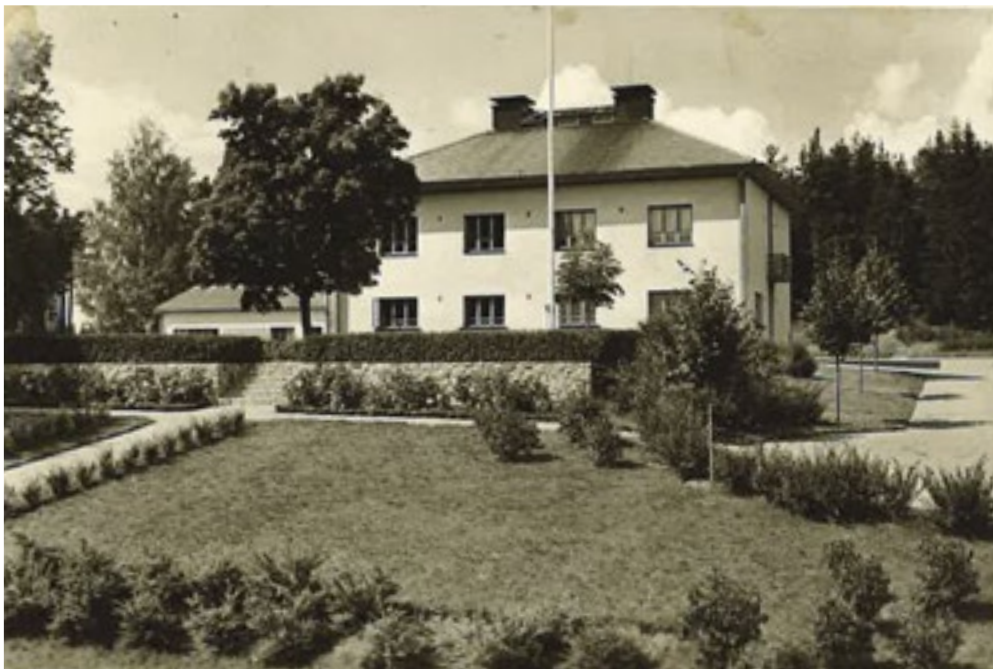
← Päärakennuksen kaakkoisjulkisivu katsoo merelle. Valokuva-albumi 1. LUKE.
