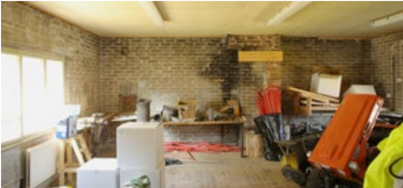
← Verstassiipi on tehty sementti- tiillistä.
