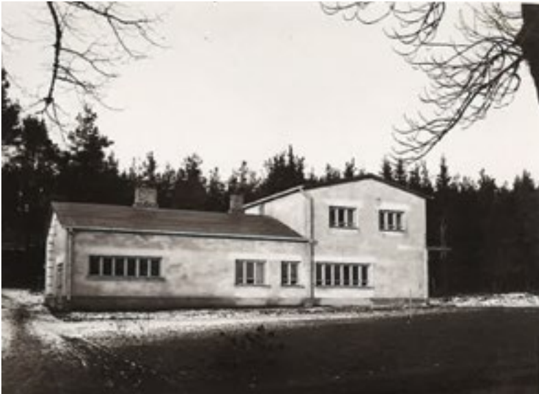
← Ruokala keskeneräisenä tammikuussa 1936. Tiilikattoa ei vielä ole laitettu ja ulkoseinät ovat maalaamatta. Piippuja ei ole pellitetty. Kuva kansiota 1. LUKE.
