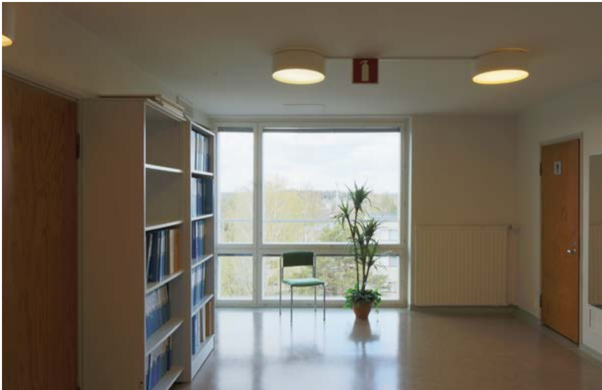
↑ Keskikäytävän pohjoispään tyypillinen aulatila, 6. kerros. Käytävän pohjoispäässä on maisemaikkuna 4.–7. kerroksessa. Lattia on yläkerroksissa ruskeanharmaata linoleum-mattoa, jonka reunoilla on seinää vasten nostettu harmaa muovimattokaista. Ikkunat on uusittu alkuperäisen puitejaon mukaan.
