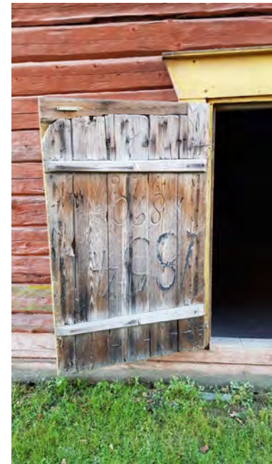
Vellisaunan oveen on kaiverrettu vuosiluvut 1854, 1890 ja 1976. Ensimmäinen vuosiluku lienee rakennusvuosi, toinen vuosi, jolloin vellisauna siirrettiin nykyiselle paikalleen ja kolmas vellisaunan restaurointivuosi.
