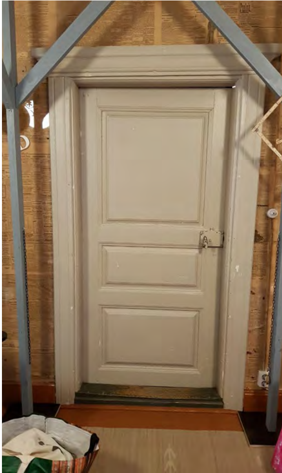
Porstuakamarin H13 ja porstuan H11 väliovi porstuakamarin puolelta. Arkkitehtitoimisto Hanna Lyytinen 2018.
