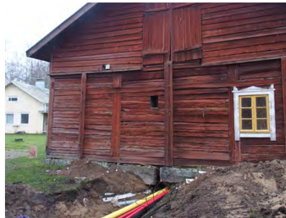
Kaukolämpöputken kaivanto navetan itäpäädyssä syksyllä 2018.
