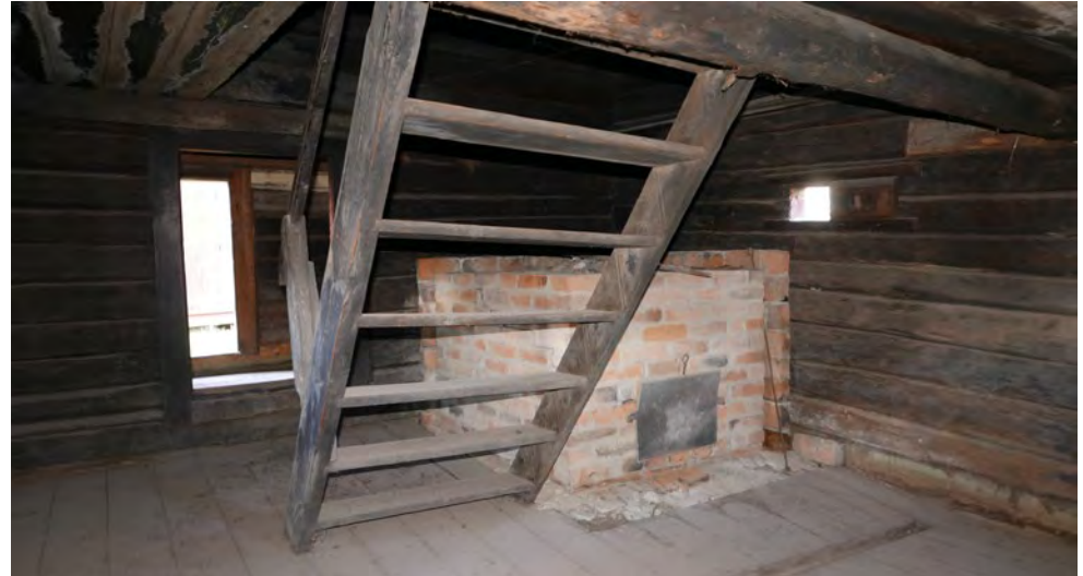
Löylyhuoneen kiuas muurattiin uudestaan 1970-luvun restauroinnissa.
