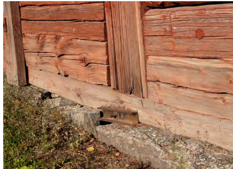
Vetotangon pää kivijalan ulkopuolella. Marko Koivuporras 2018, Studio Street Oy.
