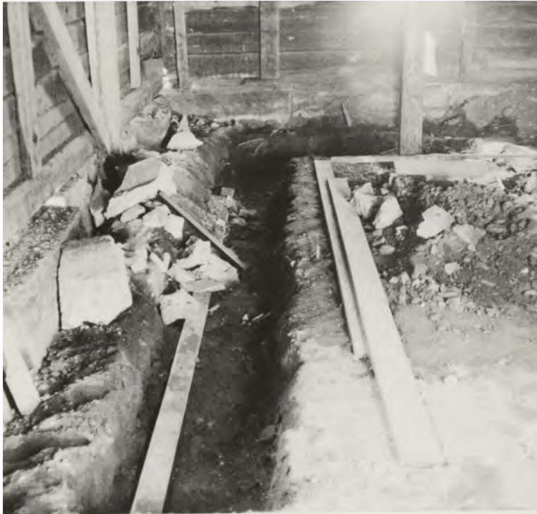
Lämpökeskuksen ja wc-tilojen kohdalta reunavahvistetun laatan pohja, toukokuu 1975. Saara Palomäki. MVA RHO21155.
