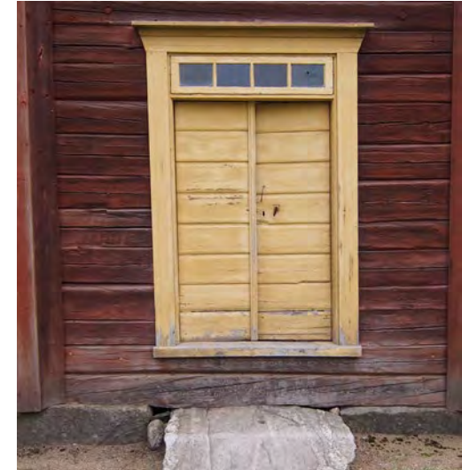
Lutin solaan johtavan pariulko-oven yläpuolella on neliruutuinen ikkuna.
