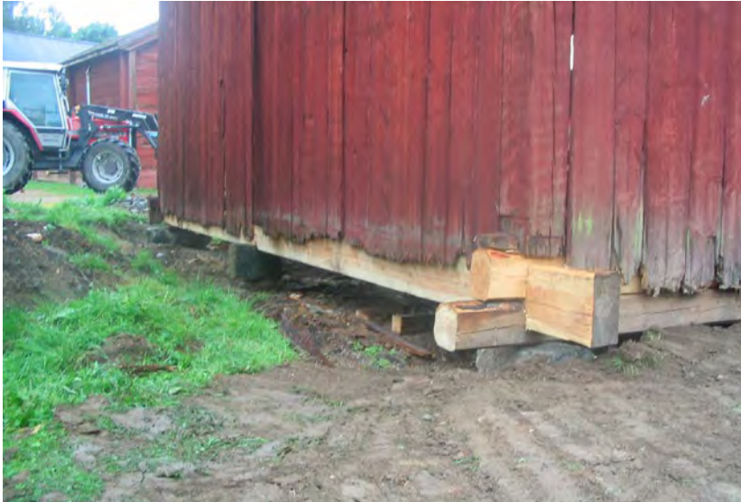
Puuliiverin itäpääty nostettuna. Kivimäki 2008, MV REST.
