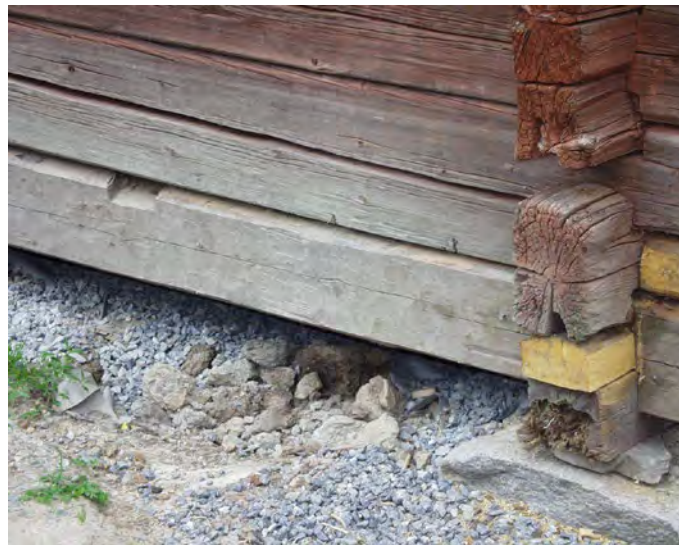
Tallin korjattu hirsinurkka 2001, MV REST.
