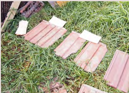
Kattotiien puhdistusmallit: vasemmalla teräsharjaus ja keskellä painepesu.
