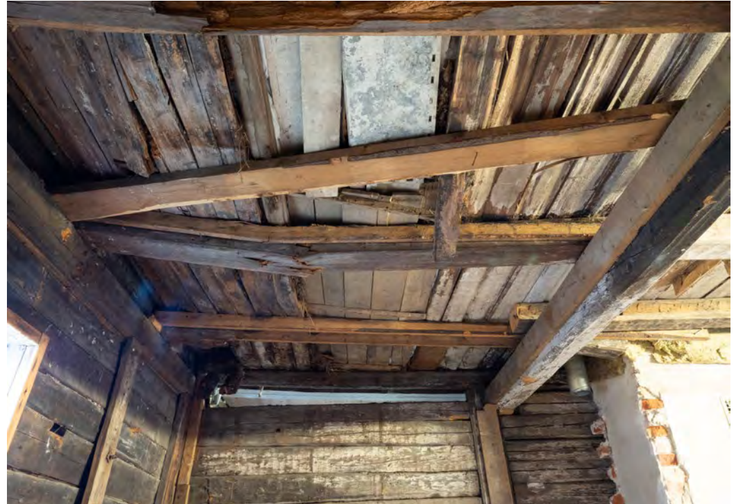
Variköökkin eli karjakeittiön välipohja ja seinä yleisö-wc-tilojen ja kattilahuoneen purkamisen jälkeen marraskuussa 2018. Marko Koivuporras 2018, Studio Street Oy.
