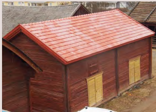
Kunnostettu katto huhtikuussa 2017.
