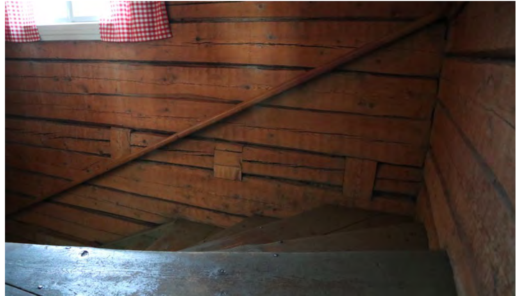
Portaiden ulkoseinää. Välipohjakannakkeiden kohdassa näkyy hirsipaikat.
