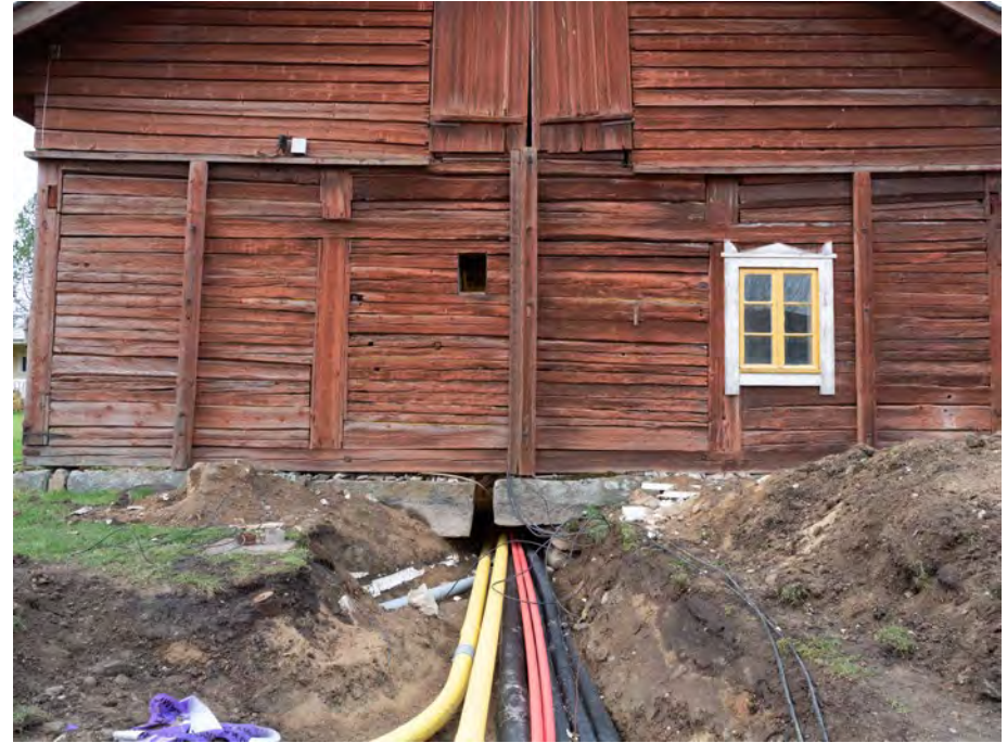
Kaukolämpöputkien kaivanto 2018. Arkkitehtitoimisto Hanna Lyytinen.
