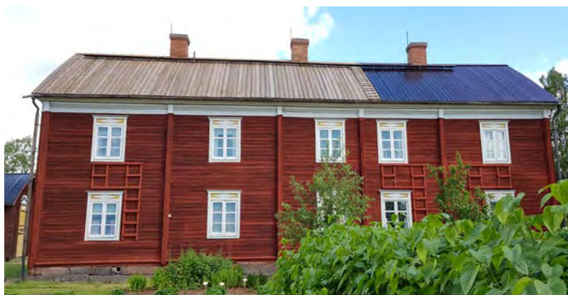
Pääratin lautakatto uusittiin vuonna 2018. Kuvassa etelälape on osittain tervattu helletervauksena. Arkkitehtitoimisto Hanna Lyytinen 2018.
