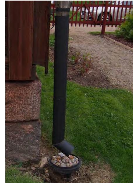
Syöksytornit vaihdettiin pintojen salaojituksen yhteydessä vuonna 2000. Arkkitehtitoimisto Hanna Lyytinen 2016.
