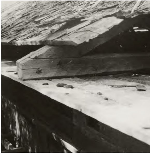
Purettua pärekattoa heinäkuussa 1975. Panu Kaila. MVA RHO19606.
