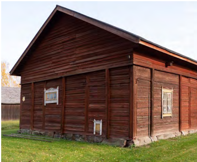
Navetan länsipääty. Marko Koivuporras 2018, Studio Street Oy.
