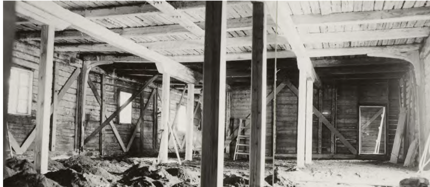
Sisäkuva länteen elokuussa 1975. Runko on tuettu ja katonkannattajapilarit siirretty alkuperäisille paikoilleen. S. Suoniemi. MVA RH016704.
