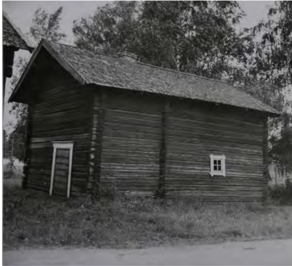
Vellisauna ennen restaurointia. Ikkunan tilalle palautettiin luukku 1970-luvun restauroinnissa. Alfred Kolehmainen, 1965. MVA KK3632:89.
