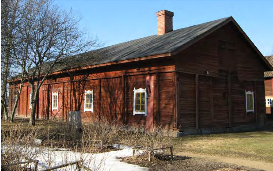
Navetan etelä- ja itäjulkisivu. Päivi Eronen 2007, MV REST.
