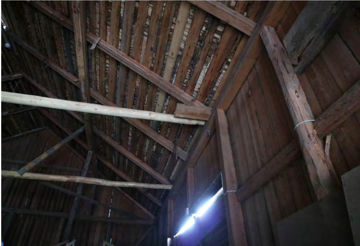
Ladon rakenteet tuettiin vuosina 2012-2013. Orsitappien kylkeen ulkoseinän vaakaoiteen pultattiin uudet sahatut vaakasuuntaiset viiden tuuman pelkkahirret, jotka kiristettiin taljojen avulla suoraan. Vinotuet palautettiin pystypilareiden ja orsipuiden alapuolisen palkin välille. Lyytinen 2018.
