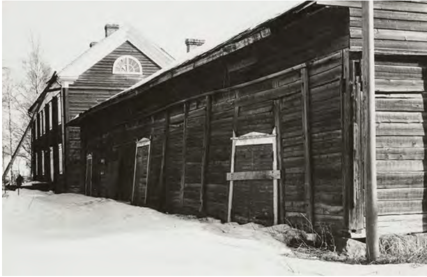
Pohjoisjulkisivu ennen oikomista 1974. E. Härö. MVA RHO10867.
