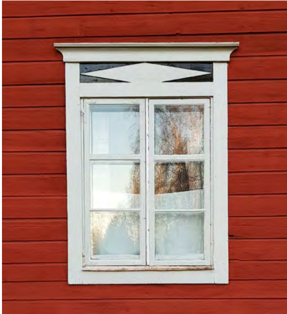
Pääratin ikkunoiden sekä niiden vuorilautojen ja yläpuolisen vinoneliöpeilin pohjan väri palautettiin vuonna 2018 vanhimpaan väritutkimuksessa löydettyyn värivaiheeseen, jossa peilin pohja on ollut musta ja vuorilaudoitukset sekä puitteet vaalean umbranharmaat. Arkkitehtitoimisto Hanna Lyytinen 2018.
