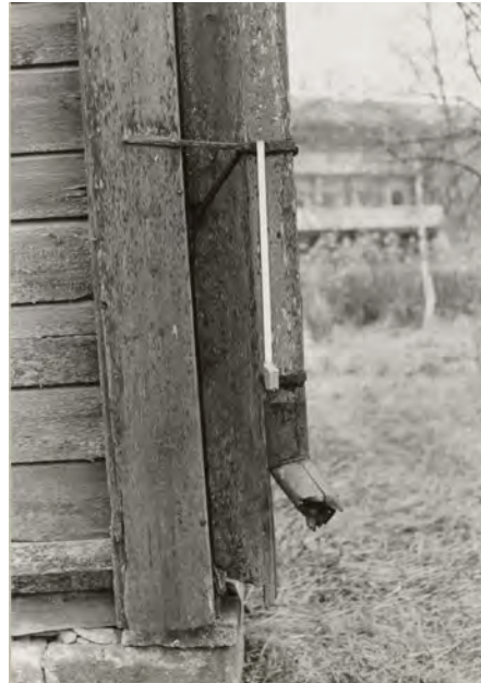
Pääratin syöksytornin alapää 1972, MVA RHO3982A.
