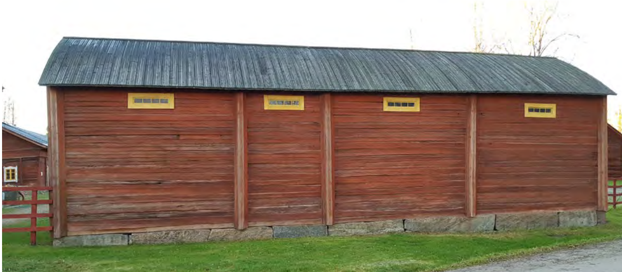
Luttiratin julkisivu itään raitin suuntaan.
