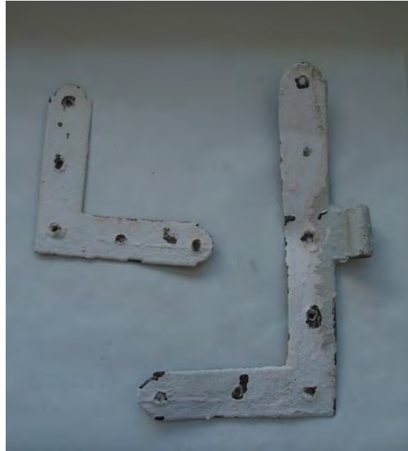
Ikkunan kulmarauta ja kulmasarana. Arkkitehtitoimisto Hanna Lyytinen 2018.
