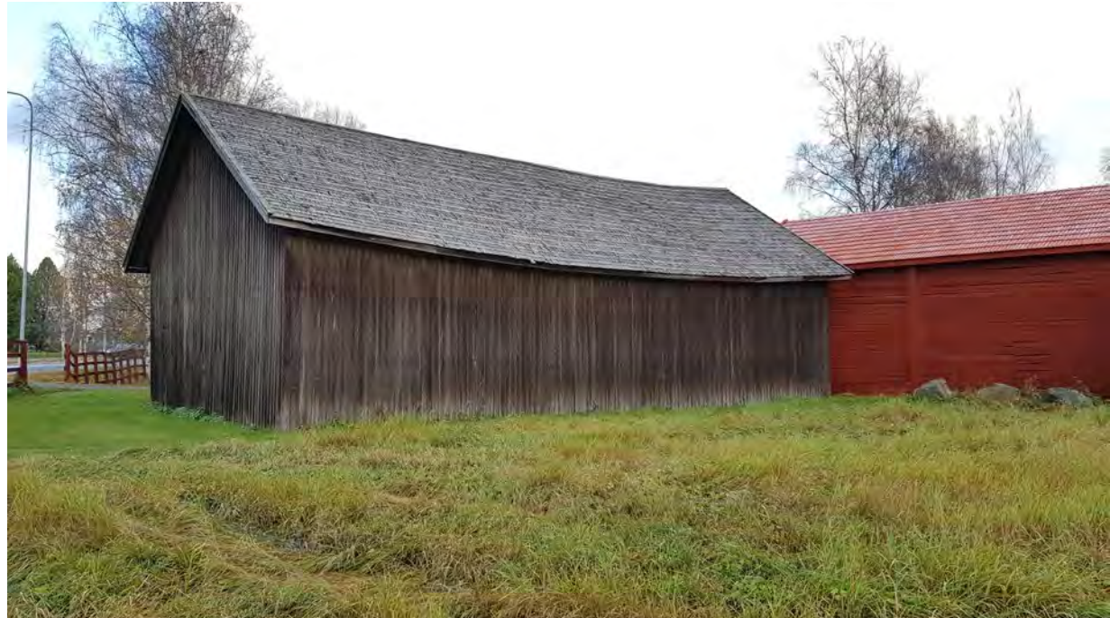
Harmaan ladon julkisivu etelään entiselle karjapihalle.
