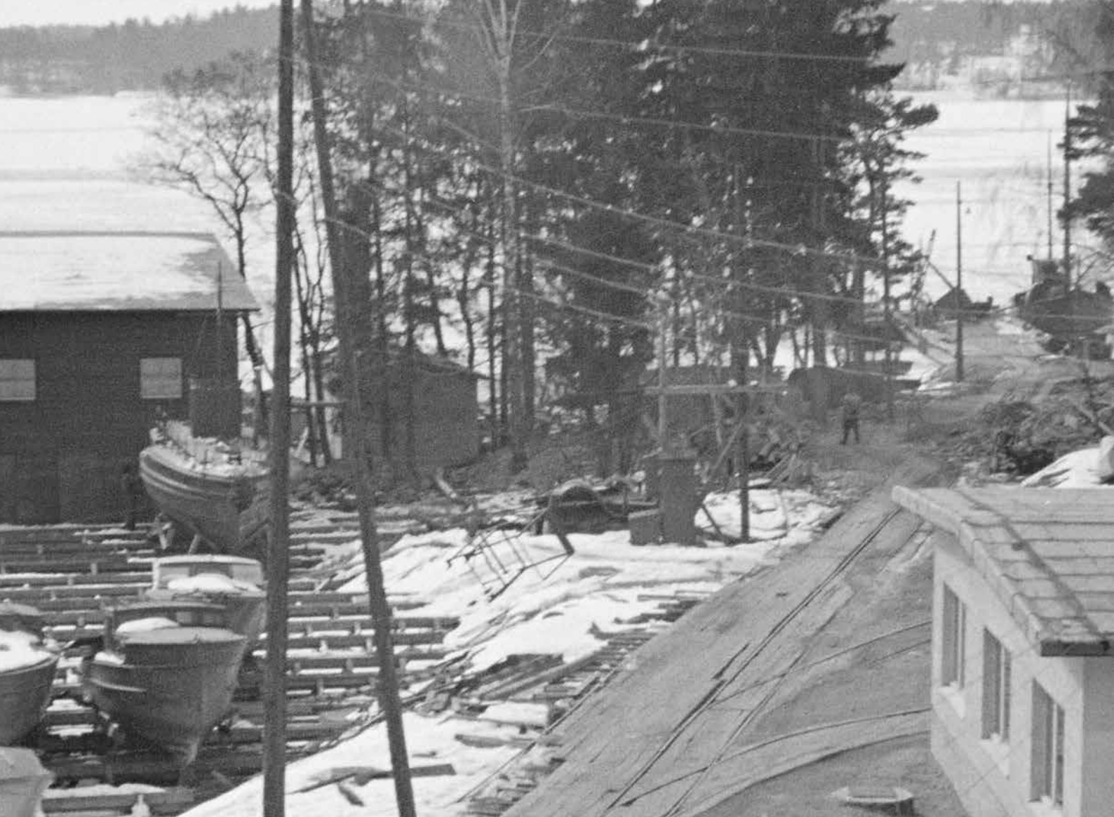
Pannuhuone 74 ja sen alkuperäinen korkea piippu näkyvät puitten siimeksessä moottoritorpedonevaja 73:n oikealla puolella keväällä 1944. SA-kuva
