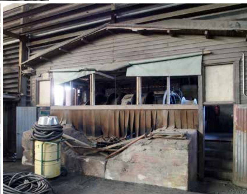
Yllä ja alla: Eteläsivulla on betoninen vaijeriperusta.
