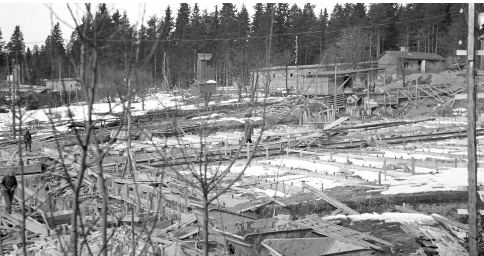
Yllä oik.: Laivatelakka rakennettiin Rantalan tilan maille. Alueelta täytyi kaivaa pois runsaasti entistä peltomaata. Taustalla oikealla näkyy sauna- ja puuvajarakennus n:o 64. SA-kuva
