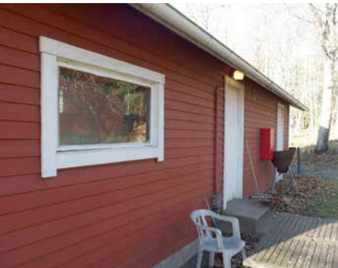
Ulkohuoneen 64 uusittua julkisivua.
