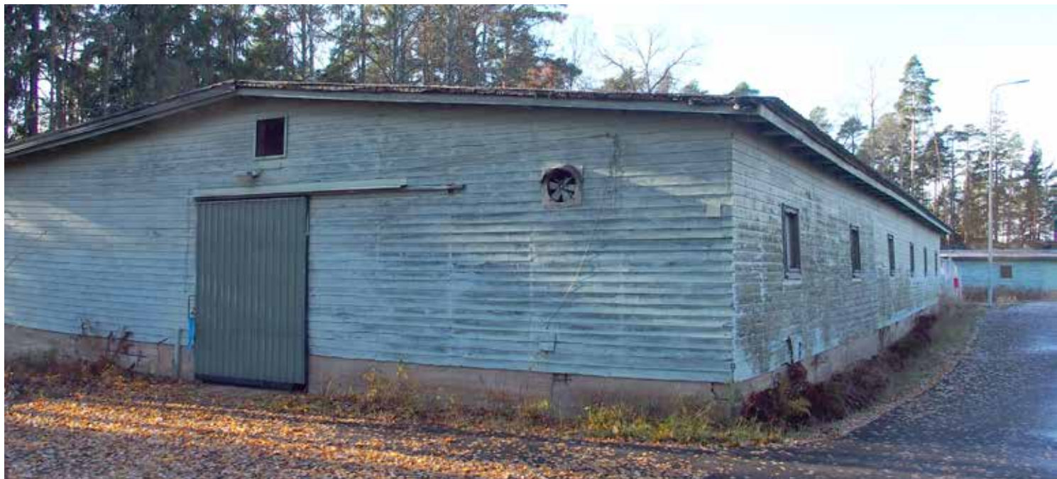
Alla ja oik.: Varasto 52 ja sen ikkuna-aukko.
