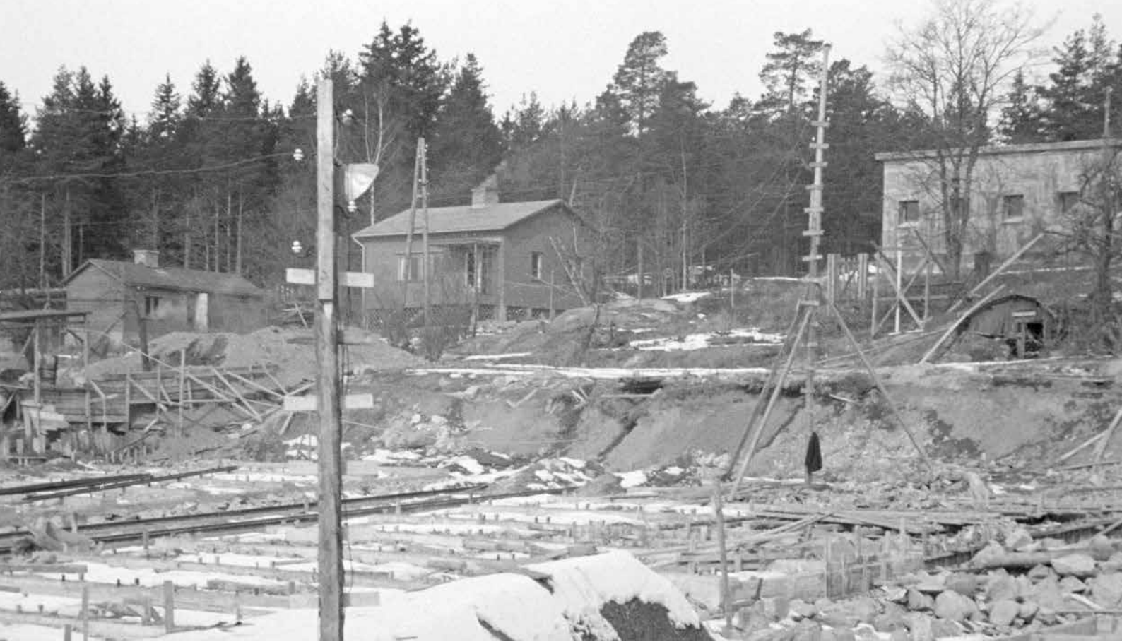
Asuinrakennus 62 (keskellä) ja ulkokuone 64 (vas.) huhtikuun alussa 1944 otetussa kuvassa. Nallikel-lari 55 on kuvan oikeassa laidassa ja sen edessä romahtamispisteessä ollut Rantalan tilan vanha maakellari. Etualalla valetaan 800 tonnin nostote-lakan betoniperustuksia. Telakka-alue tasoitettiin Rantalan päärakennuksen ja pellon paikalle maata poistamalla ja osin louhimalla. SA-kuva
