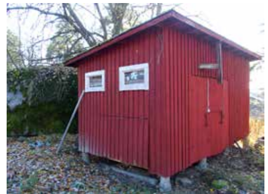
Ulkokäymälä varaston 50 luona.
