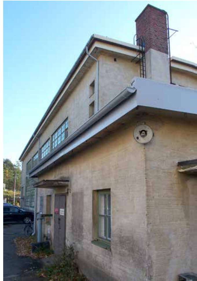
Tykkipajan pohjoissivu. Etualalla pannuhuonesiipi.
