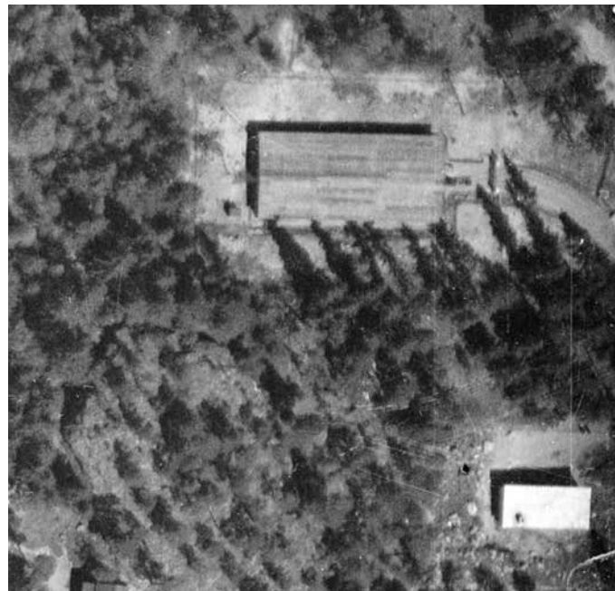
Yllä: Osa toukokuussa 1941 otetusta ilmakuvasta, jossa ylhäällä piikkilanka-aidalla ympäröity varasto 52 ja alakulmassa varasto 51. IVKK
