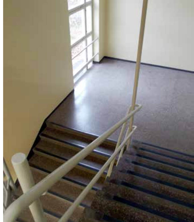
Kasarmin pääporrashuoneen mosaiikkibetoniportaat. Seinien ja kaiteiden alkuperäiset värisävyt on palautettu vuoden 2018 peruskorjauksessa.
