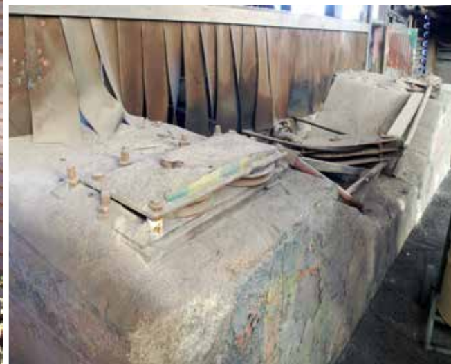
Yllä ja alla: Eteläsivulla on betoninen vaijeriperusta.
