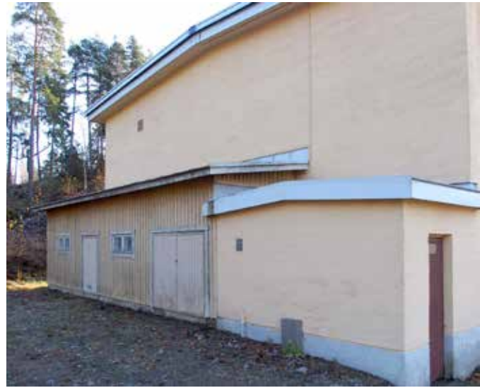
Takomon pohjoispääty ja ilmeisesti 1944 rakennettu puinen laajennus.
