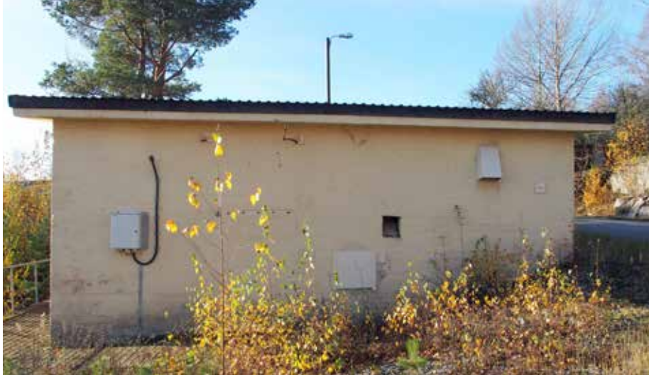
Yllä ja vas.: Vintturi- tai konehuoneen seinät ja katto ovat teräsbetonia. Eteläisivulla on jäljellä alkupe- räinen harmaa teräsovi ja teräksisen ikkunaluukun kiinnikkeet. Nosturiradan puolella on puinen silta, joka on reunustettu metallikaiteella.
