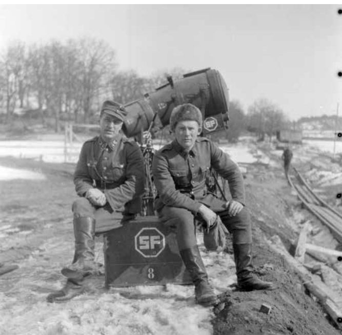
Vas.: Pansion rakennustöitä kuvanneen filmiryhmän jäsenet sotilasvirkamies (Aarne?) Kajonterä ja kersantti Kosunen. Laivatelakalta poistettu maa-aines kuljetettiin kuvan oikeassa reunassa näkyvällä kenttäradalla taustalla olevalle Tammimäen tilan ja Kirpun luodon väliselle alueelle. SA-kuva
