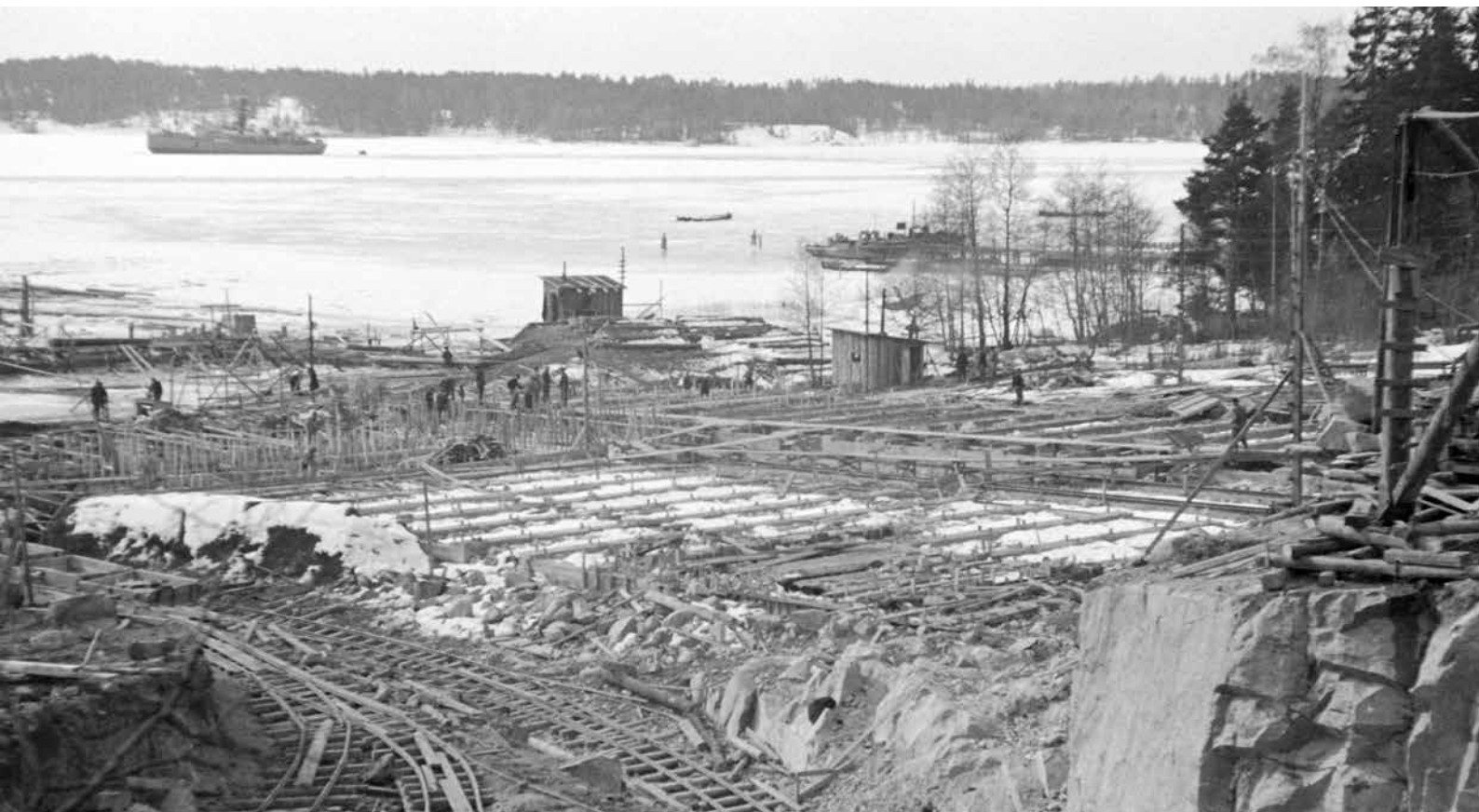
Laivatelakan työmaa huhtikuussa 1944. Taustalla telakan sivullevetoratojen betonivalutöitä. SA-kuva
