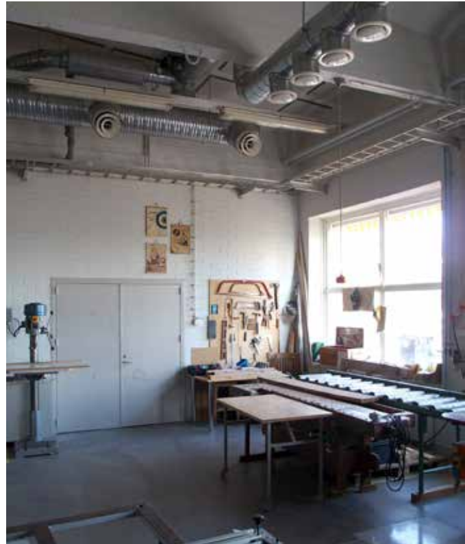
Entisen moottorikorjaamon eteläpääty. Ikkunan kohdalla oli ennen oviaukko ja moottorien pesuhuone.
