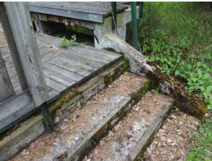
Vas.: ja alla: Aliupseerikerhon kirjaston terrassin alkuperäiset betonipinnat pilkistävät myö- hempien puurakenteiden alta.
