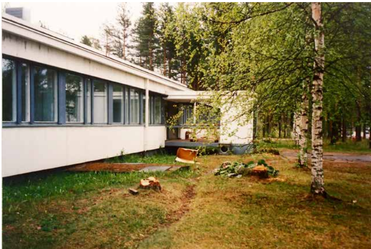
Arkistokuva varuskuntasairaalaista ennen 1990-luvun puolivälin peruskorjausta. Alun perin rakennuksen julkisivussa oli valkoinen mineriitti. Ikkunoiden puitteet olivat siniset. PHRAKL.
