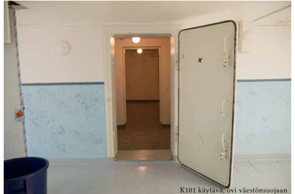
K101 käytävä, ovi väestönsuojaan
