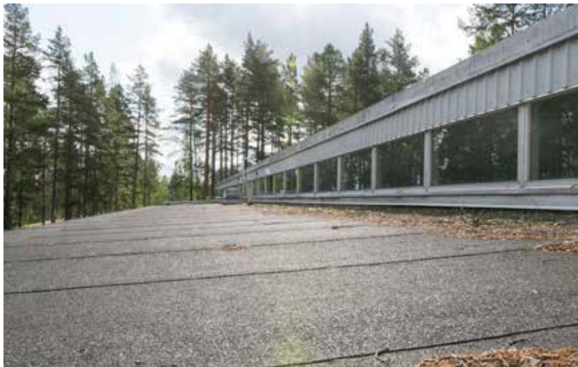
Nostetun keskiosan nauhaikkunat nousevat rakennusmassan yläpuolelle. Rakennuksen katemateriaali on mustaa bitumikermiä.
