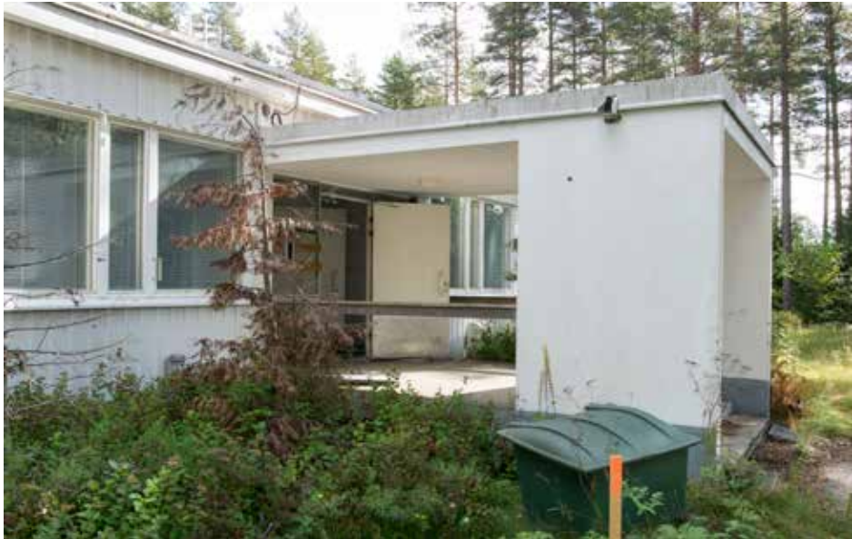
Pääsisäänkäynnin betoninen katos on arkkitehtonisesti tärkeä aihe.
