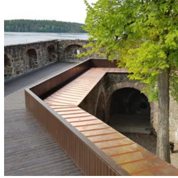
4 Vesiportin bastioni, rak. 1790-l Venäläinen aika 1743-
