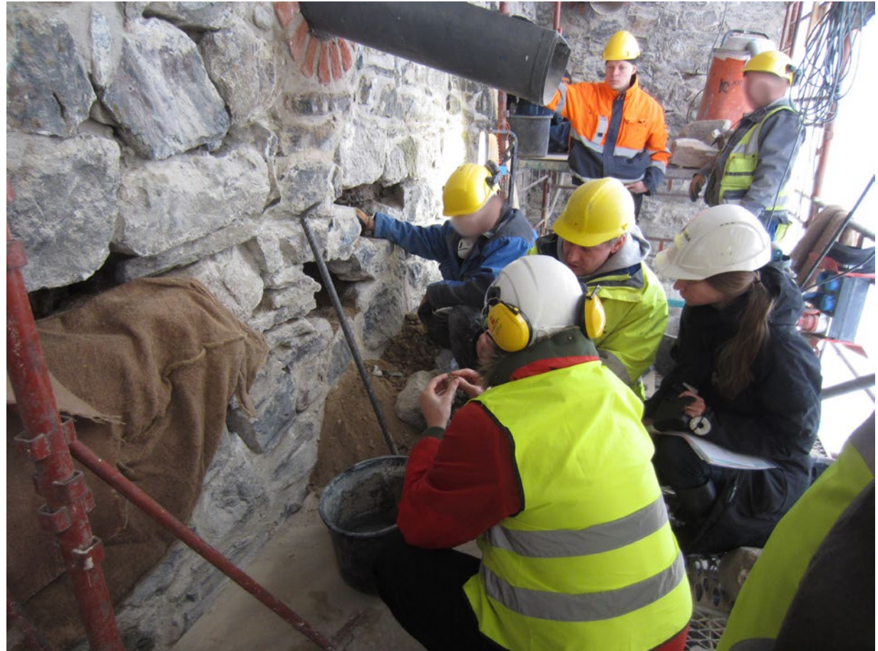
Muurinkorjausurakoitsija Jari Kaseva, Museoviraston arkkitehdit Selja Flink ja Johanna Nordman tutkivat vesiportin bastionin vasemman kyljen muurinkorjaukskohdetta. Tuija Väli-Toralala 2014, Kivityö Kaseva.
