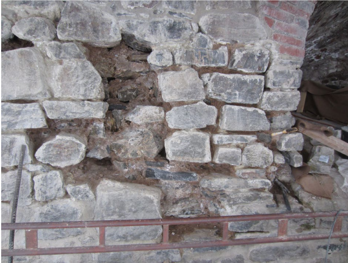
Vesiportin bastionin avattua ulkomuuria. Tuija Väli-Torala 2014, Kivityö Kaseva.
