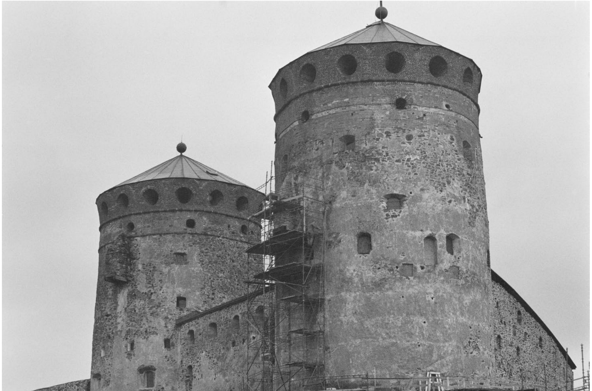
Kirkkotornin privetin muurin korjauksia varten pystytetyt rakennustelineet. Matti Laamanen 1989, Museovirasto RH00L104474.
