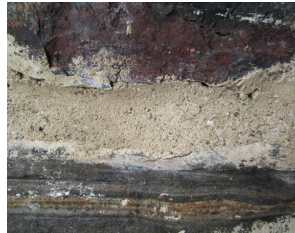
Vasemmalla on Olavinlinnan Vesiportin bastionin 1700-luvun lopulla muurattua tiiliholvia. Oikealla Vesiportin bastionin kivimuuria on korjattu ns. kylmien ulkomuurien laastilla. Tuija Väli-Torala 2017, Kivityö Kaseva Oy.
