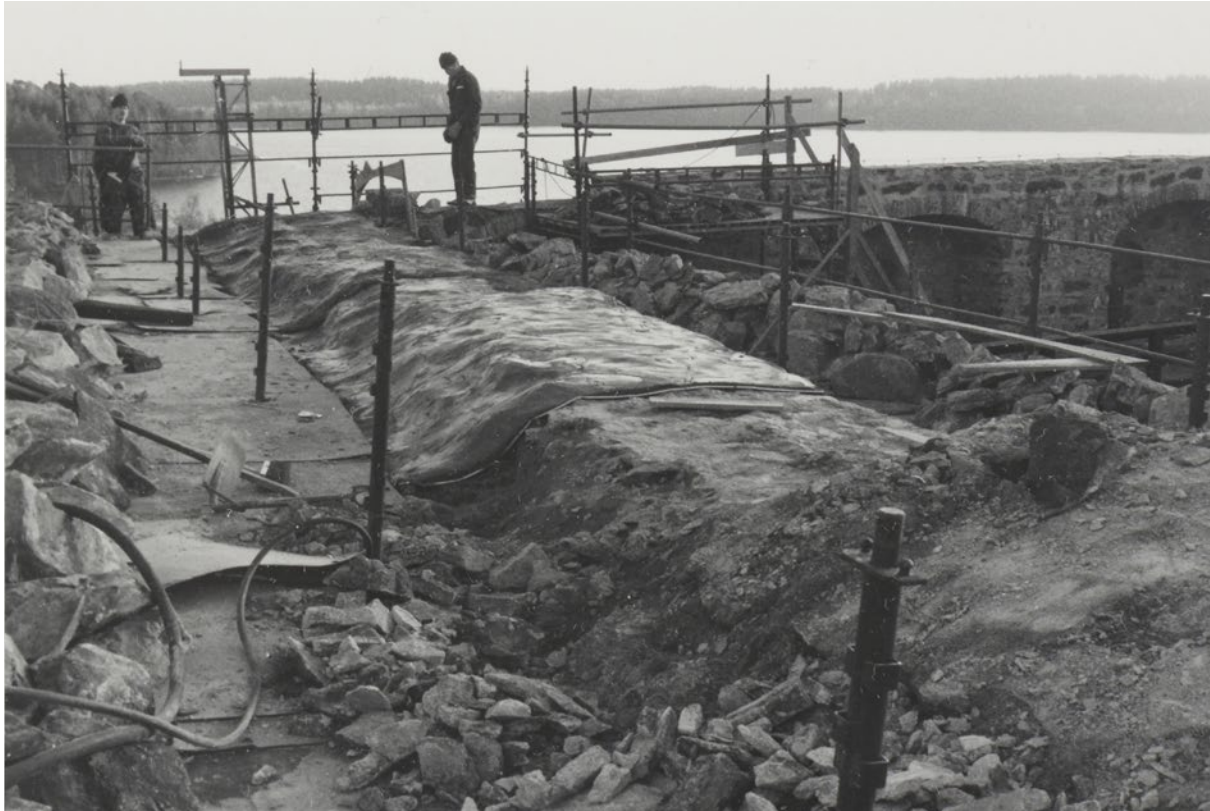
Paksun bastionin muurinharjojen korjaus on käynnissä vuonna 1988. Heikki Ahtiainen, Museovirasto RH091774.
