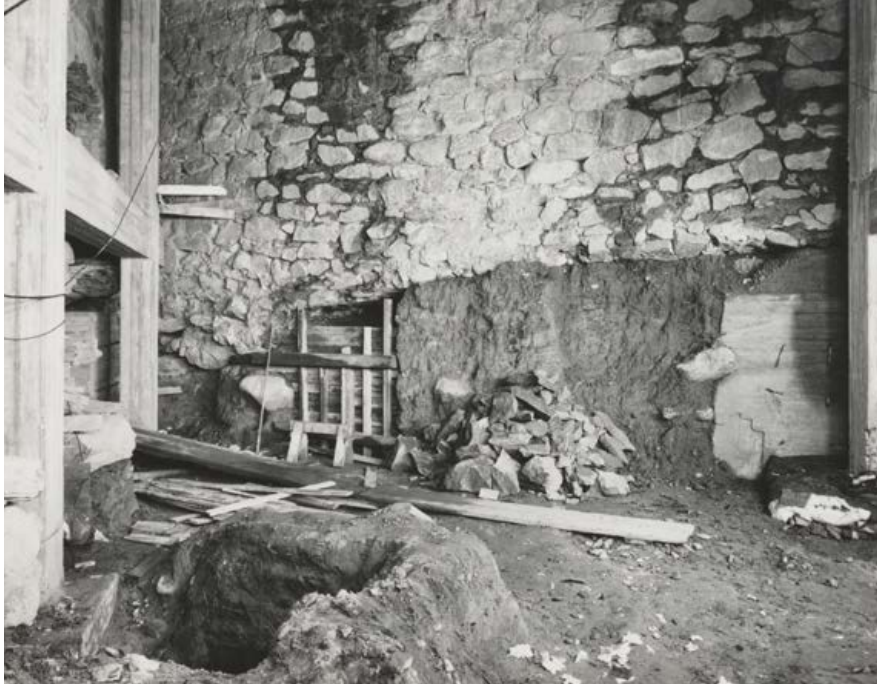
Eteläpatteri N 101 ja N 102, länsiseinän alle tehtyjä betoniperustuksia. Kuvan etualalla on hirsikehikko. P. O. Welin 1965, Museovirasto RHOOL1068.
