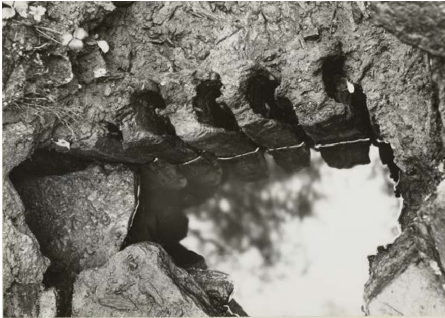
Vesikanavan alkuperäiset reunapaalut kaivettiin esiin. P. O. Welin 1972, Museovirasto RH00L3256.
