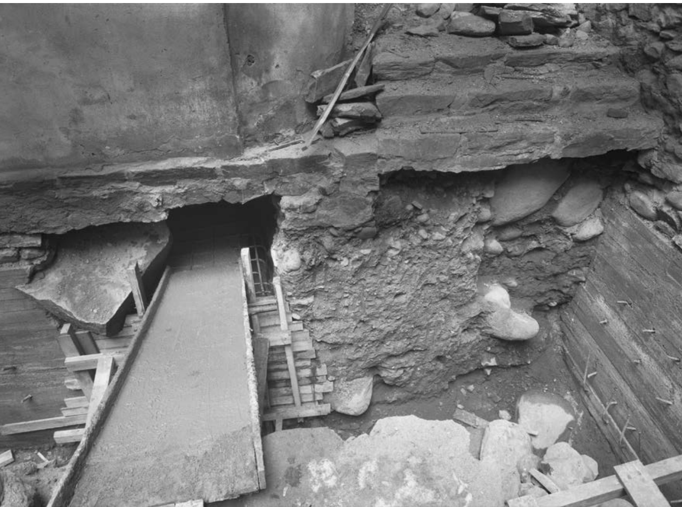
Adjutantin rakennuksen itäpään anturoiden valaminen. P. O. Welin 1964, Museovirasto RH00L759.
