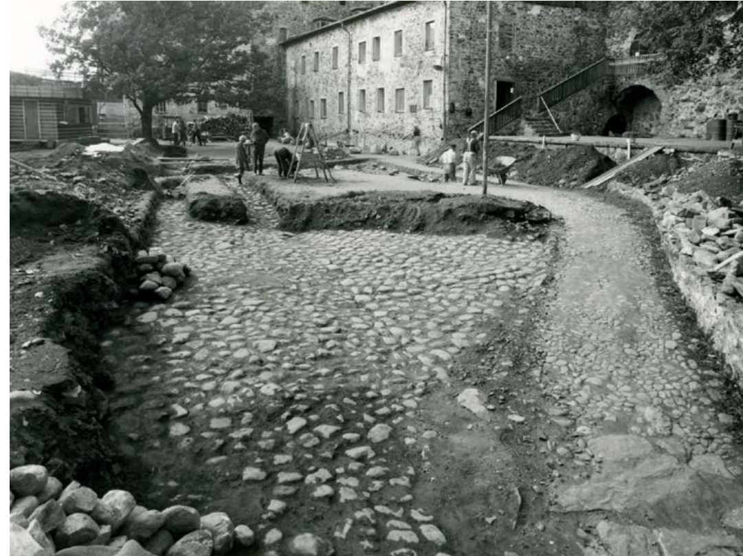
Esilinnan pihan itäosa, kivetty pihataso on osittain kaivettu esille. P. O. Welin 1965, Museovirasto RHOOL1077.
