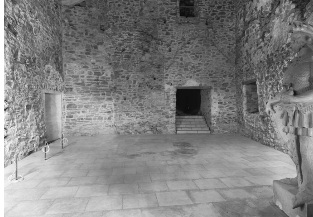
Keskushallin lattian kalkkikivilaatoitus valmiina. P. O. Welin 1971, Museovirasto RHOOL2656.
