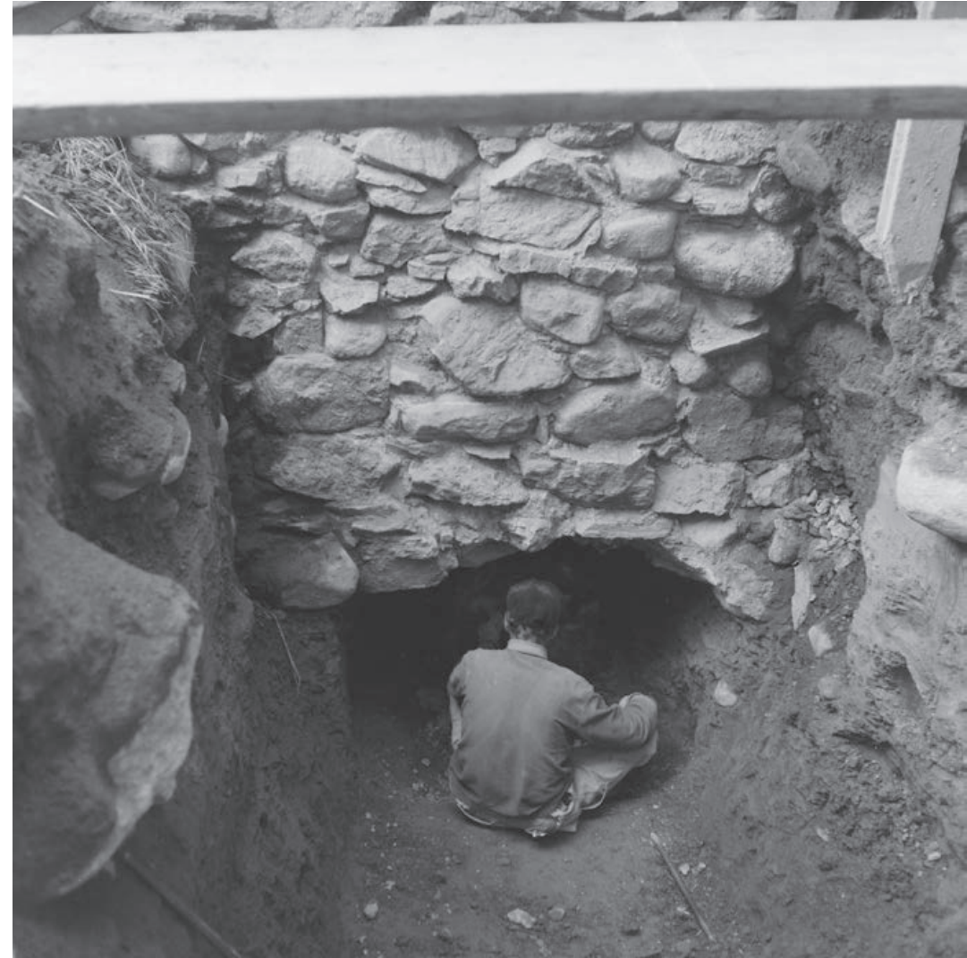
Kansliarakennuksen pohjoisseinän lämpökanavaikavanto portaiden itäpuolella. Museovirasto RHOOL1614.
