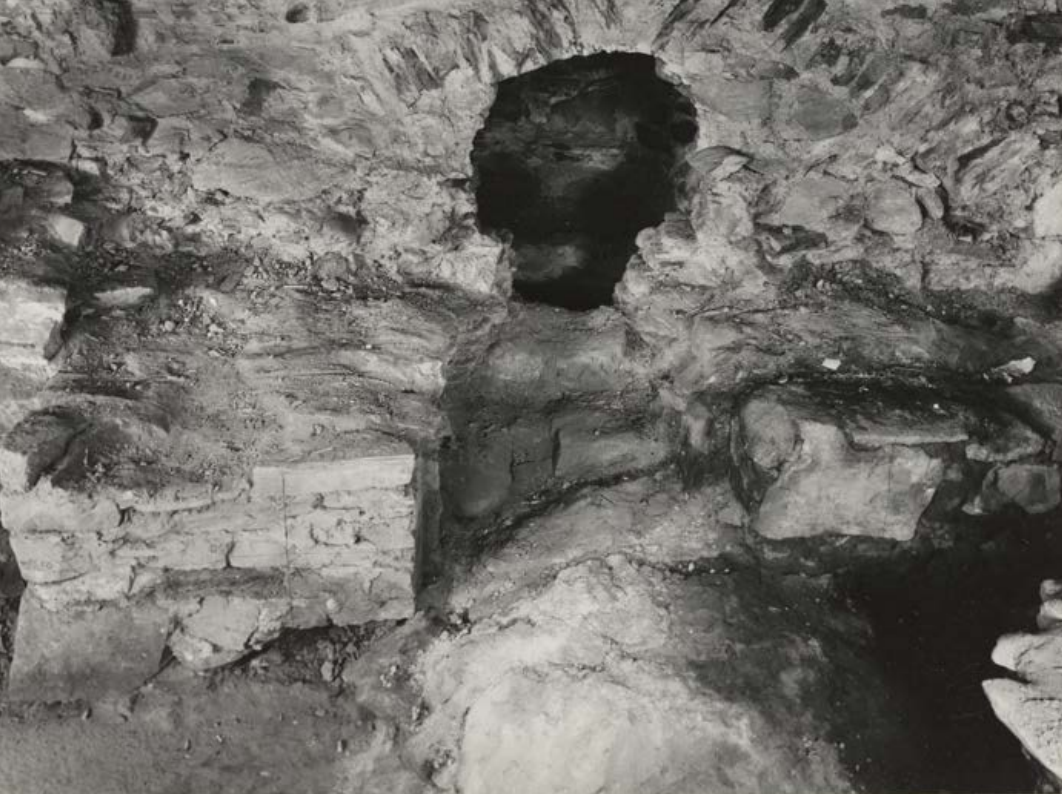
Pohjoisseinän itäosan tykkikomero oli muurattu umpeen. Museovirasto 1969; RHOOL2078.
