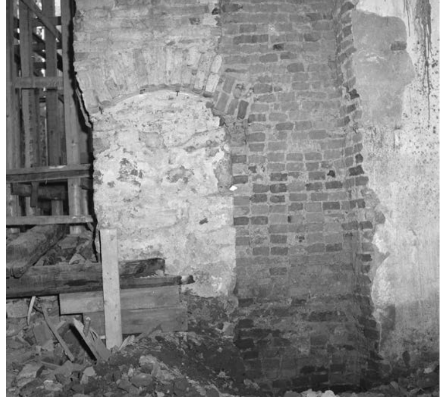
Huoneen H 201 pohjoisseinään lämpöjohtoja varten tehty syvennys. Museovirasto RH00L1939a.
