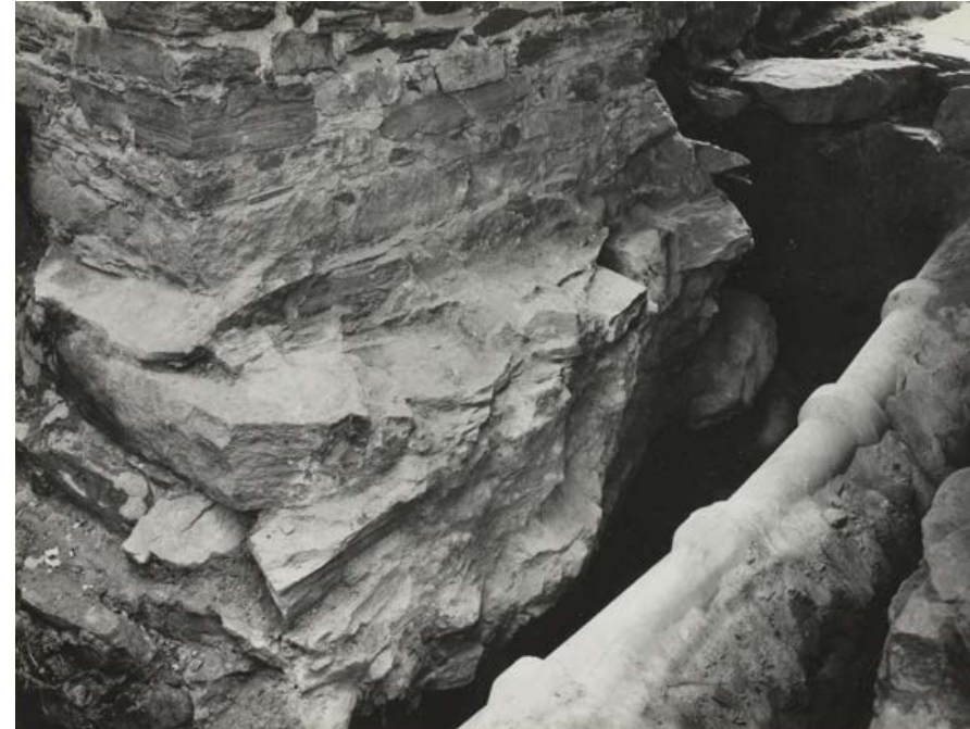
Porttikäytävän K 104 eteläseinän muurianturaa ja sadevesiputkia käytävän itäosassa. P.O. Welin 1968, Museovirasto RHOOL1788.
