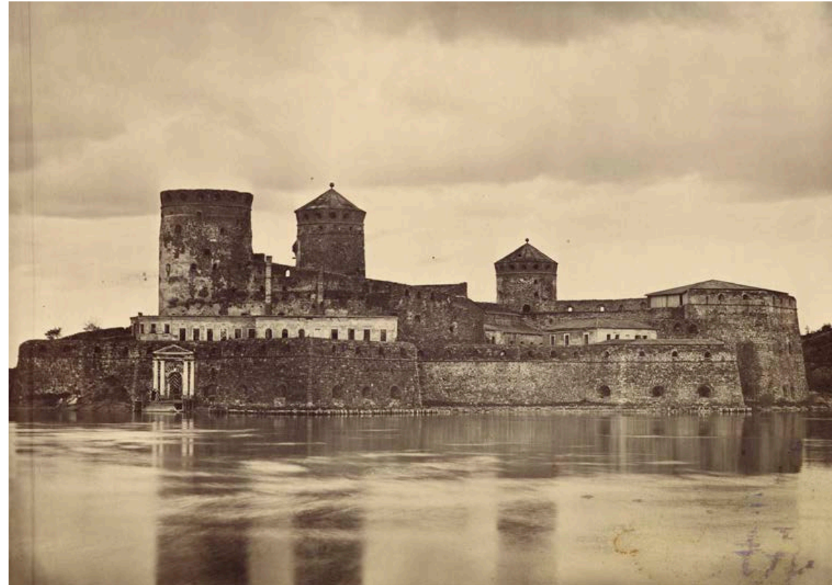
Olavinlinnan etelärantaa ennen rantamuurin rakentamista. Vesiportin bastionin ja Pikkuportin bastionin edustalla näkyy paalurivistöä. Ne kuuluvat muurien suojaksi asennettuun puuseinämään. M. L. Castren ennen vuotta 1872, Museovirasto HK10000:2466.
