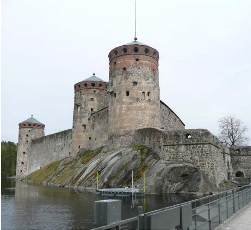
Kellobastioni ja siihen yhdistyvä pohjoismuuri on perustettu kallion päälle. Hanna Lyytinen 19.5.2009, Arkkitehtitoimisto Hanna Lyytinen Oy.
