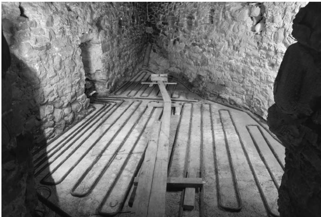
Kellariin T 105 asennettu lattialämmityksen putkisto. P. O. Welin 1971, Museovirasto RH00L3296.
