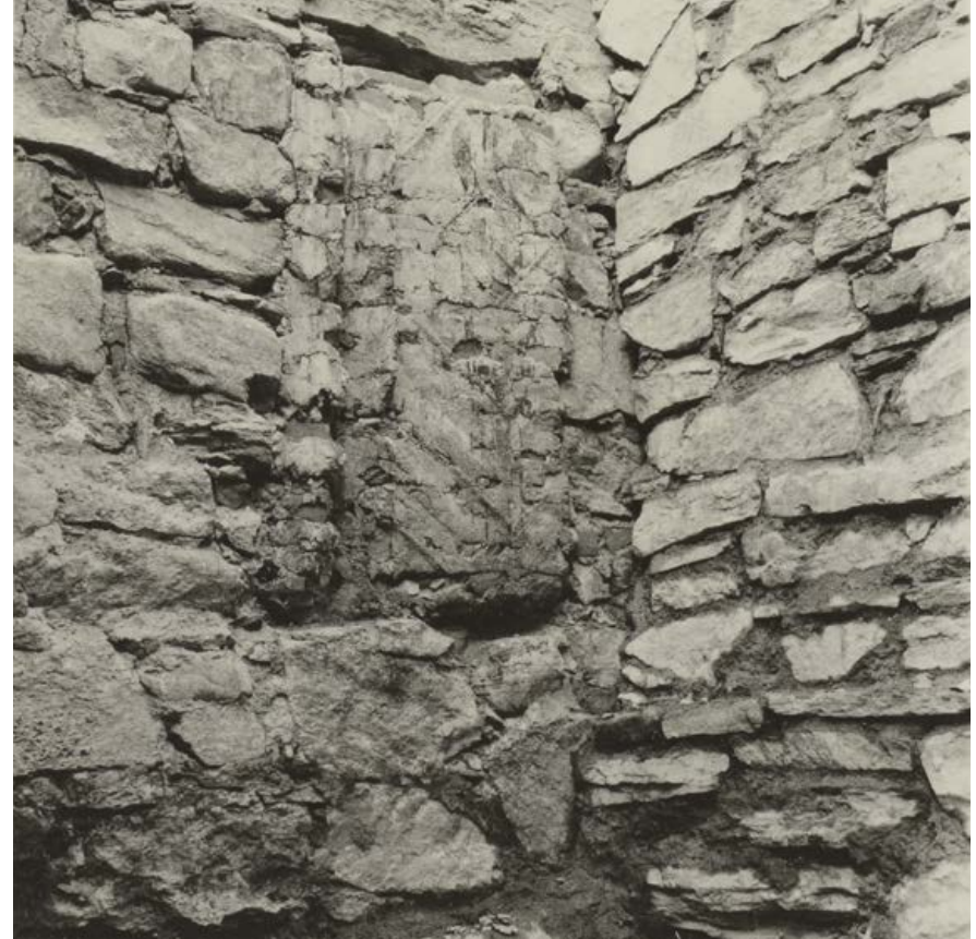
Kellarin N 104 pohjoisseinän umpeen muurattu oviaukko. 1964, Museovirasto RH00L943.
