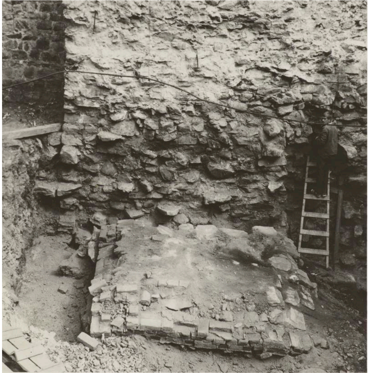
Tiilirakenne ennen purkamista eteläpatterin länsipuolella. Museovirasto 1964, RH00L949.
