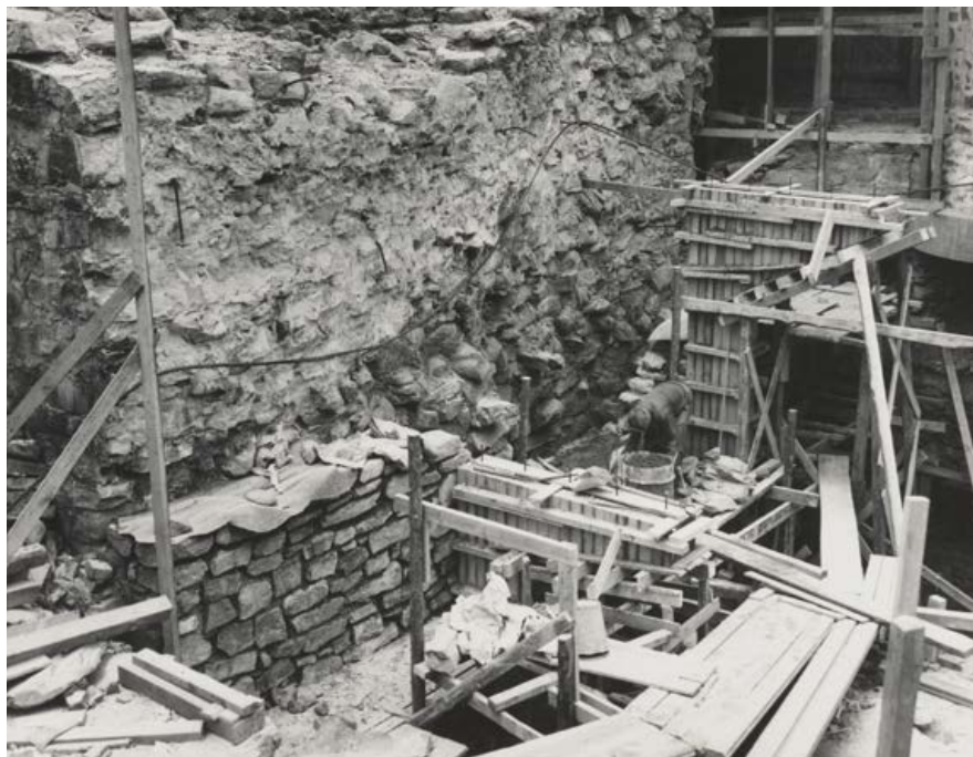
Eteläpatterin länsiseinän verhomuuraus käynnissä. P. O. Welin 1964, Museovirasto RH00L804.
