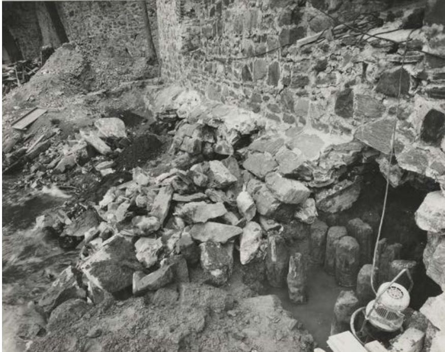
Pikkuportin bastionin oikean siiven anturoiden kaivanto ja perustusten puupaaluja. P. O. Welin 1964, Museovirasto RH00L806.
