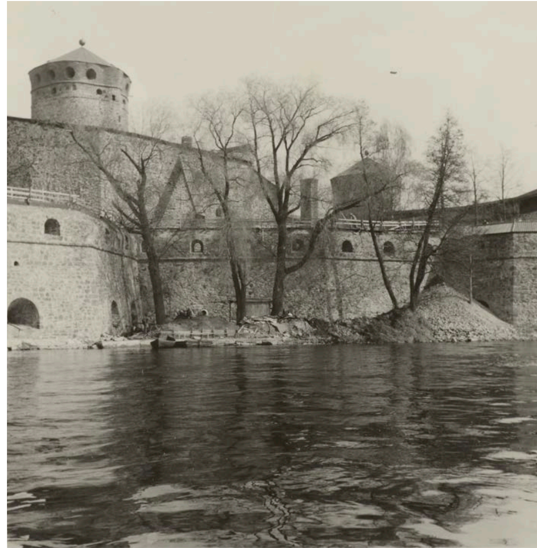
Kurtinimuurin (V) edustalle on kasattu kaivumaita vuonna 1963. Museovirasto RHOOL630.
