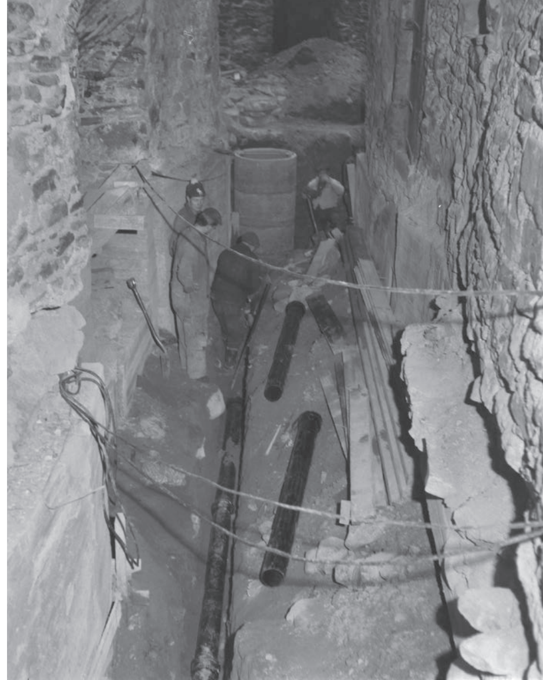
Porttikäytävän E 102 viemäriputkien asennus vuonna 1968. Museovirasto RH00L1882.
