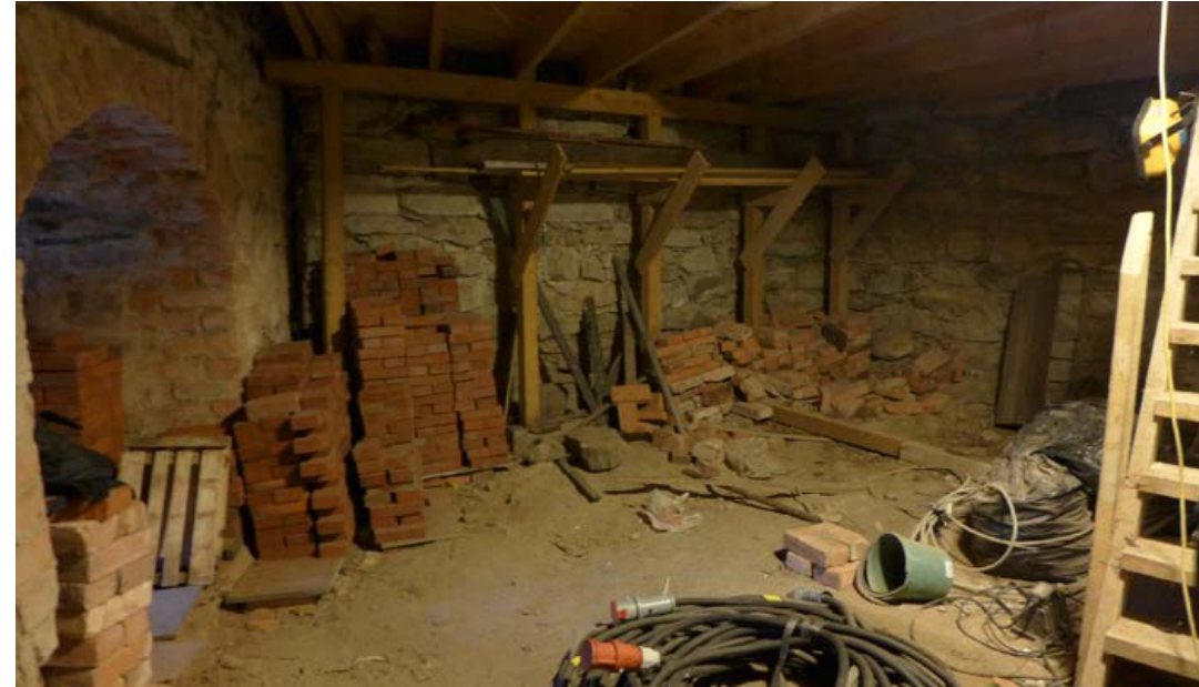
Kuilu K 003 toimii tiilivarastona. Itäseinän ampuma-aukot kuuluvat 1560-luvulla rakennettuun kehämuuriin. Päivi Hakanpää 20.12.2018. Arkkitehtitoimisto Hanna Lyytinen Oy.
