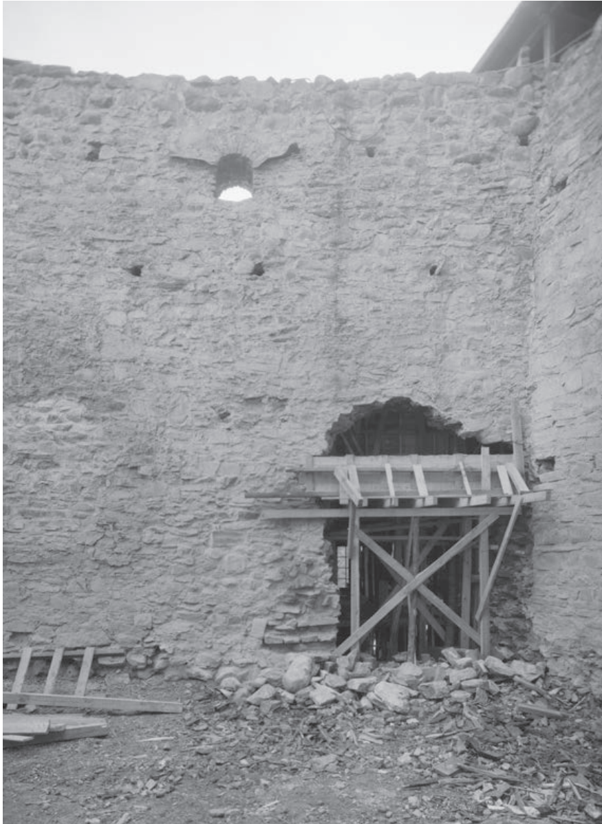
Eteläseinän oviaukko huoneeseen H 201. P. O. Welin 1968, Museovirasto RHOO1703.
