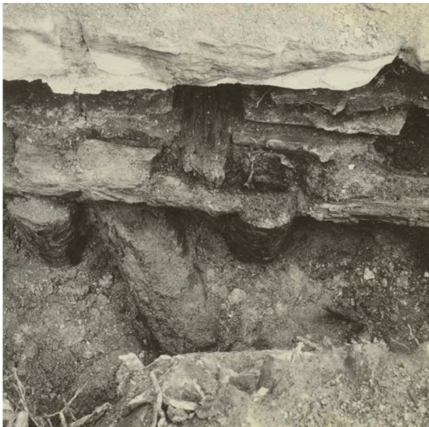
Pikkuportin bastionin muurit oli perustettu hirsiarinan ja puupaalujen varaan. Kuvassa on länsiosan muuria katsottuna itään. 1964, Museovirasto RH00L970.
