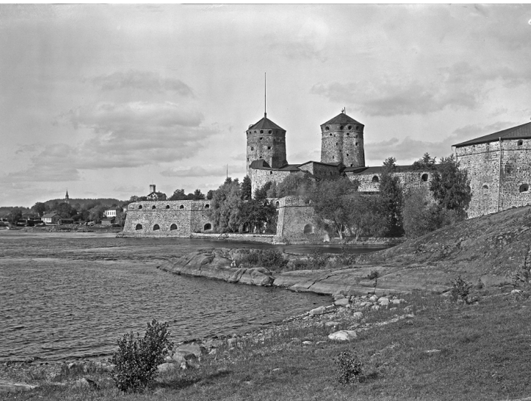
Olavinlinnan etelärantaa rantamuurin rakentamisen jälkeen. M. L. Castren 1908, Museovirasto HK19900208:784.
