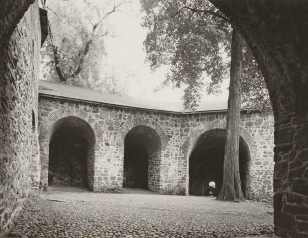
Bastionipiha vuonna 1961 ennen kaivutöiden aloittamista. Museovirasto RH00L207.
