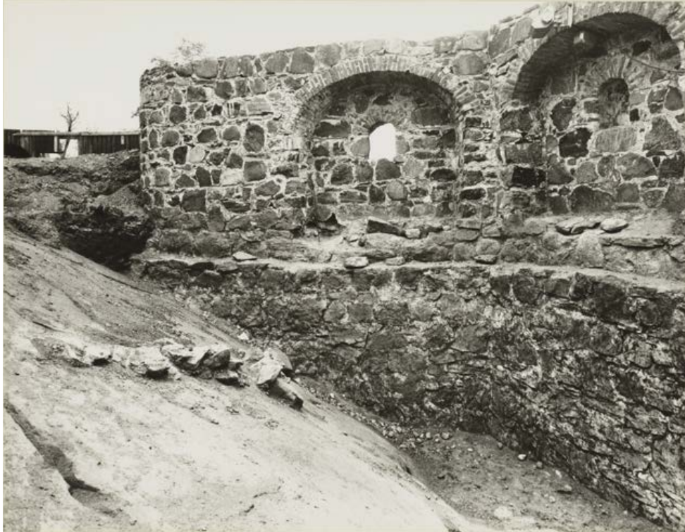
Kellobastioni U 101 tyhjennyskaivauksen jälkeen, katsottuna pohjoisesta. P. O. Welin 1973, Museovirasto RH00L3682.
