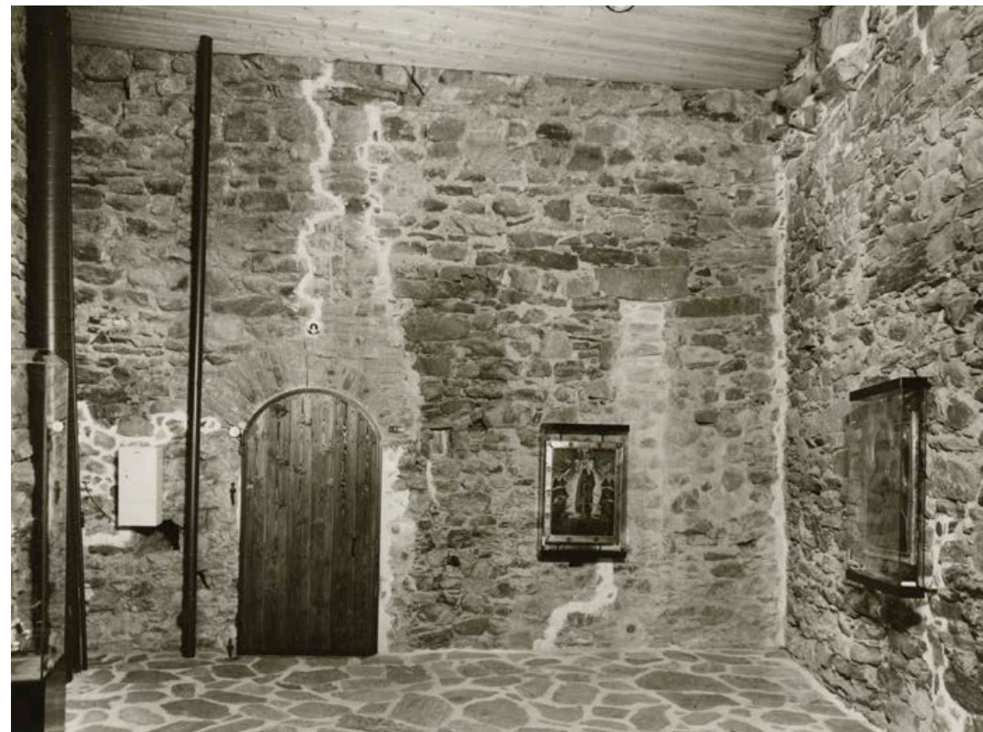
Restaurointitöiden jälkeen kellariin T 101 ja T 105 perustettiin ortodoksimuseo. P. O. Welin 1975, Museovirasto RHO102418.
