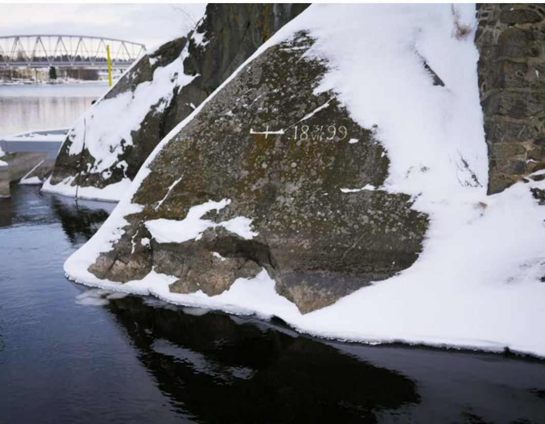
Linnan luoteiskulmaan, Kellobastionin alapuolelle kalliioon on merkitty vedenpinnan korkeus suurtulvan jälkeen 31.7.1899. Hanna Lyytinen 24.2.2017, Arkkitehtitoimisto Hanna Lyytinen Oy.
