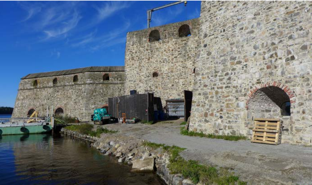
Etelärannan jäteasemaa sekä oopperan suihku- ja sosiaalityöjä ympäröi suoja-aita. Päivi Hakanpää 6.9.2016, Arkkitehtitoimisto Hanna Lyytinen Oy.
