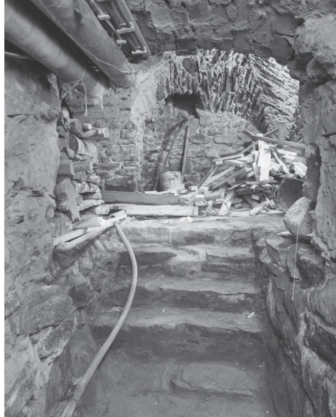
Kellarin itäosan E 101 portaat, jotka johtavat kansliarakennukseen. P. O. Welin 1967, Museovirasto RHOOL1445.
