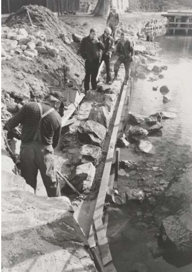
Etelärannan terassimuuria korjattiin vuonna 1985. Museovirasto, RHO79354.
