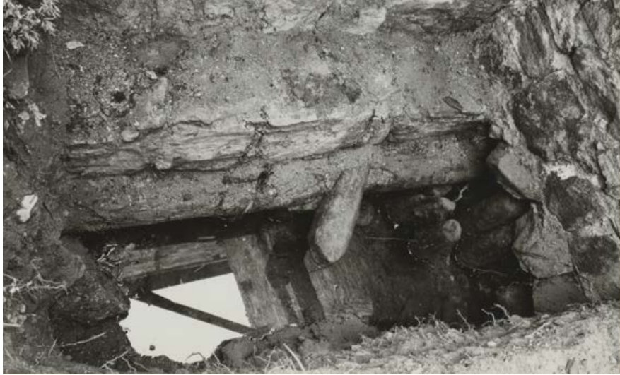
Paksun bastionin vasemman sivun ulkomuurin anturamuuria esille kaivettuna kasematti L 105 kohdalla. Anturamuurin alla oli hirsiperustus ja puupaaluja. 1961, Museovirasto RH00L222.
