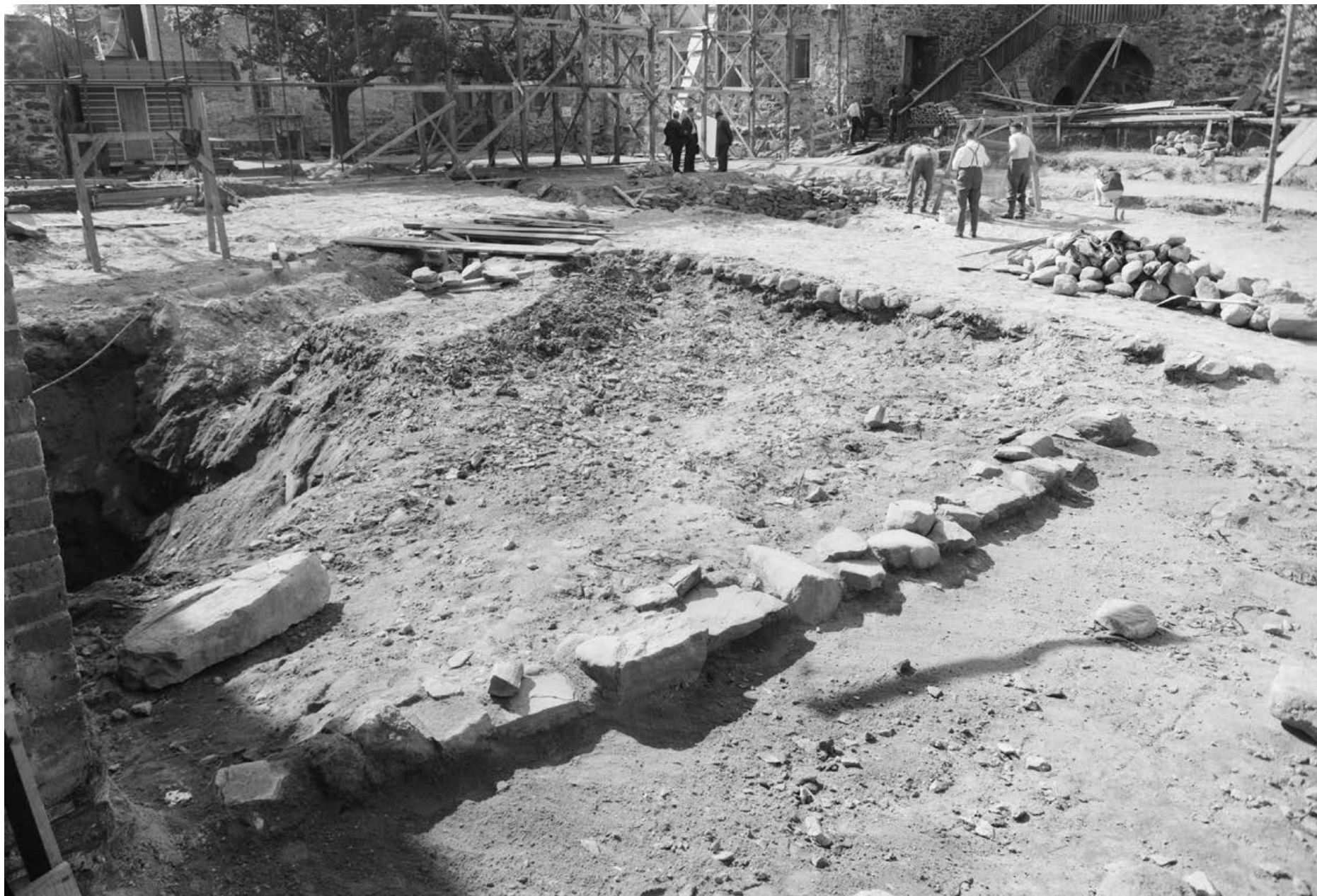
Esilinnan pihan kaakkoisosa, etualalla puurakennuksen perustuksia. P. O. Welin 1966, Museovirasto RH00L1212.
