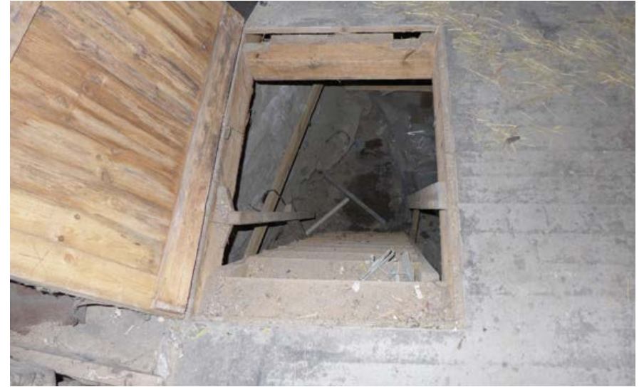
Kuiluun K 001 johtavat puuportaat. Päivi Hakanpää 20.12.2018, Arkkitehtitoimisto Hanna Lyytinen Oy.
