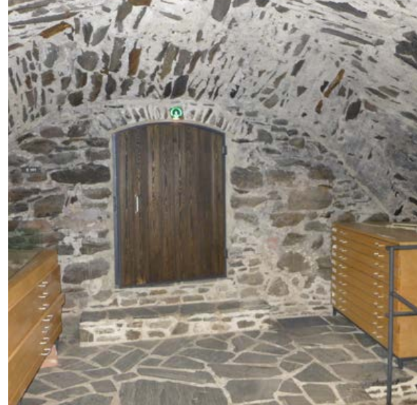
Kellarin E 101 pohjoisosaa. Päivi Hakanpää 2016, Arkkitehtitoimisto Hanna Lyytinen Oy.
