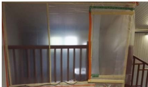
Näkymä ylätasanteen pintamateriaaleista riisuttuun nurkkaukseen. Katossa ja takaseinällä uudehko panelointi. Sivulla panelointi oli vanhempi. Seinillä oli jäänteitä aikaisemmista pintakäsittelyistä..
