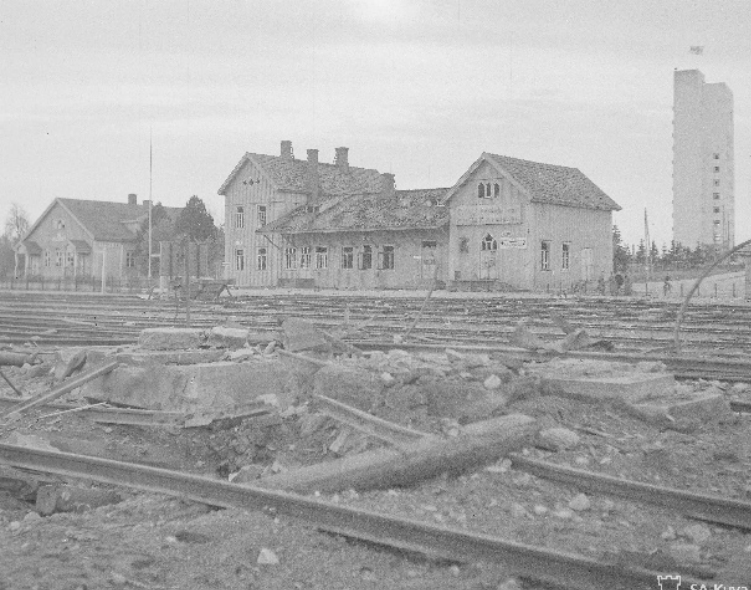
Kemin särkynyt rautatieasema rakennus säilyi rikkoutuneita lukuun ottamatta eheänä. Ratapihalla olevat rautatiekiskot sen sijaan olivat lukuisista paikoin räjäytetyt.
