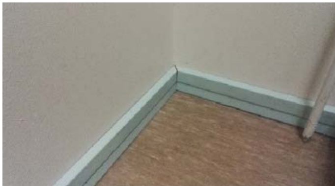
Yläkerran lattialistaa, levyseinää ja muovimattoa. Materiaalit toistuvat yläkerran tiloissa.
