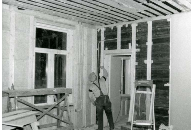
Kuvassa remonttia vuonna 1987. Seinäpinnat ovat riisuttu ennen uusia pintamateriaaleja. Kuva. Rautatiemuseon valokuva-arkisto
