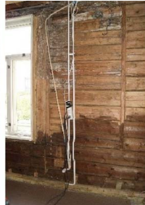
Seinät ovat koolatut, villoitetut ja levytetyt. Pinnat on tarkoin puhdistettu aiemmista pintakäsittelyistä. Levyn alta paljastuneessa hirsipinnassa on pienien paperijäämien lisäksi, havaittavissa aukkomuutos.
