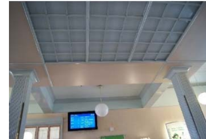
Lasitettu katon keskiosa ja puuristikko sekä oikealla vanhaa paneelikattoa, joka on muuta tilaa korkeammalla.
