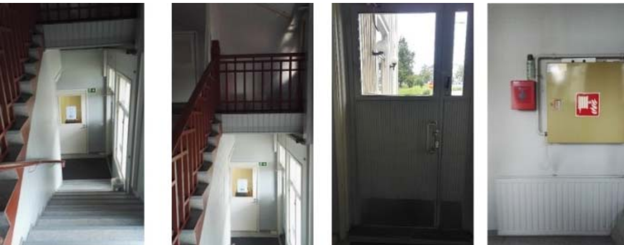
Kuvia porrashuoneesta. Kaide vaikuttaisi olevan edelleen alkuperäinen. Ovissa ja osalla seiä on muutoksia.
