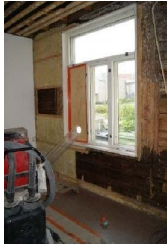
Seinät ovat koolatut, villoitetut ja levytetyt. Pinnat on tarkoin puhdistettu aiemmista pintakäsittelyistä. Levyn alta paljastuneessa hirsipinnassa on pienien paperijäämien lisäksi, havaittavissa aukkomuutos.
