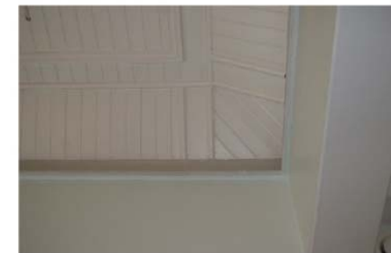
Lasitettu katon keskiosa ja puuristikko sekä oikealla vanhaa paneelikattoa, joka on muuta tilaa korkeammalla.
