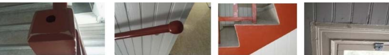
Yksityiskohtia porrashuoneesta. Lattialla on paksu muovimatto ja portaiden reunoja vahvistavat muoviset listat.
