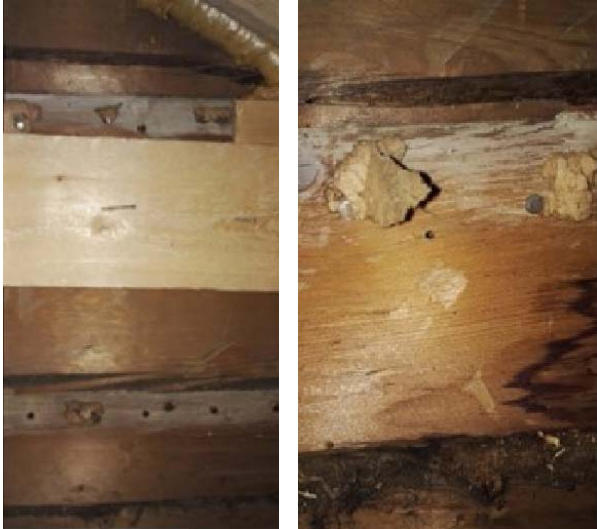
Poistetun paneloinnin alta näkyi maalausrajoja ja jäänteitä paperoinneista.
