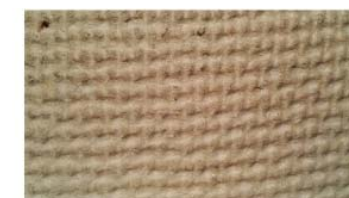
Pingotetun pahvin struktuuria rappusten alla olevassa komerossa.
