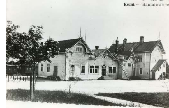
Asema pihan puolelta ennen julkisivu remonttia. Kemin historiallisen museon valokuva-arkisto.
