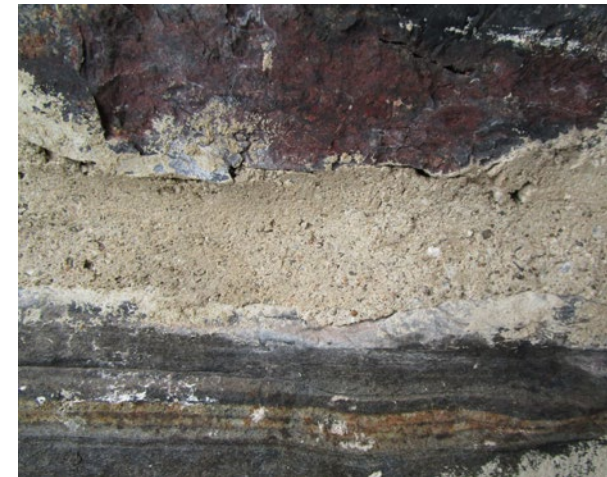
Vasemmallalla on Olavinlinnan Vesiportin bastionin 1700-luvun lopulla muurattua tiiliholvia. Oikealla Vesiportin bastionin kivimuuria on korjattu ns. kylmien ulkomuurien laastilla. Tuija Väli-Torala 2017, Kivityö Kaseva Oy.
