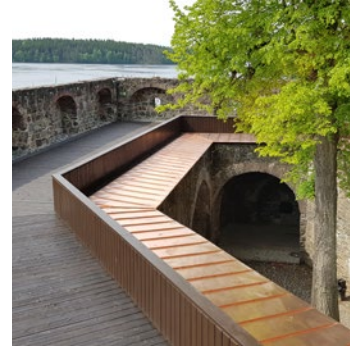
4 Vesiportin bastioni, rak. 1790-l Venäläinen aika 1743-
