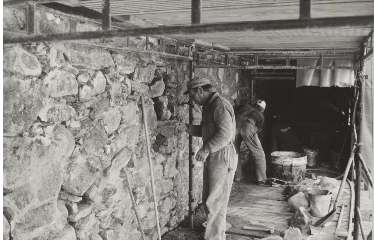
Esilinnan pohjoissiiven ulkomuurin pintavaurioiden korjausta. Heikki Ahtiainen 1986, Museovirasto RH00L92105.
