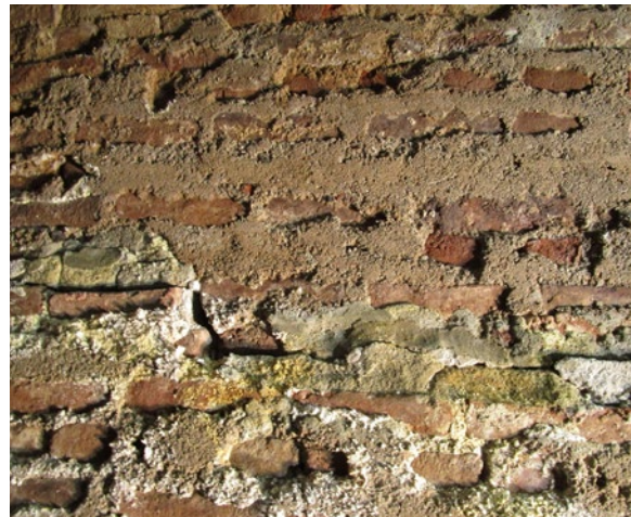
Vasemmallalla on Olavinlinnan Vesiportin bastionin 1700-luvun lopulla muurattua tiiliholvia. Oikealla Vesiportin bastionin kivimuuria on korjattu ns. kylmien ulkomuurien laastilla. Tuija Väli-Torala 2017, Kivityö Kaseva Oy.
