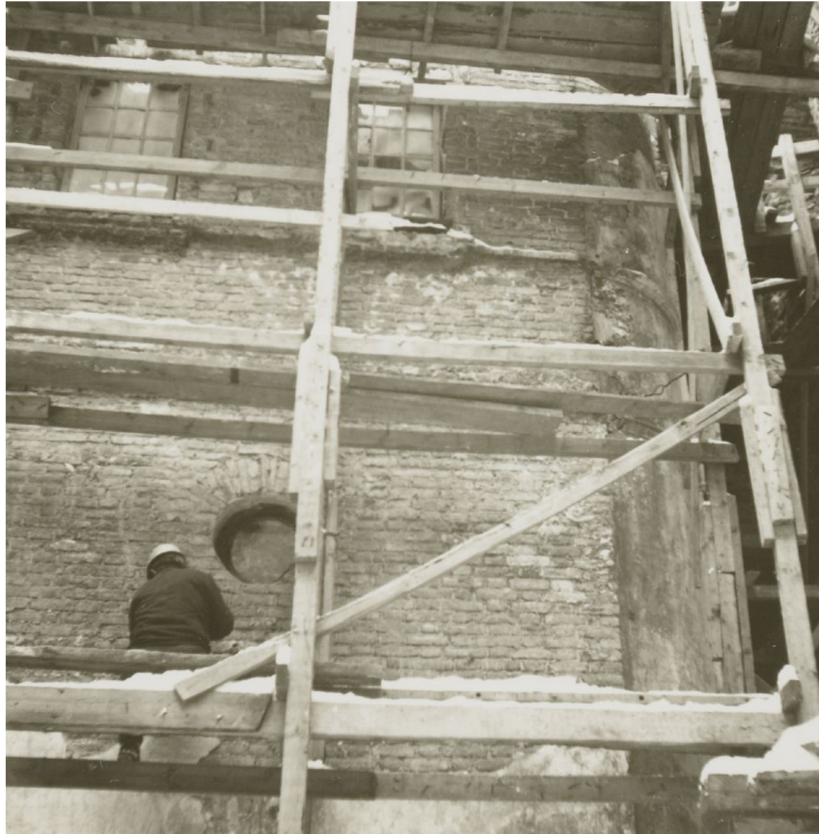
Adjutantin rakennuksen alkuperäiset rappaukset poistettiin vuonna 1970. Museovirasto RH00L2491.
