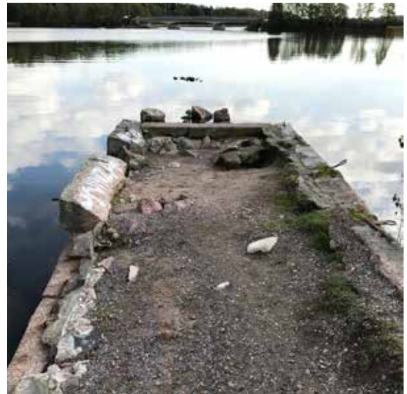
↑ Laiturin kivirakenteisen osan pinta on soraa ja sen alla on lohkokivien ja hiekan täyttö. Osa täytöstä on valunut pois kun reunakiviä on sortunut veteen. Reunakiviin on lisätty eri vaiheissa metallitappeja ja -lenkkejä, betonia ja niitä on töhritty. Laiturin kivirakenteisen osan päähän on valettu betonipalkki.
