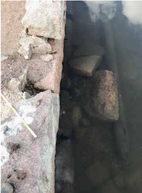
↑ Kiviharkkorakenteisen laiturin vedenpuoleisen osan alimmat harkot ovat muuta seinälinjaa ulompana ja muodostavat anturamaisen alustan ylemmille harkoille. Harkkojen väliin on myöhemmässä vaiheessa laitettu betonia ja niihin on porattu metallikiinnikkeitä. Laiturin vieressä makaa laiturilepuuttajina käytettyjä hirsä, betonilaattoja ja rakenteesta pois vierähtäneitä kiviharkkoja.
