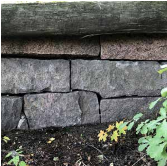
↑ Laiturin luoteispäässä ylin kivikerta poikkeaa kivimateriaaliltaan alemmista ja on todennäköisesti uusittu. Kiviharkot on muotoiltu sopimaan toisiinsa.
