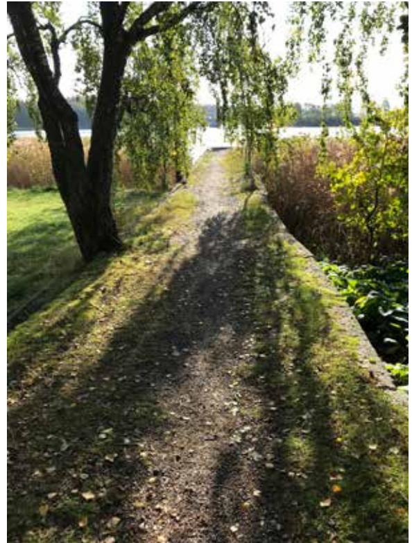
↑ Huomattava osa veden yläpuolisista laituri-rakenteista on kuivalla maalla, sillä rantaviiva on siirtynyt täyttömaan myötä.
