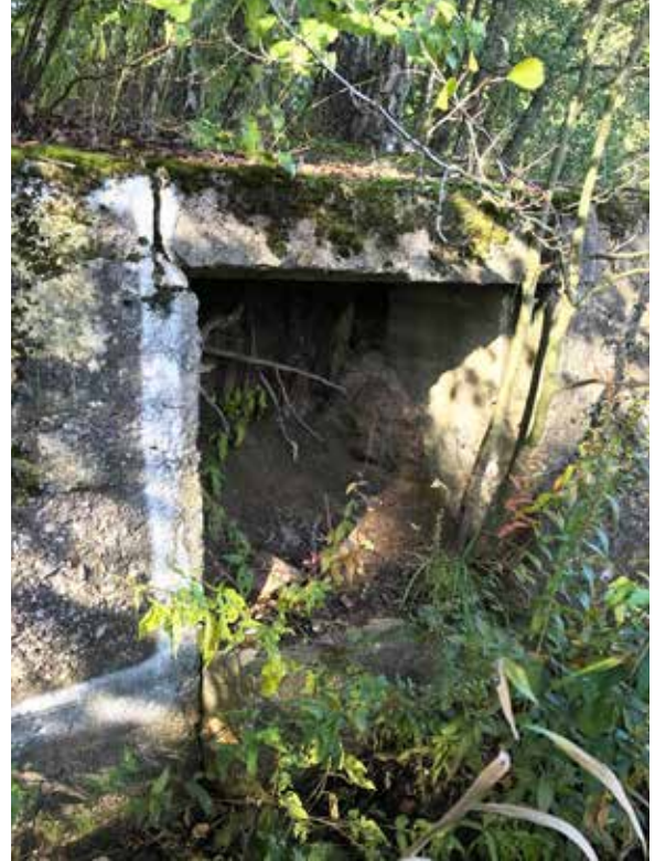
→ Betonirakenteen itäpäässä on noin 1,6 m korkeassa seinässä komeromainen syvennys.
