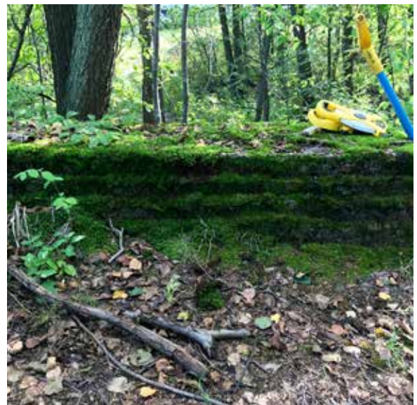
← Betoniseinässä näkyy ulkopuolella muottilauδοitus ja ulos työntyviä raudoituksia.
