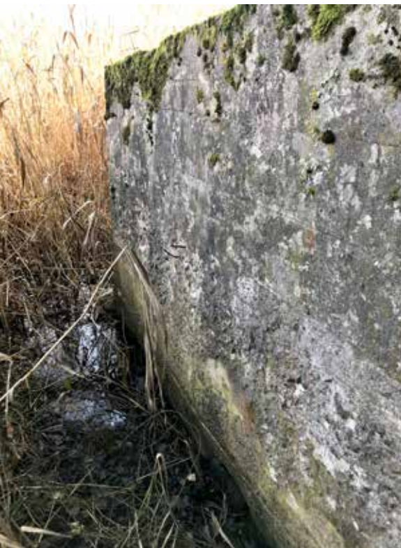
← Betoniseinässä näkyy ulkopuolella muottilauδοitus ja ulos työntyviä raudoituksia.
