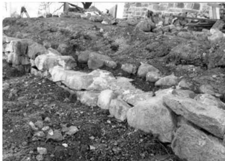
Läntisen ulkovarustuksen muurin korjaus käynnissä keväällä 1993. Valokuvat Lee- na Venhe, MV, k338/14 (ylempi kuva) ja k338/16 (alempi kuva).
