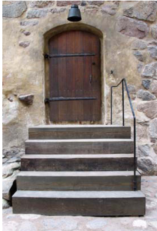
Nunnakäytävän uudelleen rakennettu porras ja uusi rautakaide. Merja Nieminen 2016.
