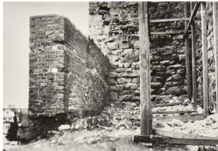
Vankilarakennuksesta jäljellä ollut, osittain 1907 uudelleen muurattu tiiliseinän osa purettiin vuonna 1951. MV, kesäkuu 1951, RHOTL1305.
