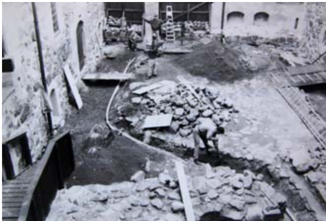
Päälinnan pihan poikkimuurin perustus moreenin päällä ja uusi sadevesikaivo 1992. Kuva no 10, Leena Venhe, MV.
