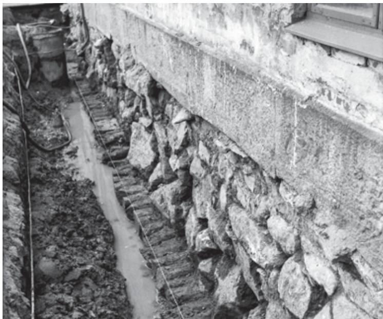
Eteläsiiven pohjoisseinän muurin alla hirsipeti esiin kaivettuna ennen paalutusta 1974. Marggareta Willner 1974. MV, RHOTL2487.
