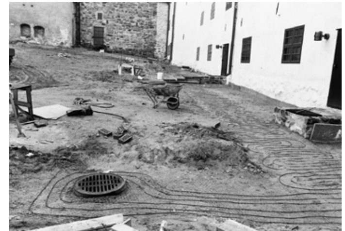
Lämmityskaapelointi asennettuna pihan pohjoispuolella. Kaapelointi ei tietävästi ollut käytössä, ja osa kaapeloinnista purettiin vuonna 2016 tehtyjen sadevesiputkien korjausten yhteydessä. P. Kujanpää 1987. TMK, KF912793.
