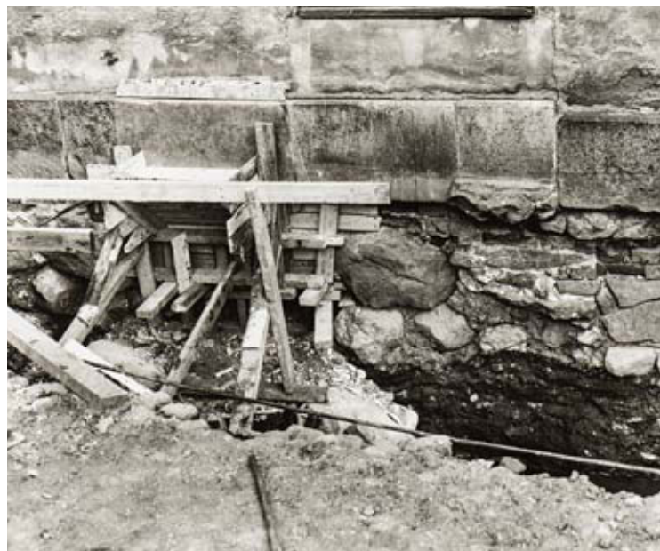
Vasemmalla Vanhaa pihatasoa kaivauksen alkaessa pohjoissiiven porrashuoneen (A112) oven vieressä. Ilmo Kajala 1975. MV, RHOTL10000:5.8.69.
