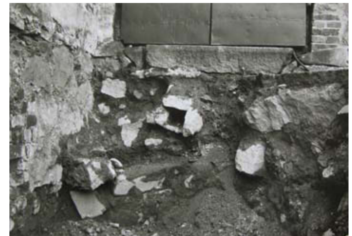
Lounaisnurkasta puretun portaalan alla olevaa vanhaa vinoa kehämuuria ja vanha nelikulmainen sadevedenpoistokanaali. Welin 1974. MV, F2551.
