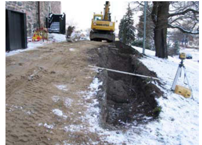
Ylhäällä / Hydraulinen nostin huoltosillan osana. Tasoon lisättiin metallikaide vuonna 2018. Merja Nieminen 2011. Alhaalla / Sadevesiviemärin kaivuu pohjoispuolen ajoväylällä 2004. Antti Suna 2004.
