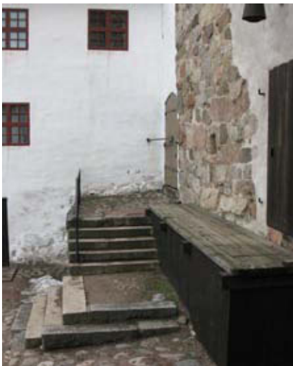
Lämmönvaihdinhuoneeseen ja Pajapihalle johtava porras ja kulkutaso pihan lounaisnurkassa. Merja Nieminen 2011.
