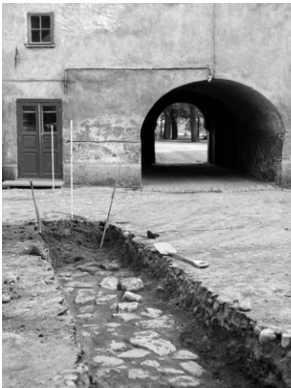
Vanhempaa pihakiveystä paljastui putki- kaivuun alkaessa kesällä 1958. C.J. Gard- berg 1958. TMK, N17354.
