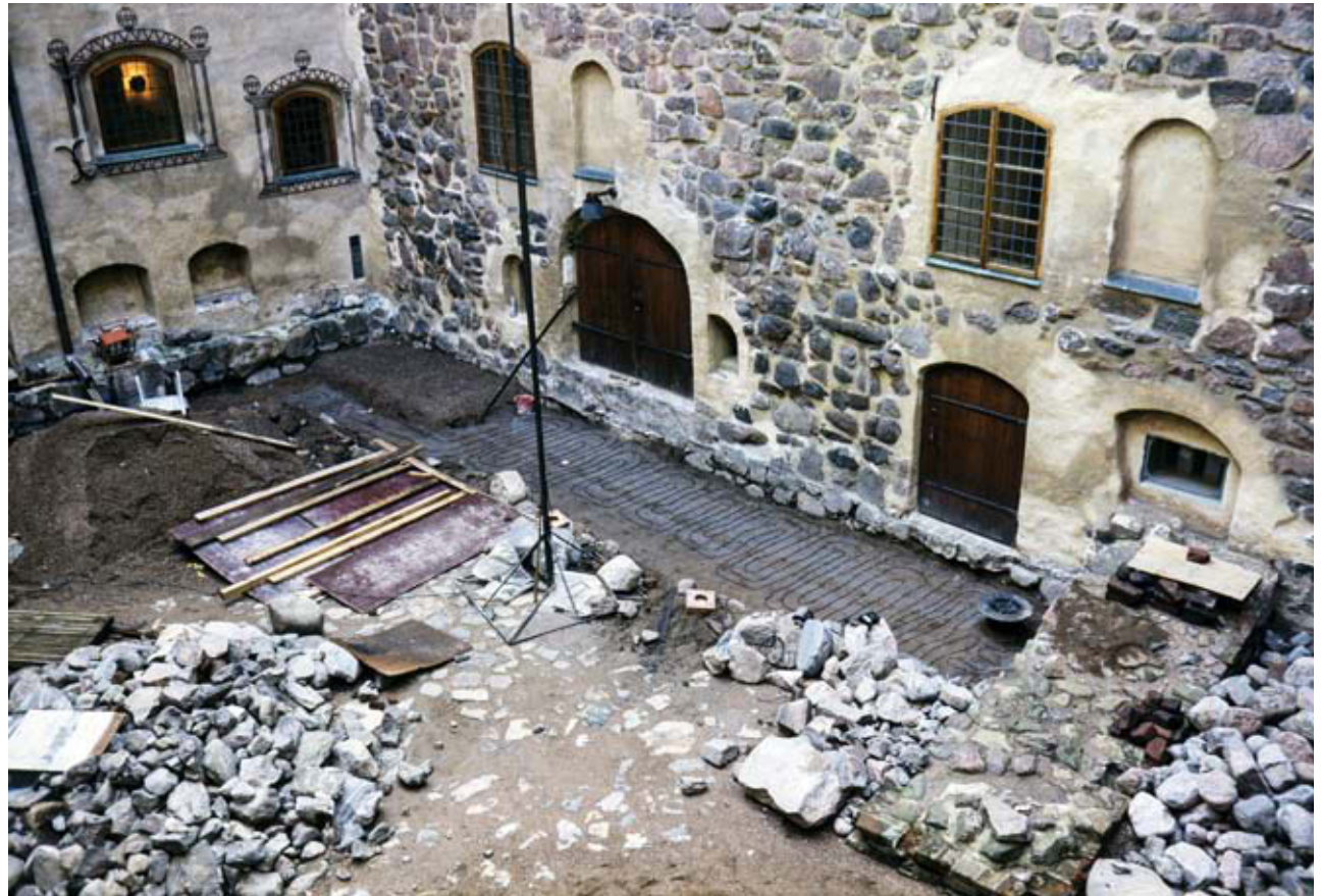
Päälinnan pihan länsiosan lämmityskaapeliä asennus. Ilmo Kajala 1992. MV, väridia 2262.
