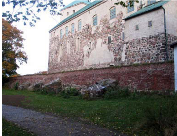
Pajapihan muuri ennen korjausta ja korotusta, Antti Suna 2007.
