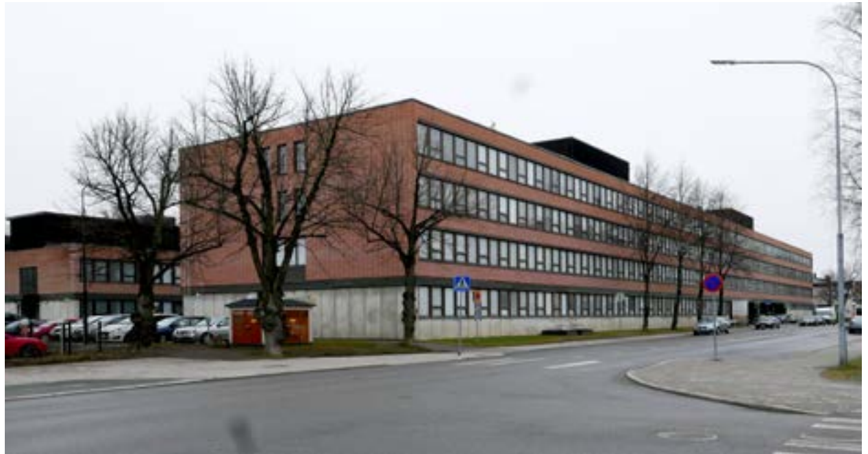
Virastotalon Torikadun puoleinen punatiilinen julkisivu on voimakkaan horisonttaallinen.
