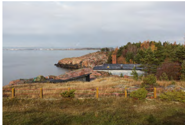
Voima-asema kuvattuna kohti pohjoista syksyllä 2017.
