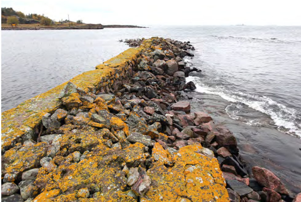
Kuva 24. Pikku Kuivasaaren länsirannan aallonmurtaja on osittain sortunut.
