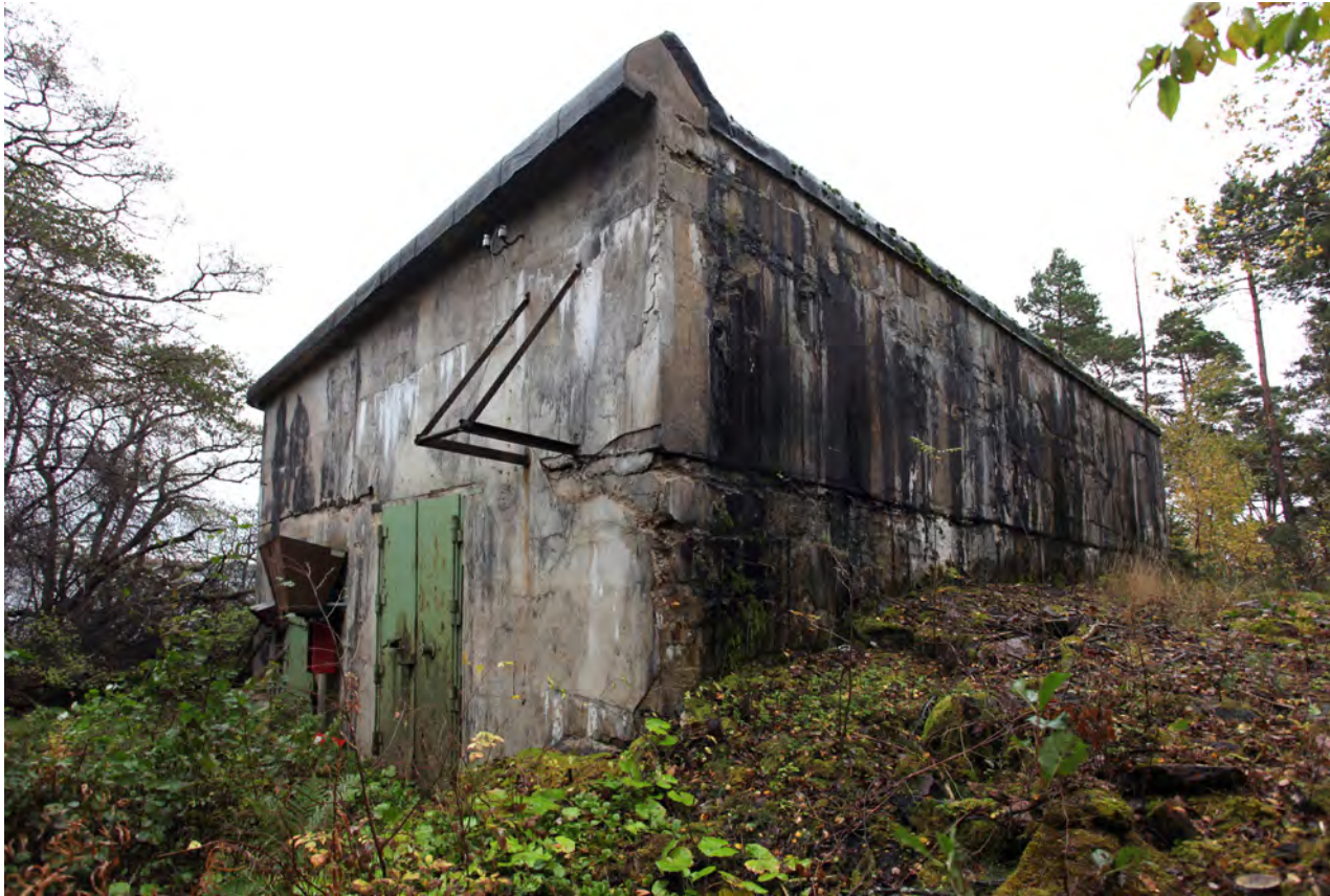
Yösodankäynnissä tärkeä valonheitin linsseineen ja peileineen tuli suojata betonisen kasematin sisään.
