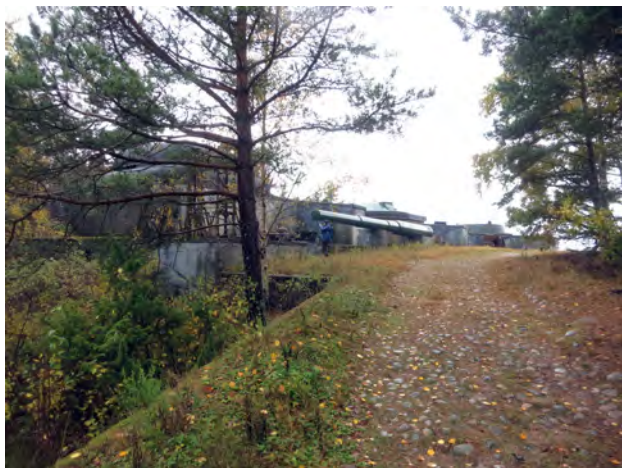
Kasemateille johtaa saaren pohjoisosan laiturilta kaareva, mukulakivillä päällystetty, vuonna 1911 valmistunut tykkitie.
