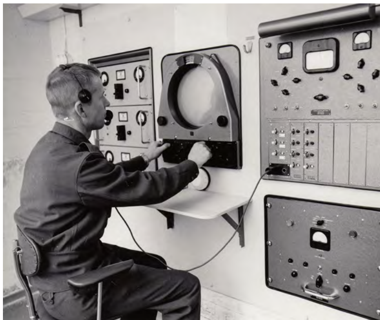
Tutkalaitteistoa Kuivasaaren tulenjohtotornin (10) maanalaisissa tiloissa vuonna 1968.
