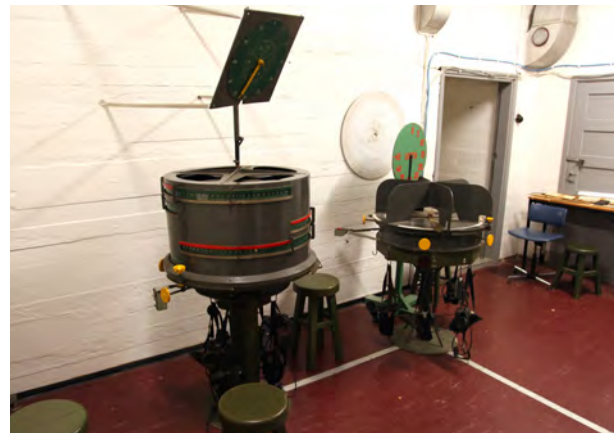
Kuivasaaren keskiön laitteita voima-asemassa (11).
