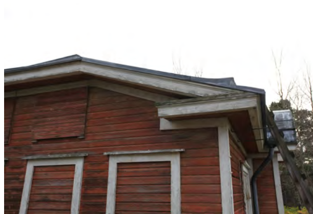
Kissanpenkki eli taitettu räystääs.
