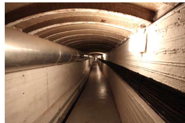
1930-luvulla rakennettu maanalainen yhdyskäytävä johtaa kasemateista (13) voima-aseman (11) tiloihin. Katossa näkyy kaarevia teräspalkkeja.
