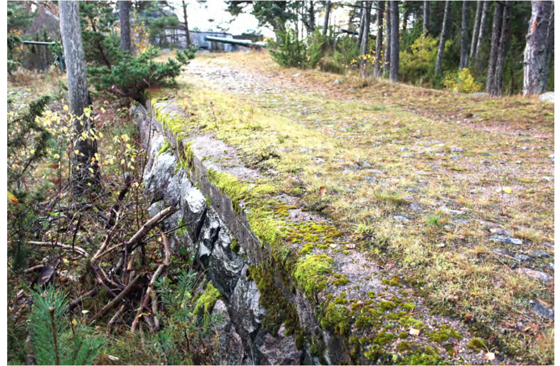
Kuva 20. Tykkitie päätty kasemattipatterille (13), jota edeltävä tien kaarre on pengerretty luonnonkivillä.
