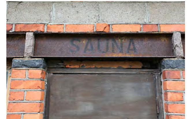
Ovi- ja ikkuna-aukot on vahvistettu teräspalkein.
