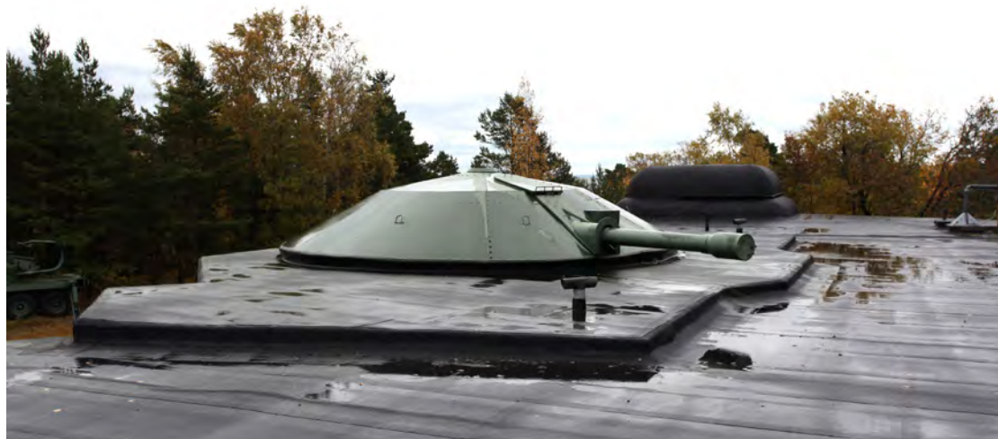
Kasemattipatterin idänpuoleisin tykki on Tampellan tehtaalla 152/45 C -nimisestä Canet-tykistä modernisoitu 152/50 T -tykki, joka on tuotu vuonna 2002 museotykiksi. Tykin takana näkyy vuonna 1916 rakennettu
