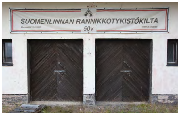
Vajassa on vinopaneloidut pariovet.
