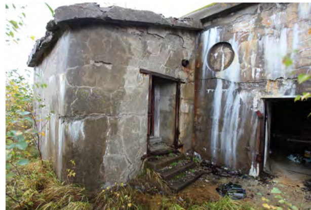
Betoniseinissä on pyöreitä syvennyksiä eli valeikkunoita. Ulko- ovet ovat huonokuntoista, alkuperäistä yksilehtisiä teräsovia. Vuonna 1917 valmistunut lisäsiipi toimi miina-aseman jäähdytyshuoneena.
