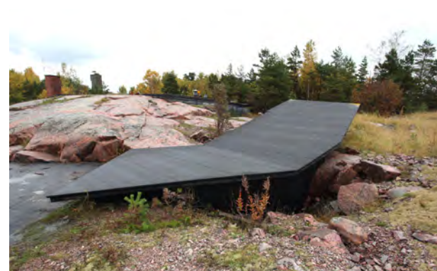
Kuva 5. Voima-aseman (11) lounaispuolella sijaitsee maalaiseseen tilaan johtava sisäänkäynti. Rakennelman huopakate on äskettäin uusittu.
