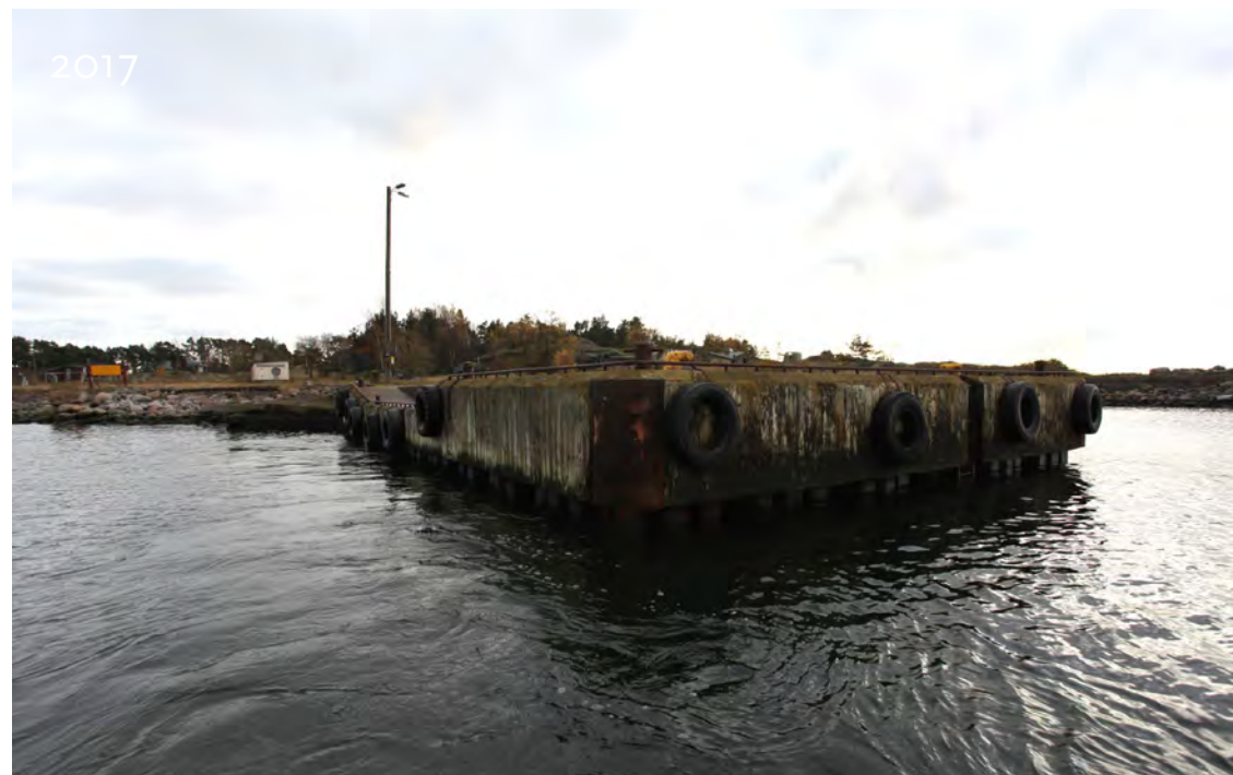
Kuva 23. Kuivasaaren pohjoisrannan laiturin lokakuussa 2017. Laituri on uusittu vuonna 1992 ja se on nykyisin betonirakenteinen.
