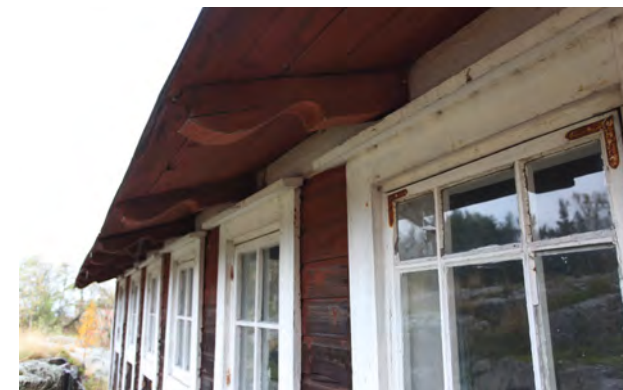
Räystäskonsolit on koristeveistetty.
