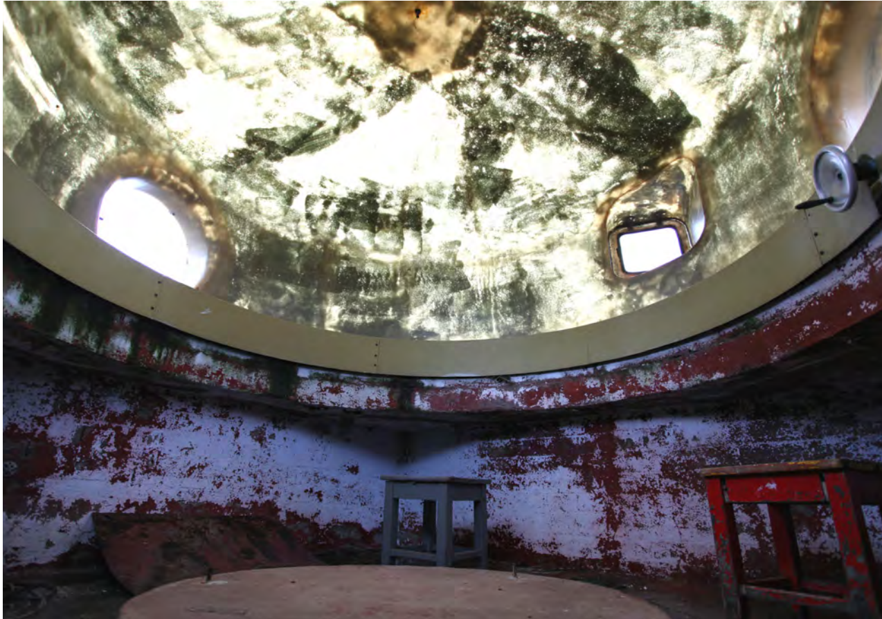
Tornin ylin sisätila on pyöreä potero, jonka läpikuultava lasikuitukatto on lisätty mahdollisesti 1960-luvulla.
