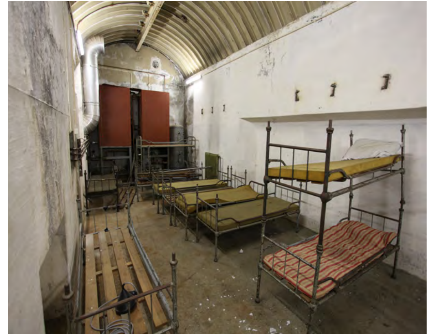
Voima-asemassa on majoitustilaa kaiken kaikkiaan 55 hengelle. Makuusalissa on kaareva, rautakiskoin tuettu katto.
