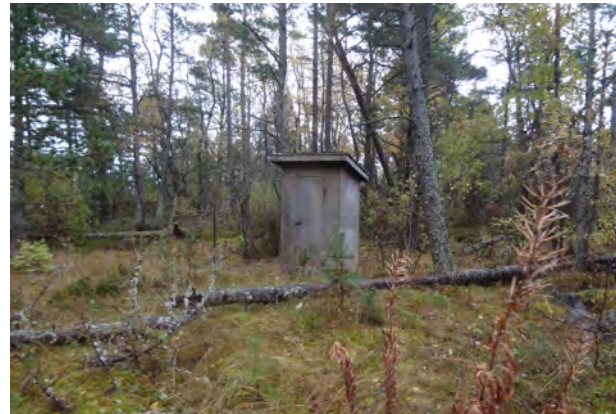
Kuva 9. Vanerilevyseinäinen kuivakäymälä sijaitsee rivitalon (8) itäpuoleisessa metsässä.
