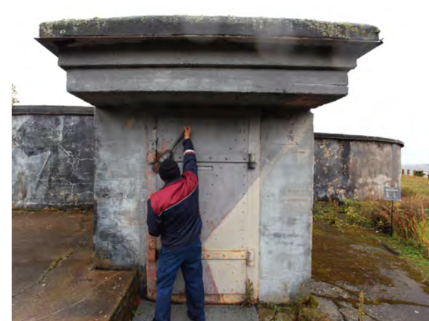
Kasemateissa on paksut teräsövet.
