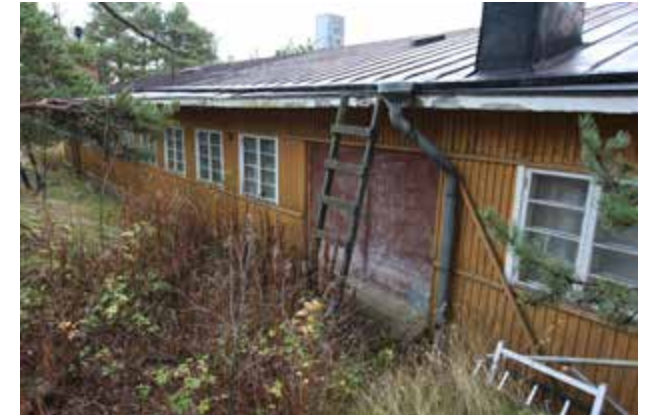
Kasarmin länsisivulla on suuri levyovi. Edusta on pusikoitunut.
