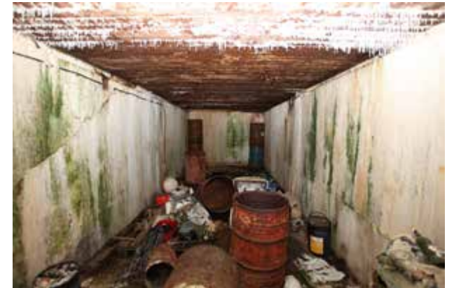
Vuonna 1915 valmistuneen pohjoispäädyn miina-aseman sisätiloissa on rataakiskojen varaan valettu betonikatto.
