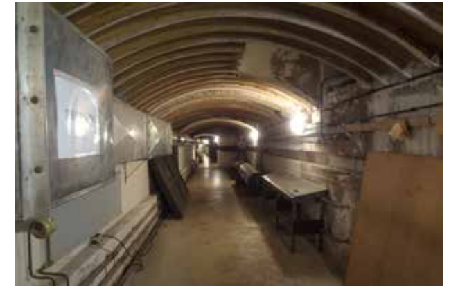
Kasemattien (13) ja voima-aseman välinen maanalainen yhdystunneli on rakennettu 1930-luvulla.
