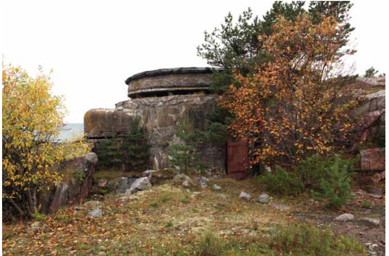
Etäisyysmittauspaviljonki näkyy vasemmalla. Sen päällä on optista Zeiss-mittaria varten rakennettu paviljonki, josta on hyvä näkyvyys merelle. Vahvan betonirakennuksen päällä on luonnonkivimuuras. Ovi on terästä.
