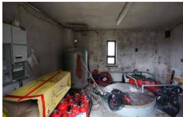
Vajan eteläpäädyn huoneessa sijaitsee kaivo.
