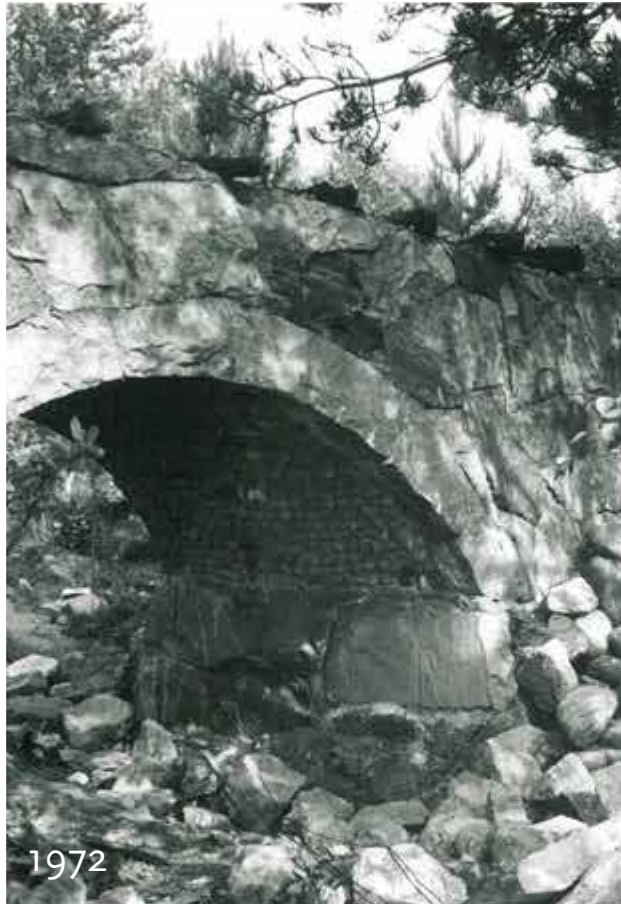
Kuvassa näkyy kivivallin silta vuonna 1972. Ratakiskot oli tällöin jo purettu, mutta ratapölkkyjä oli tällöin vielä tallella. Kuva: teoksesta Löfgren 1972, 47 / Kaj-Erik Löfgren.
