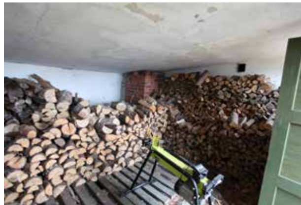
Sisätilojen seinät ja katto on rapattu ja maalattu. Katto on kalteva.
