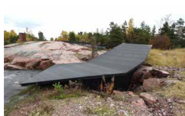
Kuva 5. Voima-aseman (11) lounaispuolella sijaitsee maanalaiseen tilaan johtava sisäänkäynti. Rakennelman huopakate on äskettäin uusittu.
