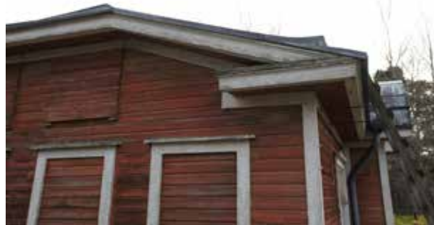
Kissanpenkki eli taitettu räystääs.
