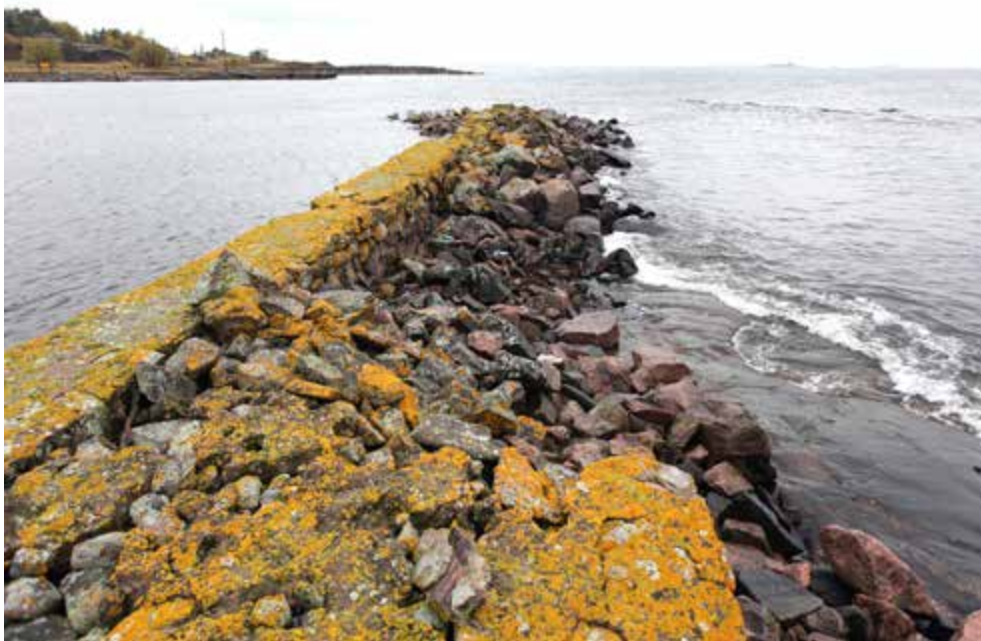
Kuva 24. Pikku Kuivasaaren länsirannan aallomurtaja on osittain sortunut.
