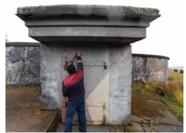
Kasemateissa on paksut teräsövet.
