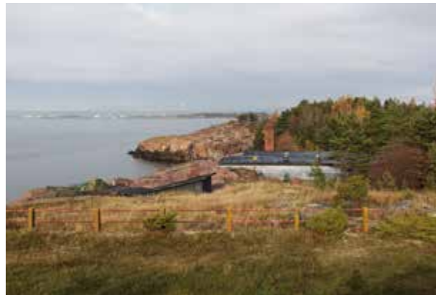
Voima-asema kuvattuna kohti pohjoista syksyllä 2017.
