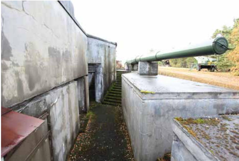
Kasemattien kellaritiloihin laskeudutaan ulkoportaiden ja kapeiden käytävien kautta.
