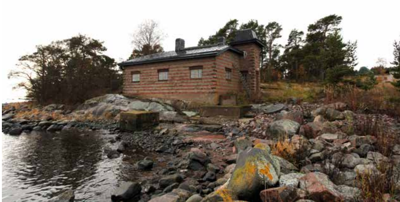
Saunarakennus sijaitsee lähellä rantaviivaa. Rannan betonikuutiot ovat puretun laiturin perustuksia.
