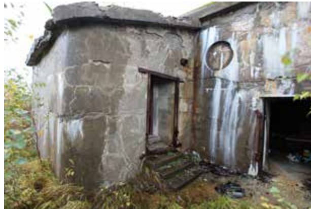
Betoniseinissä on pyöreitä syvennyksiä eli valeikkunoita. Ulko-ovet ovat huonokuntoista, alkuperäistä yksilehtisiä teräsovia. Vuonna 1917 valmistunut lisäsiipi toimi miina-aseman jäädytyshuoneena.
