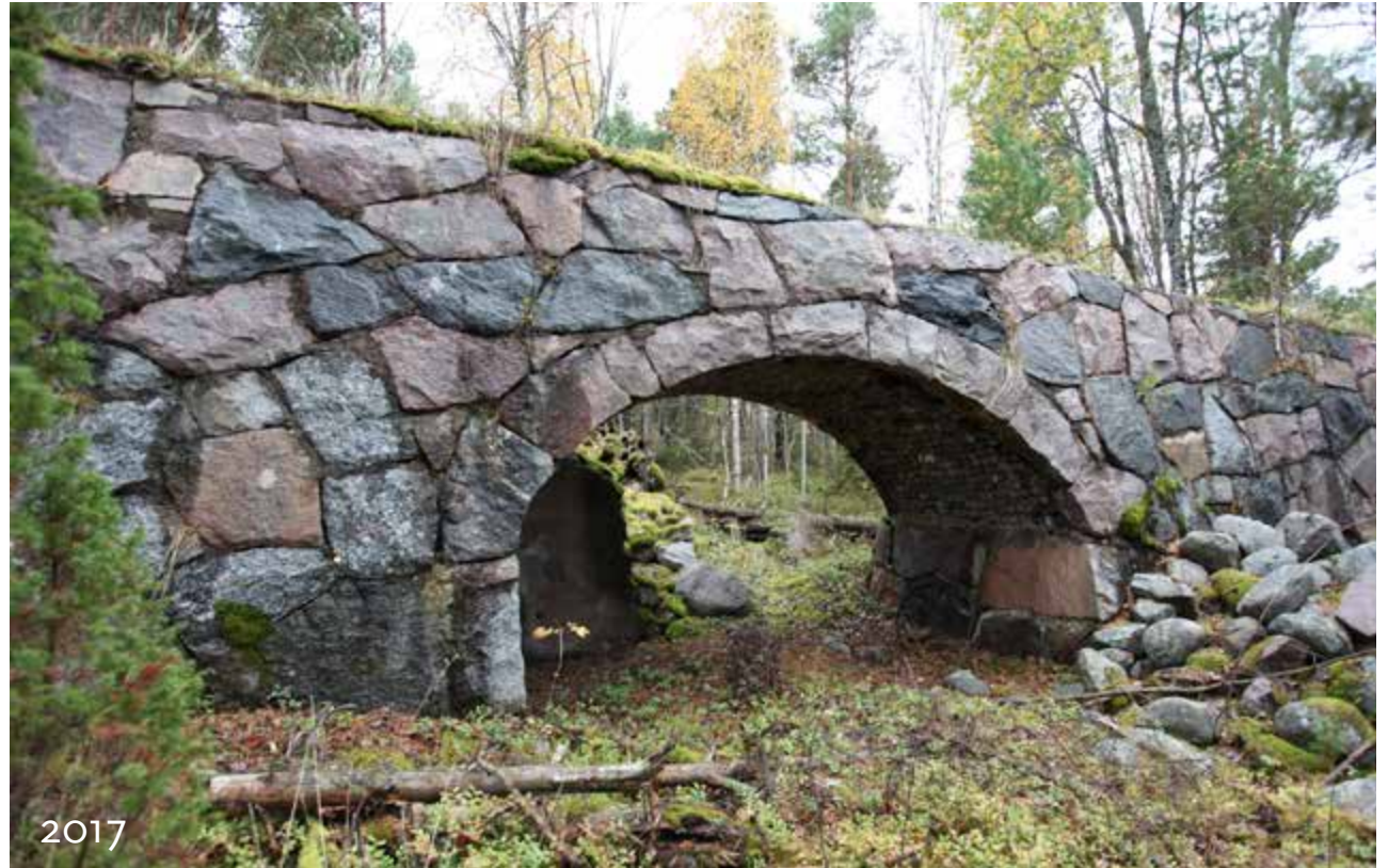
Valonheittimen siirtoradan vallin kivisilta syksyllä 2017. Ratapölkkyjä ei ole säilynyt.
