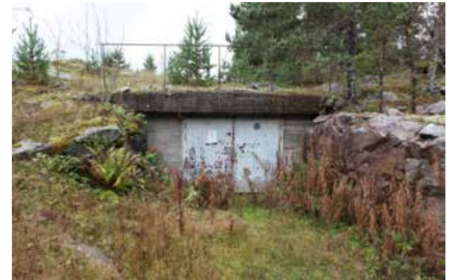
Kuva 7. Maanalaisen tilan betoniseinäinen sisäänkäynti saaren eteläosassa. Ympäristössä on aiemmin sijainnut useita konekivääri-, tykki- ja yhdyshauta-asemia sekä miehistökorsu.
