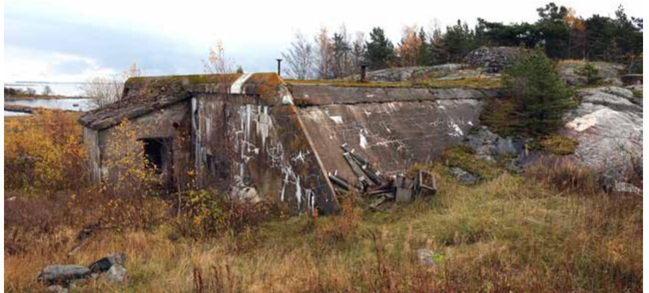
Miina-asema sijaitsee rakennuksen pohjoisosassa. Sen betoniset katto- ja seinärakenteet kytkeytyvät kiinni kalliioon.
