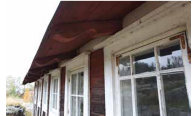
Räystäskonsolit on koristeveistetty.
