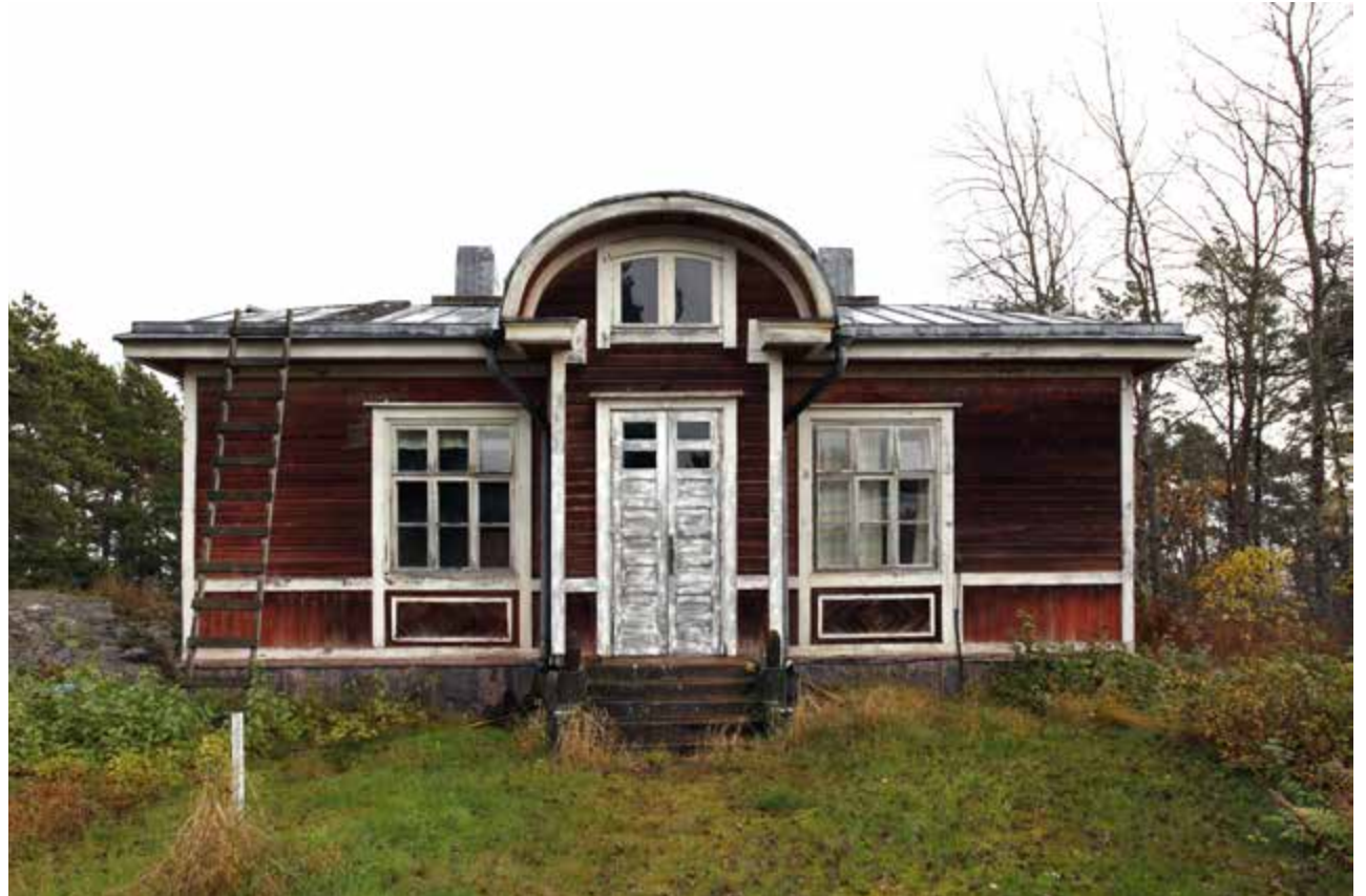
Pääsisäänkäynti sijaitsee lännen puolella. Pariovi ei ole alkuperäinen.
