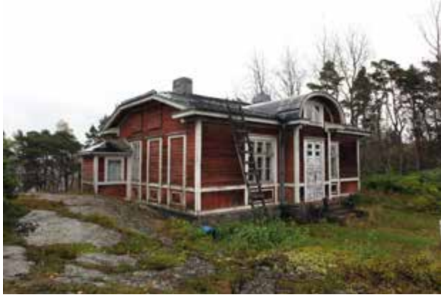
Linnakkeen päällikön talon pohjoispääty ja länsisivu.
