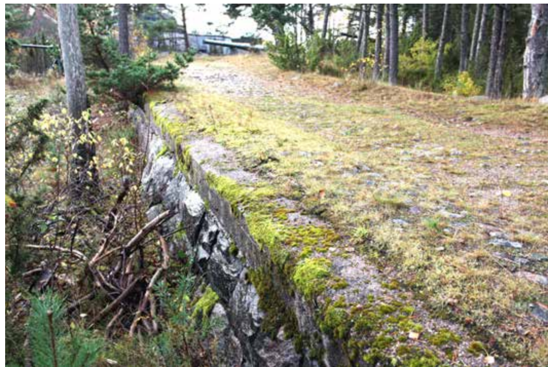
Kuva 20. Tykkitie päättyy kasemattipatterille (13), jota edeltävä tien kaarre on pengerretty luonnonkivillä.
