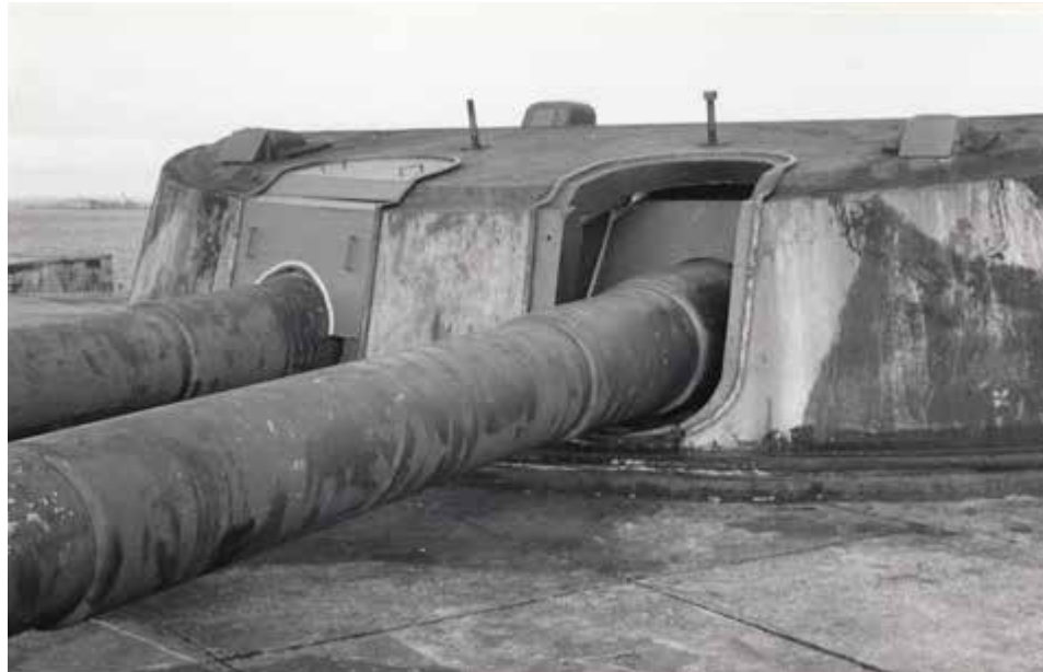
Kaksoistykkin toisen putken suoja-aukko on paikoillaan Kuivasaaren kasemattipatterissa.
