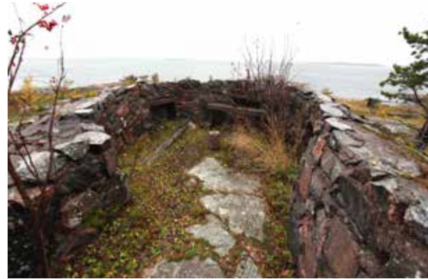
Kuva 3. Saaren luoteisosan kallion laella oleva kivistä muurattu kasematti.
