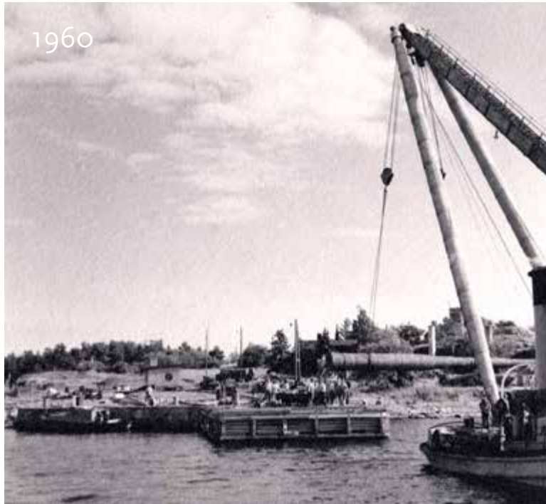
21. heinäkuuta 1960 otetussa kuvassa puretaan saareen palautettavan Obuhov-tykin putkia vaunuista. Kuivasaaren pohjoisrannan laiturissa on ollut hirsiaarkut. Kuva: Puolustusvoimat / Rautio.
