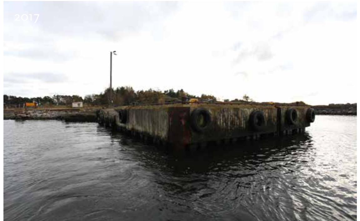
Kuva 23. Kuivasaaren pohjoisrannan laiturin lokakuussa 2017. Laituri on uusittu vuonna 1992 ja se on nykyisin betonirakenteinen.
