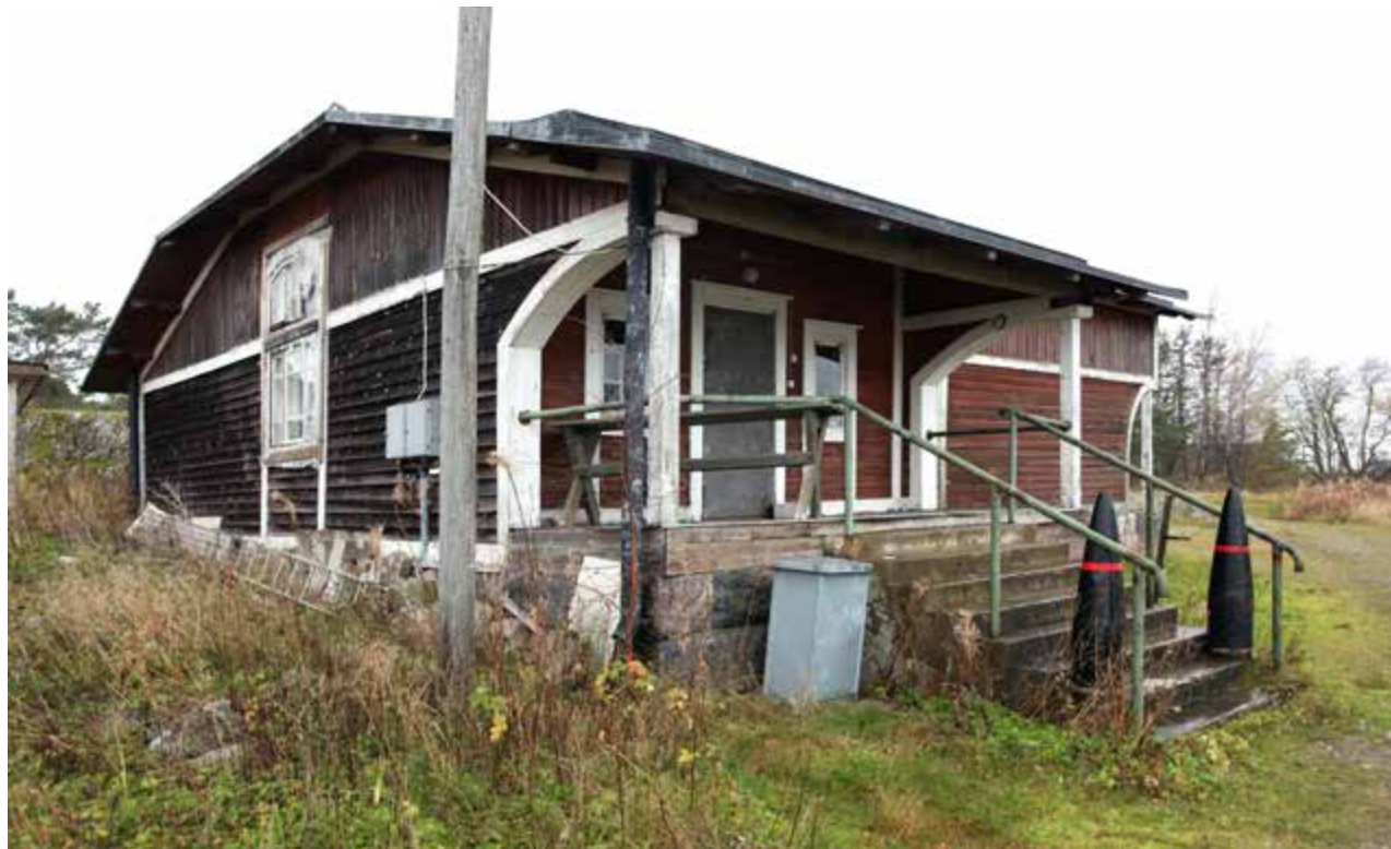
Sisäänkäynnin yhteydessä on avokuisti ja betoniporras, jonka reunoilla on ammuksset.
