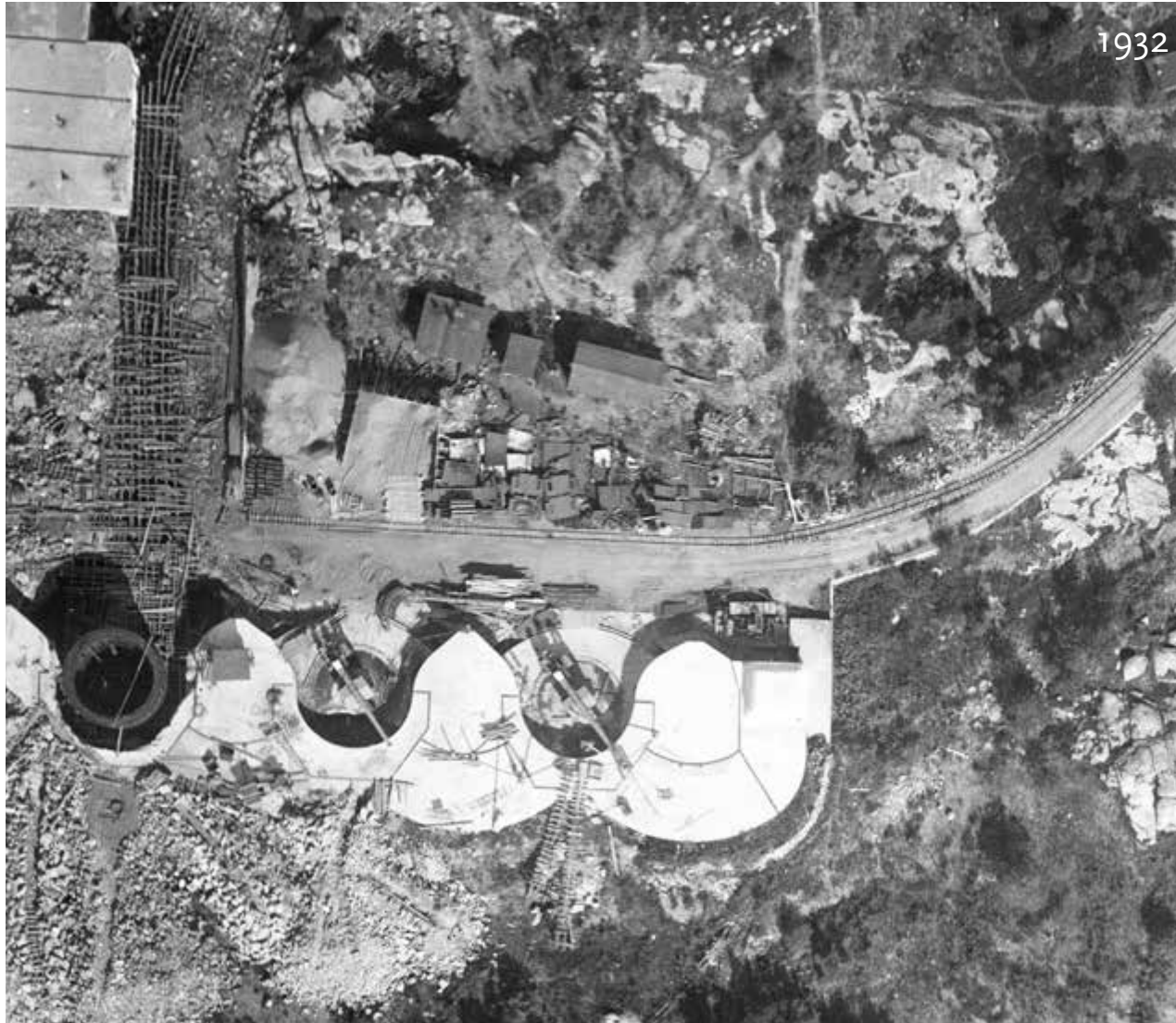
Vuoden 1932 ortoilmakuvassa näkyy kaksi 1910-luvulla asennettua kymmentuhamaista Durlacher-tykkiä. Kuvan ulkopuolelle jää vielä kolmas. Yksi tykki on purettu ja sen paikalle rakennetaan 12-tuumaisen kaksoistykkin tornia, jonka lieriö on jo asennettu. Kuva (osa): Puolustusvoimat.
