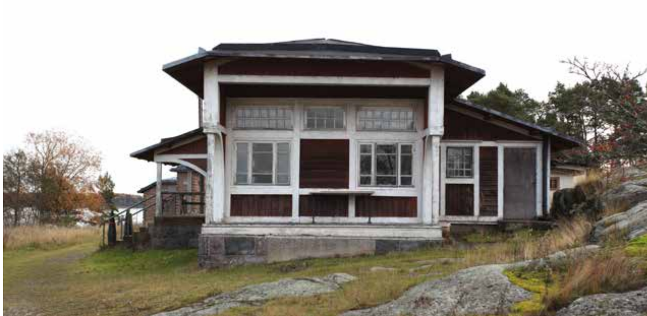
Ruokalan julkisivu luoteeseen. Ikkunat ovat alkuperäisiä, puisia ruutuikkunoita. Takana vasemmalla pilkottaa saunarakennus ja oikealla ruokalan vaja.
