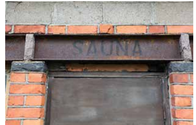
Ovi- ja ikkuna-aukot on vahvistettu teräspalkein.
