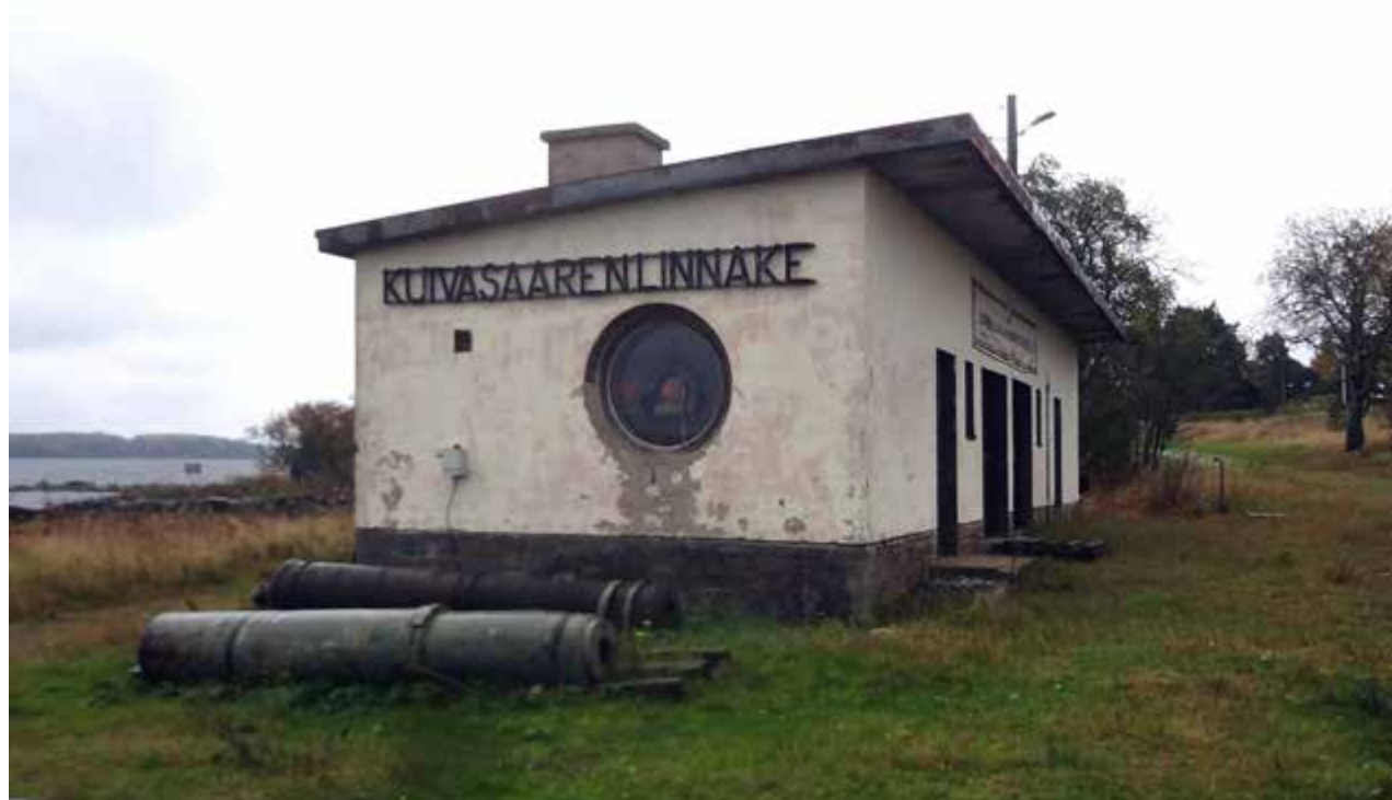
Palokalustovaja tervehtii Kuivasaaren tulijaa ensimmäisenä rakennuksena. Luoteen puoleisen päädyn yläosaan on kiinnitetty kahden vaakapuuiriman varaan yksittäiset puulevystä sahatut, mustaksi maalatut kirjaimet "KUIVASAAREN LINNAKE".
