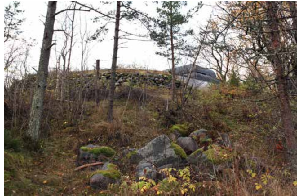
Kasemattien kaakkoiskulman rintavarustuksessa on luonnonkivimuur.
