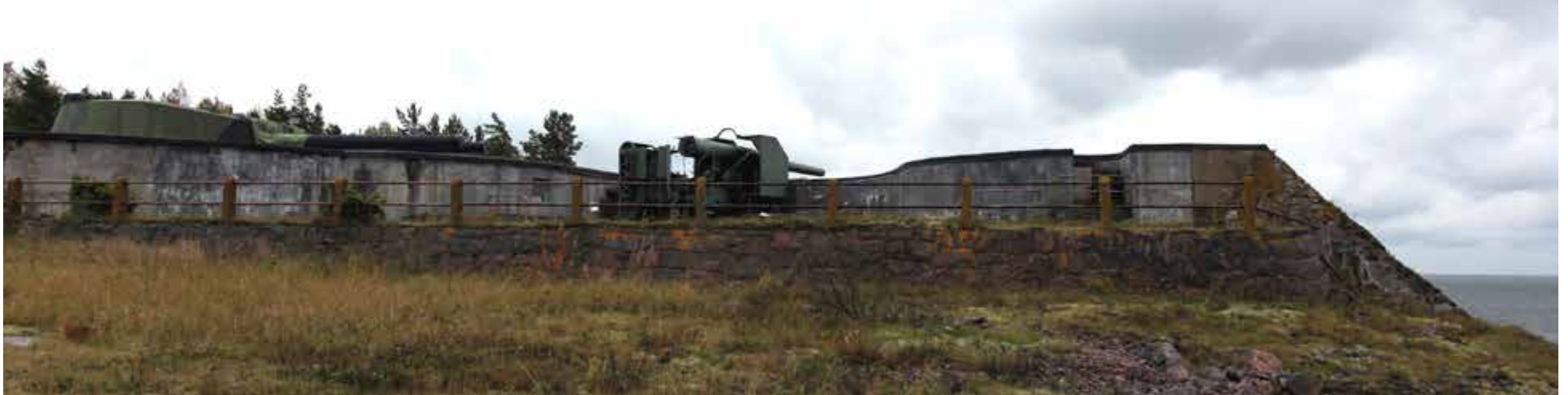
Kasemattipatteri kuvattuna kohti etelää syksyllä 2017. Vasemmalla näkyy Obuhov-kaksoistykkitorni, keskellä 10-tuumainen Durlacher-tykki. Rakennelma päättyy lännessä mereen laskevaan, luonnonkivimuurilla tuettuun jyrkänteeseen.
