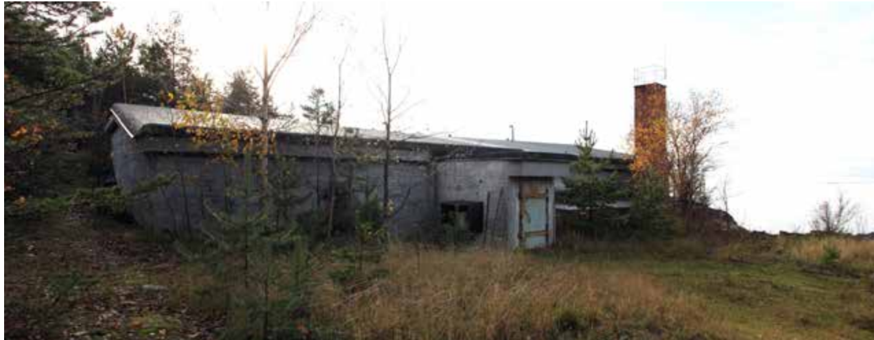
Voima-asema on betoninen, osittain maanalainen rakennus Kuivasaaren länsirannalla.
