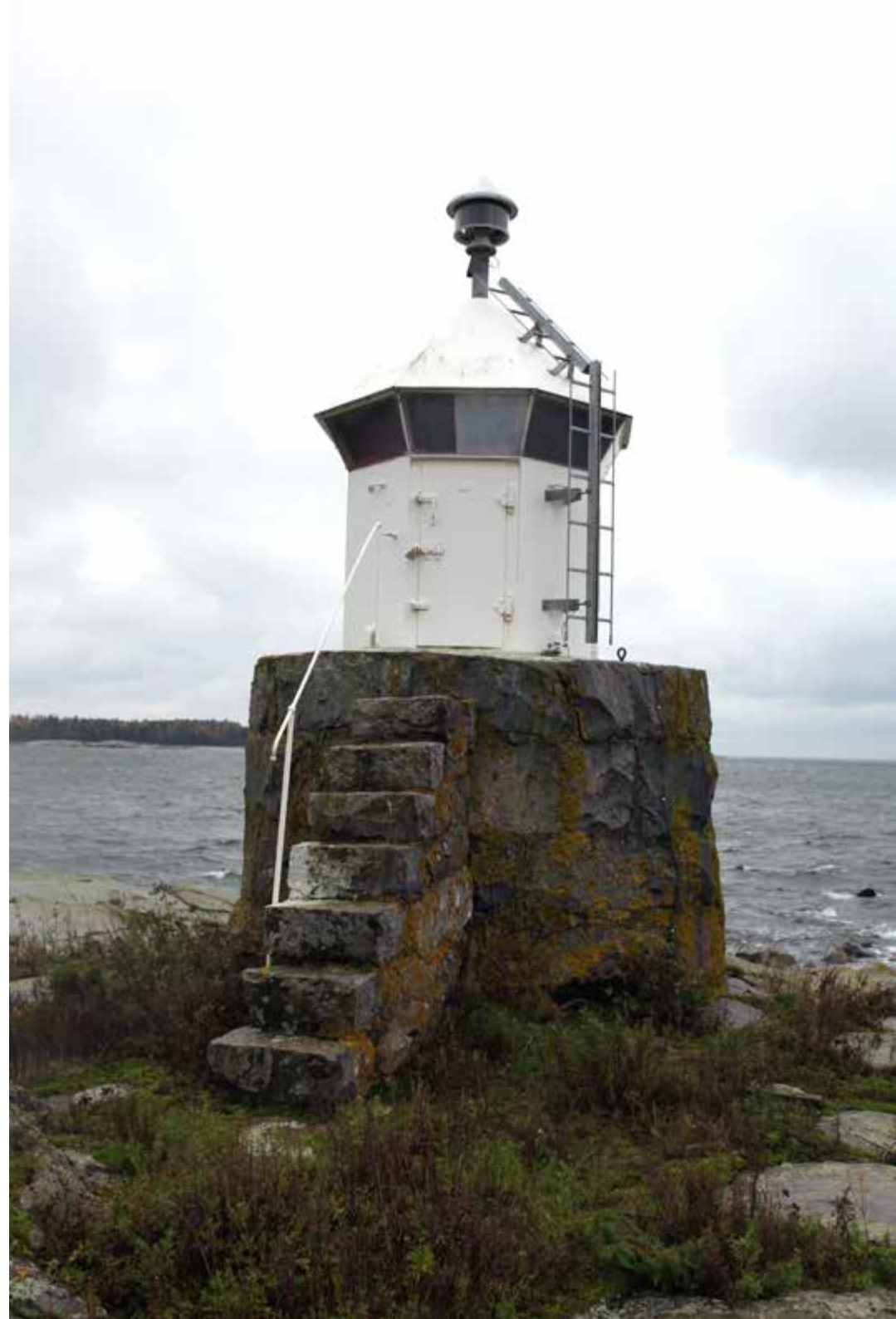
Kuva 27. Pikku Kuivasaaren kaakkoisrannalla on pienikokoinen, luonnonkivien päälle rakennettu majakka eli loisto.
