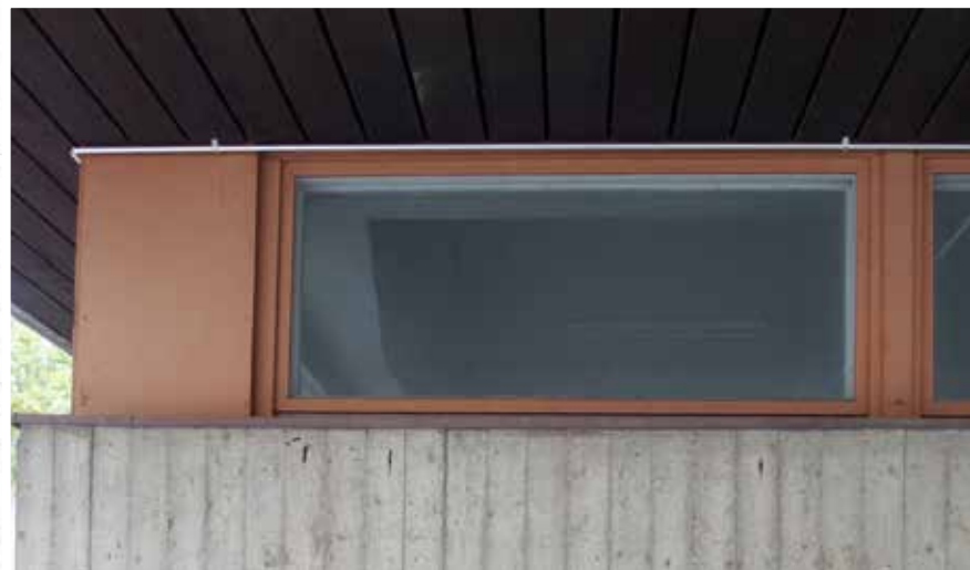
Alla: Alkuperäinen ikkuna.
