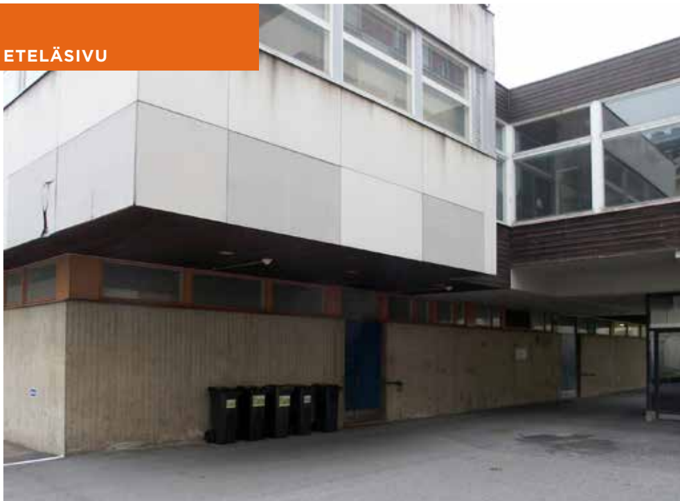
Yllä: Lounaiskulmassa on jouduttu uusimaan useita mineriitilevyjä.
