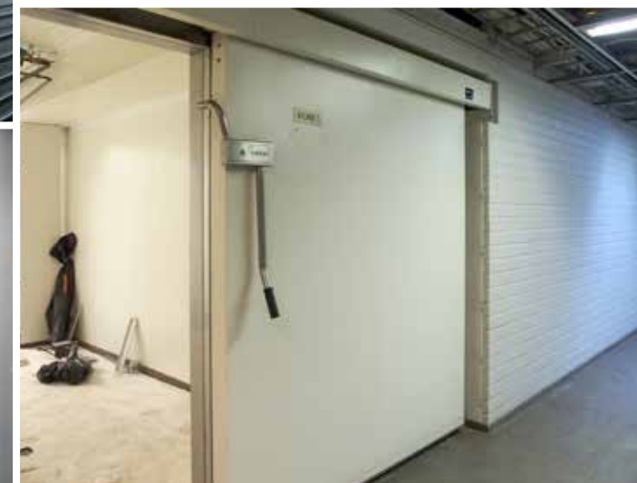
Alla: Kellarin varastotilojen 1990-luvun liukuovi.
