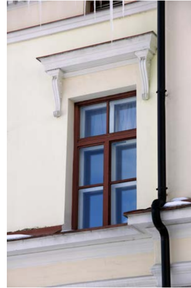
135. Kuusiruutuinen ikkuna toisessa kerroksessa.
