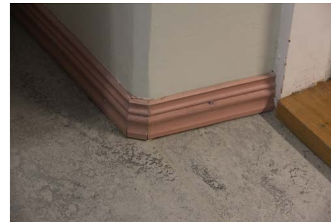
173. Lattialistat on tehty vanhan mallin mukaisesti. Kynnykset ovat 1980-luvulta.
