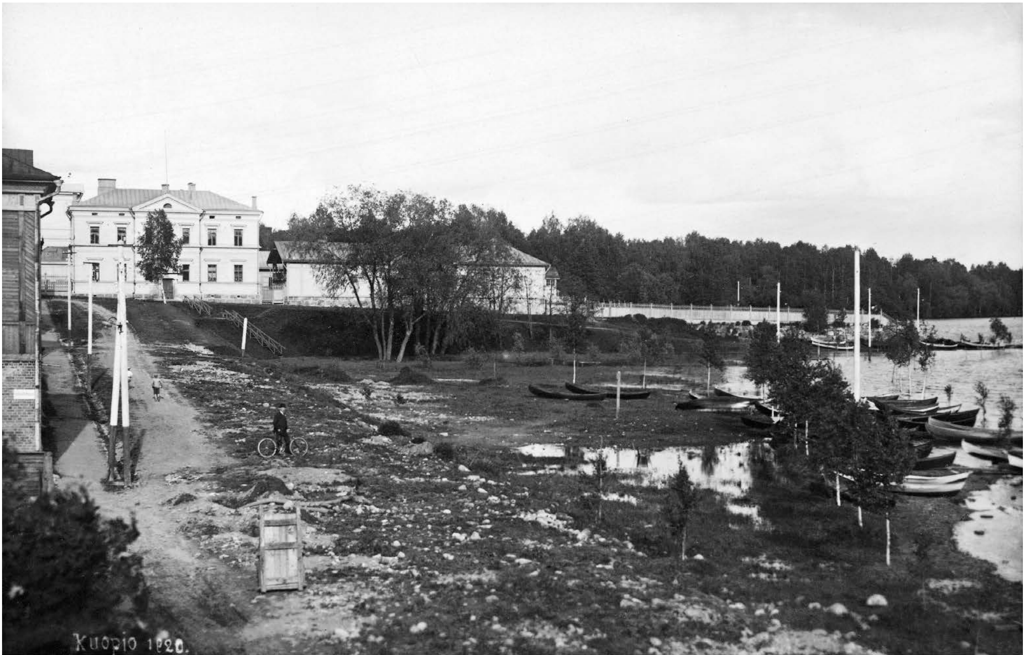
82. Näkymä nykyisen Brahenpuiston suunnasta piiri-insinöörin taloa kohti ennen ullakon rakentamista vuonna 1920. Oikealla puolella on hirsirakenteinen kylmä talousrakennus. KUVA: Kuopion museo, Lauri Marjanen
