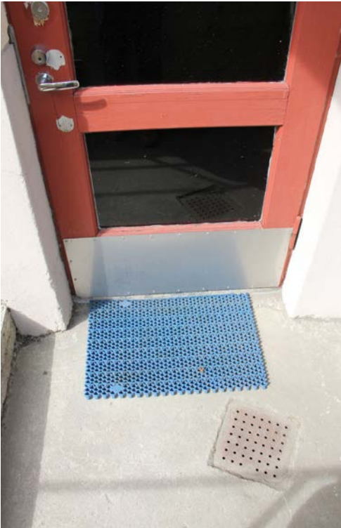
226. Talon pääsisäänkäynti on maantason alapuolella. Kellarin ovi on ulko-oven takana vasemmalla.
