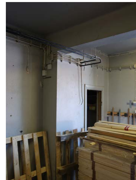
198. Alkuperäinen ulkoseinä on puhkaistu. Kehys on jätetty tukirakenteeksi.
