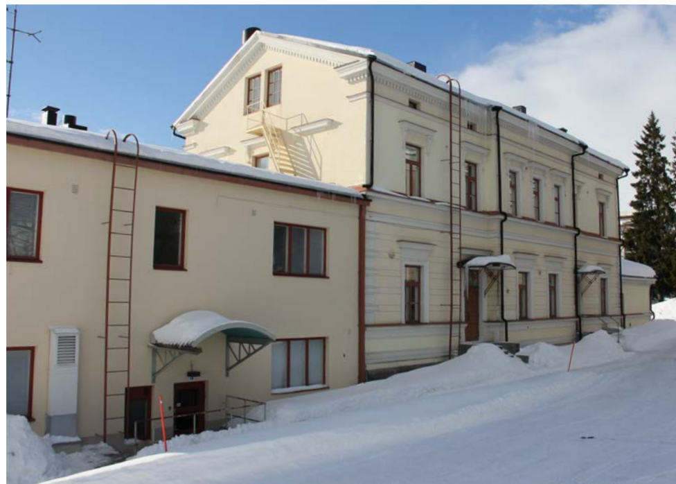
114. Julkisivu sisäpihan puolelta kaakosta. Konttorirakennuksen päädyssä on varatienä toimiva porras. Sen molemmin puolin on fragmentit pii-rustussalin poistetuista ikkunoista.
