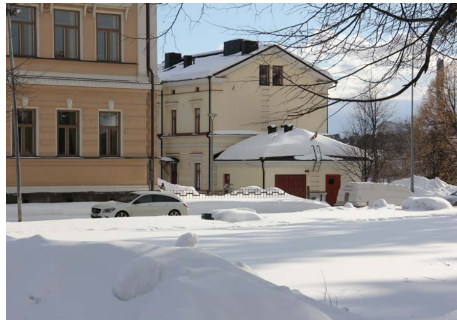
108. C-talon pohjoispääty Piispanpuiston suunnasta.
