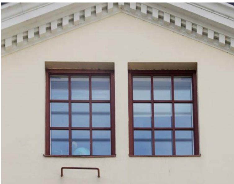
139. Kolmannen kerroksen yhdeksänruutuisen ikkunaparin muoto on 1930-luvulta.
