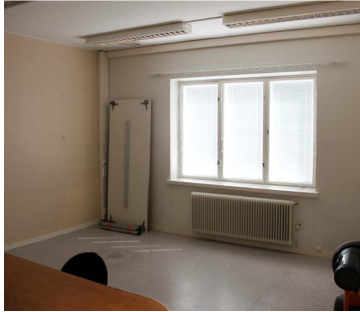
210. Entinen olohuone. Alkuperäinen radiaattori on 1930-luvulta. Pihan puolelle suuntautunut ikkuna on kolmijakoinen.
