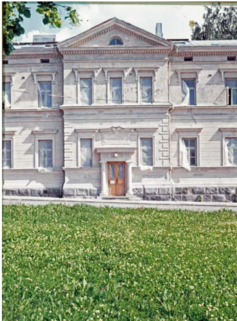
95. Puhdistettu julkisivu odottaa maalausta kesällä 1976. KUVA: Kuopion museo, Sakari Martikainen
