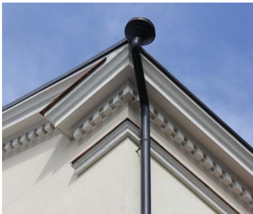
118. Räystäääseen lisättiin hammaslistavuonna 1931, kun aumakatto muutettiin satulakatoksi.
