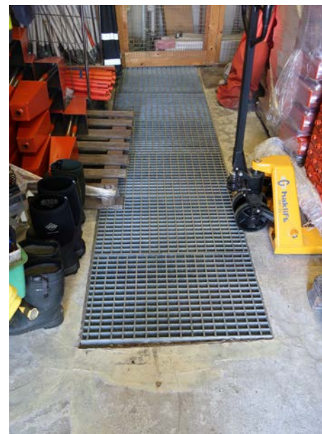
197. Huoltomonttu autotallin lattiassa.
