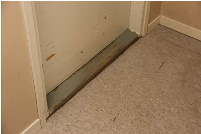
212. Alkuperäinen ulko-ovi ja elämää nähnyt kynnyks.
