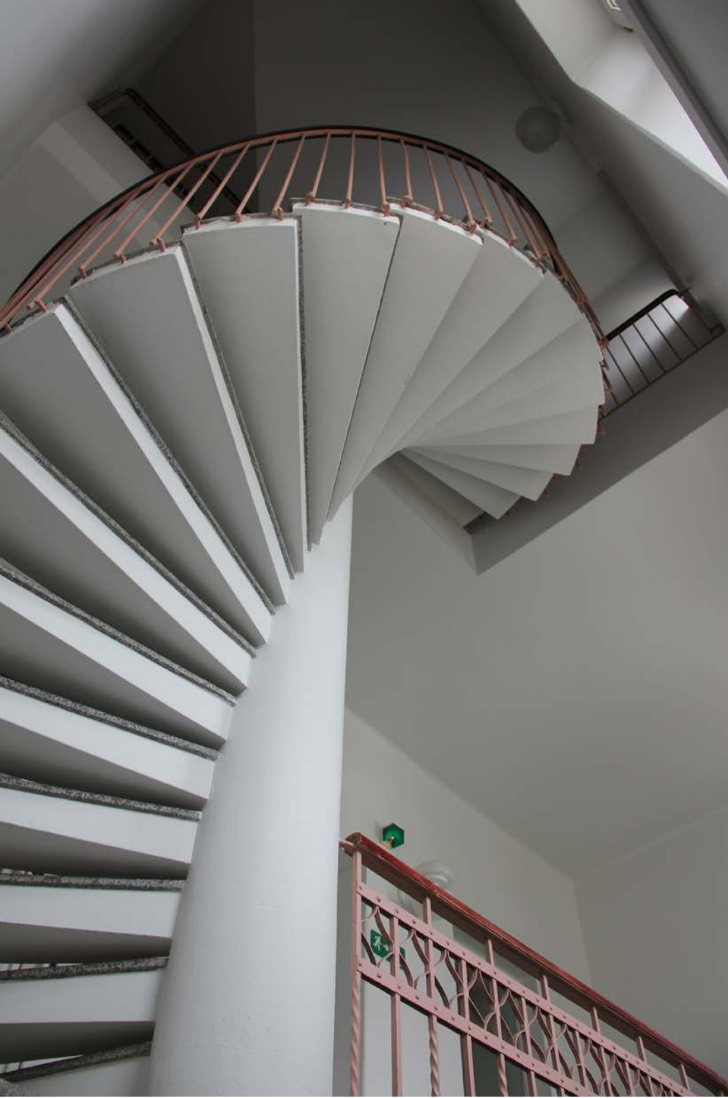
188. Porras kiertyy 360 astetta pyöreän betonipilarin ympäri.
