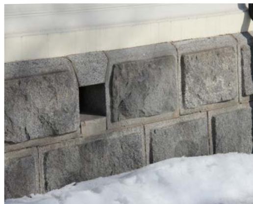
119. Alkuperäinen kivijalka on tehty lohkotusta ja reunoilta hiottu harmaagraniitista.
