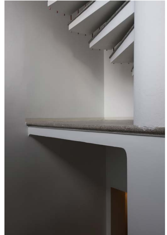
186. Ohut betonitaso tehtiin samassa yhteydessä kierreportaan kanssa. Se liittyy toisen kerroksen puiseen välipohjaan.
