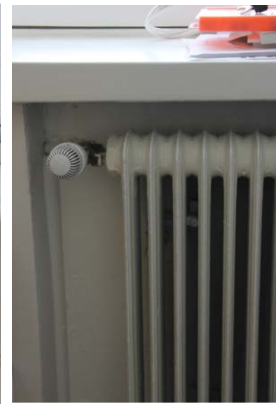
160. Asunto-osan alkuperäinen radiaattori 1930-luvulta.
