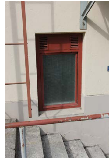
138. Asunto-osan kellarin ikkuna.
