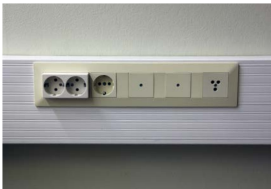
156. Konttoriosan tyypillisiä sähkökalusteita. Kalusteet ovat pääosin 1980-luvun mallistosta.
