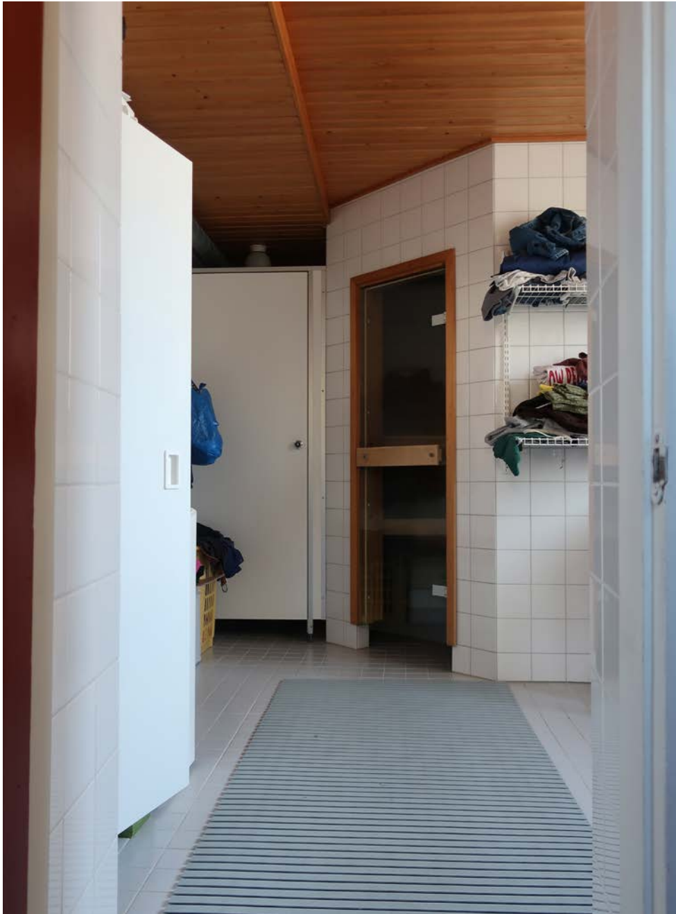
199. Näkymä eteisen ovelta saunalle. Löylyhuonetta on kavennettu ja sen viereen on rakennettu wc.
