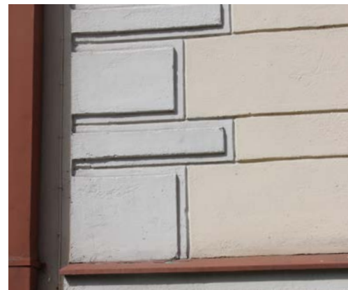
120. Konttoriosan rustikointi on alkuperäinen. Nurkkia on tehostettu vaalealla rappauksella.
