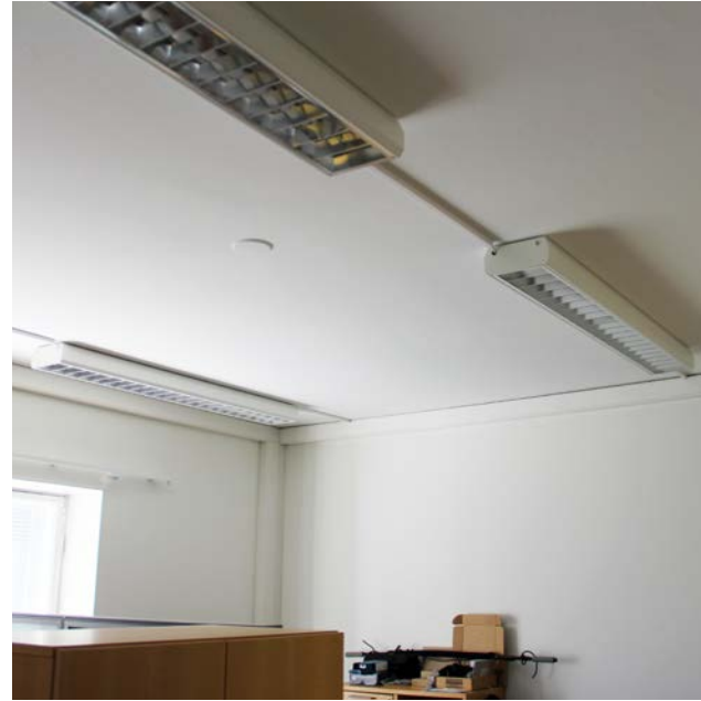
219. Sisäkatto on tasoitettu ja maalattu. Asennukset on tehty katon alapintaan.
