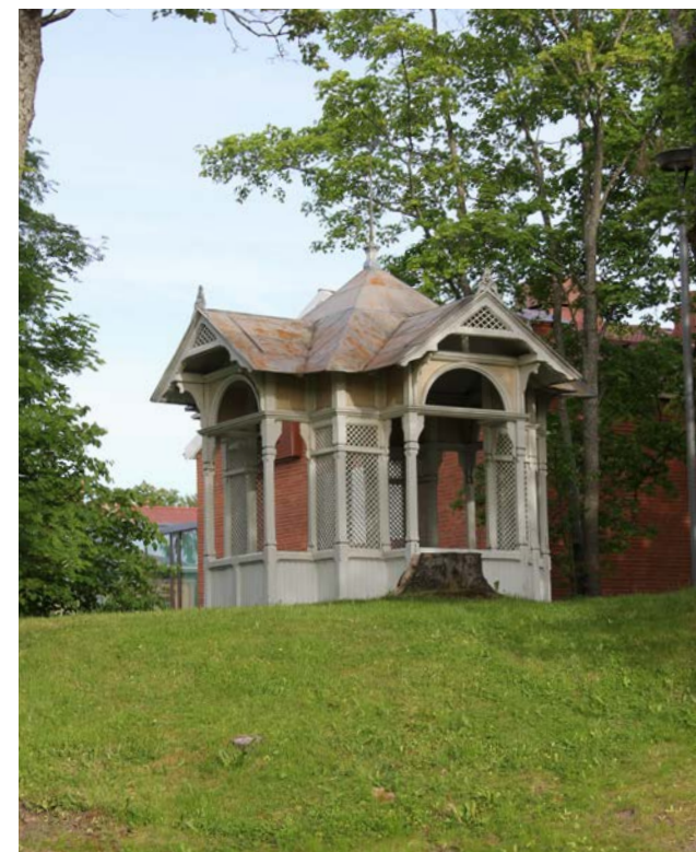
112. Kukulalla sijaitseva huvimaja kuuluu 1880-luvun rakennusryhmään.
