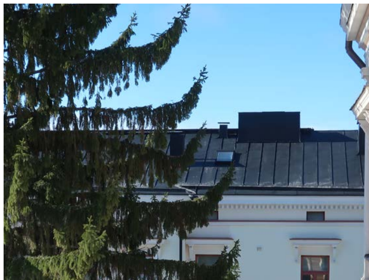
152. Konttoriosan katto. Keskellä yksi viidestä kattoikkunasta. Sen yläpuolella vanha sydän- muurin tiilihormi, jota on hyödynnetty ilmanvaihtokanavana.
