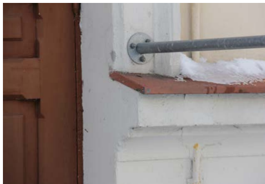
130. Alkuperäisen sisäänkäynnin detaljeja.
