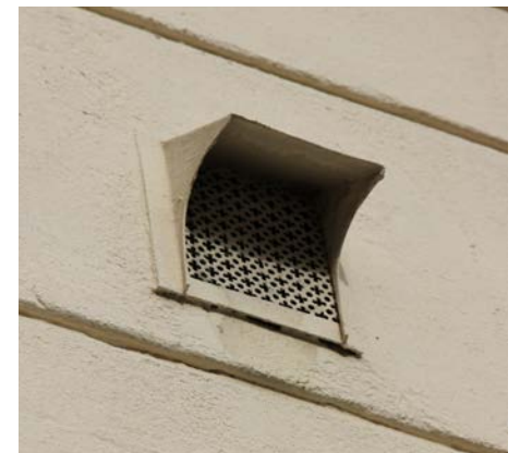
121. Alkuperäisen muotoiset metalliset korvausilmaventtiilit ovat säilyneet ikkunoiden välissä.
