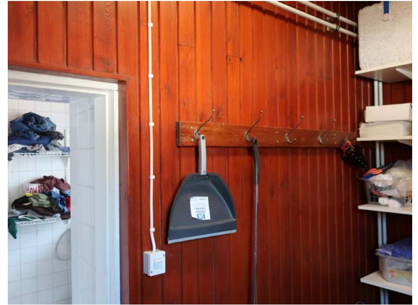
200. Saunan eteisen panelointia.
