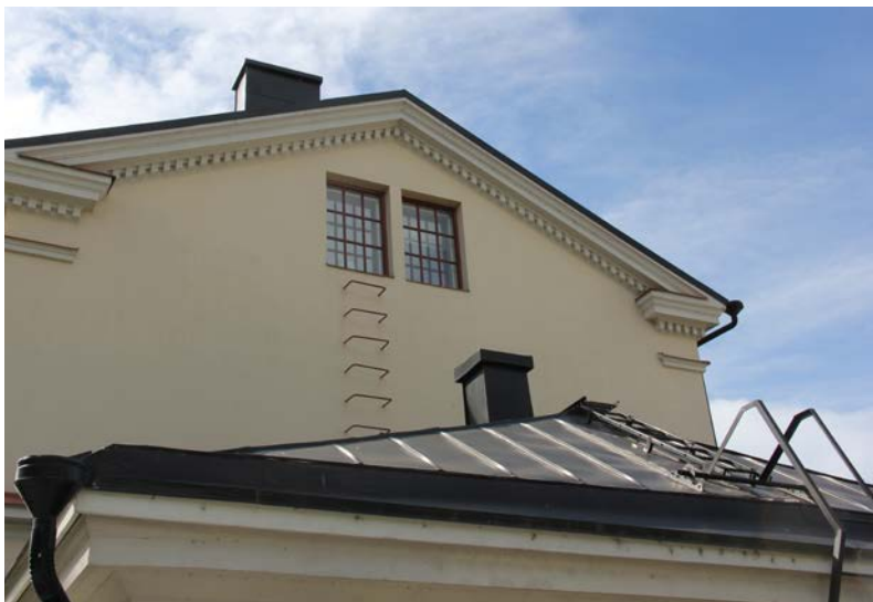
150. Vesikatto on tehty konesaumatus pelliä. Vesi ohjataan jalkalistoilla terässuppiloihin. Etu- alalla autotallin katto.
