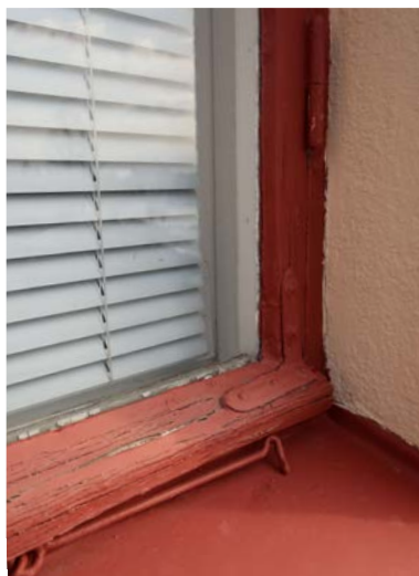
142. Asunto-osan ikkunat ovat alkuperäisiä sisään ja ulos avautuvia puuikkunoita.
