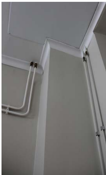
158. Lämpöputkia pinta-asennuksena.
