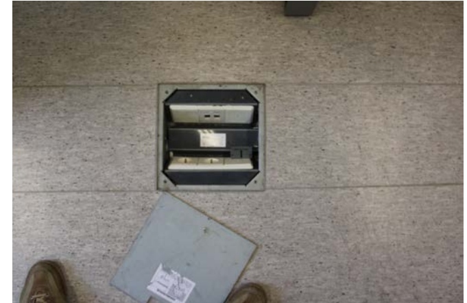
214. Lattiaan on upotettu asennusrasioita.
