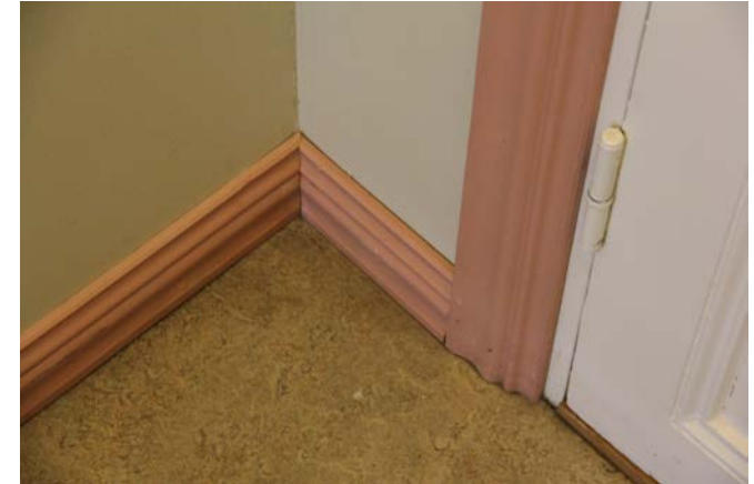
184. Lattialista on tehty alkuperäisen mallin mukaisesti. Oven karmilista on kunnostettu samanaikaisesti vanhojen ovien kanssa.
