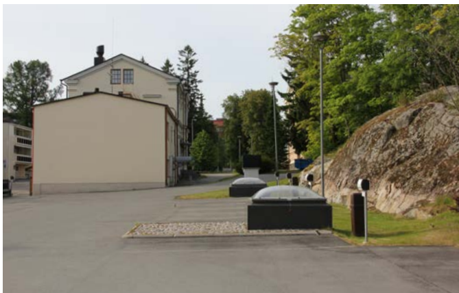
109. Maanalaisen ja maanpäällisen pysäköinnin rakenteita.
