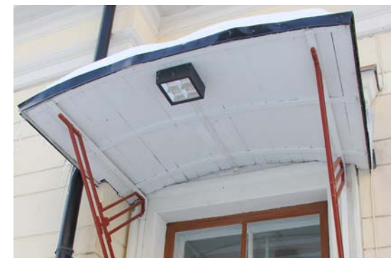
131. Konttoriosan metallirunkoinen ovikatos.
