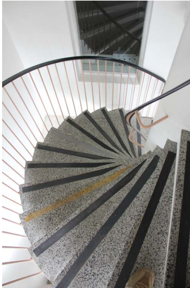
185. Kolmanteen kerrokseen johtava kierreporras on tehty vuonna 1964.
