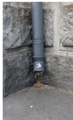
145. Kadun puolella sadevesi lasketaan asfaltille.
