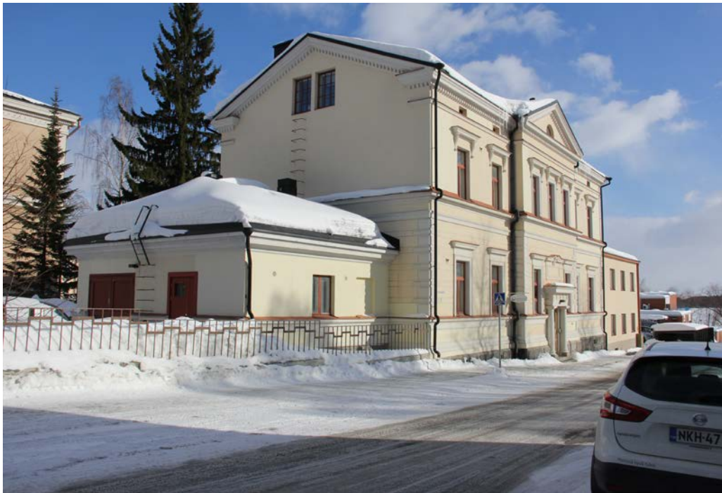
116. Piispankadun suuntainen pääjulkisivu luoteesta. Alkuperäinen yksikerroksinen rakennusmassa on keskellä. Kadulle avautuva pääsisäänkäynti on lisätty vuonna 1914.
