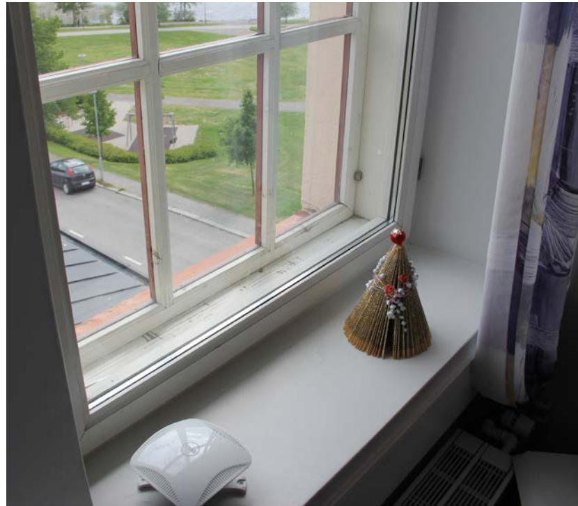
189. Kolmannen kerroksen päätyikkunat avautuvat etelään. Sisempi lasi on lämpölasi. Ulompi lasi on yhdeksänruutuinen. Ikkuna toimii varapoistumistienä.
