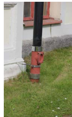
146. Pihan puolella vesi johdetaan hulevesijärjestelmään.
