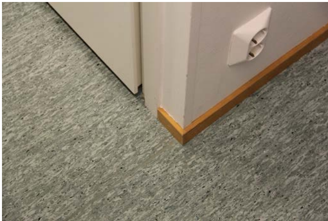
221. Vihreän vinylimatto on asennettu 2006.
