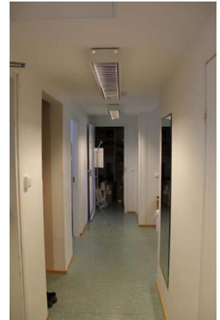
216. Toisen kerroksen asunnot on yhdistetty purkamalla huoneistoja erottanut lyhyt väliseinä. Huoneet sijoittuvat nyt pitkän yhteisen käytävän varrelle.
