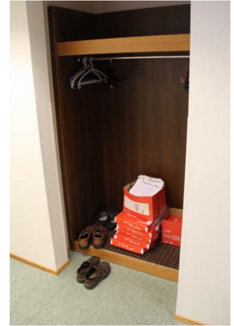
220. Poistetun ulko-oven paikalle tehty vävarastoakäytetään naulakkona. Laajennus ulottuu porrashuoneen puolelle.
