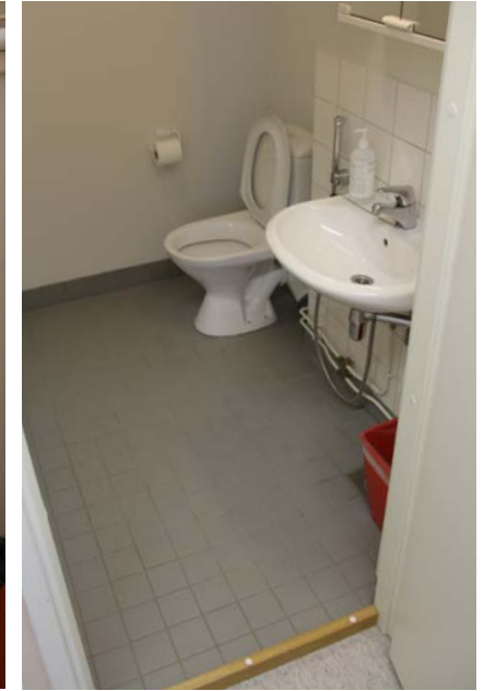
211. Ensimmäisen kerroksen wc:tä on laajennettu. Vesikalusteet ovat 2000-luvulta.
