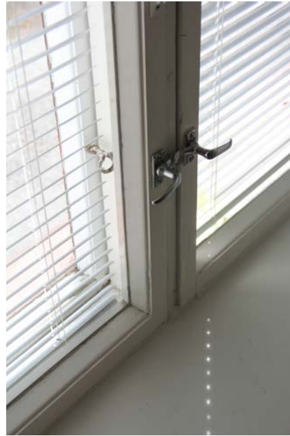
209. Asunto-osassa on alkuperäiset ikkunat. Ne ovat kaksipuitteisia sisään ja ulos avautuvia puuikkunoita.
