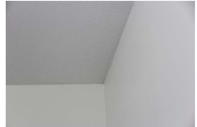
223. Seinän ja alakaton liittymä.
