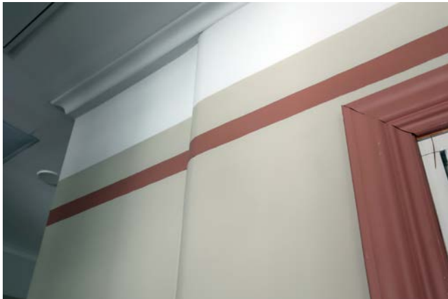
182. Seinän ja katon liittymä. Kattolista on yksinkertainen kovera puulista. Seinänylää osaa koristaa leveä punaruskea raita.
