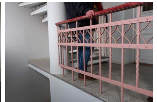
178. Toisen kerroksen vuonna 1964 tehty kerrostaso. Porras jatkuu kolmanteen kerrokseen kierteisenä.
