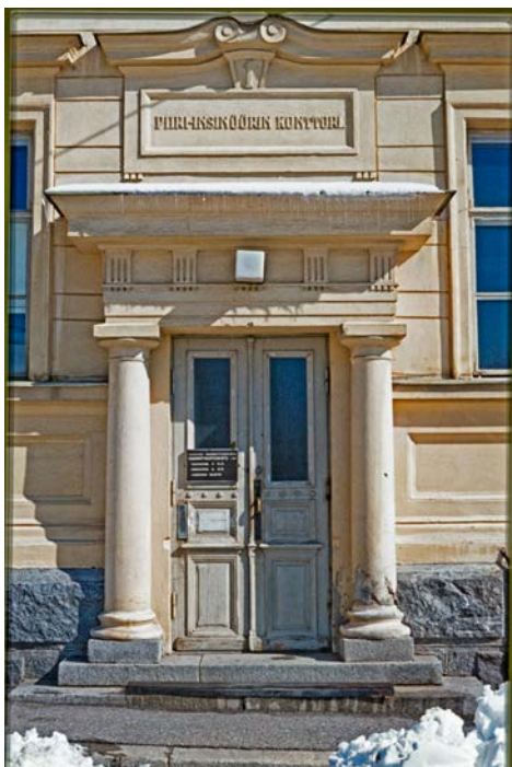
100. Pääsisäänkäynti ennen vuodelta 1975 ennen julkisivu-maalausta. KUVA: Kuopion museo, Helena Riekkö
