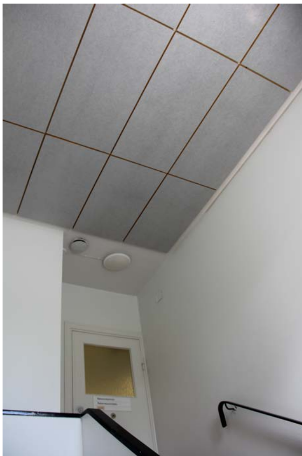
203. Alakattoon on asennettu akustiikkalevyjä. Porrashuone päättyy toisen kerroksen asuntojen ovelle.
