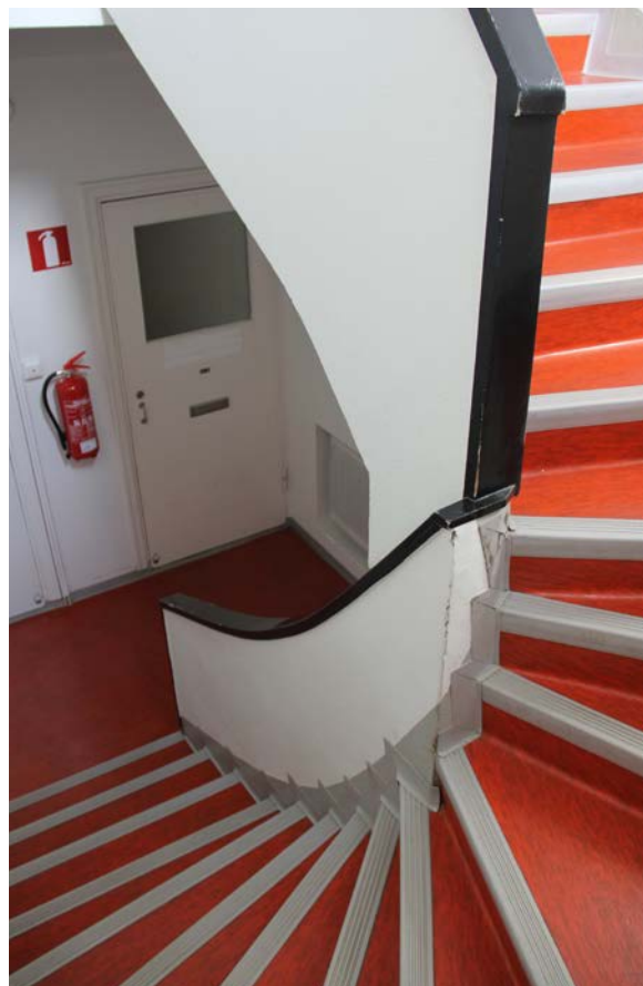
204. Porras kiertyy umpikaiteen ympärille. Askelmat on päällystetty punaisella vinyylimatolla ja harmaalla reunalistalla.
