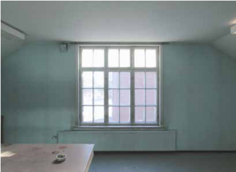
← Rakennuksen itä- osan toisen ker- roksen eteläpääty. Huonetilan levytys on 1970-luvun lo- pulla.
