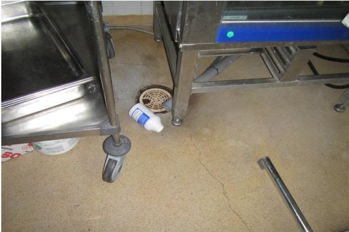
Kuva 11: Ravintolan keittiön lattian kunto vaatii saneerausta. Tila on ollut käyttämättä 1-2 vuotta.
