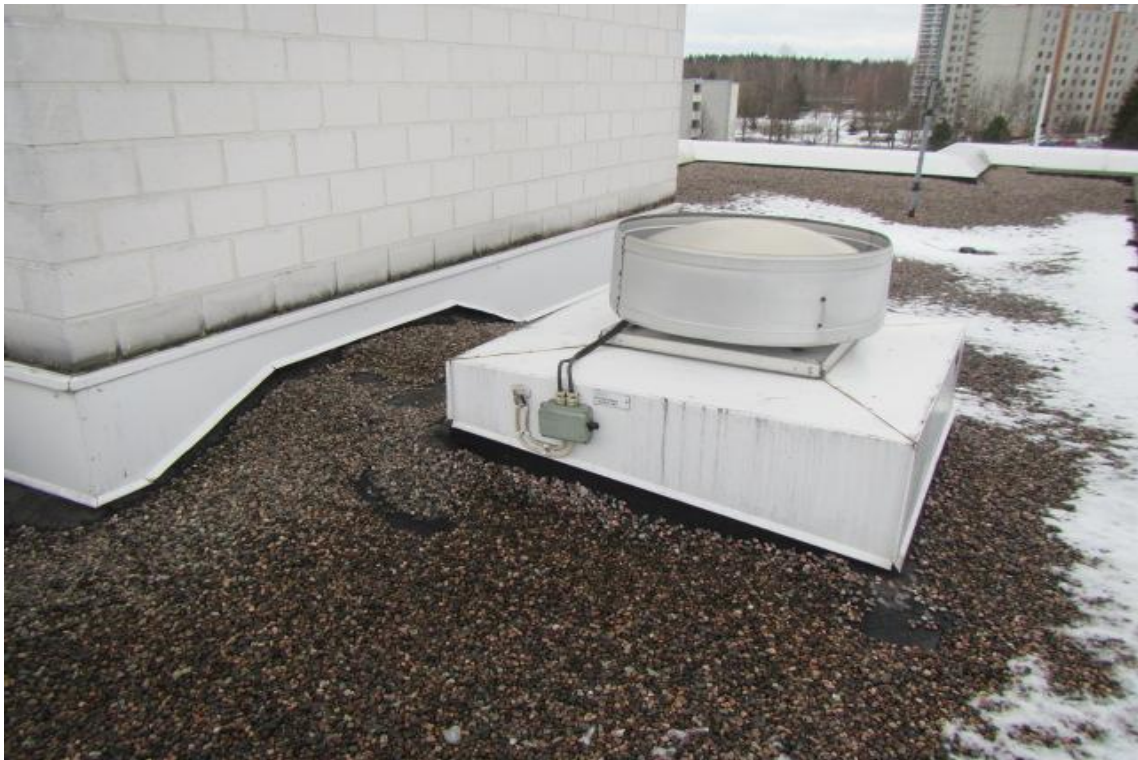
Kuva 15: Vesikatteen päällä on singelikerros.
