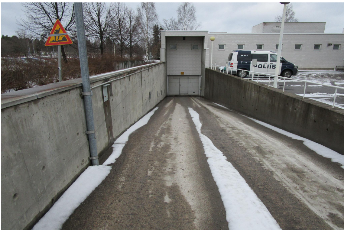
Kuva 2: Ajoluiskan lämmityskaapelit ehdotetaan uusittavaksi ajoluiskan uusimisen yhteydessä.
