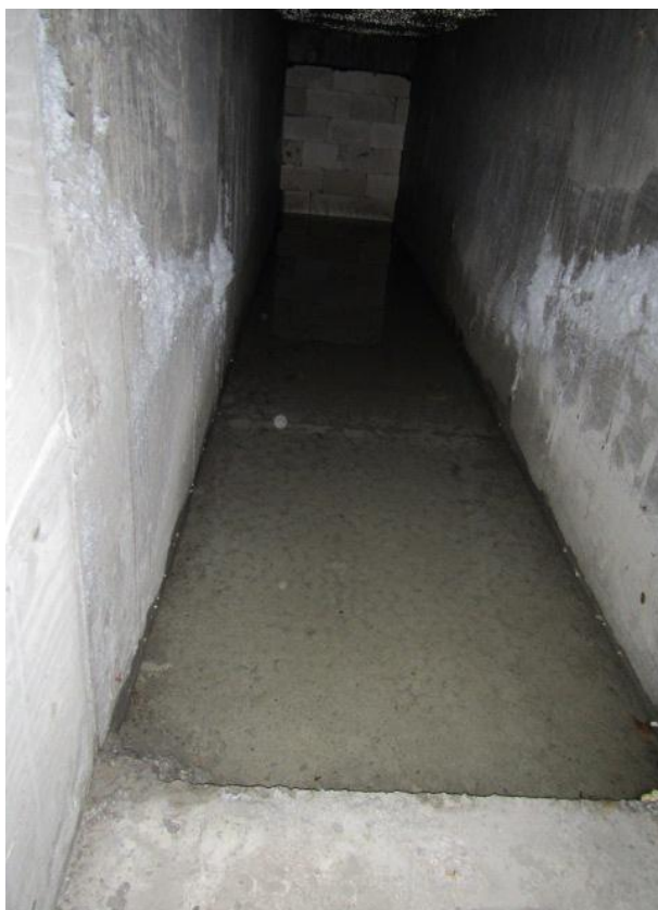
Kuva 3: Väestönsuojan varapoistumistien pohjalla on vettä katselmuksen aikana.
