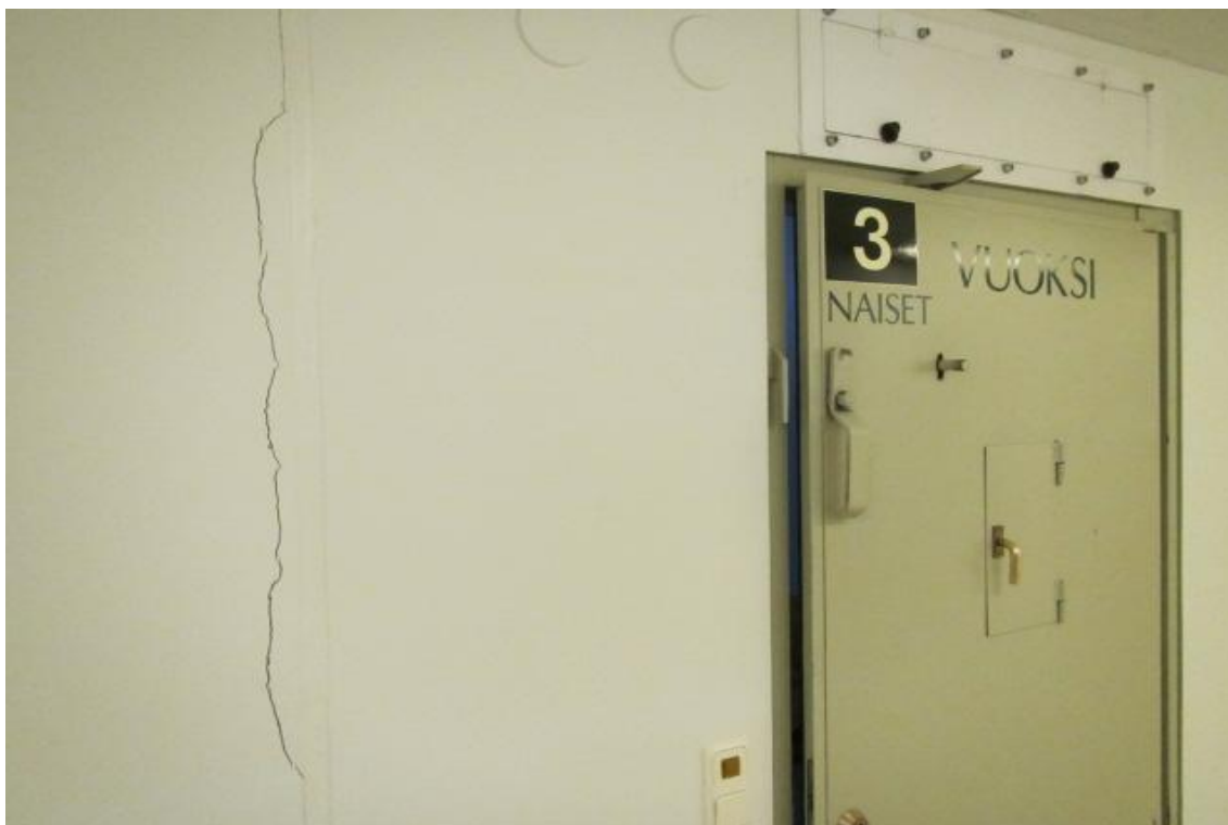
Kuva 4: Rakennuksen liikuntasauaman viereen muodostunut sauma osalla 3.
