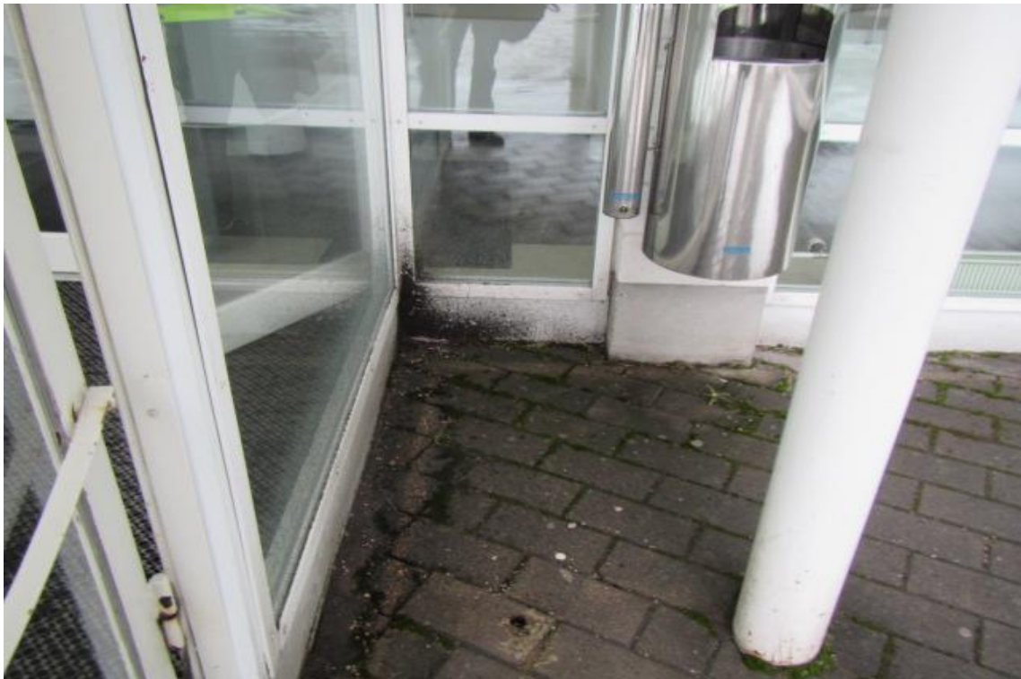
Kuva 16: Sokkelin nosto on matala ja roiskevesi lokaa sokkelin pintaa.
