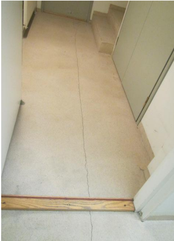
Kuva 5: Ulkoilupihan kohdalla rakennuksen leveysuunnassa on halkeama.
