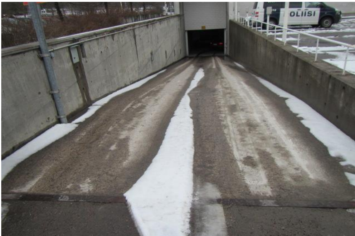
Kuva 8: Autohalliin johtavaan ajoluiskaan uusitaan lämmitys.
