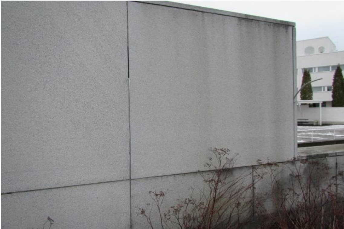
Kuva 9: Graniittijulkisivun saumaukset tulee uusida pohjoispuolella.
