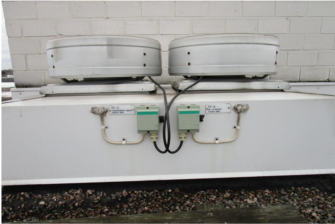
Kuva 5: Huippuimureita katolla.
