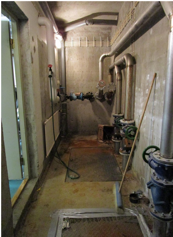
Kuva 2: Perusvesi- ja jätevesipumppaamot tulevat uusittavaksi tarkastelujakson lopussa.
