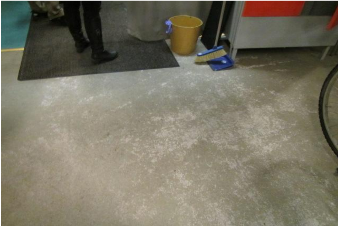
Kuva 1: Kellarikerroksen lattiapinnat ovat kuluneet erityisesti autohallissa.
