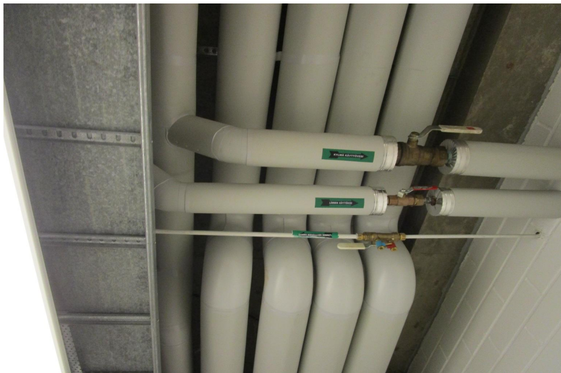
Kuva 4: Muovipinnoitteiset villakourueristeet ovat hyvässä kunnossa.
