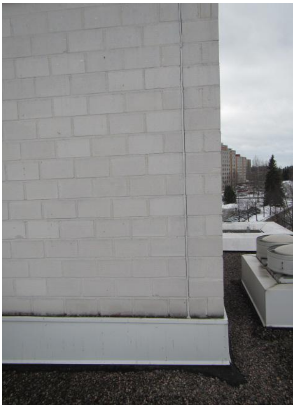
Kuva 12: Tiiliseinän liikuntasaumat tulee uusia tarkastelujakson alkupuolella. Juuripellitykset uusitaan vesikatteen yhteydessä.
