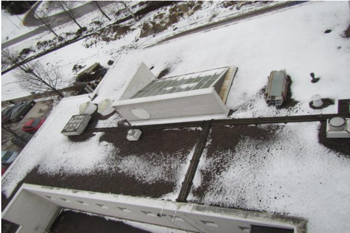
Kuva 13: Matalan osan 3 vesikatto. Katolla on kattoikkunoita 2-3 ja laajempi kattoikkuna.
