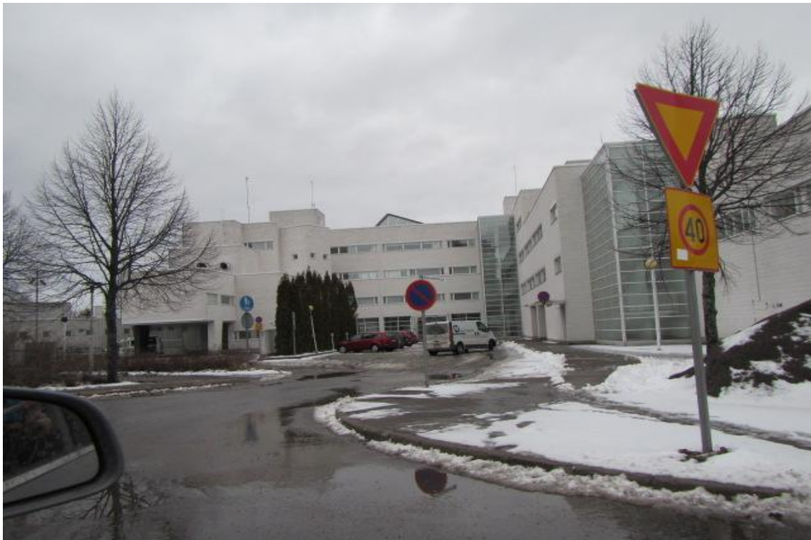
Kuva 14: Sisäpihan pinnoitteessa on halkemia. Kasvillisuus on hyväkuntoista.
