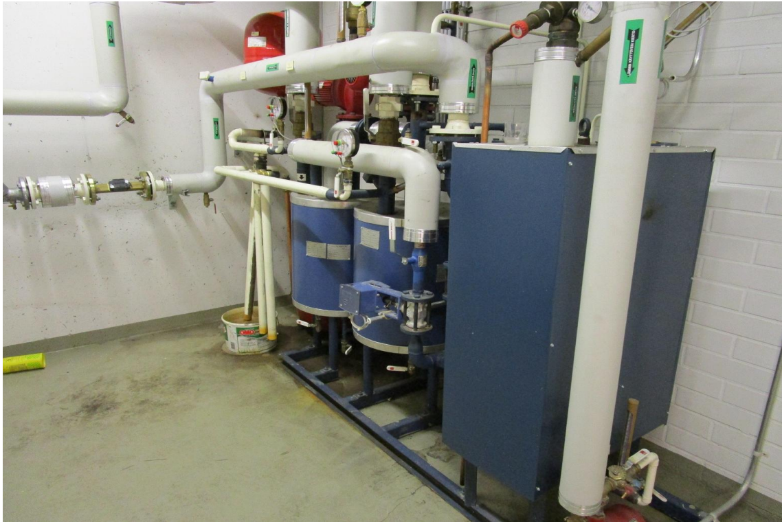
Kuva 1: Kaukolämmön jakokeskus tulee teknisen käyttöikänsä puolesta uusittavaksi tarkastelujakson loppupuolella.
