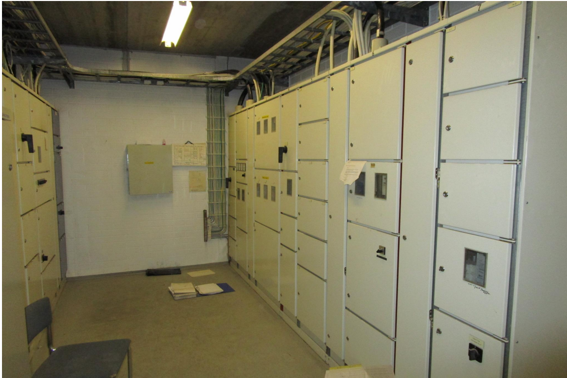
Kuva 3: Kiinteistön pääkeskushuone.
