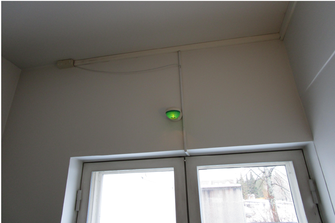
Kuva 4: Pääosa kiinteistön poistumistievalaisimista on alkuperäisiä kuvaopasteettomia valaisimia.
