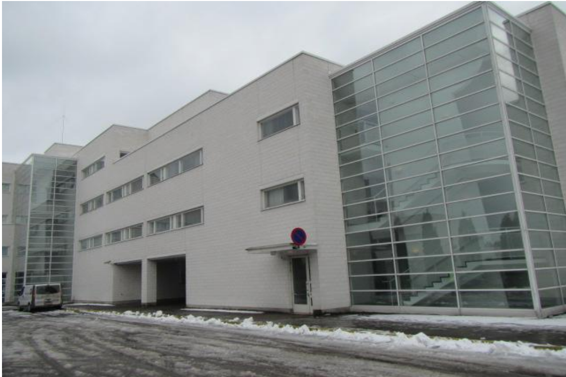
Kuva 7: Porrashuoneiden lasielementit uusitaan. Siiven keskivaiheille alikulkutien kohtaan on muodostunut halkeama läpi talon leveysuuntaan.
