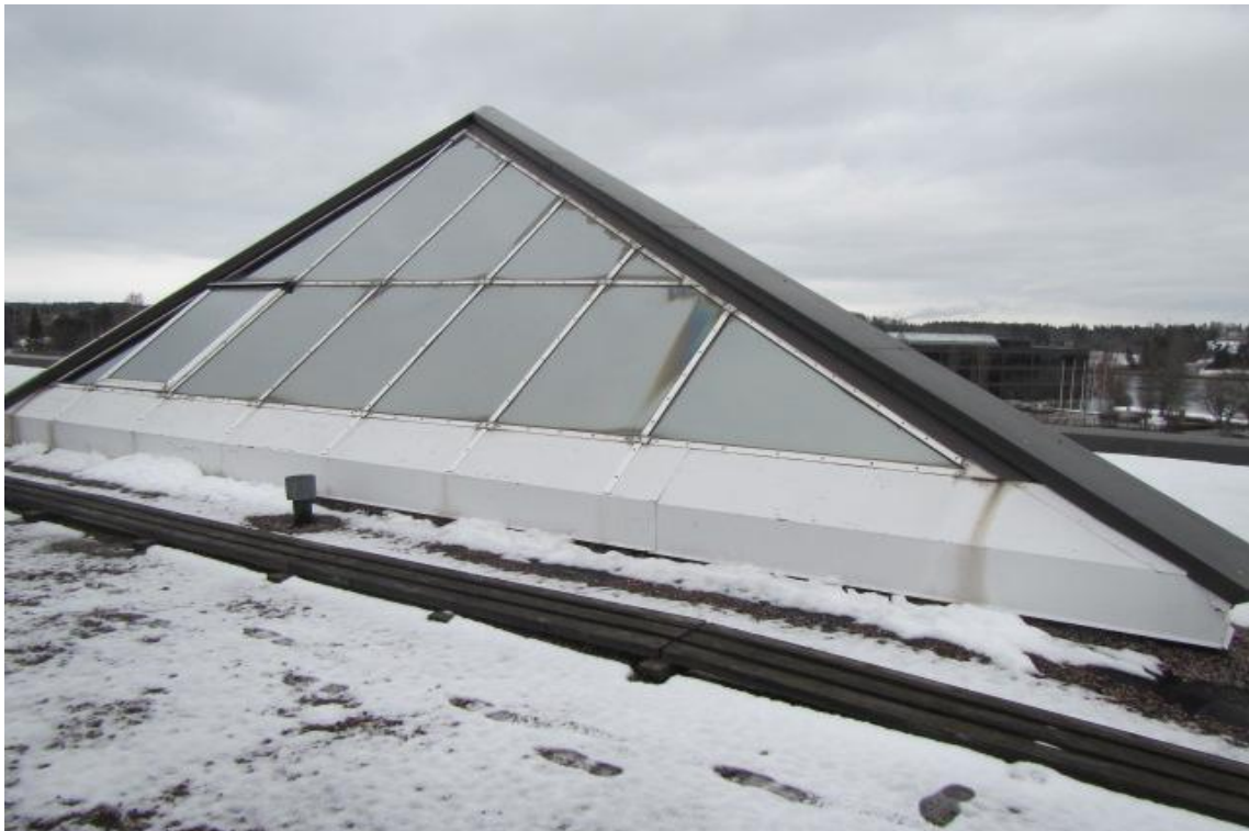
Kuva 10: Vesikaton kattoikkuna on osalla 2. Ikkuna on vuotanut kuvan vasemmasta laidasta.
