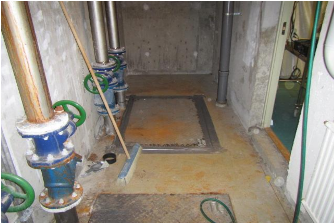
Kuva 2: Kellarikerroksen pumppaamon huone tuoksuu viereiseen tilaan.
