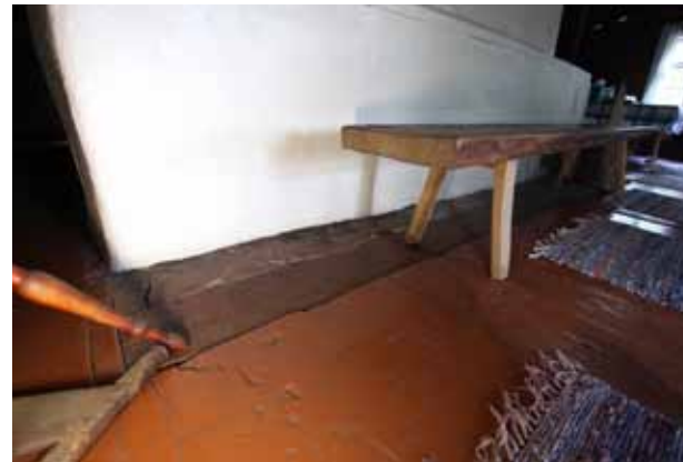
Lattialautojen ja uunin kyljen välissä on lauta.
