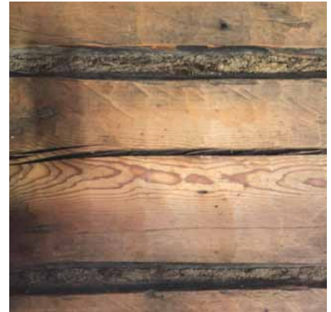
Yksityiskohta piilutusta ja tilkitystä hirsiseinästä.
