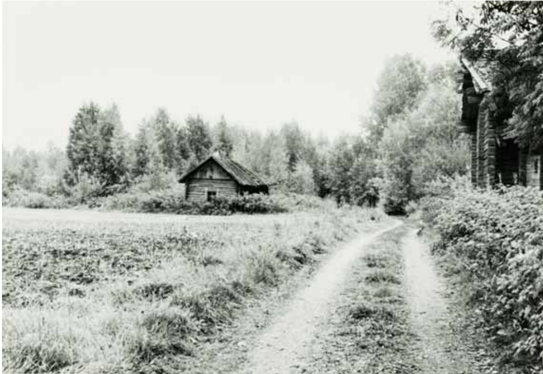
Näkymä Yläkujalta kohti saunaa ennen korjauksia vuonna 1984. Kuva: Matti Laamanen / MV RHO.
