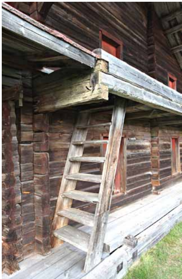
Porras johtaa puiselta "sillalta" parvelle, josta astutaan yläaittaan ja Mikon aittaan.
