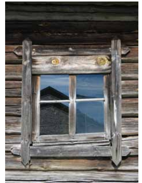
Löylyhuoneen ikkuna vuonna 2016.
