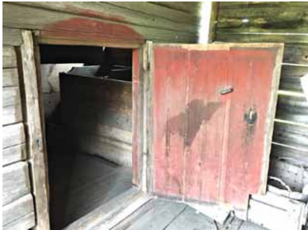
Isoon riistaitaan johtava ovi väliköstä kuvattuna.
