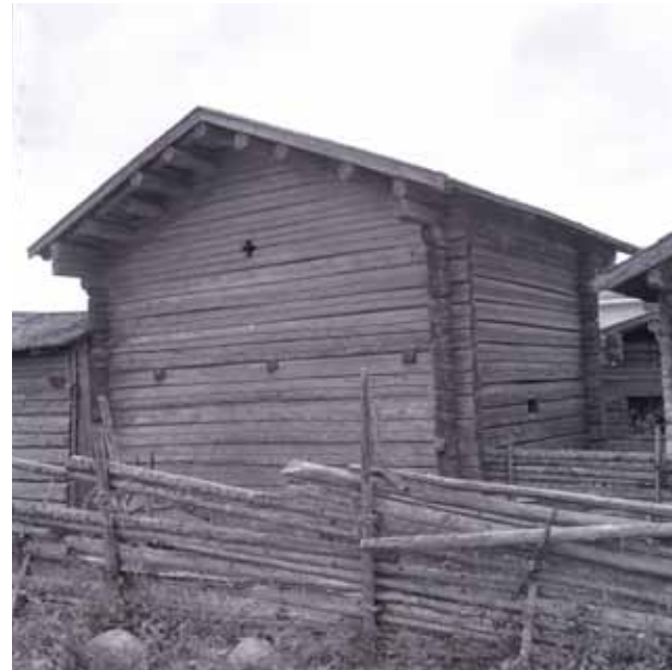
Vanha talli ja Yläkujan riukuaitaa vuonna 1960. Kuva: Osmo Vuoristo / MV KK.
