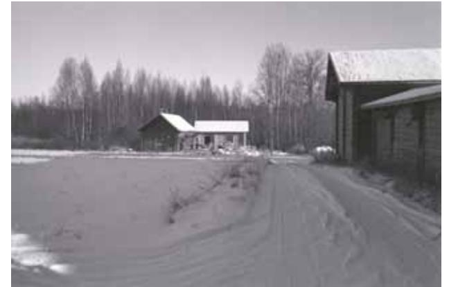
Näkymä Yläkujalta kohti Huoltorakennusta vuonna 1988. Kuva: Matti Laamanen / MV RHO.
