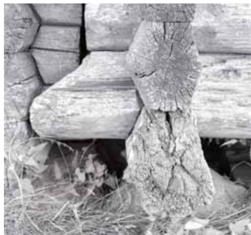
1700-luvun lopun rakennustapaa: Jauhoaitan muotoillut pelkkahirret ja sulkaurkka. Kuva: Osmo Vuoristo 1960 / MV KK.
