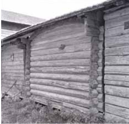
Jauho- ja Piikoin aitan haljaslaipiot ja päätykonsolit vuonna 1960. Kuva: Osmo Vuoristo / MV KK.
