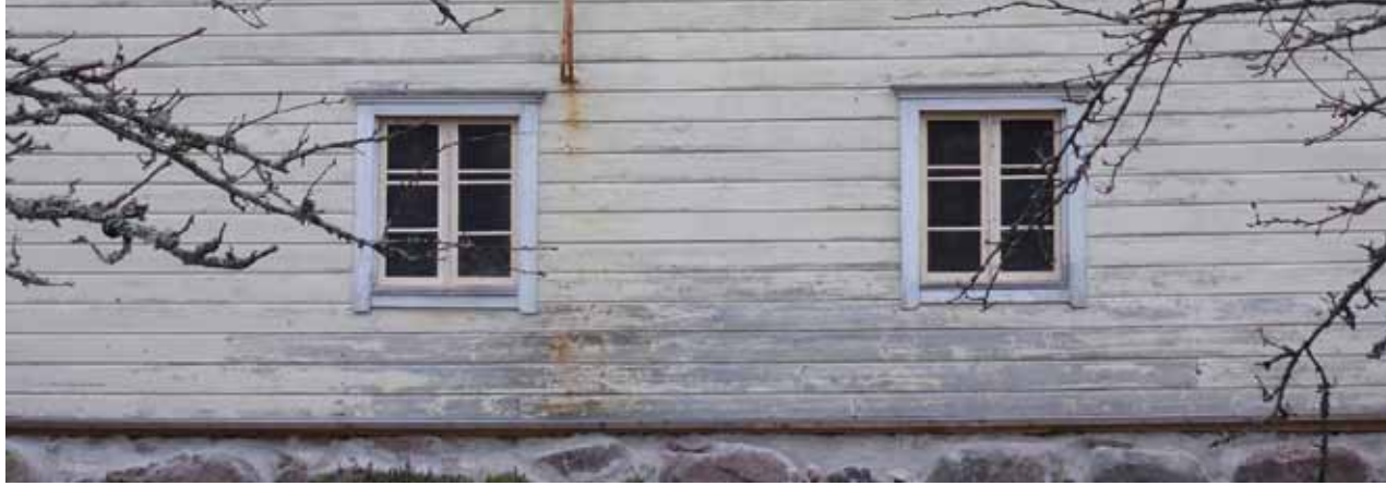
Ulkopuitteiden paikalle asennettiin korjausten ajaksi vaneriset suojalevyt, joihin oli maalattu puitejako. Näin talo ei näyttäisi hylätyltä eikä ehkä kohtaisi ilkkivaltaa.
