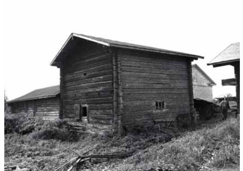
Hevostalli ennen 1980-luvun korjaushankkeen kunnostuksia. Kuva: MV REST.
