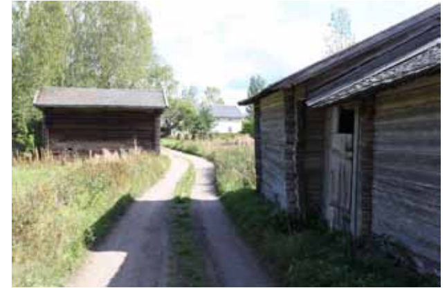
Näkymä Yläkujalta lähestyttäessä Lyttikkälää. Oikealla ovat Riistaitat, vasemmalla Riihi. Keskellä pilkottaa Päärakennuksen länsijulkisivu. Kuva on elokuulta 2018.
