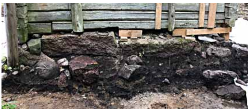
Kaivaukset paljastivat aiemman, erittäin massiiviselta vaikuttaneen kivisaunan perustukset. Kuva on otettu saunan itäpäädyssä vuonna 2018.
