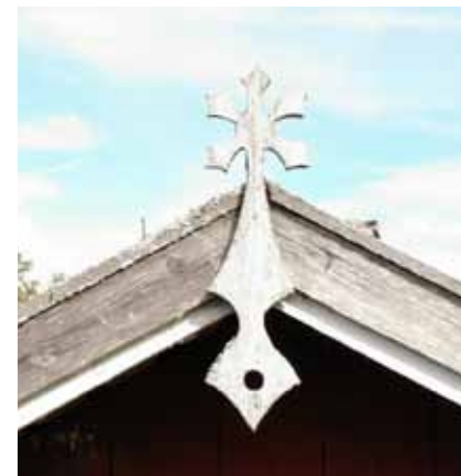
1980-luvulla rekonstruoidun Navetan katoksen päätykoriste, joka on aiempaan verrattuna ylösalaisin.
