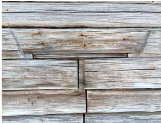
Savutuvan ikkunan paikka itäseinässä.
