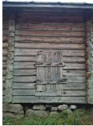
Tyhjennysluukku karjakujan puolella.
