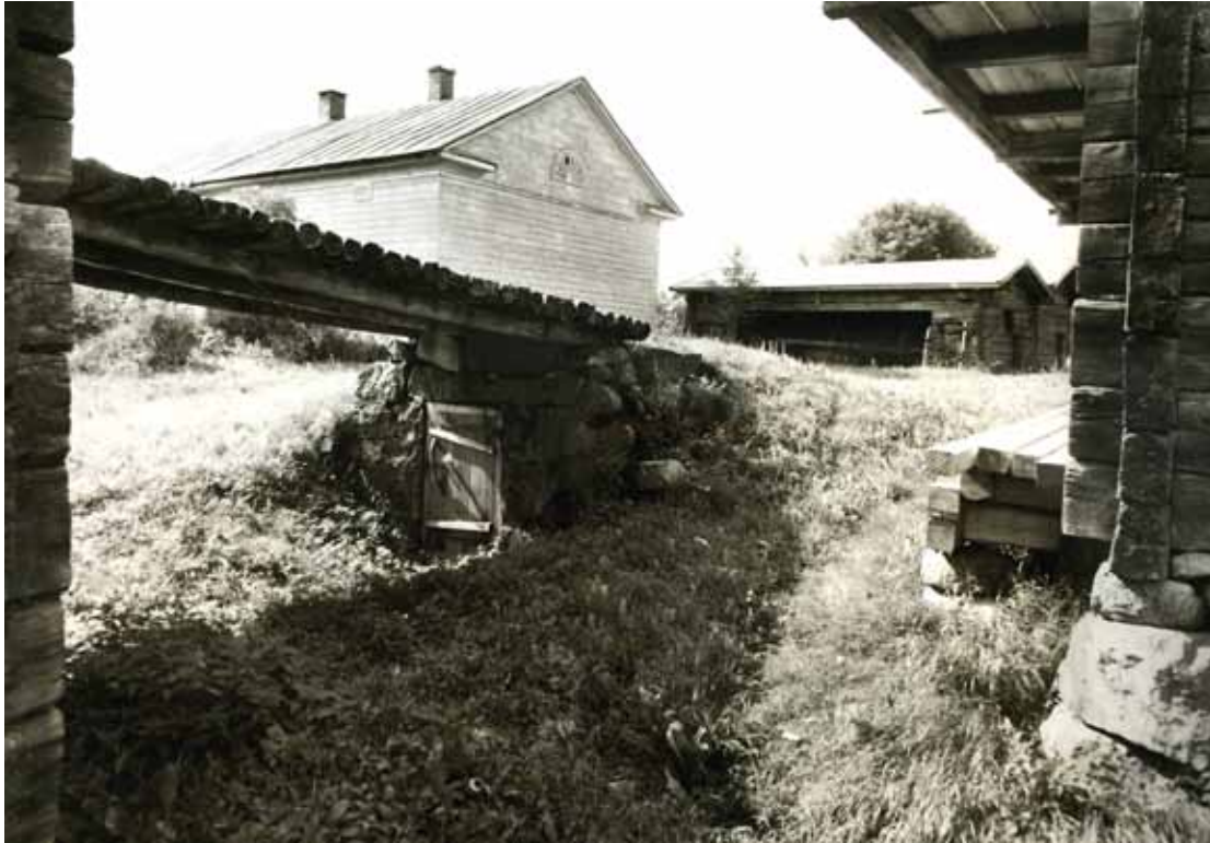
1980-luvun kuvassa kellarin ovi näyttää korjatulta. Kuva: P. O. Welin / MV RHO.
