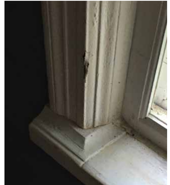
Kyökin ikkunan listoitus ja vesipenkki poikkeavat muista ikkunoista, ja ikkuna on asennettu julkisivupintaan nähden muita sisemmäksi. Ikkuna saattaa olla muita vanhempi.
