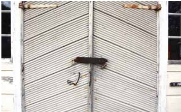
Ulko-ovissa on vinopanelointi helmirihlotuin laudoin, rautasaranat pitkällä saranalehdellä ja kierteinen vedin.
