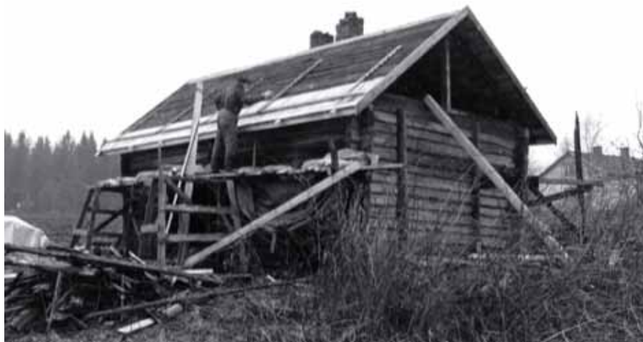
Saunan korjaustöitä 1980-luvulla. Kuva: MV REST.
