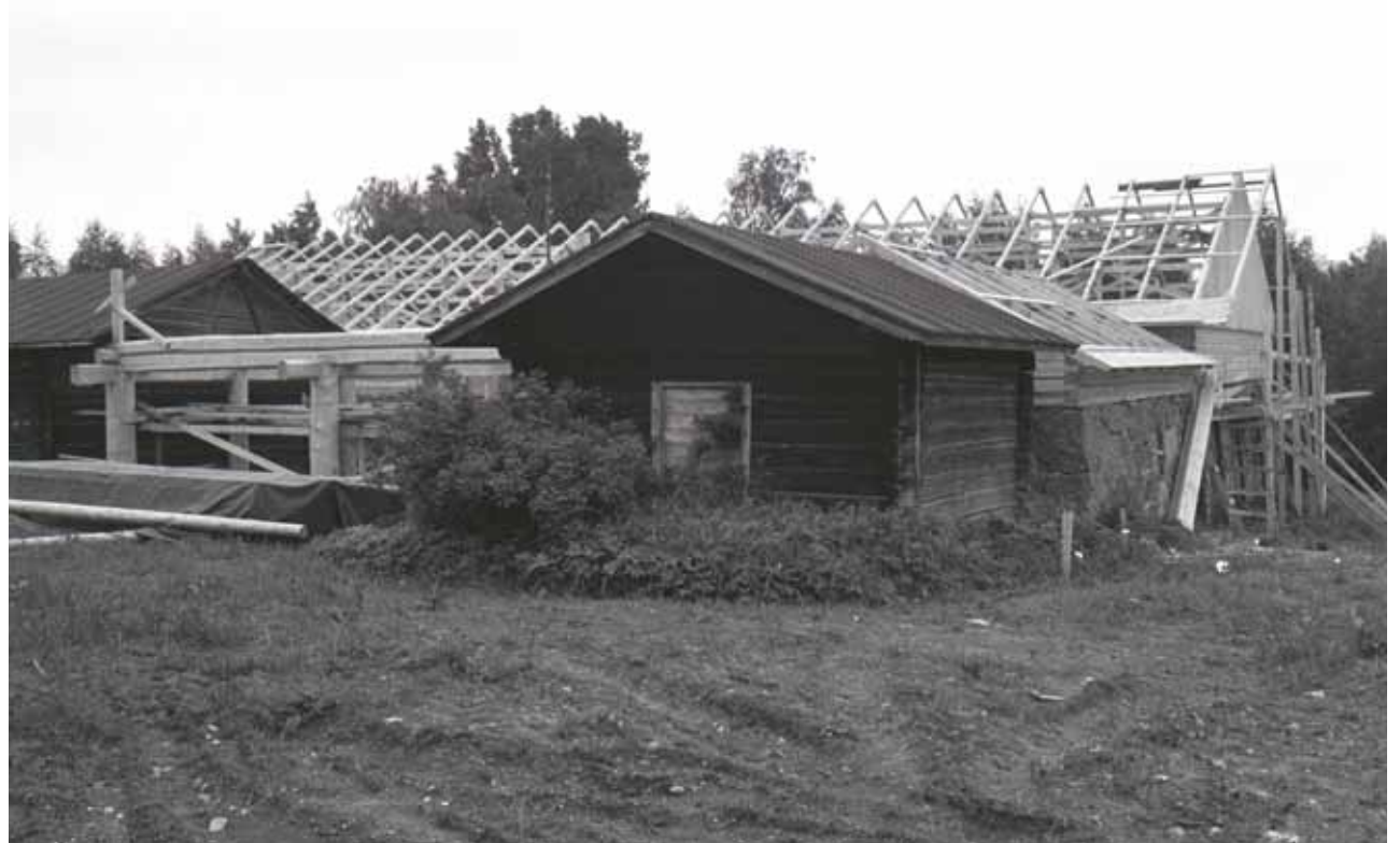
Kartanomuan aitan takana rakennetaan Navetan kattoa ja katoksen rekonstruktiota vuonna 1988. Kuva: Matti Laamanen / MV RHO.
