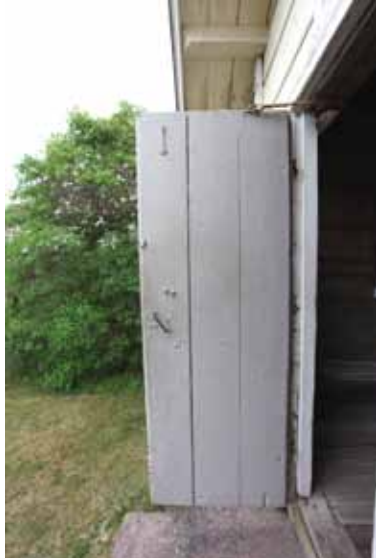
Ulko-oven runkona on kolme pystylautaa.
