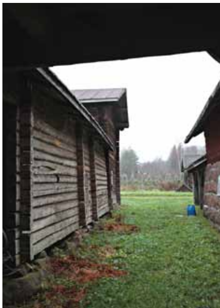
Kuja vuonna 2014; vasemmalla Vajarakennus ja Hevostalli, oikealla Navettarakennus.
