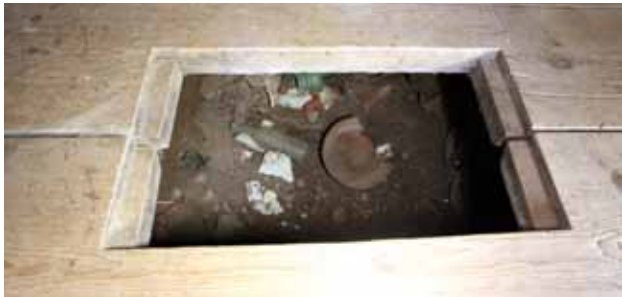
Kyökin lattialuukku on avattavissa.
