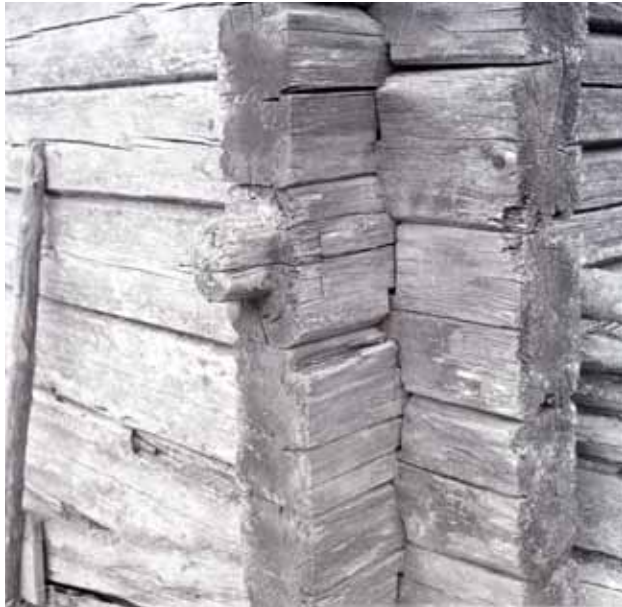
Vanhan tallin nurkkasalvain neljänneen vuonna 1960. Kuva: Osmo Vuoristo / MV KK.
