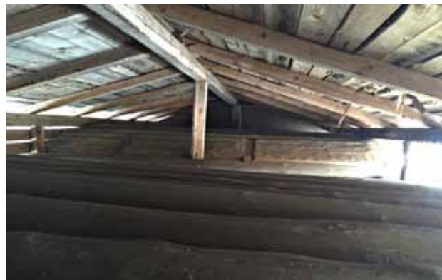
Jauho- ja Piikoin aitan haljasholvit ylhäältä kuvattuina.
