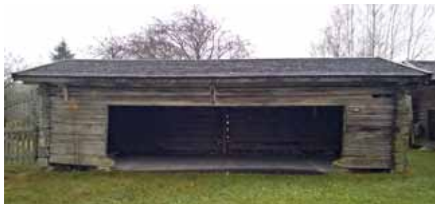
Etuseinässä alimpina on vanhat, katkaistut pelkkahirret.
