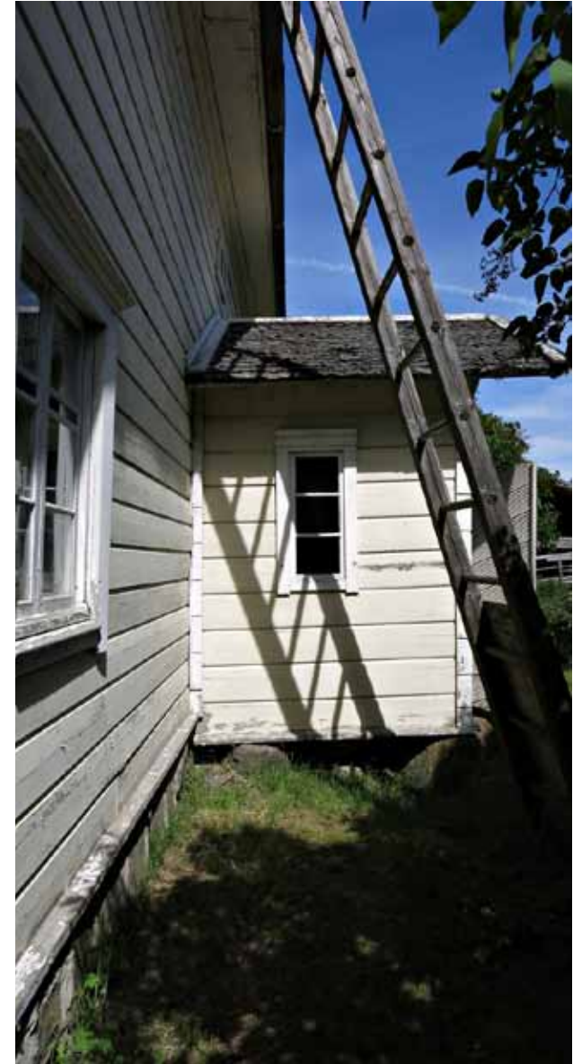
Talon vuorilaudoituksen helmassa on vesilista. "Harkotettu" lista peittää kuistin ja talon rungon liittymiskohdan.
