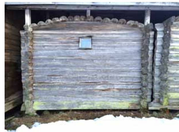
Piikoin ja Jauhoaitan pelkkahirret ja päädyn ylin hirsikerta on päistään muotoiltu. Etu- ja takaseinällä kolmen ylimmäisen sivuhirren päät on alun perin muotoiltu pitkiksi konsoleiksi. Aitoissa on haljaksista tehdyt, holvimaiset laipiot.
