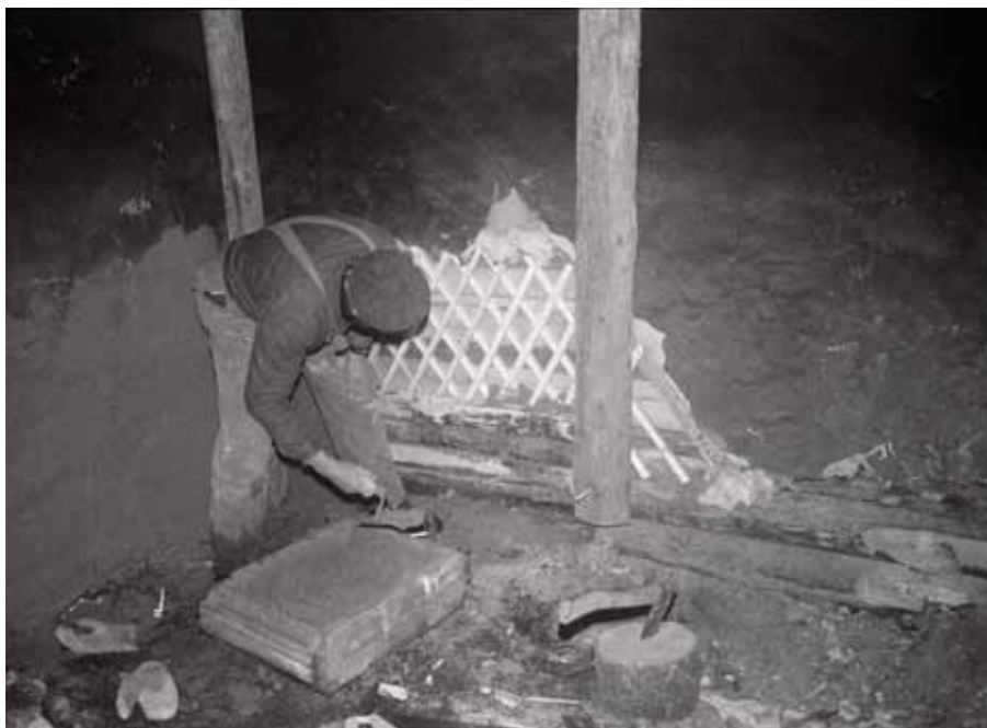
Saunan seinärappauksen korjausmenossa vuonna 1988. Verkkona on käytetty tikkujen lisäksi sinkittyä katiskaa. Kuva: Matti Laamanen / MV RHO.
