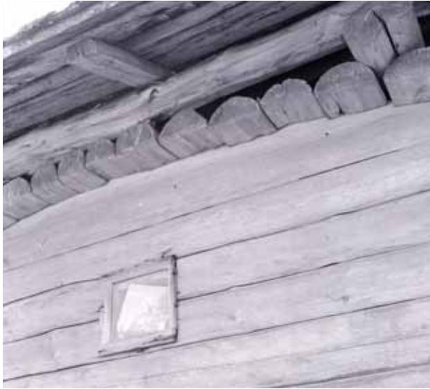
Piikoin aitan takaseinää ja kattoa vuonna 1960. Kuva: Osmo Vuoristo / MV KK.
