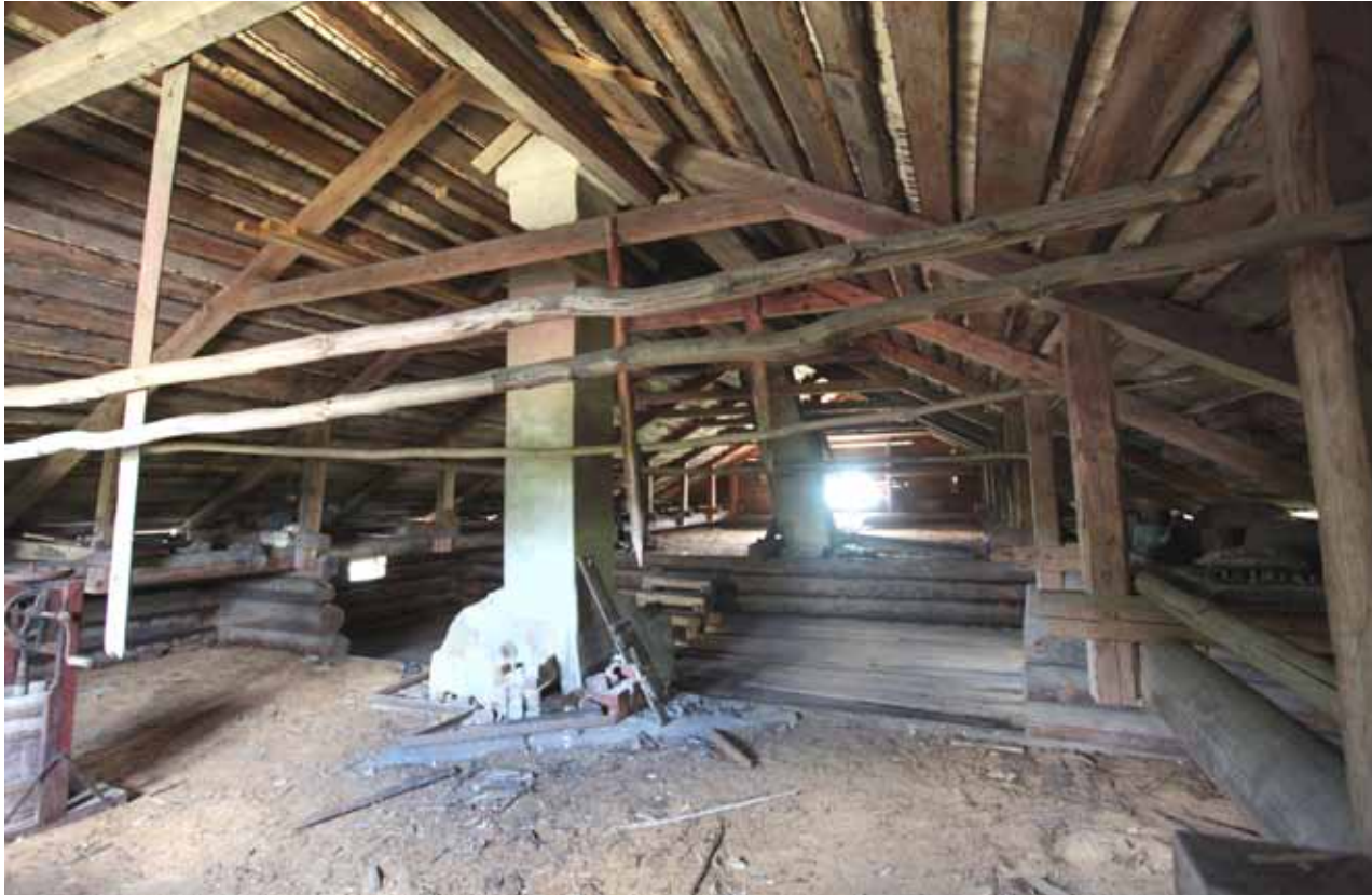
Kuva ullakolta takakammarin yläpuolelta, keskellä kyökin ja kammareiden yhteinen savupiippu. Taaempana tuvan uunin piippu.
