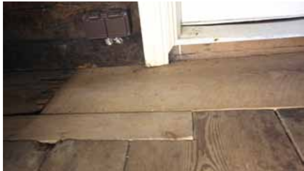
Paikkakorjauksia oven edustalla.
