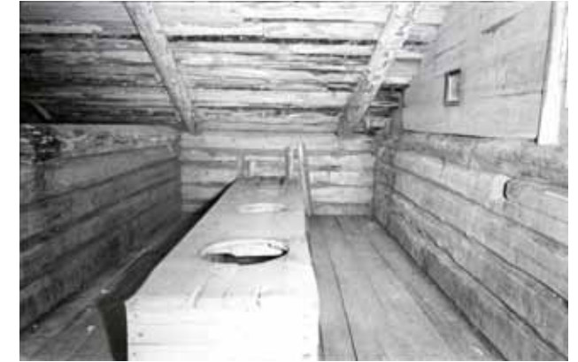
Käymälän lattia on viisi hirttä tasakertaa alempana. Istuin-osa on keskellä lattiaa, joten siinä voidaan istua kahdelta suunnalta. Etummainen reikä on ”Mikon reikä”. Kuva: Osmo Vuoristo 1960 / MV KK,
