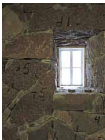
Navetan ikkunoita vuonna 2018.
