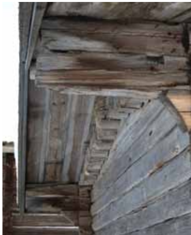
1700-luvun lopulla rakennetuksi arvioidun Jauhoaitan konsolihirret.
