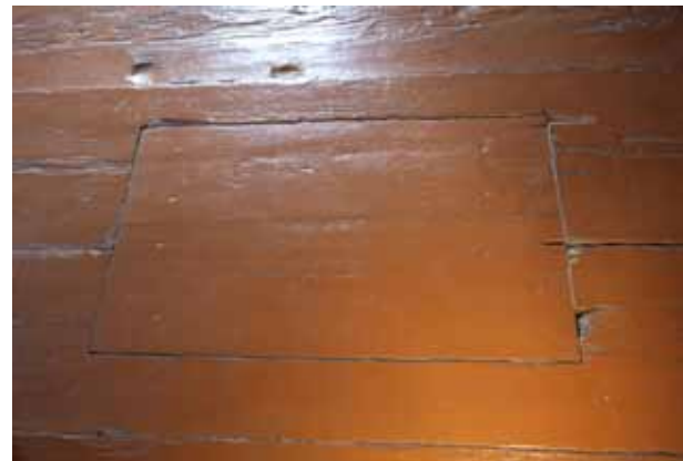
Tuvan lattiassa oleva siivousluukku on ruuvattu kiinni.
