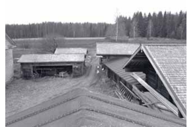
Kolmen aitan rivi jätettiin 1980-luvun restauroinnissa huopakattoiseksi. Kuva: Matti Laamanen, 1986 / MV RHO.
