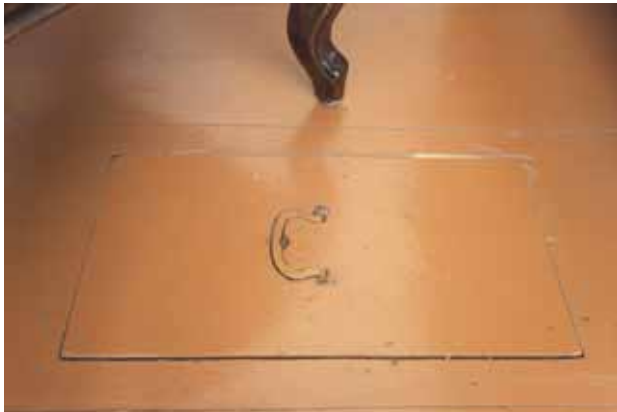
Takakammarin lattiassa on siivousluukku, jossa on taottu, luukkuun uppoava rautakahva. Luukku on ruuvattu kiinni.
