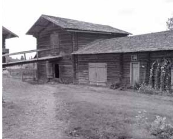
Hevostalli pärekattoisena vuonna 1960. Oikealla osa Vajarakennusta (kärryliiteri ja käymälä). Kuva: Osmo Vuoristo / MV KK.
