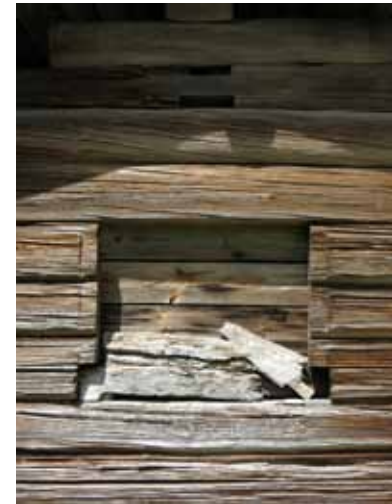
Myös liiterin pohjoispäädyssä on entisen kammarinikkunan aukko.
