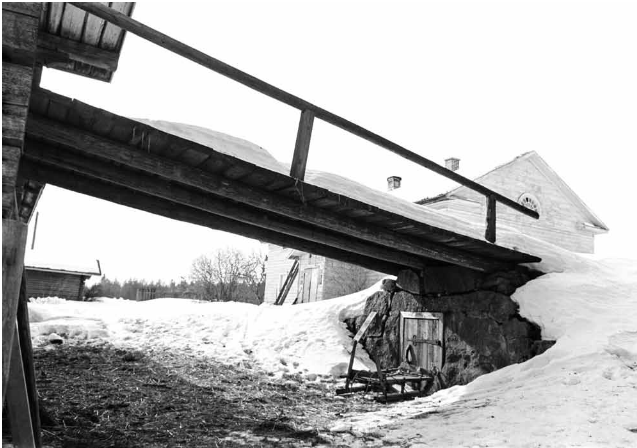
Hevostallin ajosilta ja kellarin ovi vuonna 1963. Kuva: Osmo Vuoristo / MV KK.
