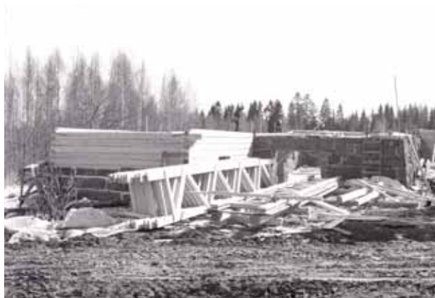
Navetan sikopajan rakennustyömaa vuonna 1987. Kuva: Matti Laamanen / MV RHO.
