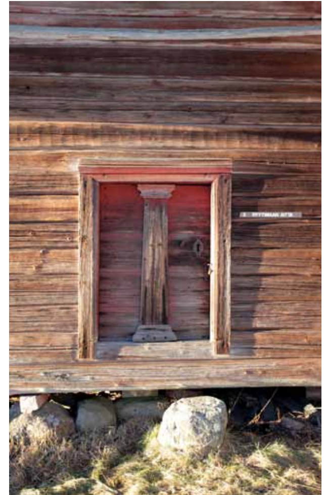
Aitan alapohja tuulettuu hyvin. Auringonvalo korostaa piiluumistyön jälkeä.
