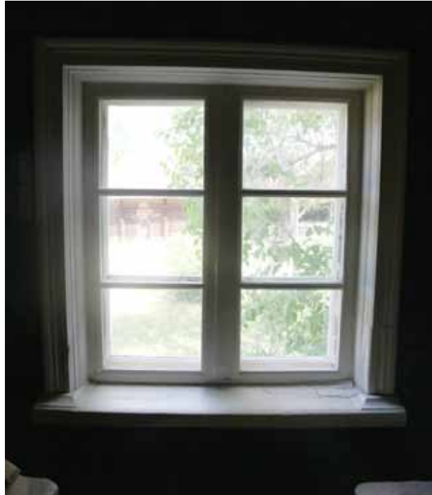
Kyökin urapuiteikkunassa ei ole koristeellisia lävistyksiä eikä värilaseja.
