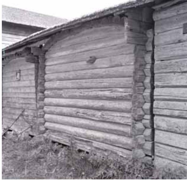
Jauhoaitan ja Piikoin aitan haljaslaipiot ja päätykonsolit vuonna 1960. Kuva: Osmo Vuoristo / MV KK.
