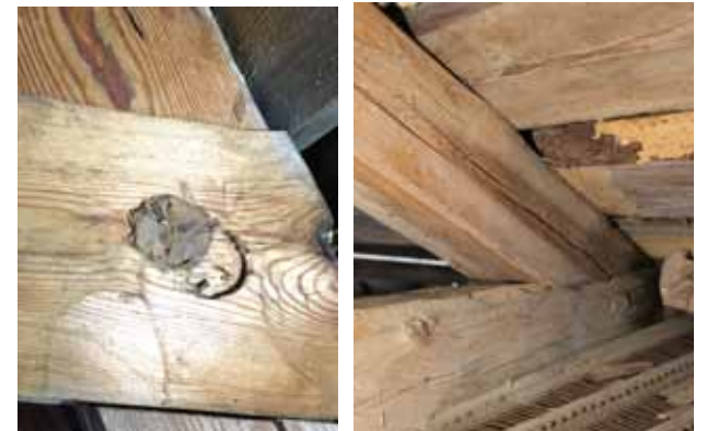
Konttipuun ja selkäpuun puutappiliitoksia.
