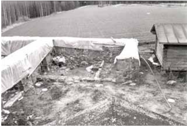
Karjakeittiö ja maitohuone suojaressun alla vuonna 1986. Kuva: Heikki Ahtiainen / MV RHO.
