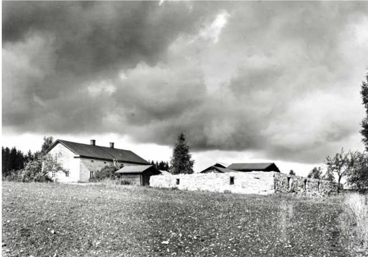
Navetta 1980-luvulla. Navetan vasemmalla puolella Kartanomuan aitta ja Päärakennus. Kuva: P. O. Welin / MV RHO.
