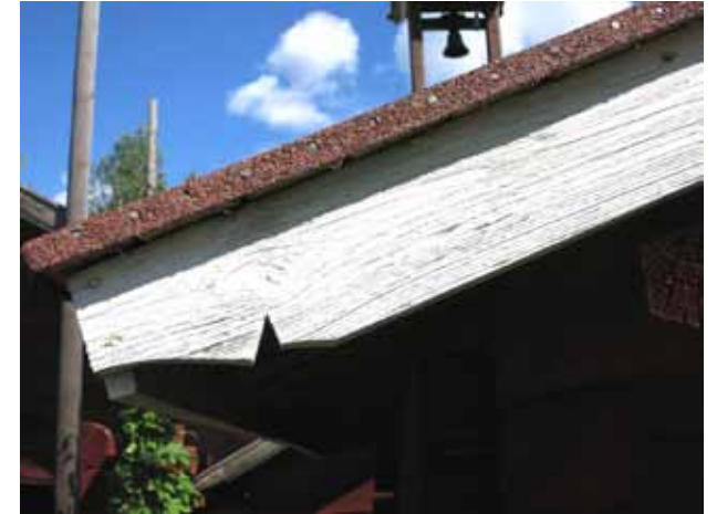
Otsalautojen päähän on muotoiltu tippanokka.
