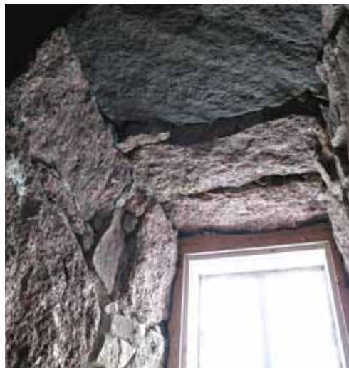
Suurlievän ikkuna-aukko 1980-luvun ikkunoineen.
