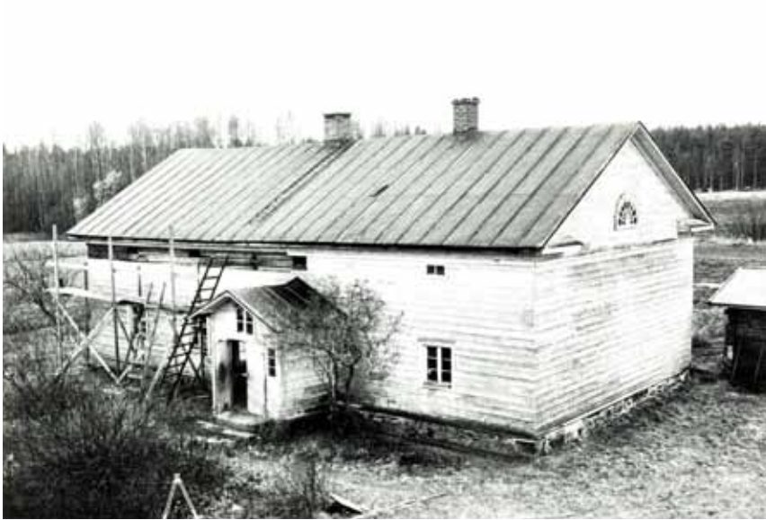
Päärakennuksen julkisivukorjaustöitä vuonna 1986. Kuva: MV RHO.
