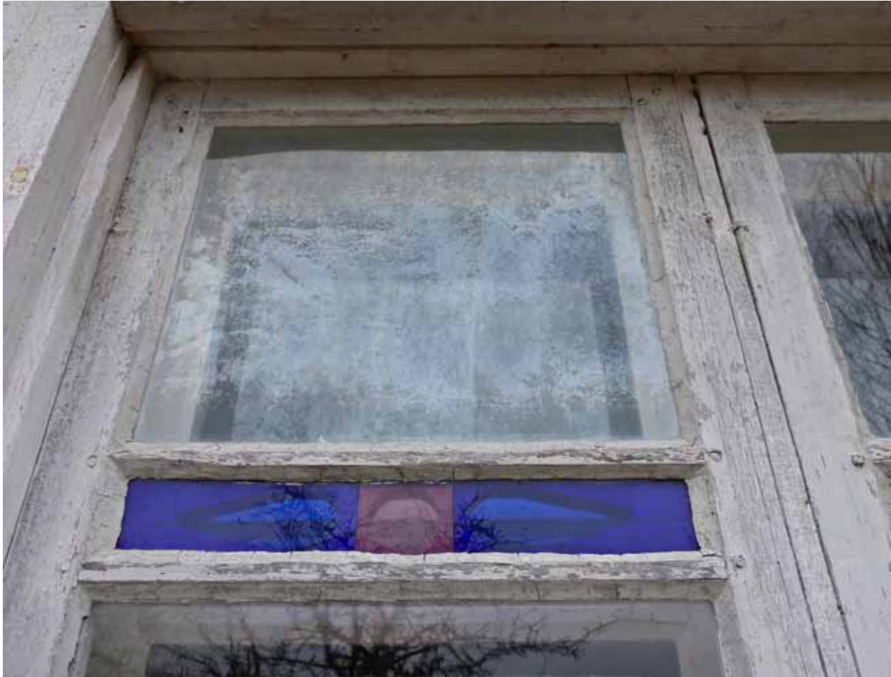
Värilaseja ulkopuolelta kuvattuna. Kuva: Matti Valkonen, 2017.
