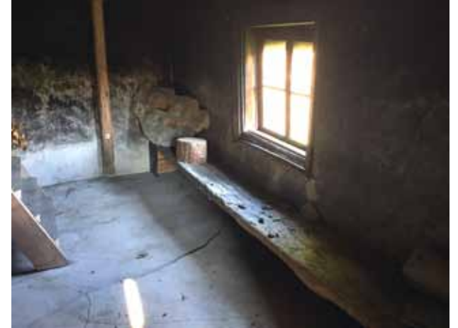
Löylyhuoneen ikkunaseinällä on penkki ja sen yläpuolella kuivatusorsi.
