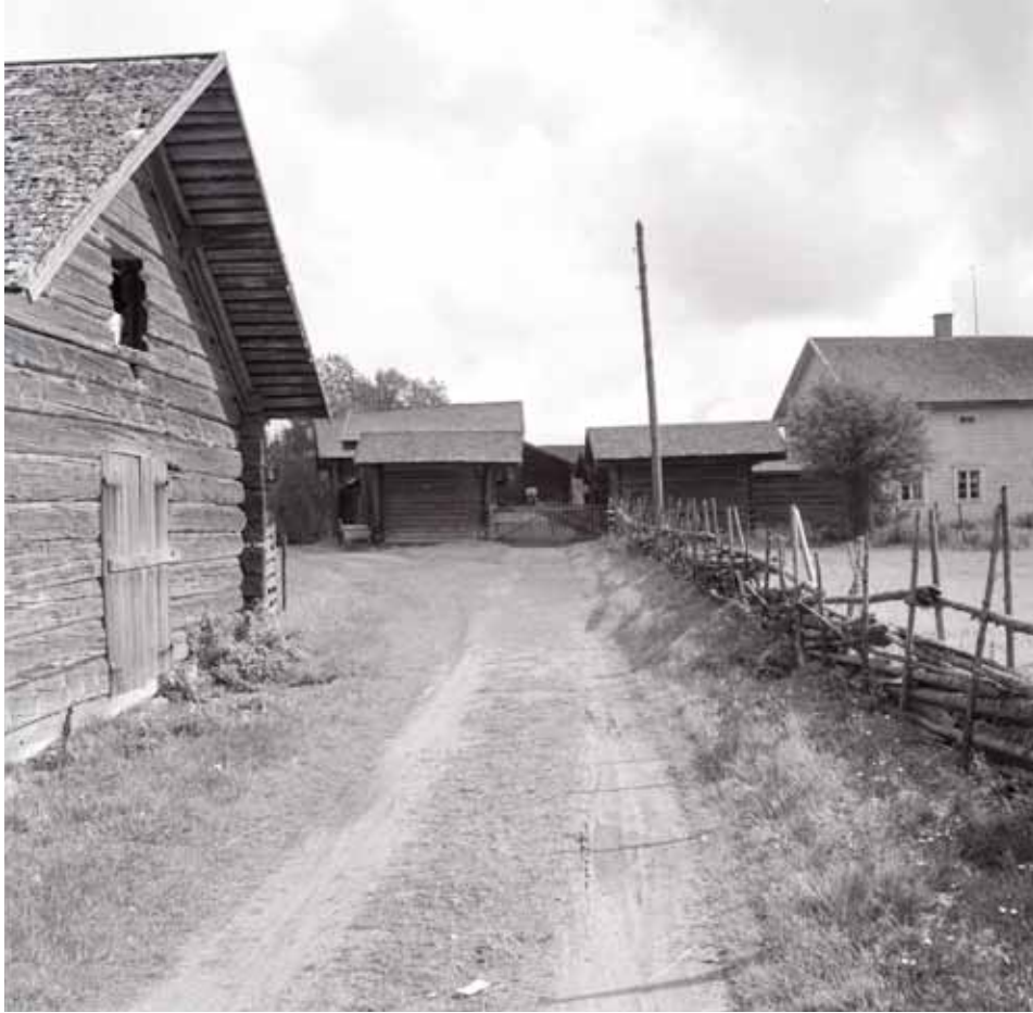
Lyytikälän entisen päärakennuksen ladoksi (P022) muutettu tupa vuonna 1960 Yläkujan varrella. Kuva: Osmo Vuoristo / MV KK.
