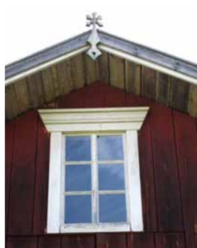
Vanhan mallin mukaan tehty ikkuna.
