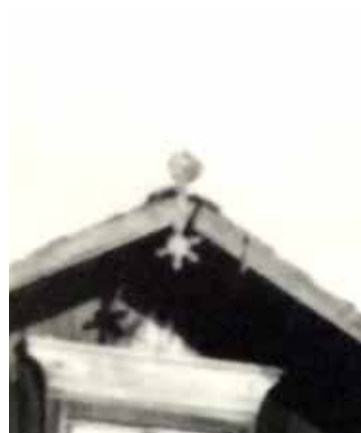
Navetan katoksen tähtimäinen päätykoriste vuonna 1962. Kuva (osa): Osmo Vuoristo / MV KK.
