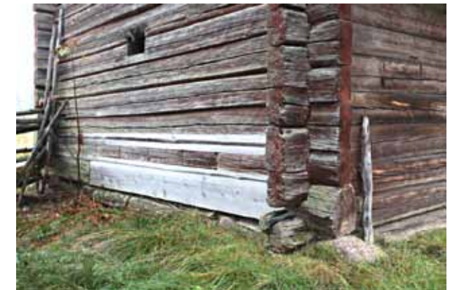
Sivuseinän valoaukko ja vuoden 2009 hirsipaikkauksia.
