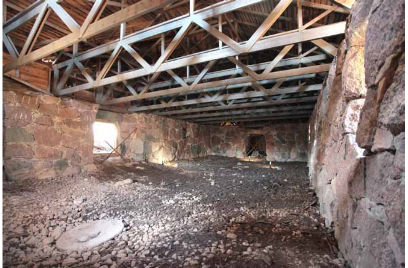
Navetan 1980-luvun lopun kattorakenteita.
