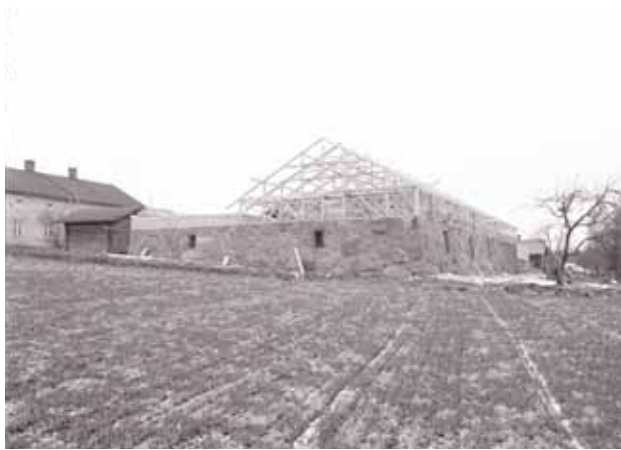
Kattorakenteet työn alla 1980-luvulla . Kuva: MV RHO.
