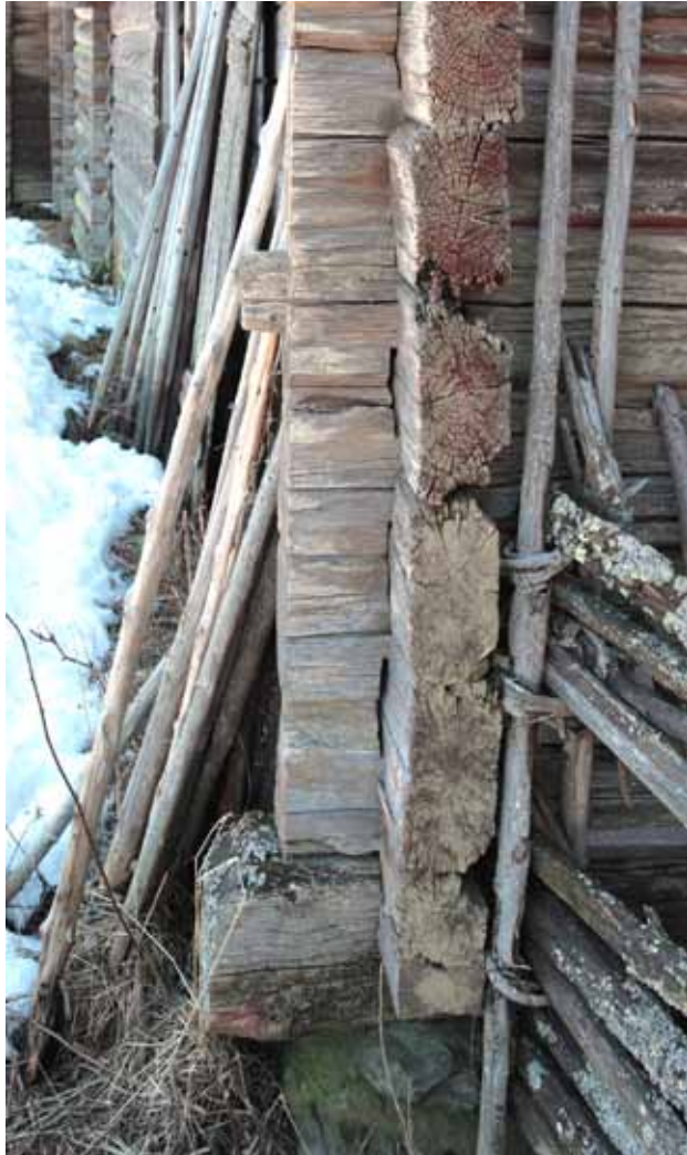
Pelkkahirren pää takaseinällä ja hirren "nenä".
