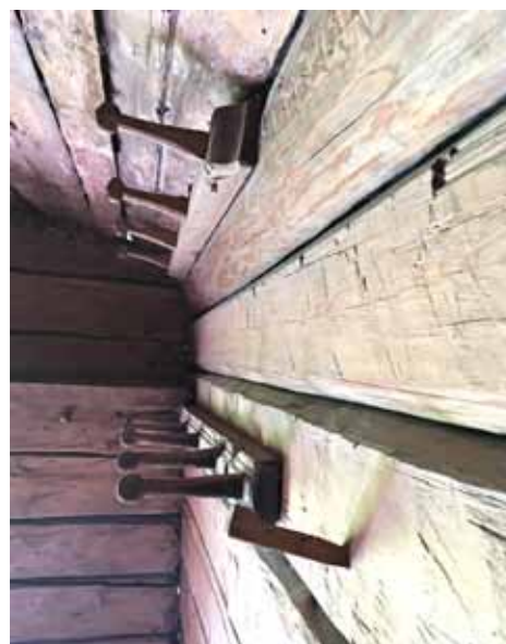
Kirveen työstöjälkeä ja vaatenaulakoita sivuseinässä.
