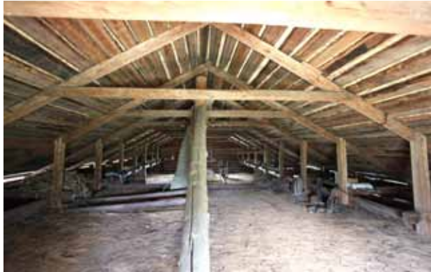
Ullakko kuvattuna kohti pohjoispäätä. Keskellä ansas.
