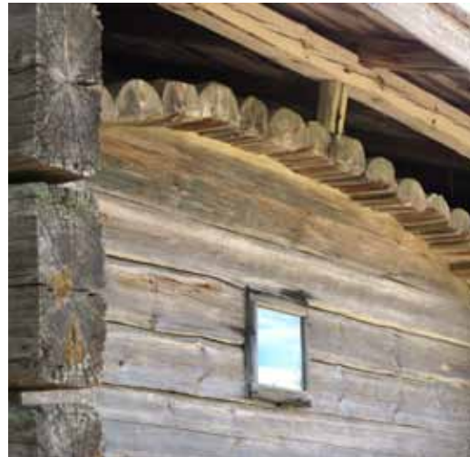
1700-luvun lopulla rakennetuksi arvioidun Piikoin aitan pohjoispäätä haljasmaipioineen.
