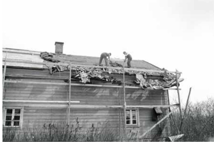
Vanhaa pärekattoa puretaan vuonna 1988. Kuva: Matti Laamanen / MV RHO.
