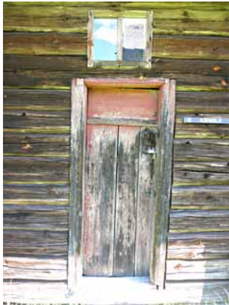
Oven yllä on tapitettu, naulakiinnitetty ikkuna.
