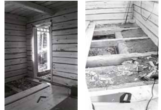
Huoltorakennuksen uudisrakennusvaiheen sisäkuivissa vuodelta 1989 näkyy multapenkki. Kuvat: P. Kärki / MV RHO.
