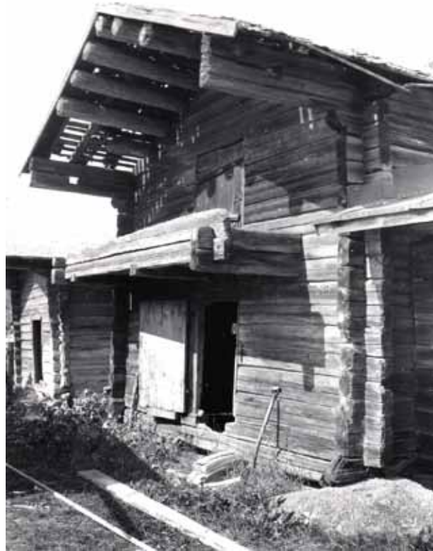
Vanha talli 1980-luvun korjauksia edeltävässä kunnossaan. Kuva: MV REST.
