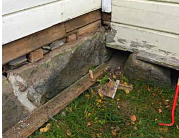
Sivuseinilläkin hirsien välit olivat lahonneet ontoiksi, tai vaihdettuja hirsii ei oltu varattu tiiviisti yhteen. Vaarnatappeina oli käytetty sinkittyä terästankoa. Näihin kohtiin sovitettiin kiilamaiset tiukat puupaikat, jotta seinien kuormia saatiin siirtämään perustuksille.
