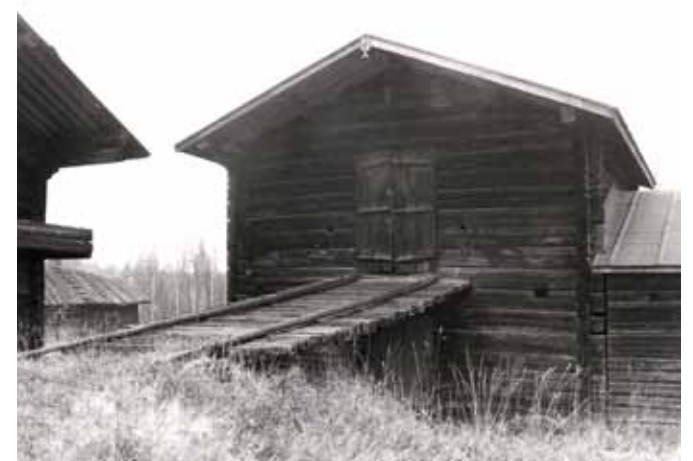
Hevostallin ajosillasta puuttuivat 1980-luvun alussa kaiteet. Kuva: MV REST.
