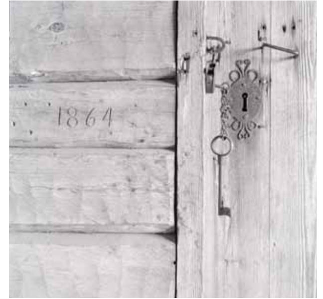
Pienen riistaitan oven viereen on kaiverrettu vuosiluku 1864. Kuva on vuodelta 1960. Kuva: Osmo Vuoristo / MV KK.
