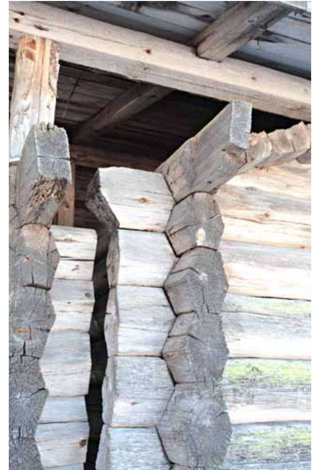
Jauhoaitan takaseinän konsolihirsi; ylintä konsolihirttä on ohennettu.
