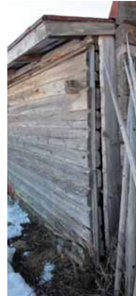
Nurkan alla on tiiliä tukena.
