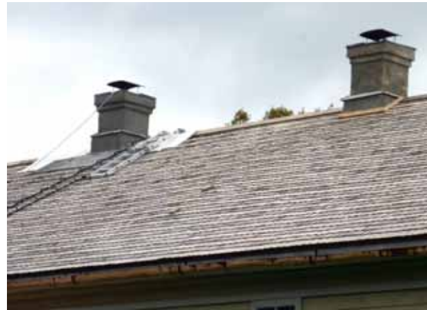
Uusi pärekatto, uudet räystäskourut ja korjatut piiput hattui- neen vuonna 2016.
