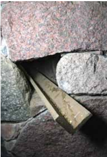
Vesikouru laskee Suurlievään.
