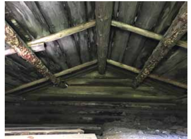
Vesikattorakenteita ja aluslaudoitusta, johon on käytetty kierrätettyjä uralautoja.
