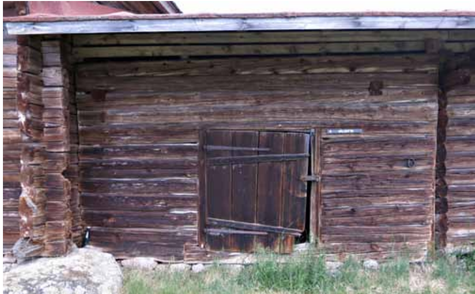
Väliliiterin pihanpuoleinen sivu.
