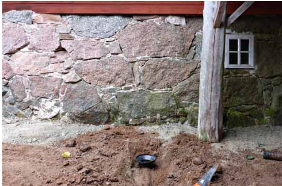
Salaojakaivo kujalla ennen peittämistä.
