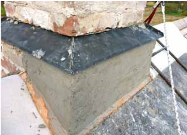
Uudelleen rapattu savupiippu uusine corten-suojapelteineen. Sivun valokuvat: Matti Valkonen 2016.
