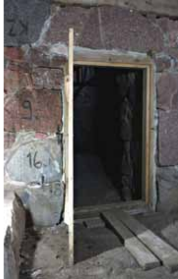
Karjakeittiöstä Suurlievään vievän oven ympärillä on 1980-luvun korjauksessa numeroitua ja uudelleen ladottua muuria.
