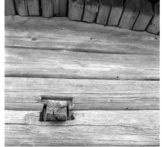
Jauhoaitan takaseinällä on katkaistulla kartiotapilla suljettu valoaukko. Kuva: Osmo Vuoristo, 1960 / MV KK.
