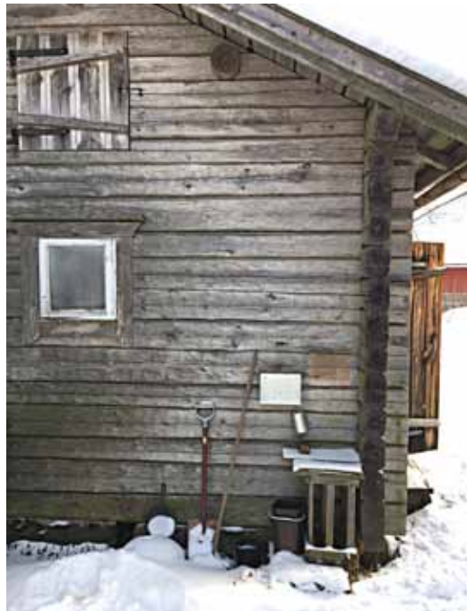
Pohjoisseinällä on käsienpesupaikka.
