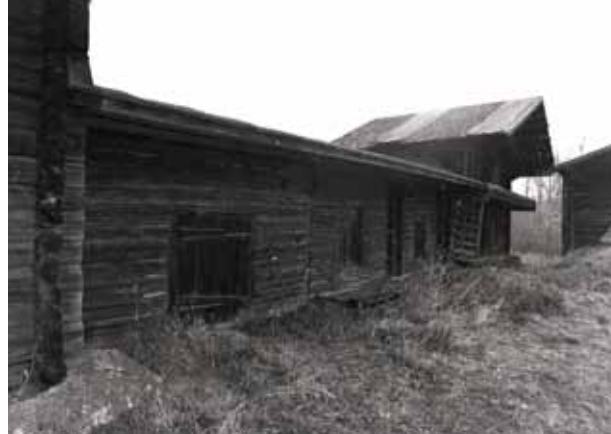
Kolmen aitan rivi 1980-luvulla ennen korjauksia. Kuva: MV REST.
