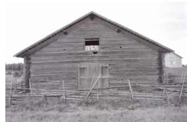
Lyttikkälän 1800-luvun alun päärakennuksen tupa lato- käytössä (P022) vuonna 1960. Kuva: Osmo Vuoristo / MV KK.
