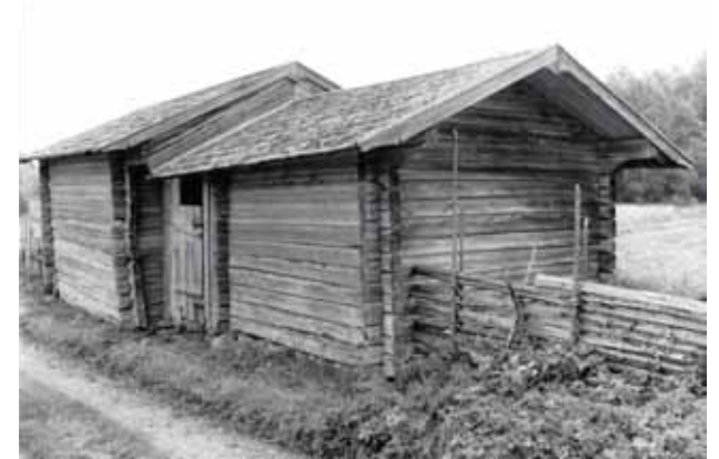
Riistaitat katteen, kurkihirren päätykoristeen ja koristeellisten otsalautojen uusimisen jälkeen 1990-luvulla. Kuva: MV REST.
