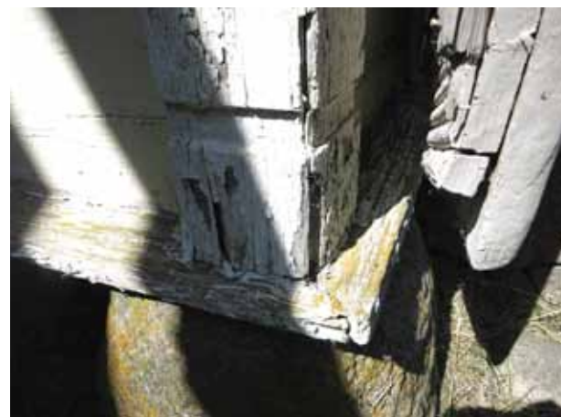
Kuistin laudoituksen helmassa on vesilista.
