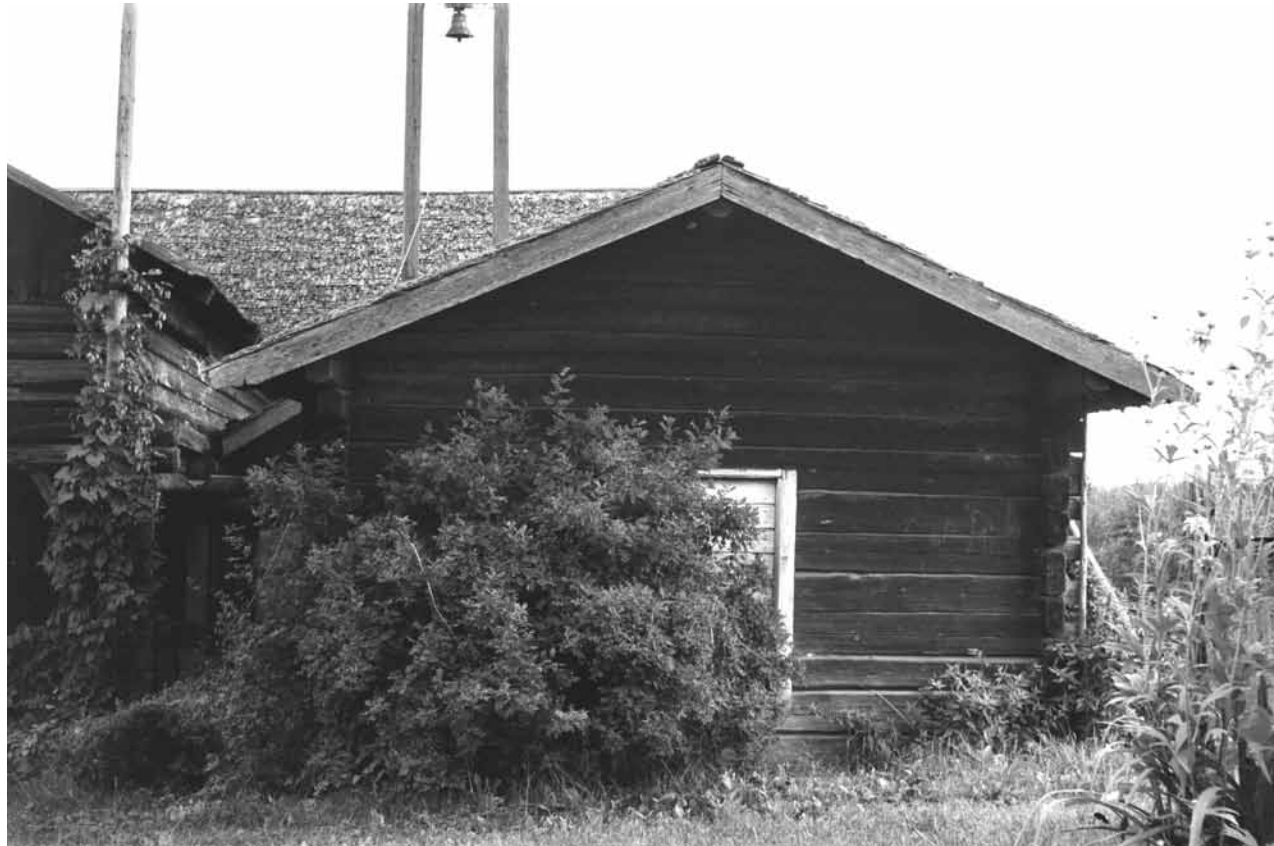
Kartanomuan aitta vuonna 1961. Kuva: Osmo Vuoristo / MV KK.
