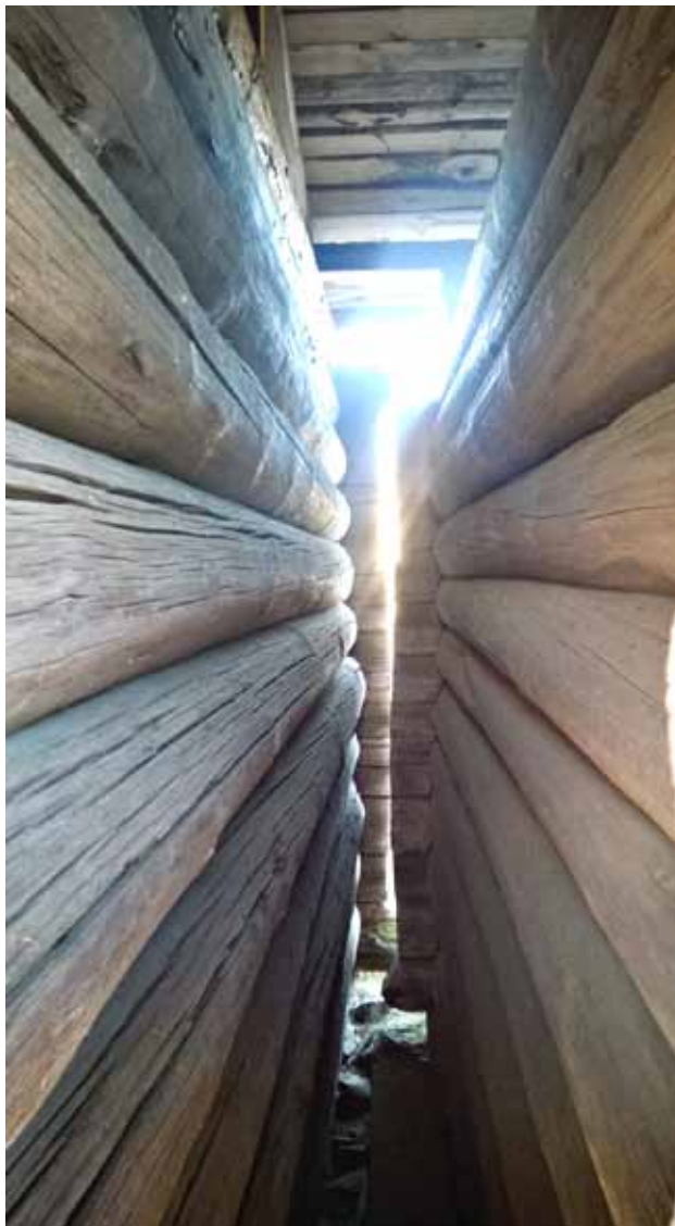
Jauho- ja Piikain aitan sivuseinät ovat ulkopinnaltaan piilumattomia.
