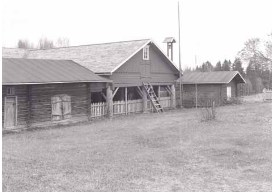
Navetan katos maalattuna vuonna 1989. Kuva: P. O.Welin / MV RHO.
