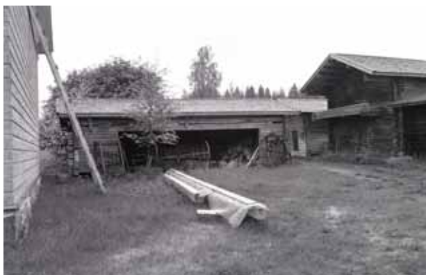
Halkoliiteri korjauksen jälkeen vuonna 1988. Kuva: Matti Laamanen / MV RHO.
