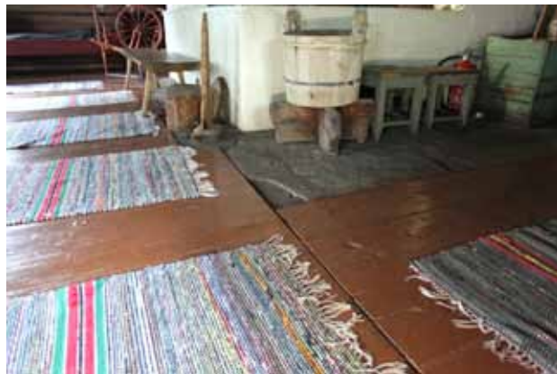
Uunin edustalla on betonilaatta.
