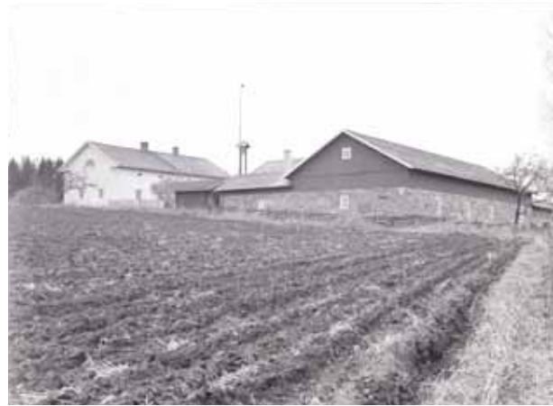
Navetta korjausten valmistuttua. Kuvat: P. O. Welin, 1989 / MV RHO.
