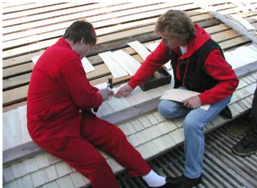
Halkoliiterin pärekattoa kunnostettiin, kun Lyytikkälässä järjestettiin 11.9.2004 Euroopan rakennusperintöpäivänä Avoimien Ovien päivä. Kuva: MV K-as.
