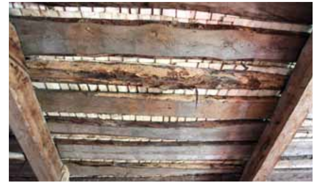
Pärekatteen aluslaudoitusta. Pärekkate on uusittu vuonna 2016.
