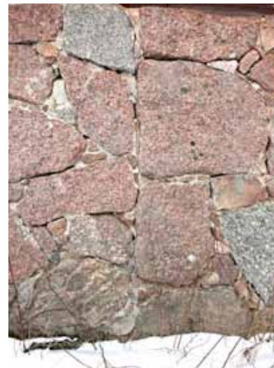
Karjakeittiön ja Suurlievän saumakohta.
