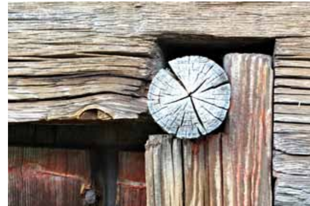
Oven pielipuu on "kiilattu" pulikalla.
