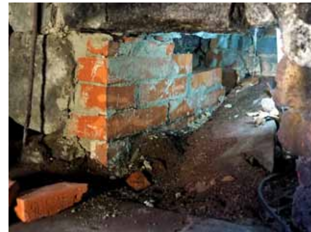
Vasemman kyljen alaosan uutta muurausta vuonna 2015.
