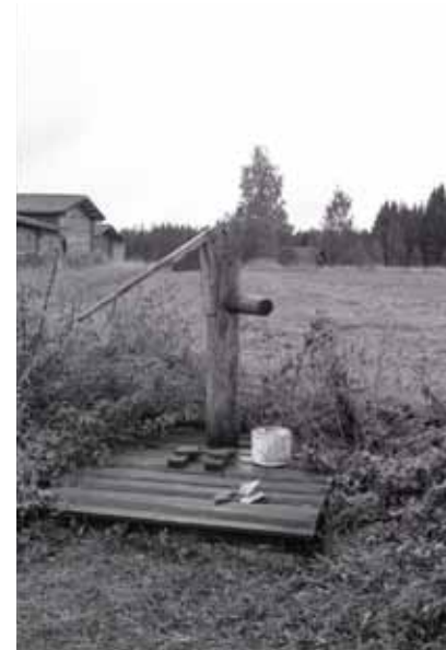
Kaivo 1980-luvulla. Taustalla näkyvät aitarivi. Kuva: H. Ahtiainen / MV RHO.
