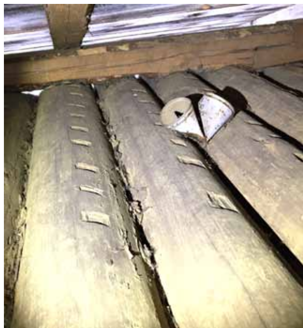
Haljasholvin haljaksissa on siirtomerkintöjä.
