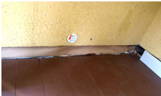
Lattioiden avaamisen yhteydessä vuonna 2012 levyt sahattu poikki lattialistojen takaa. Listan takana oli vain paperi jos sitäkään. Kuva: Culturelli.
