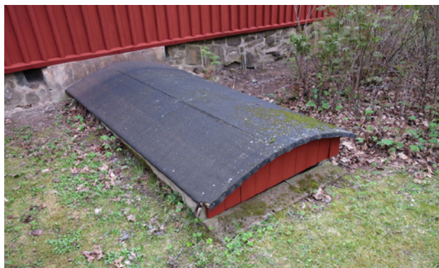
Vuonna 1982 rakennettu kellariportaan katos vuonna 2015.
