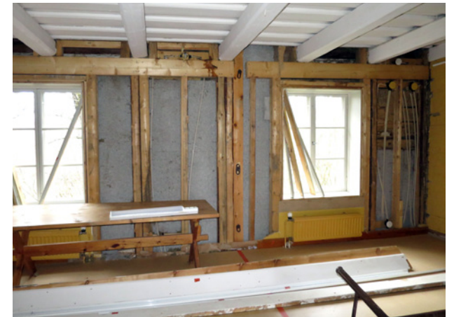
Ulkoseinän eristeet oli osaksi vaihdettu selluvillaksi vuosina 2011–2013.
