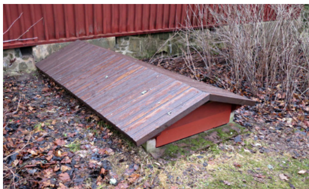
Uusittu kellariportaan katos marraskuussa 2018.
