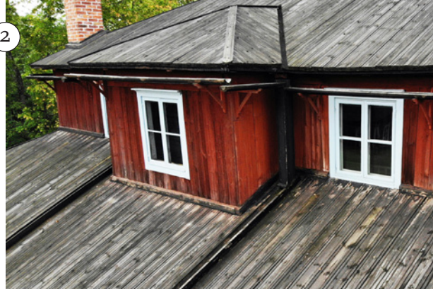
2. 1978–1982 toisen kerroksen ulkokuuoraukseen kunnostettu pääosin vanhoilla laudoilla, ylälaitaan lisättiin uusi vaakalauta. Vesikourujen rekonstruktio. 2007 toisen kerroksen seinät maalattu punamullalla.
