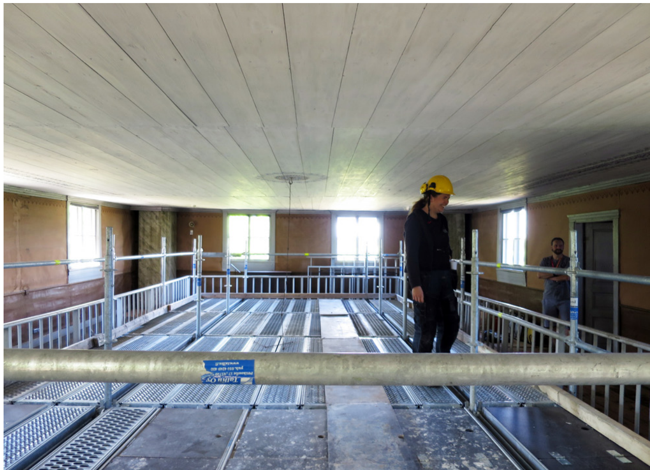
Keskikaton restaurointia varten pystytetyt telineet vuonna 2017.
