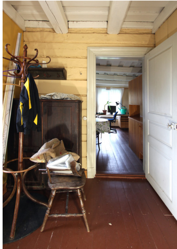
Välikkö (H2) ennen purkutöitä.
