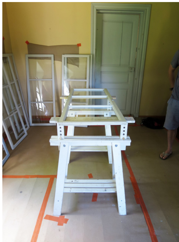
Alipytingin ikkunoiden kunnostusta pukkien päällä.
