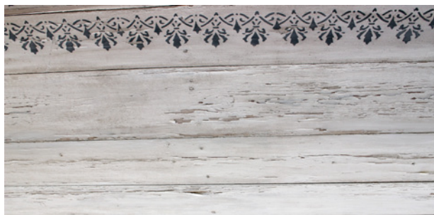
Maali hilseili paikoin suurina lastuina. Kuva: Kollaasi.
