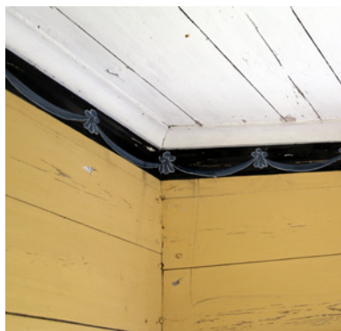
Koristemaalausnauha ja kattolista.
