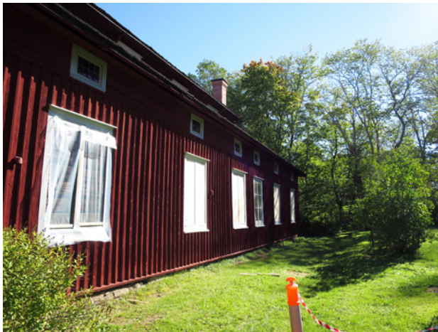
Ylipytingin ikkuna-aukot suojattiin kunnostuksen ajaksi vuonna 2016.
