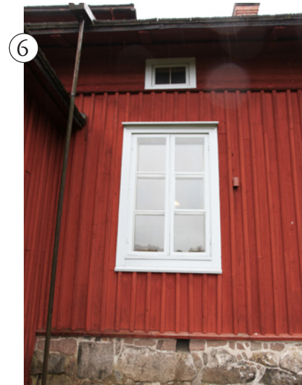
6. 2016 kaikki ikkunat kunnostettu.
