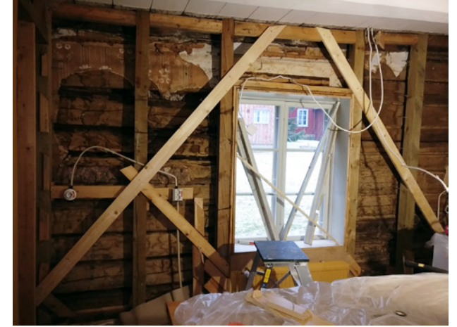
Työn aikana seinään lisättiin väliaikaiset vinotuet eli reevaukset. Kuva: Culturelli.
