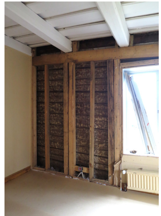
Kamarin ulkoseinähirsissä on veistojäljet savirappauksen tartuntaa varten.
