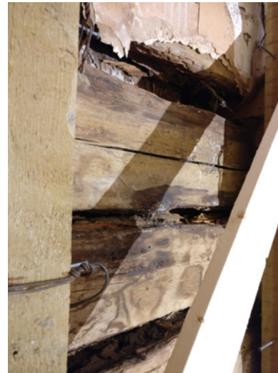
Viitisen senttimetriä leveästä hirsien välisestä raosta näkyvät ulkovuorauksen alla olevat tuohet, joiden välistä paistaa päivä. Kuva: Culturelli.
