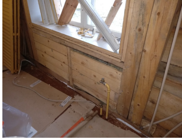
Patterin tausta purkutöiden aikana. Kuva: Culturelli.
