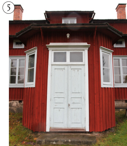
5. 1978–1982 kuisti kunnostettu. Ovet uusittu. 2006 ovet huoltomaalattu. Oven päällä kirkaskupuinen valaisin.
