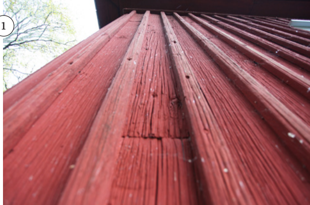
1. 1978–1982 ensimmäisen kerroksen ulkokuuoraukseen kunnostettu pääosin vanhoilla laudoilla. 2015 ensimmäisen kerroksen seinät maalattu punamullalla.
