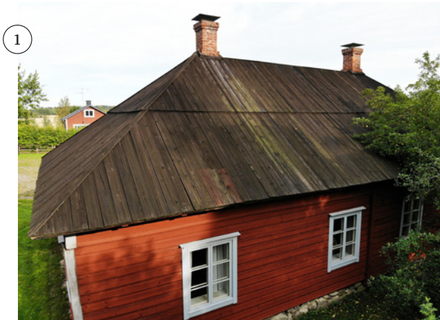
1. 1973–1975 vesikatto korjattu, huopakate. 1982 huopakaton päälle kaksinkertainen lautakate painekyllästetystä puusta. 2007 pintakäsittely Pinotex Classic -sekoituksella.
