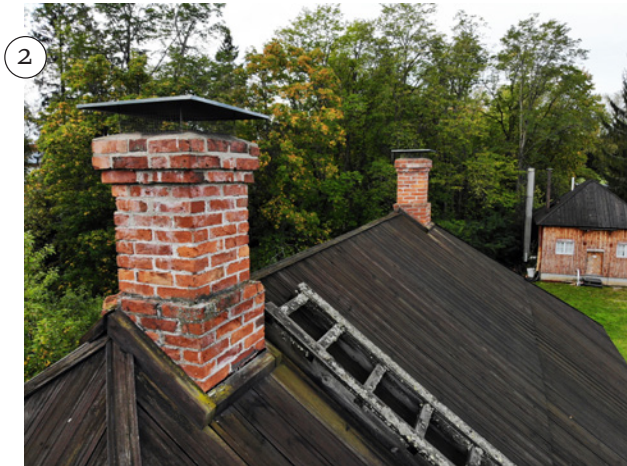
2. 1978–1982 piippujen uusiminen vanhan mallin mukaan. 2006 suojahattujen asennus.
