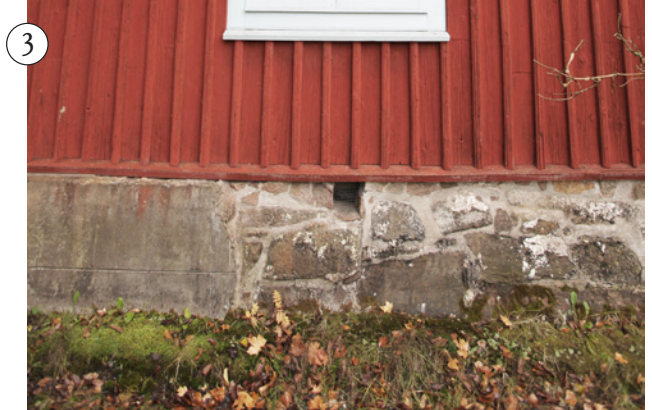
3. 1978–1982 sokkeli korjattu. Betonimantteli poistettiin kaakkoiskulmaa ja kellariportaankin kohtaan ottamatta.
