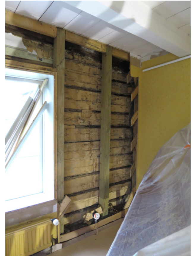
Uusi runko oli jäykistetty molemmista päädyistä harvalla vinolaudoituksella. Pitkillä sivuilla oli jäykisteenä pelkät 12 mm:n lastulevyt.
