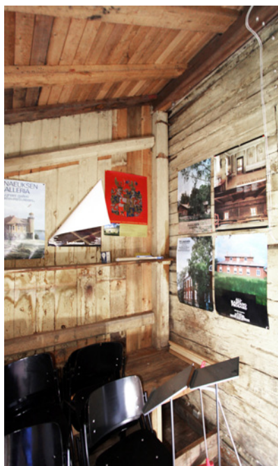
Keittiön kuisti on rankarakenteinen ja lautaseinäinen.
