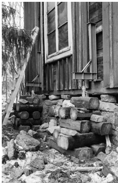
Vuonna 1979 rakennusta notettiin tunkeilla alimpien hirsikertojen vaihtamista varten.
