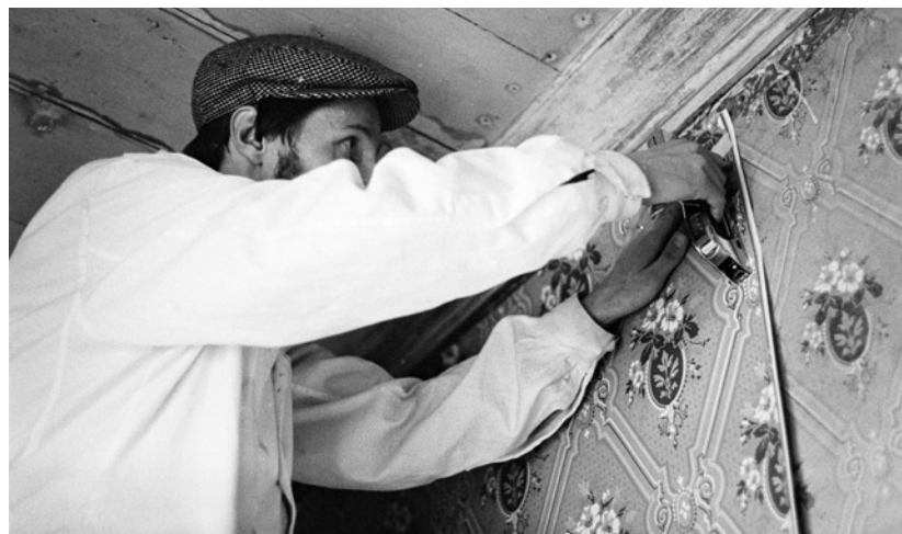
Pentti Pietarila kiinnittää uutta tapettia nitojalla Arkiston (H7) seinään. Kuva 1982: MV pääarkisto 58650 / Hannu Puurunen.
