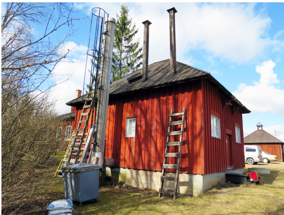
Lämpökeskuksen teräspiippu ja käymälöiden poistoilmaputket kaakkoissivulla vuonna 2015.
