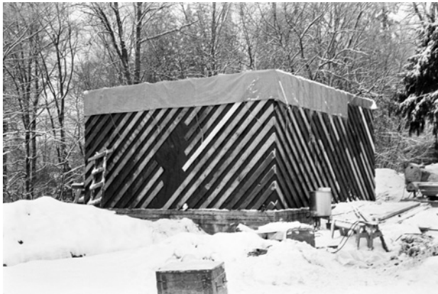
Huoltorakennus työmaavaiheessa tammikuussa 1979. Kuva: MV pääarkisto 38841 / Simo Suoniemi.
