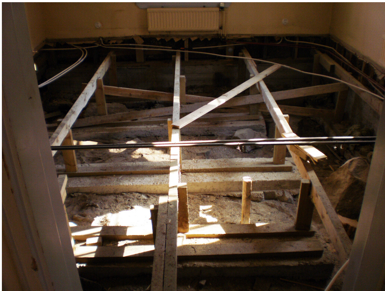
Purettua lattiaa vuonna 2012. Kuva: MV K-asema / Kari Gröndahl.
