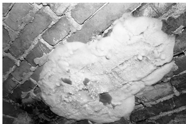
Lattiasientä kellariholvin katossa. Kuva: MV pääarkisto 61109.
