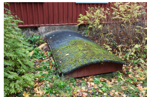
Kellarin ulkoportaalle tehtiin kaareva katos Maire Kempin piirustusten mukaan. Kuva lokakuulta 2018.
