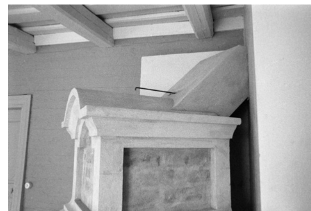
Salin uunin vino hormiliitäntä. Kuva: MV pääarkisto 36209 / Maire Heikkinen.
