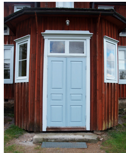
Museoviraston valokuvista käy ilmi, että pääovi oli ennen vuoden 2006 maalaus-kunnostusta yhtä vaalea kuin ikkunat ja sai ikkunoita sinertävämmän sävyn vasta tässä vaiheessa. Kuva: MV K-asema.
