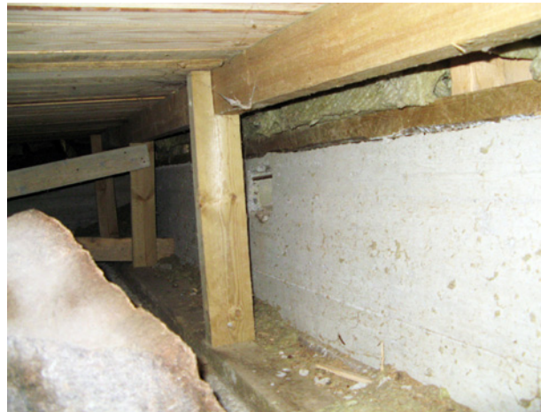
Tukirungon betoninen tukimuuri ja lattialautoja tukeva erillinen runko.vuoden 2011 kuvassa. Kuva 2011: MV K-asema / Päivi Eronen.
