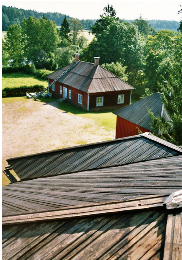
Alipytingin, huoltorakennus ja Ylipytingin kattoa vuonna 2007. Kuva: MV K-asema.
