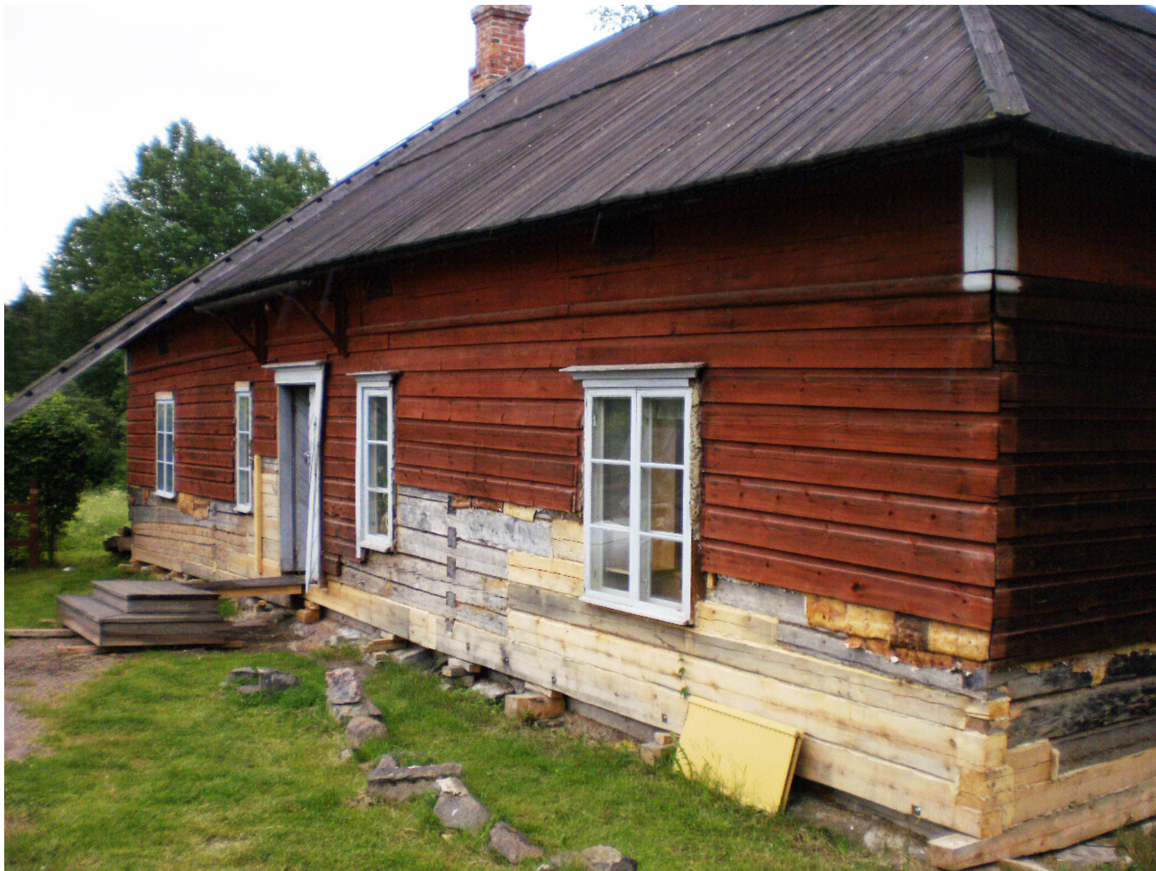
Korjattua hirsiseinää vuonna 2012. Kuva: MV K-asema.
