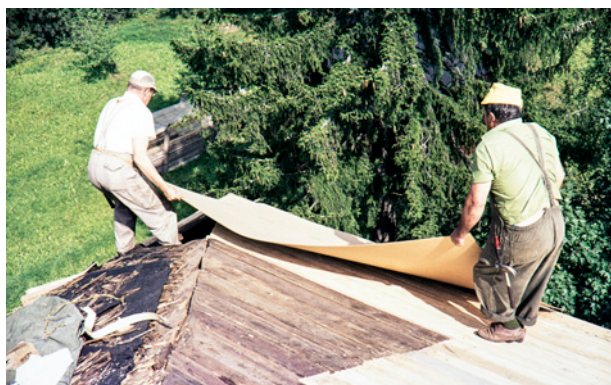
Kattotöitä vuonna 1972. Kuva: MV pääarkisto 340/22251.
