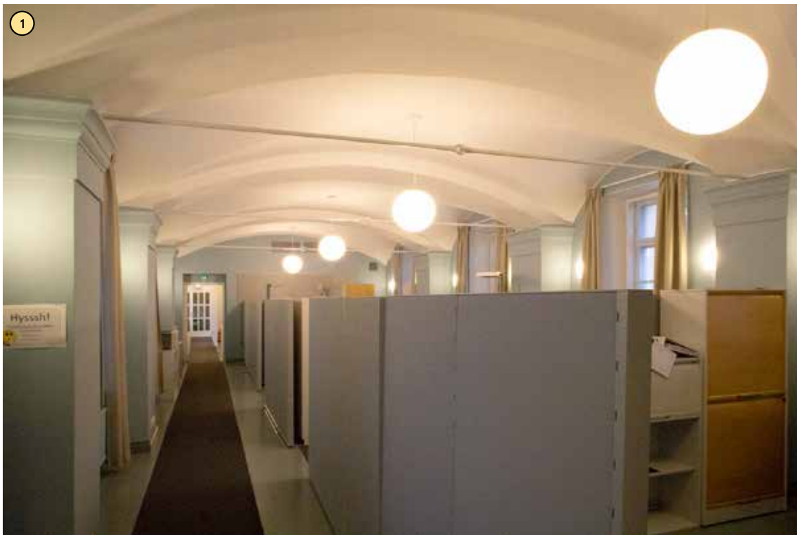
Nykyinen kirjastosali palautettiin alkuperäiseen, yhtenäiseen asuunsa 1990-luvun peruskorjauksessa. Kuvassa lähimpänä näkyvän holvin paikalla oli eräässä vaiheessa porras, joka purettiin ja holvi palautettiin betonirakenteisena alkuperäisen rakenteen kaltaiseksi.
