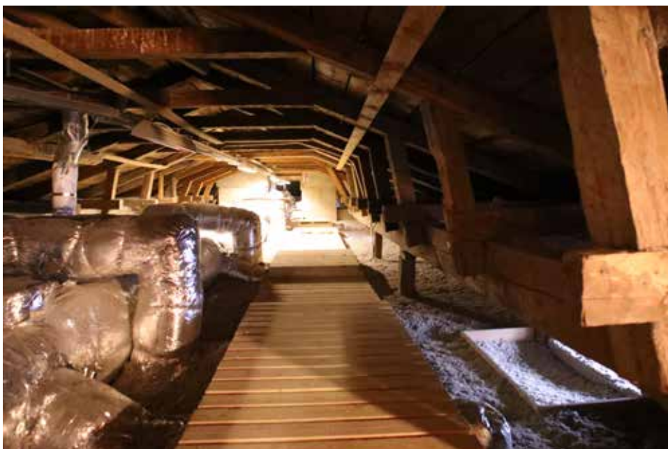
Ullakko on kylmää tilaa ja sen rakenteissa on nähtävillä useita ajallisia kerrostumia.
