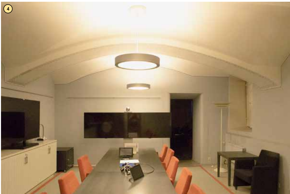
Aulan itäpuolella sijaitsevassa nykyään kokoustilana toimivassa huoneessa on näyttävä ristiholvattu katto. Koristemaalaukset on tehty 1990-luvulla.
