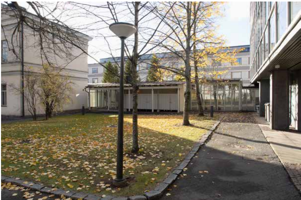
Yhdyskäytävä vanhan ja uuden osan välillä on peräisin 1990-luvun peruskorjauksesta. Käytävä on puolilämmin ja idän puolelta lasiseinäinen. Siihen on upotettu myös roskakatos.
