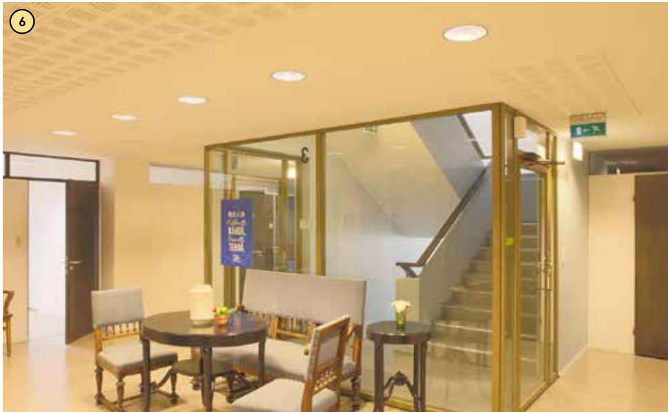
Porraskäytävän metallirunkoiset lasiseinät ovat alkuperäisiä.
