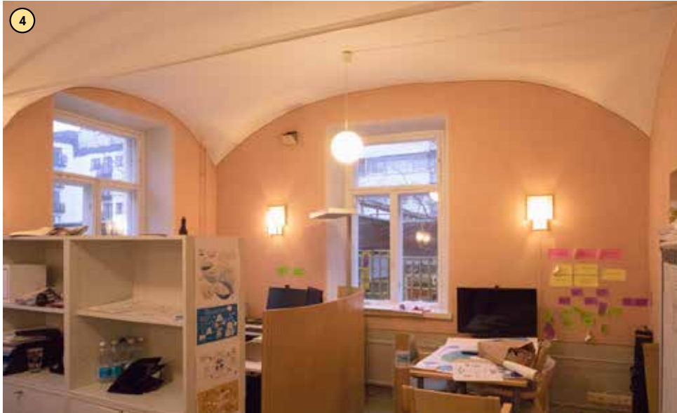
Rakennuksen itäisen pihanpuoleisen ulokkeen päätyhuoneessa on ristiholvattu katto sekä vanha vetotanko.
