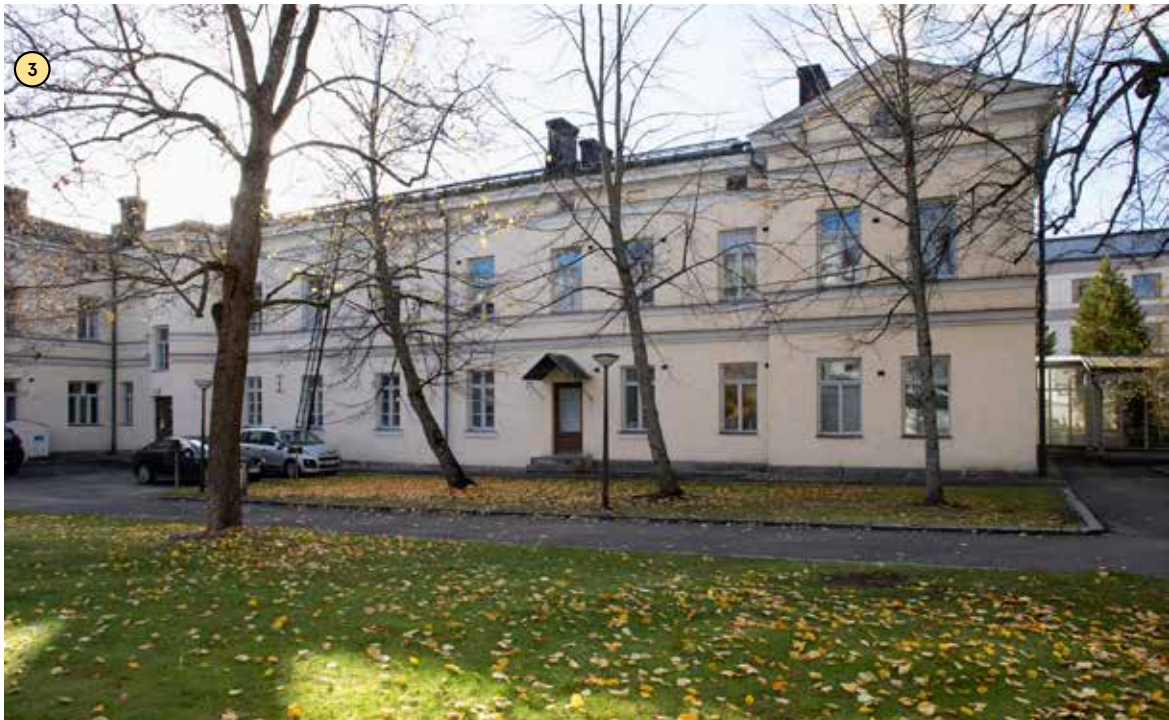
Pihasiipeä on jatkettu useaan otteeseen ja myös siihen lisättiin 1800-luvulla pyöristetty porrashuone. Siiven viimeinen jatke päätukolmioineen on rakennettu samassa 1800-luvun lopun vaiheessa porrashuoneen kanssa.
