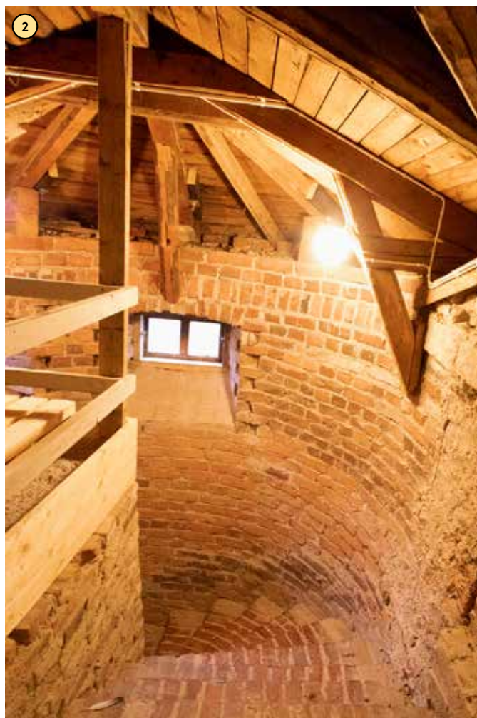
Pihasiiven portaikon ullakolle johtava osa on sisätiloiltaan rappaamaton.
