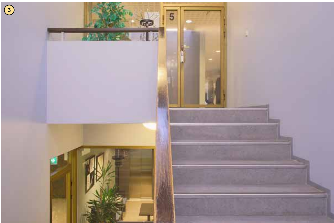
Pääporras on muodoltaan yksinkertainen. Alkuperäinen massiivipuinen käsijohde on yhä paikallaan.
