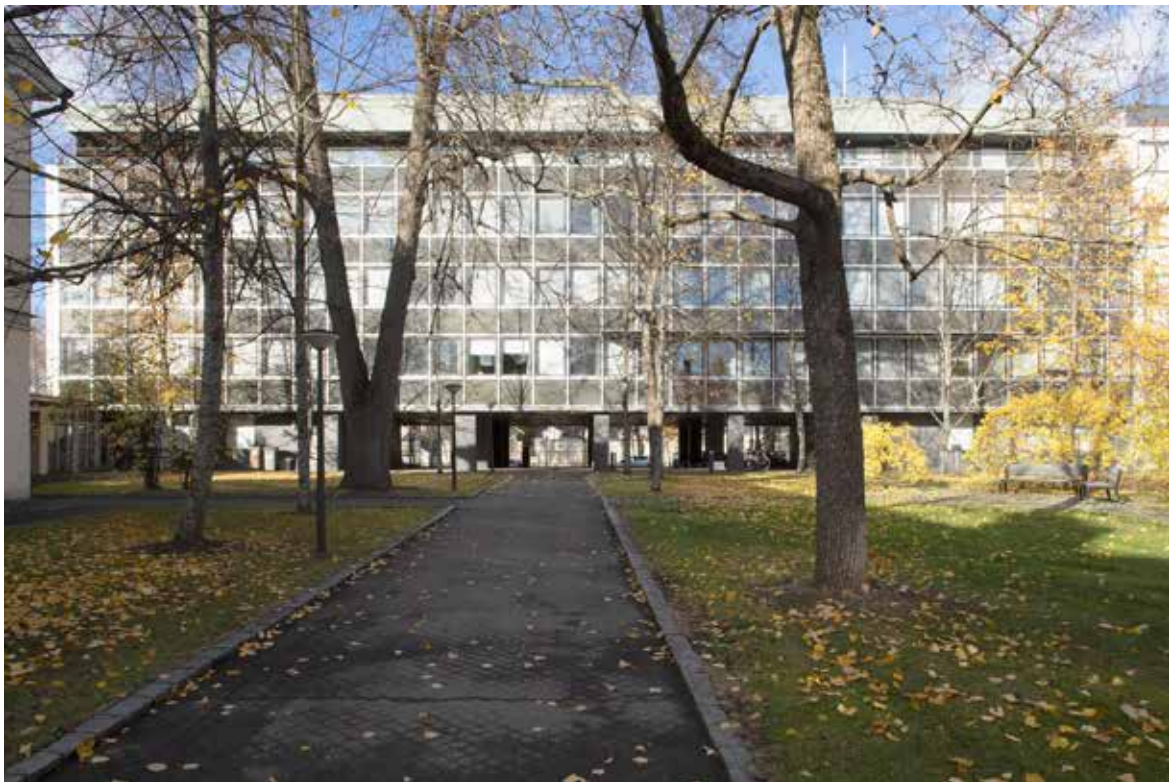
Näkymä lääninhallituksen talon pihalta Birger Jaarlin kadulle päin. Alun perin tästä pohjoispäädystään suljettu piha yhdistyy nyt suoraan katuun virastotalon avonaisen pohjakerroksen välityksellä.
