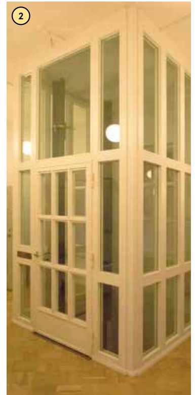
Toisessa kerroksessa hissikuilu on lasitettu ja ulkoasultaan aulatilaan sovitettu.
