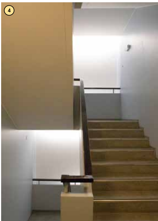
Pääporras on takaa valaistu kattoikkunoiden ja pohjakerrokseen asti ylettyvän valokuilun avulla.
