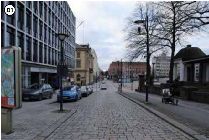
Näkymä Raatihuoneenkadun ja Linnankadun kulmasta länteen. Raatihuone on molemmin puolin suurempimittakaavaisten rakennusten varjostama, eikä enää nouse julkisivurivissä esiin muuten kuin tyylillisesti.
