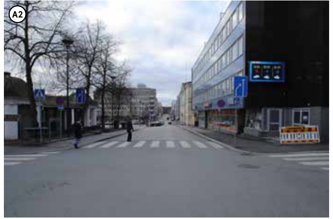
Näkymä Linnankadun ja Hallituskadun kulmasta länteen. Hallituskadun myötäistä näkymää hallitsevat 1960-luvun toimistotalot molemmin puolin lääninhallituksen taloa. Rakennusten mittakaava on pyritty pitämään lääninhallituksen talon mukaisena.
