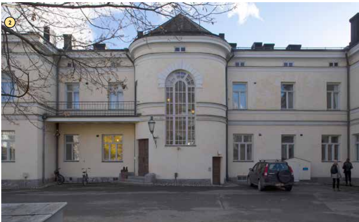
1800-luvun lopussa lisätty iso porrashuone poikkeaa kaareviltä muodoiltaan Engelin empirearkkitehtuurista ja erottuu selkeästi omana ajallisena kerrostumanaan. Myös vasemman puoleinen parveke lisättiin sen yhteydessä.
