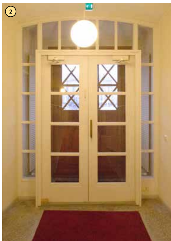
Tuulikaappi on rakennettu 1990-luvun peruskorjauksen yhteydessä. Ennen peruskorjausta tämä sisäänkäynti oli 1930-luvun vaiheesta alkaen toisarvoisessa käytössä.
