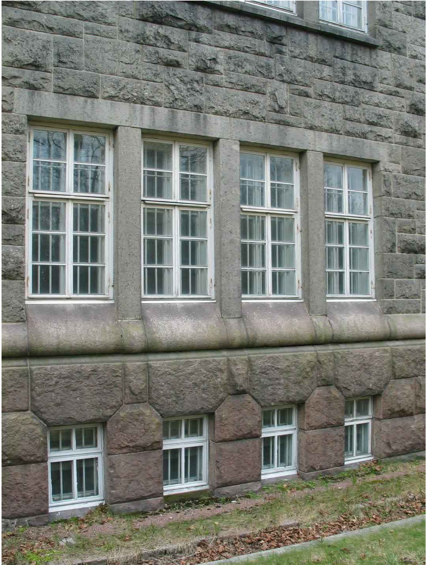
Ikkunalasit on 1970-luvulta lähtien kiinnitetty listojen varaan.
