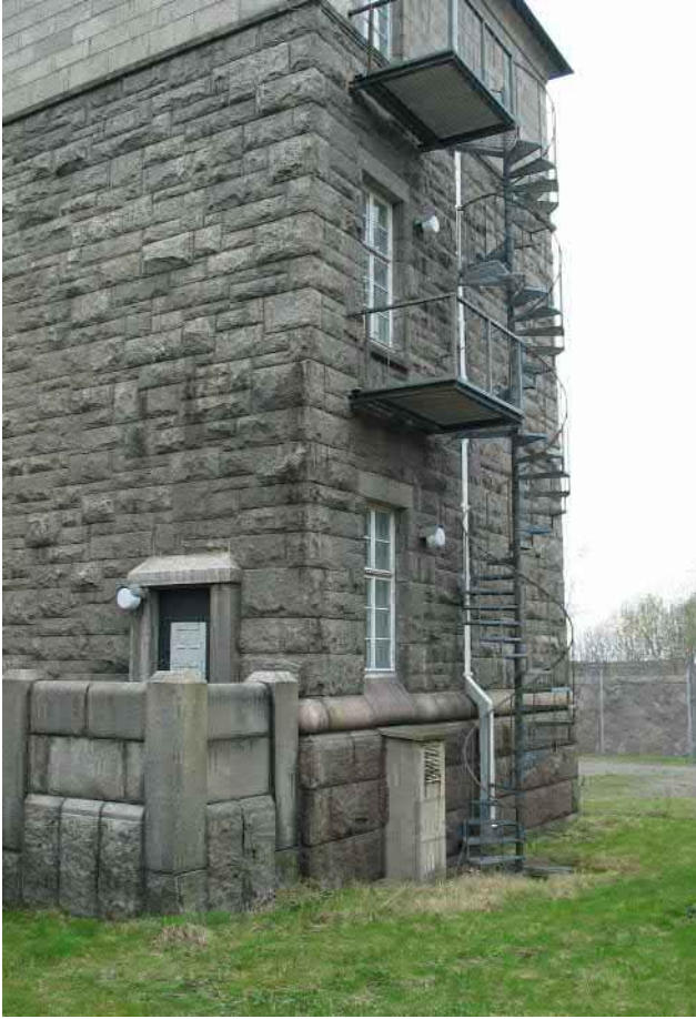
Päätyyn on 1976 rakennettu ulkopuolinen hätäpoistumissporras.
