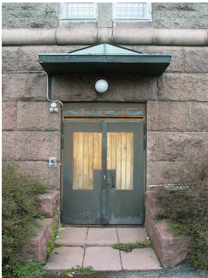
Lounaissivulla on 1970-luvun peruskorjauksen yhteydessä rakennettu uusi ulko-ovi kellarikerrokseen.
