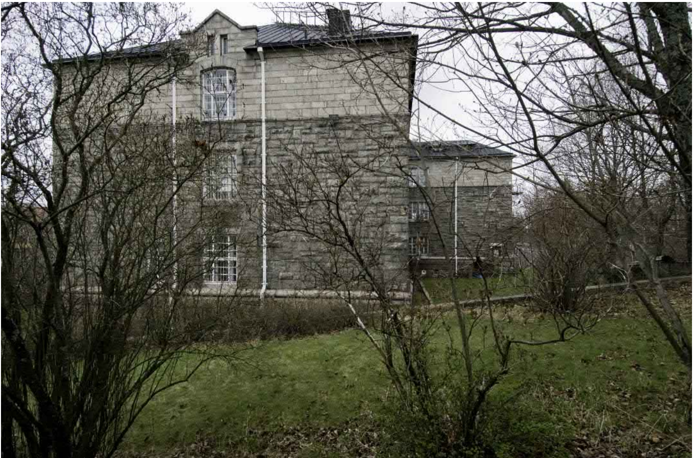
Julkisivu kaakkoon ja piha-alue. Nurmikolle on istutettu kukkivia koristepensaita ja käytävän reunalla pensasaidanne. Kuva: Kar i Hakli
