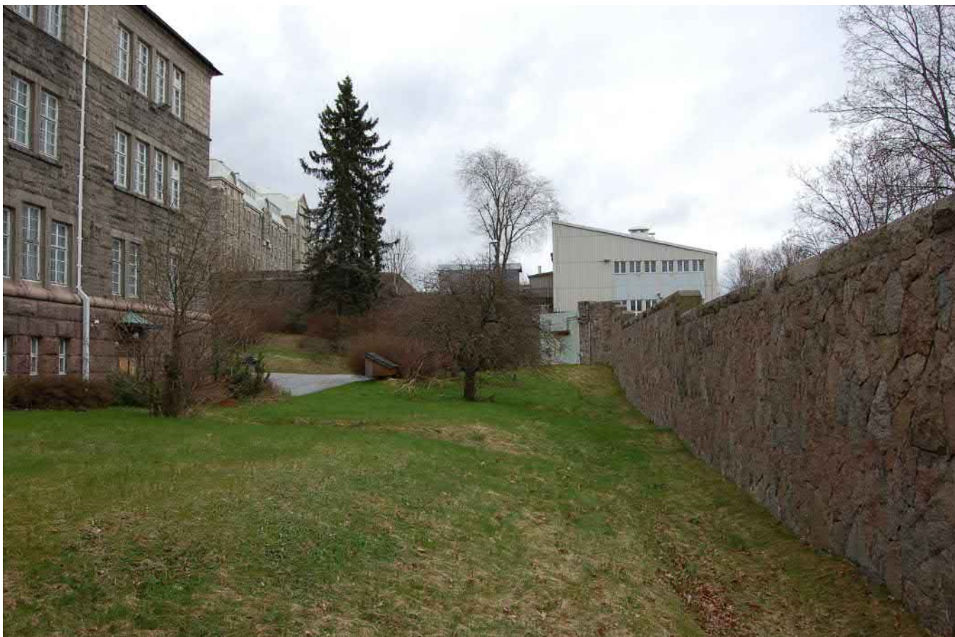
Pihan lounaisreuna ja muurin julkisivu pihalle. Taustalla näkyy 1960-luvulla rakennettu uusi portti.. Kari Hakli 2010.
