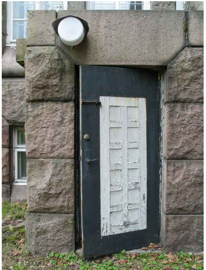
Työpajatilojen uusittu ulko-ovi koillissivulla.
