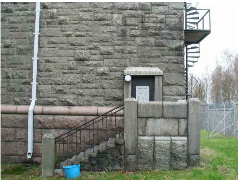
Sellisiiven 1. kerroksen varauloskäytävä.
