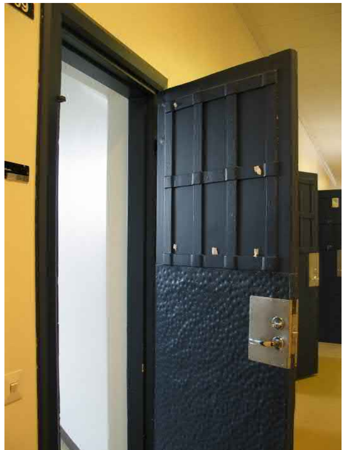
Sellisiiven ovet ovat mahdollisesti 1920-luvulta.
