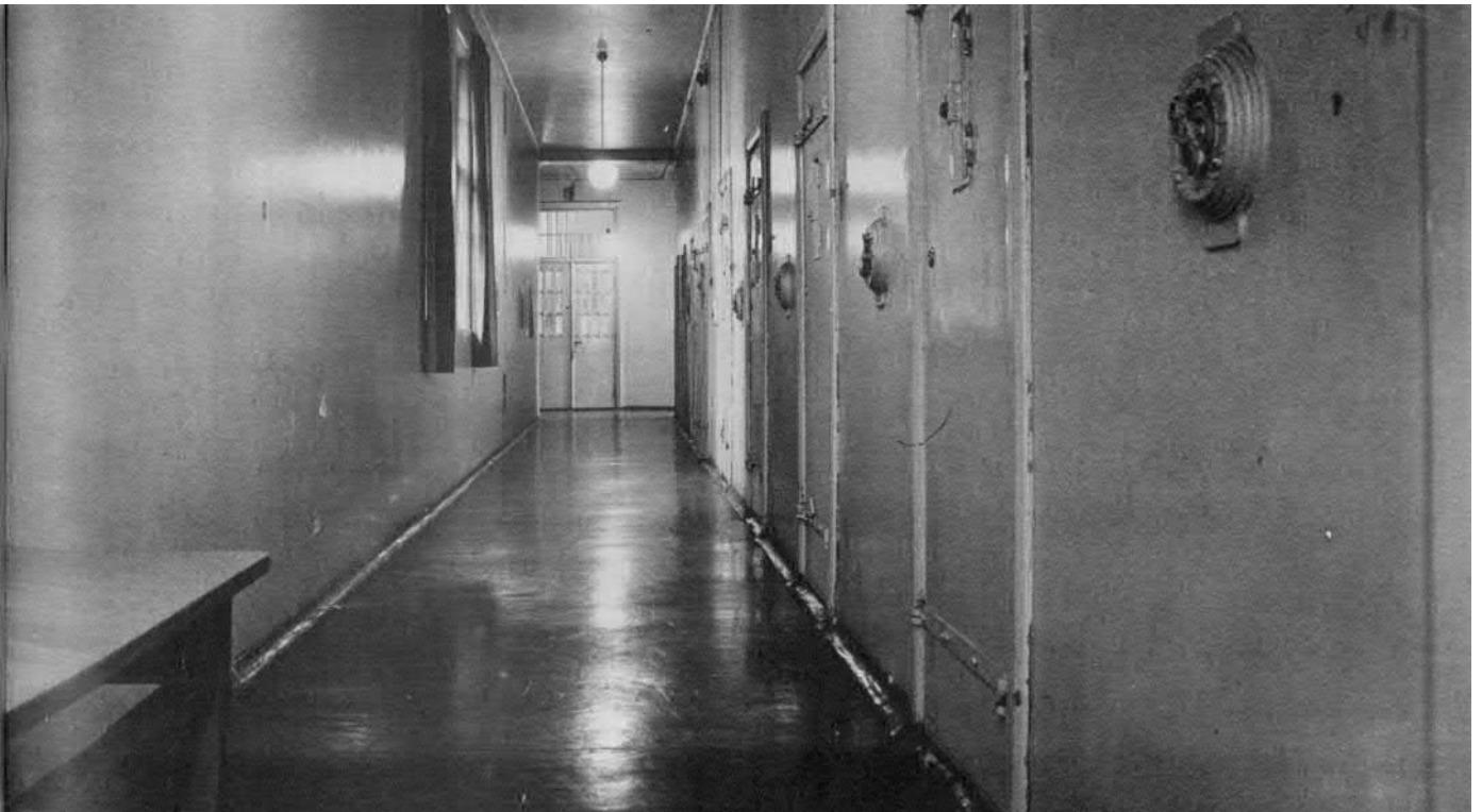
Sellikäytävä ennen peruskorjausta ja alakaton rakentamista. Taustalla näkyy porrashuoneen ovi. Kuva on Pentti Sammallahden kuvaamasta sarjasta. Vankimielisairaalan peruskorjauksen esisuunnittelutyöryhmän mietintö. 1974.
