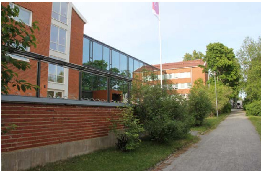
157. 1950-luvun virastotalot toteuttivat funktionalistista avoimen korttelin periaatetta. Niiden väliin vuonna 2011 rakennettu lasinen laajennusosa katkaisee fyysisen yhteyden lääninhallituksen puutarhasta Kuopionlahden suuntaan.
