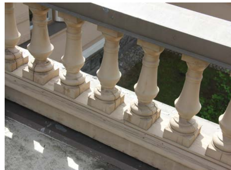
199. Kaiteiden balustradipylväät on tehty puusta ja maalattu hiekkakiven sävyllä. Kaiteen säänkestävyyttä on parannettu pellityksillä.
