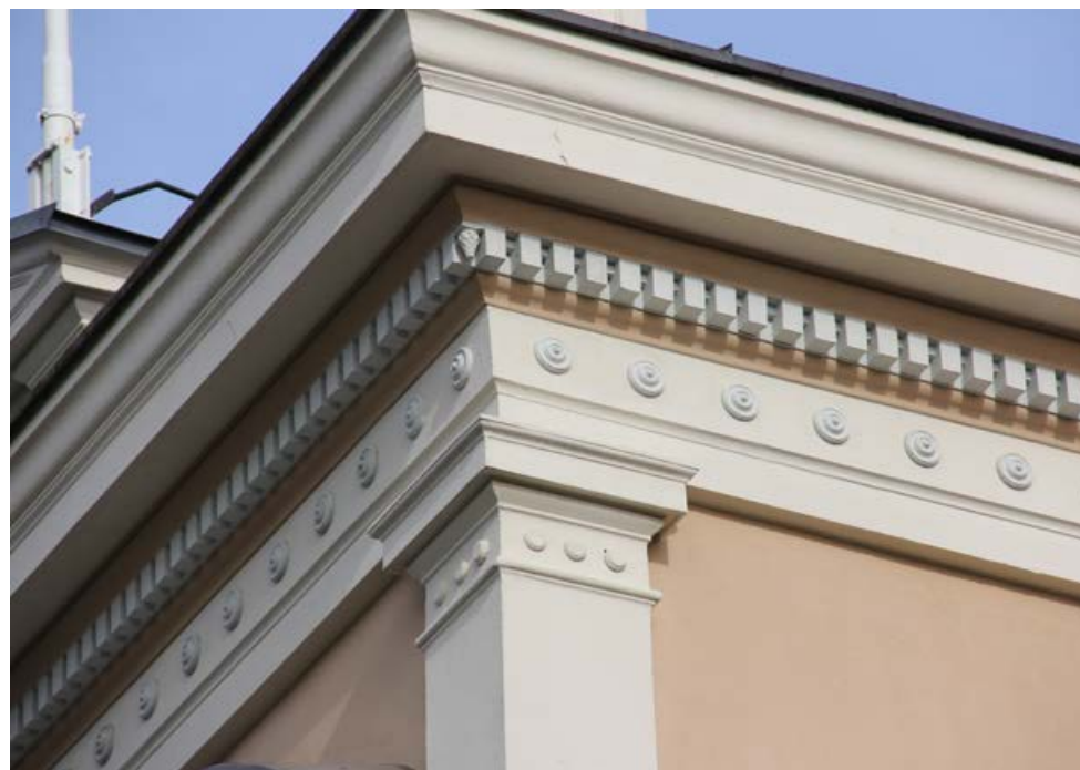
173. Yksityiskohta keskirisaliitiin ulkonurkasta. Koristeet on ennallistettu vuonna 1998.
