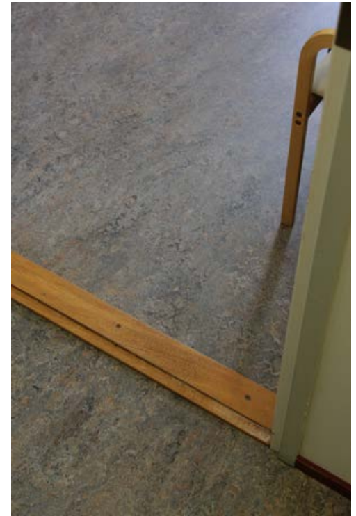
317. Käytävän lattia materiaali jatkuu huoneisiin.
