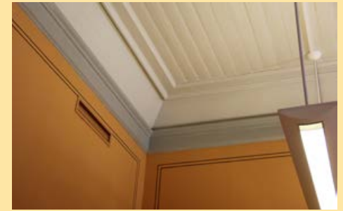
240. Katon ja seinän liittymä työhuoneessa 222
