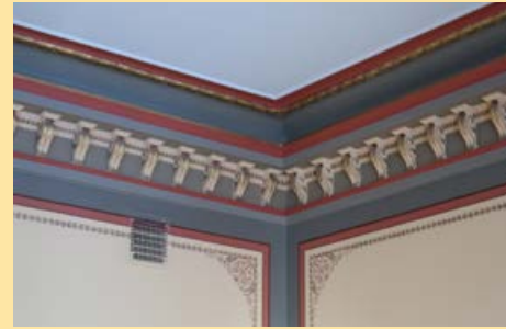
235. Katon ja seinän liittymä juhlasalissa 218
