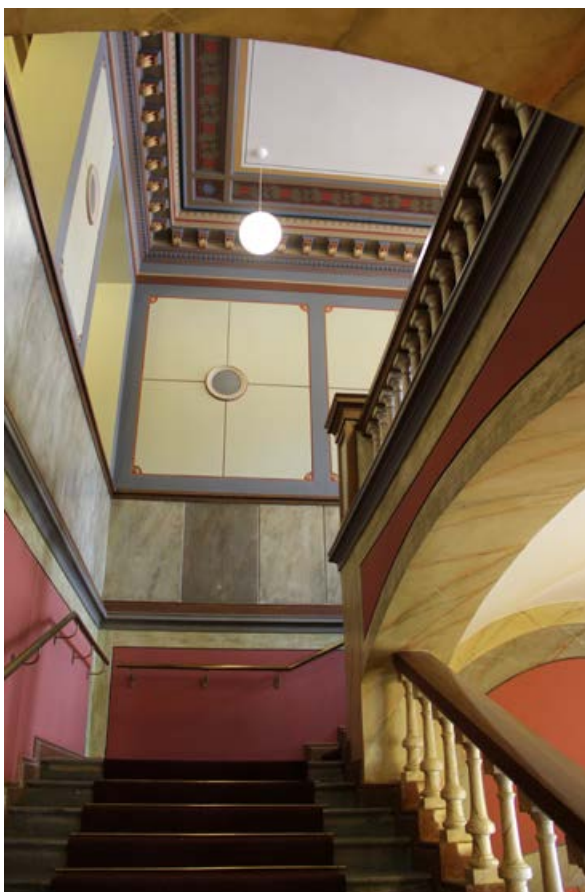
347. Porrashuoneen rintapaneloinnista erottuva muita tummempi osa on alkuperäinen maalaus. Se löydettiin vuoden 2001 ennallistamisen yhteydessä ja päätettiin jättää näkyviin.
