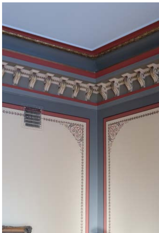
355. Juhlasalin koristemaalauksia ja kattolistaa.
