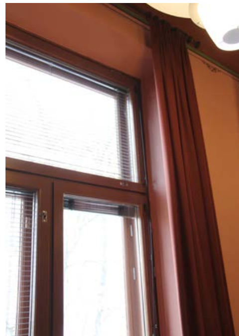
214. Yleisöaulan ikkuna on maalattu ruskeaksi.
