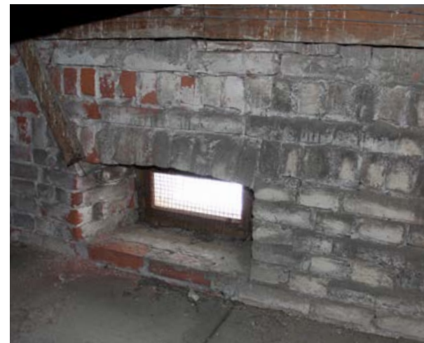
211. Ullakon haukkaikkuna on varustettu verkolla.
