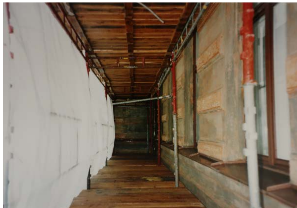
136. Julkisivun rappaus ja pellitys uusittiin. Kuvassa kerrostamista puhdistettua ensimmäisen kerroksen julkisivupintaa. Kuva on otettu rakennustelineeltä suojahupun sisältä kesällä 1997. KUVA: Kuopion lääninhallituksen arkisto, Ulla Hiltunen
