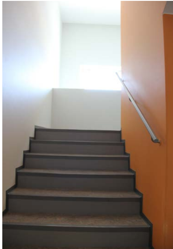
336. Porrasvarsi nousee kohti kahden kerroksen korkuista valokuilua.
