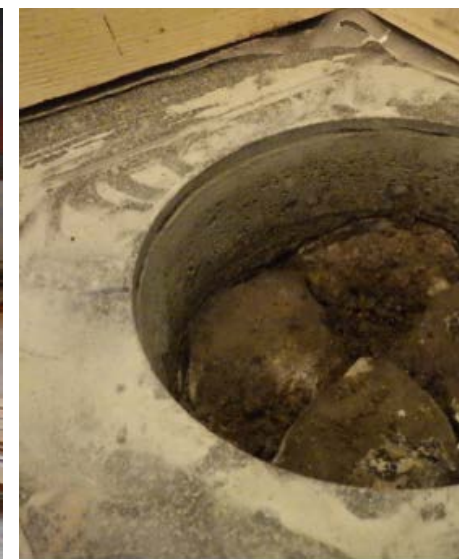
269. Kellarin betonilaatan alta paljastui kivistä ladottu alkuperäinen lattia. KUVA: Ramboll Finland Oy
