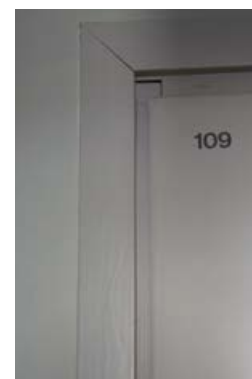
285. Laakaovia on käytetty moderneissa toimisto-huoneissa ja teknisissä tiloissa. Vanhimmat laa-kaövet ovat viilupintaisia.
