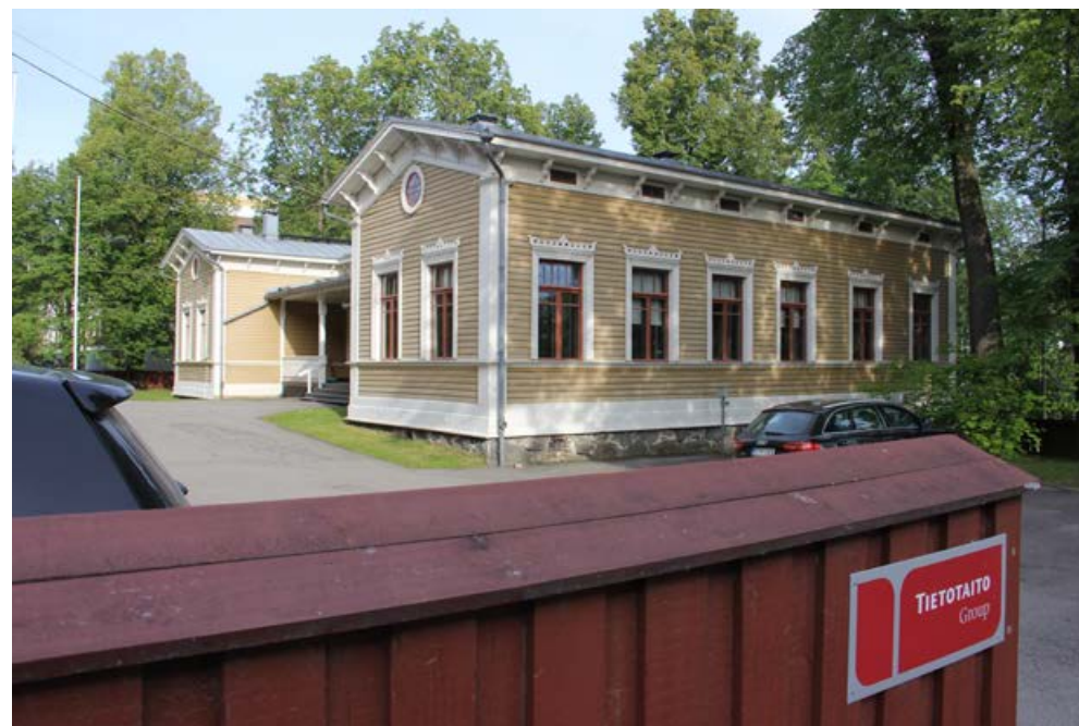
26. Everstiluutnantti Forsténin talo vuodelta 1852 oli Väinölänniemeen johtavan rantavyöhykkeen ensimmäinen rakennus. Korttelin muut rakennukset ovat arkkitehti Th. Granstedin suunnitteleimia ja ne rakennettiin kuuromyökkäin koulun käyttöön.
