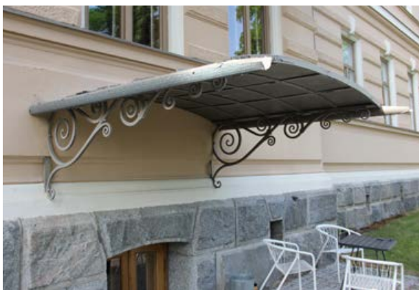
194. Kellariin johtavan oven katos.
