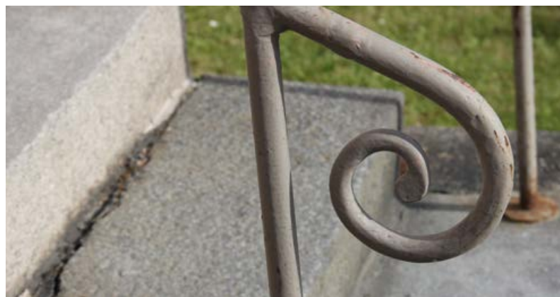
195. Sivuportaan käsijohde länsipäädystä.
