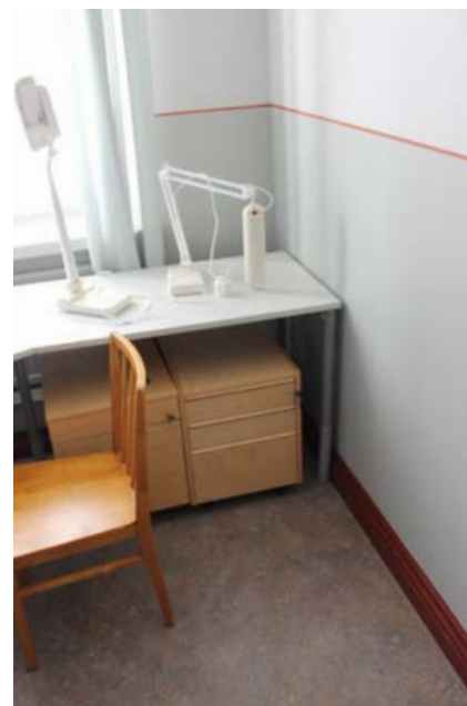
303. Alkuperäisen mallin mukaan seinien alaosat on maalattu harmaaksi. Seinälistan tehtävää tekee ohut punaisella maalattu raita. Tila 117.
