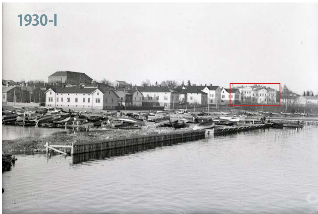
36. Kuopionlahden rantaa nykyisen Brahen puiston suunnasta 1930-luvulla. Läänihallituksen rakennus on kuvan oikeassa reunassa. KUVA: Kuopion Museo
