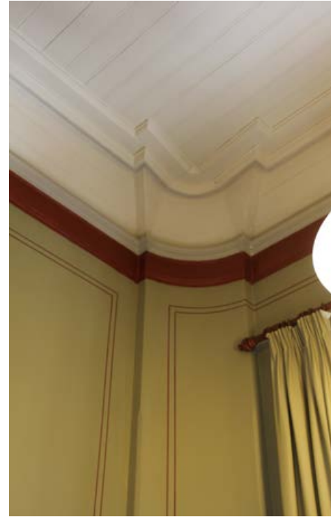
377. Yksityiskohta työhuoneen 223 ulkonurkasta.
