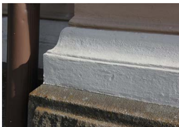
172. Perustuksen ja julkisivun liittymän kerroksellisuutta.
