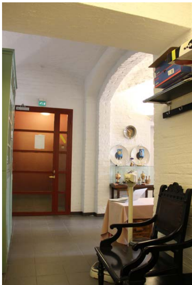
393. Alakerran kahvion eteistila. Lattia on päällystetty kuivapuristelaatalla. Oventakana on porrashuone.
