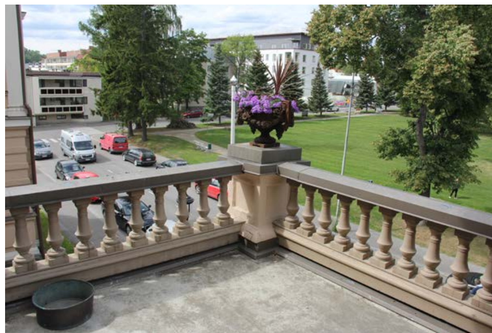
198. Parvekkeen taso on oli aikaisemmin asfaltoitu. Uusi pinnoite on vesitiivis ja siihen on asennettu lämmityskaapelit. Pilareiden päällä on valurautaiset amforat.
