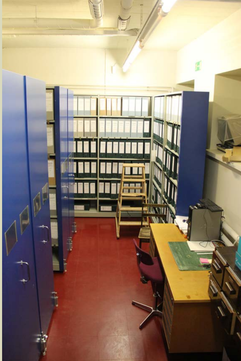
411. Näkymä porrastasanteelta päätearkistoon 019. Lattia on vinyylilaattaa ja katossa on palovillalevyt. Ikkunat on muurattu umpeen.
