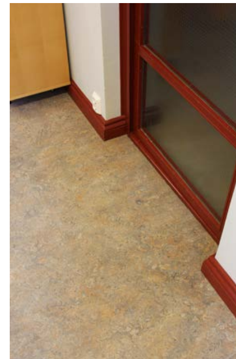
324. Lattiamateriaalina on linoleum-matto. Tila on palo-osastoitu teräskehäisellä lasioivella.
