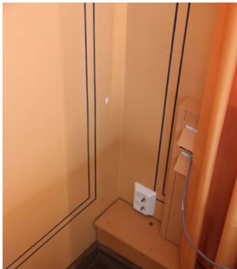
435. Sähköpistorasioiden ja tietoverkkojen johdotukset ja kalusteet vaativat runsaasti tilaa. Vasemmalla tekniikka on upotettu parkettiin. Oikealla pystyy nostettu ja seinän sävyllä maalattu kaapelikotelo.
