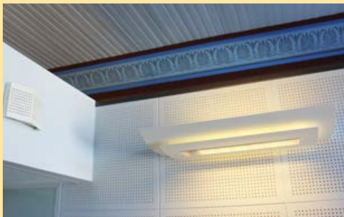
259. Toisen kerroksen salin tilanjakaseinää.
