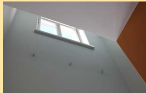
261. Porrashuoneen sileäksi rapattua ulkoseinää.
