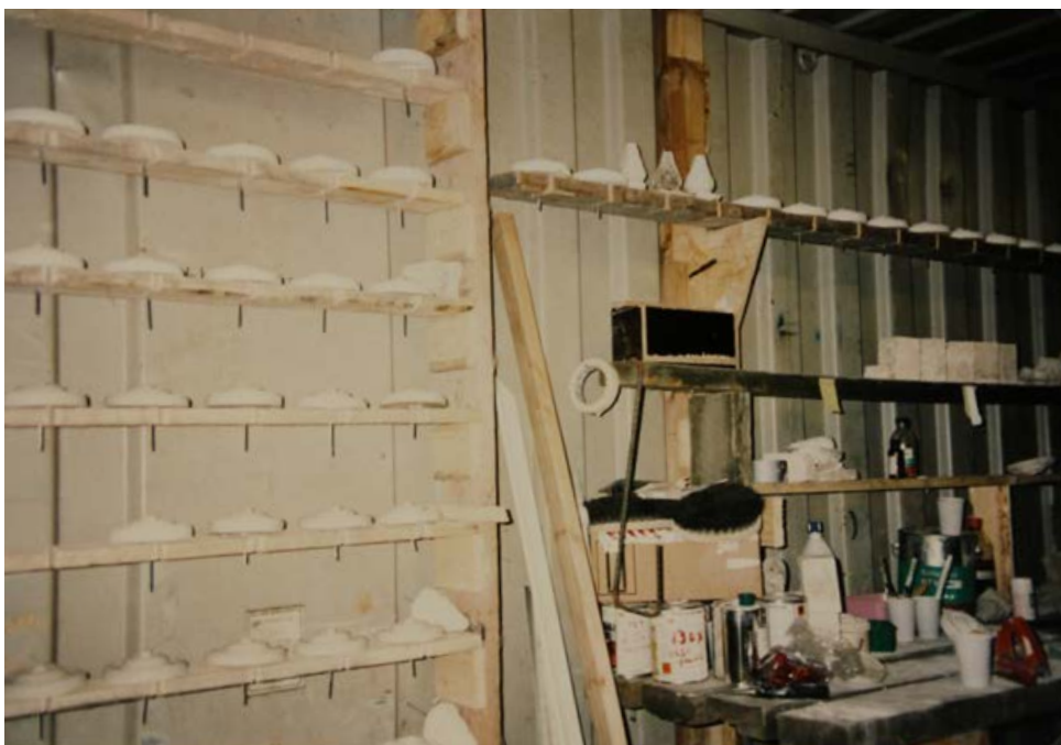
135. Julkisivun puuttuvat koristeet valettiin työmaalla. Työssä käytettiin 1980-luvulla yleistynyttä silikonimuottia. Kuvassa valoksia kuivumassa. KUVA: Kuopion lääninhallituksen arkisto, Ulla Hiltunen
