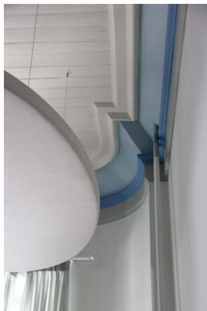
302. Varalääninsihteerinhuoneenulkokulmatonpyörästetty. Alkuperäinen alakatto listoituksineen on säilynyt. Tila 116.
