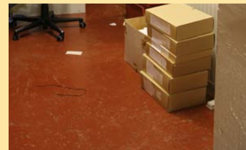
279. 1930-luvun maalattua betonilattiaa kellarissa.
