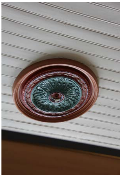
372. Salin kattorosetti kopioitiin vestibyylistä.
