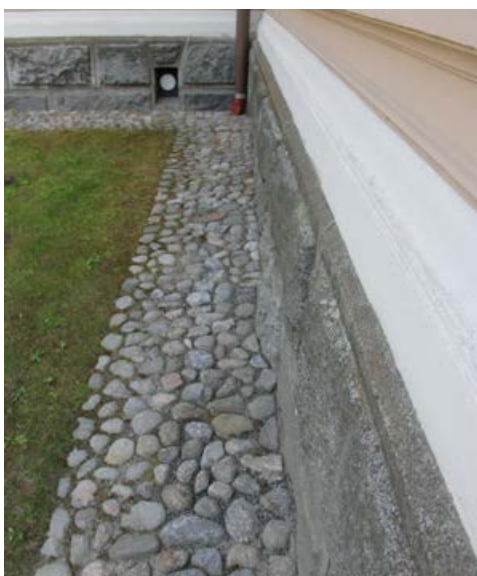
226. Länsipäädyssä sadevedet johdetaan suljetun maanalaisen putkiston kautta kokoojakaivoon.
