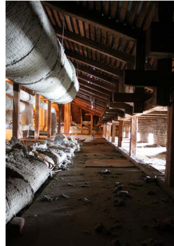
418. Harjan suuntainen näkymä puutarhan puoleiselta käytävältä. Lisäeristeen yläpinnan tasolle jääneet haukkaikkunat antavat tilaan luonnonvaloa.
