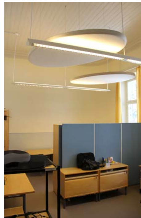
323. Länsipäädyn alakattona on alkuperäinen helmiponttikatto, jota reunustaa koristelematon kattolista. Tila 128.
