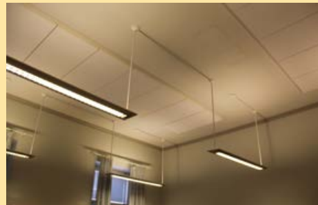
247. 1970-luvun levykatto tilassa 118
