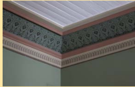
234. Katon ja seinän liittymä tilassa 217
