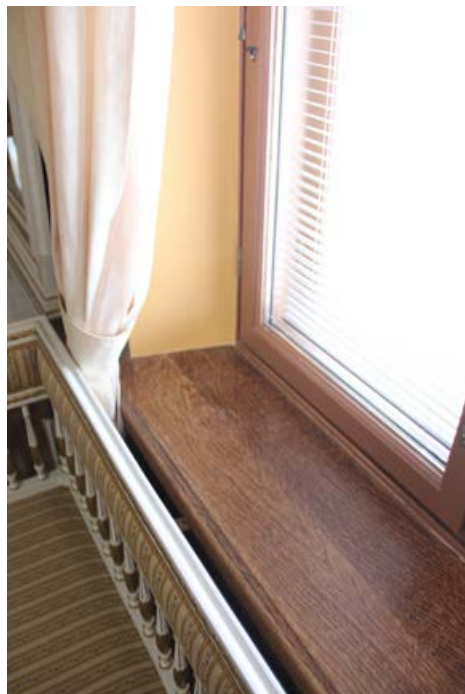
359. Ootrattu ikkunapenkki. Ikkunapuite on ruskea.
