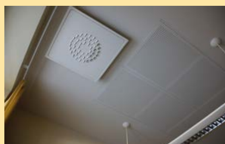
246. 2000-luvun levykatto tilassa 206
