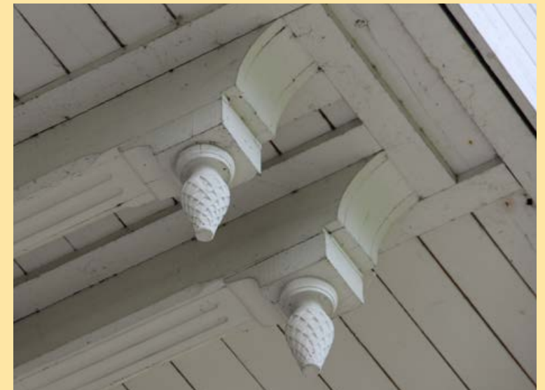
202. Käpykoriste parvekettä kannattavassa konsolissa. Kaikki parvekkeen puuosat uusittiin painekyllästetyistä puusta vuonna 1979.
