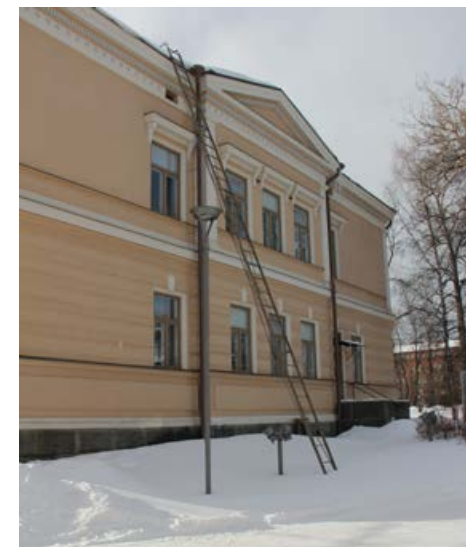
220. Katollejohtavat metallitikkaatovatsäilyneet rakennuksen itäpäädyssä.
