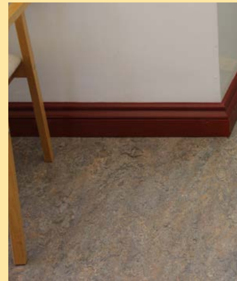
273. Rakennuksen yleisin lattiapinnoite on ruskeanharmaa Forbo-linoleum.
