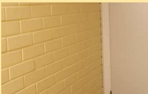
263. Kellarin muurattua väliseinää 1970-luvulta.
