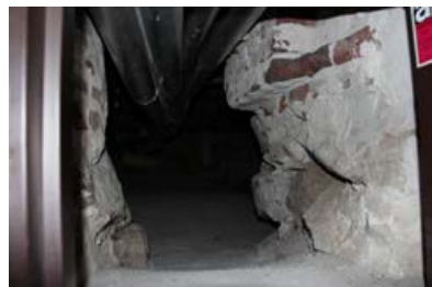
404. Varatieluukku johtaa laipioon 024.
