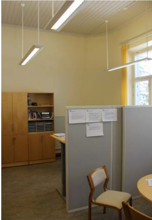
387. Huoneiden ulkonurkat on pyöristetty. Länsipäässä alakatto on tehty puupanelista. Kattolista on yksinkertainen ja koristeeton. Tila 128.
