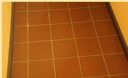
276. Kellarin käytävän keraamista laattaa.
