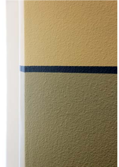
389. Seinätontasoitettu ja maalattua lakerrantöhuoneiden tavoin. Seinän ala- ja yläosan sävyjä erottaa sininen viiva.
