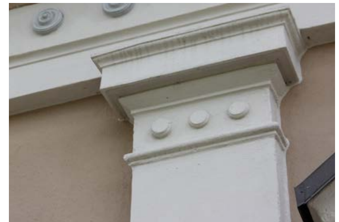
179. Pilasterit kannattelevat ruusukkeilla koristeltua arkkitraavia.
