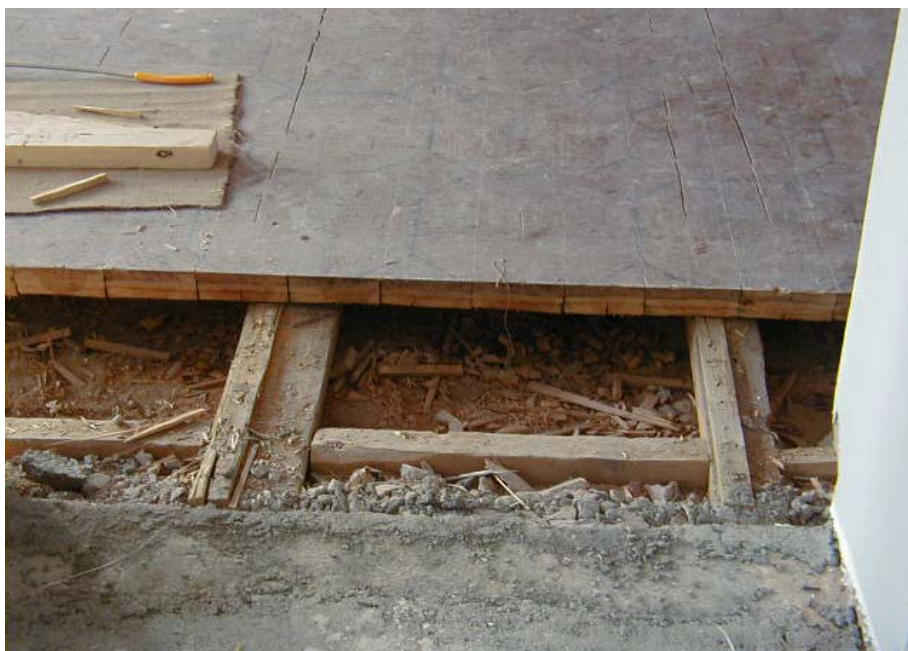
137. Yleisöaulan lattia avattuna seinän vierestä. Lattialankulla on vahvuutta 70 mm ja siihen on ootrattu par-kettikuvio. KUVA: Kuopion lääninhallituksen arkisto, Ulla Hiltunen
