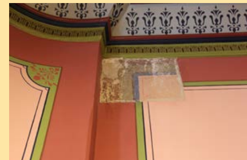
258. Alkuperäistä seinämaalausta on jätetty näkyviin.
