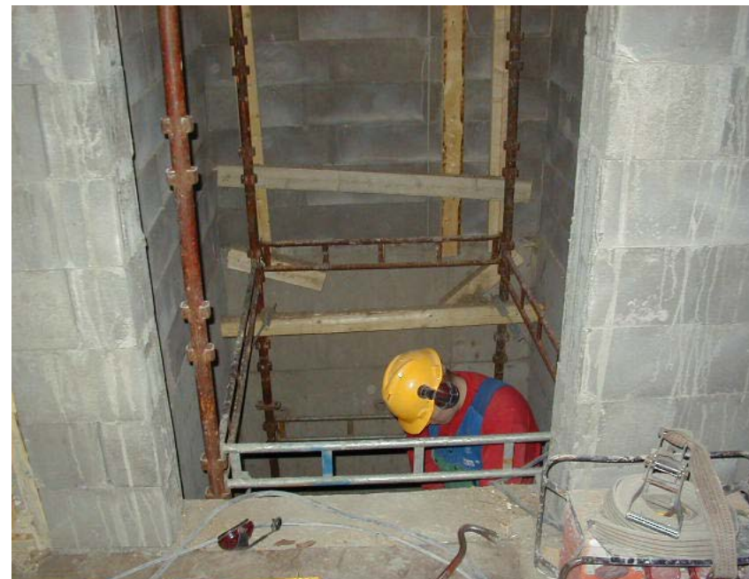
146. Hissikuilun muurattua runkoa rakennetaan. KUVA: QVIM Arkkitehdit
