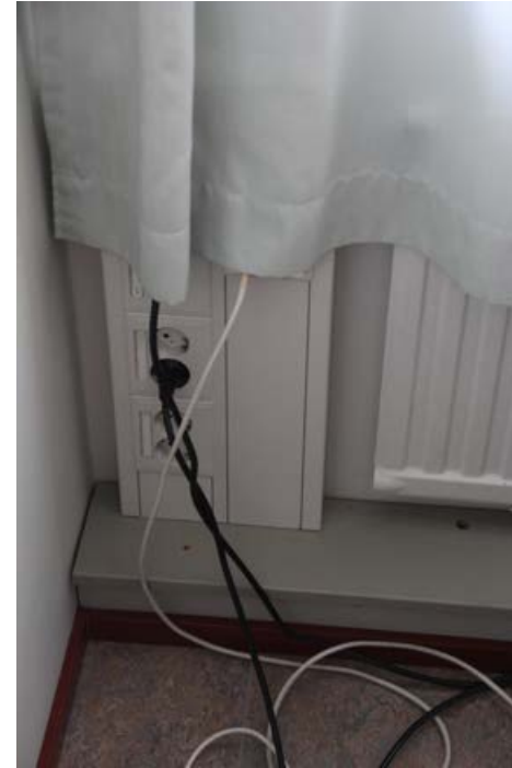
384. Sähkö- ja atk-johdot kulkevat koteloituina ulkoseinällä. Tilanpuutteen vuoksi pistokkeet on sijoitettu tornimaiseen kouruun.
