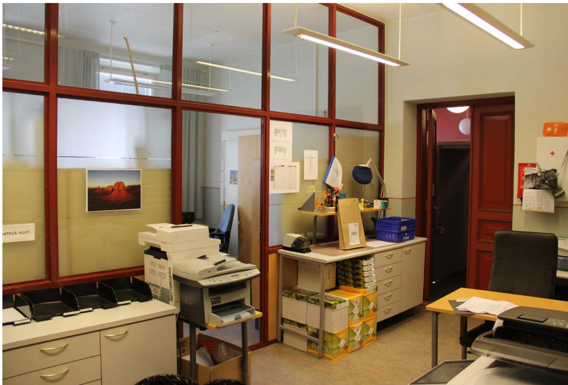
301. Teräsrakenteinen lasiseinä erottaa entisen virastomestareiden työtilan ja entisen osastosihteerin huoneen.
