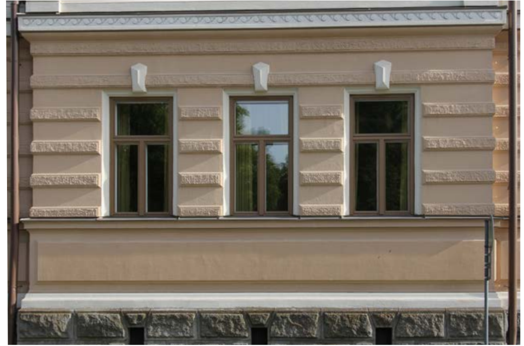
204. Päätyjulkisivun ensimmäisen kerroksen T-ikkunat. Toisessa kerroksessa ikkunat ovat suurempia.
