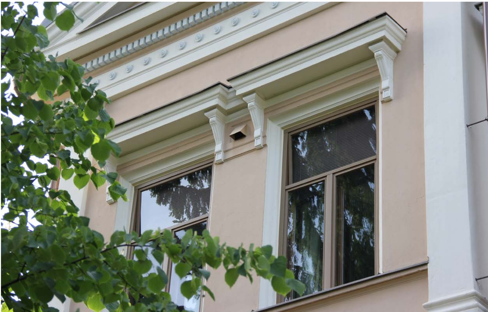
217. Toisen kerroksen sivurisaliitin ikkunapari. Kuvassa yläsaranoitdut yläikkunat ovat raollaan.
