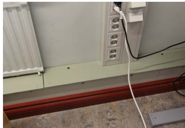
320. Tekniikkaa ikkunan alapuolella.
