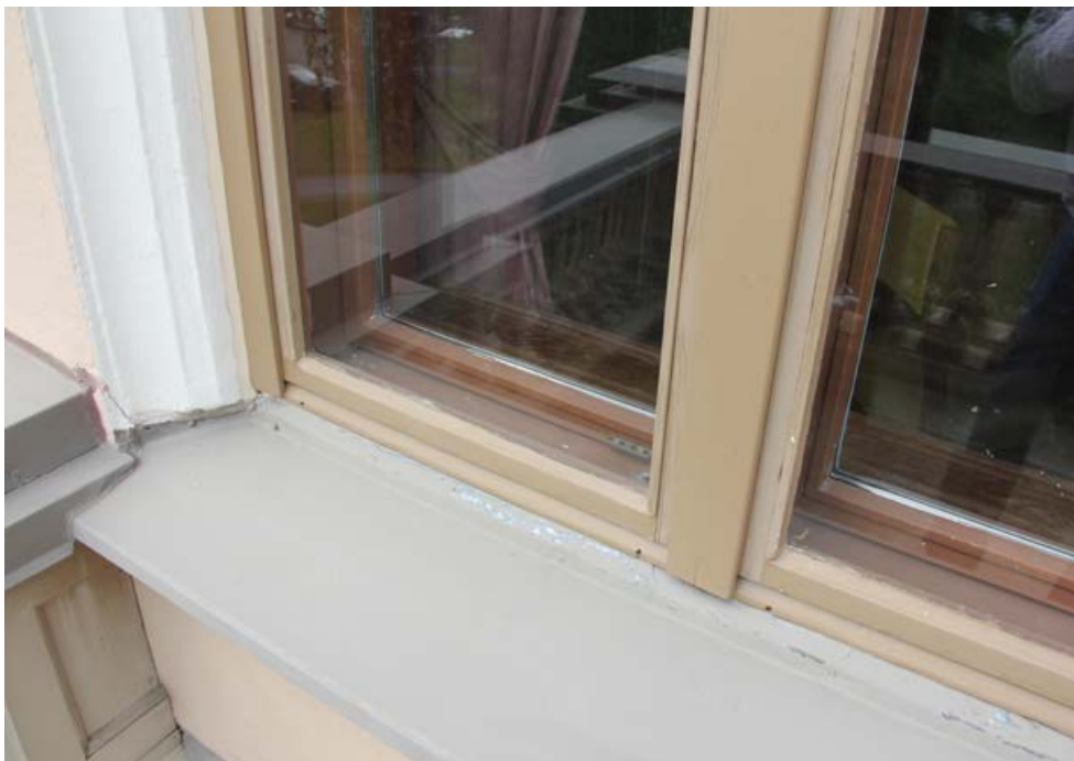
207. Ikkunat on uusittu vuonna 1979. Yksilasiset ulkopuitteet on tehty painekyllästetystä puusta.
