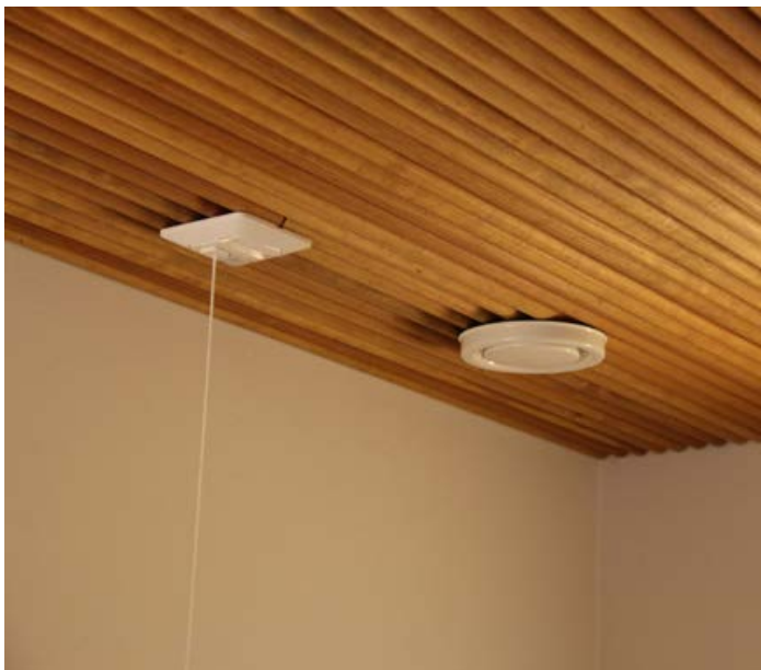
333. Alakatoissa on käytetty jälleenrakennuskaudelle tyypillistä sormipaneelia. Katto on käsitelty öljyvahalla.
