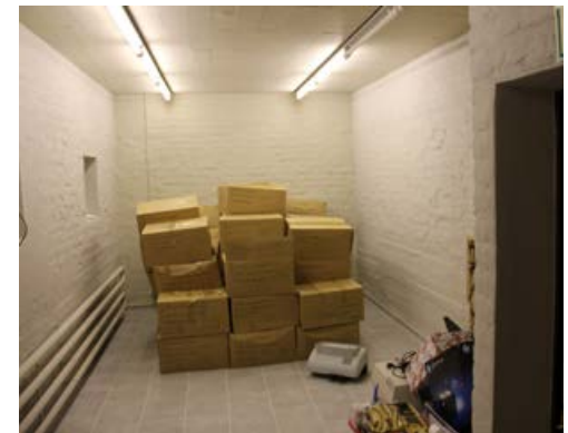
412. Maaherran kellarivarasto 020 on muutettu arkistoksi. Kevyet väliseinät on purettu ja alakatossa on palovilla.
