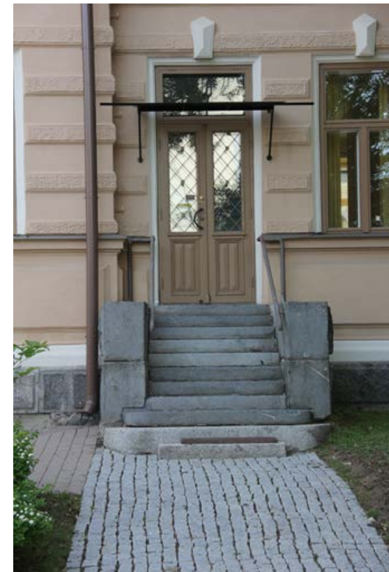
193. Itäsiiven ovi on palautettu alkuperäiselle paikalleen 1979.
