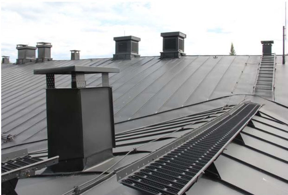
218. Kattomaisemaa lipputangon luota harjan suuntaan. Sydänmuurin kohdalla sijainneista savuhormeista on tehty ilmanvaihtokanavia.
