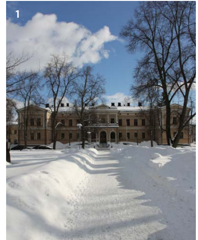
4. Päärakennuksen etufasadi muodostaa Maaherrankadun päätteen.
