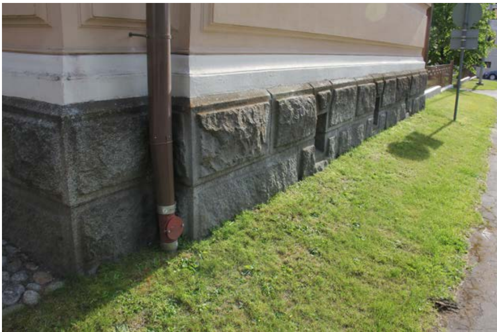
226. Länsipäädyssä sadevedet johdetaan suljetun maanalaisen putkiston kautta kokoojakaivoon.
