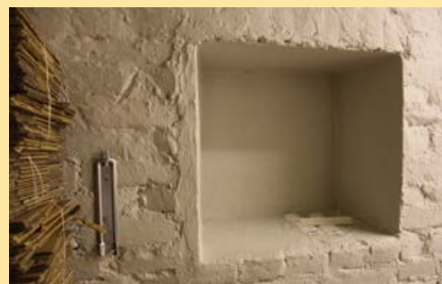
265. Tiilivuorausta kellarin ulkoseinässä.
