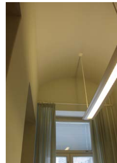
428. Tavanomaisia loisteputkivalaisimia on käytetty luovasti epäsuoraan valaistukseen.
