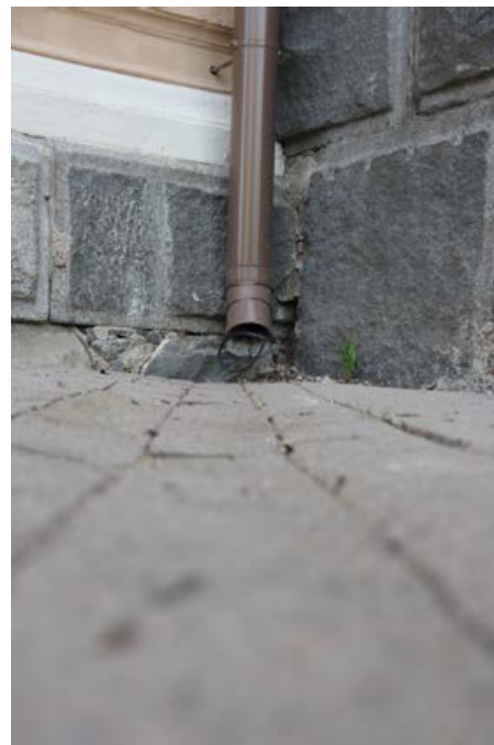
227. Itäpäädyssä vesi johdetaan painaunmia pitkin.
