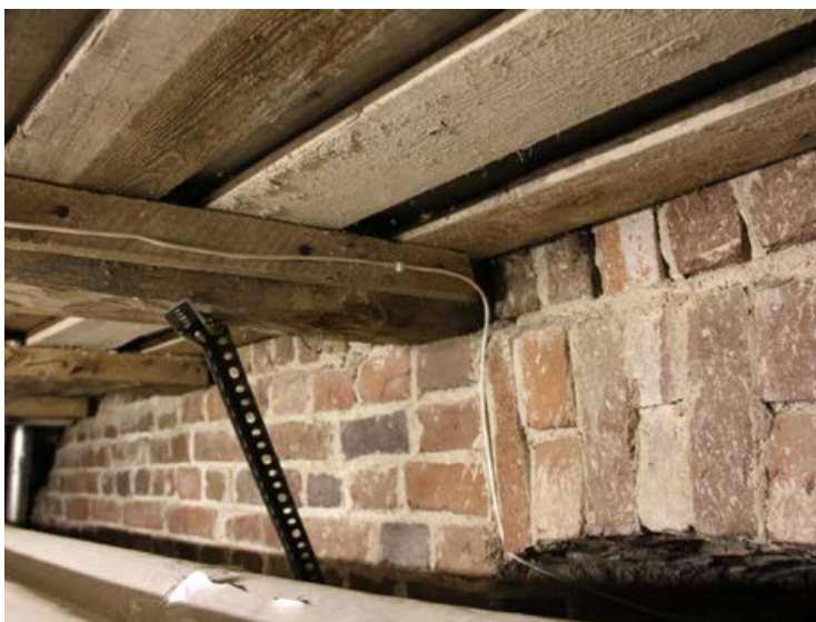
267. Ensimmäisen kerroksen välipohja kellarista katsottuna. Täyteenä käytetty hiekkasammaleos on säilynyt. Kannatinhirsien päät on upotettu ulkoseinämuuriin.
