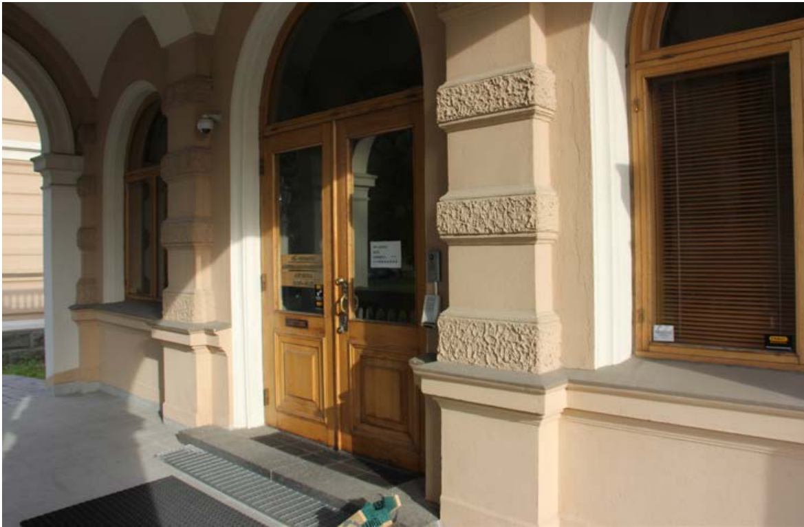
185. Pääoven alkuperäinen ovijärjestys palautettiin vuonna 1979. Sitä ennen pääoven paikalla oli ikkuna ja sitä reunusti kaksi sivuovea.
