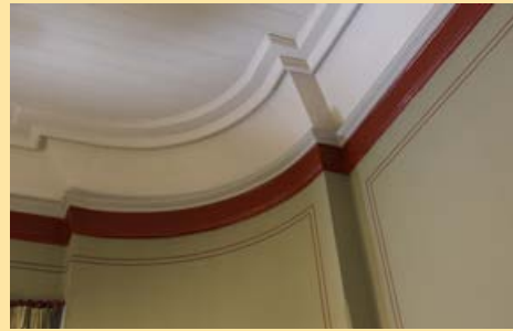
238. Katon ja seinän liittymä työhuoneessa 223
