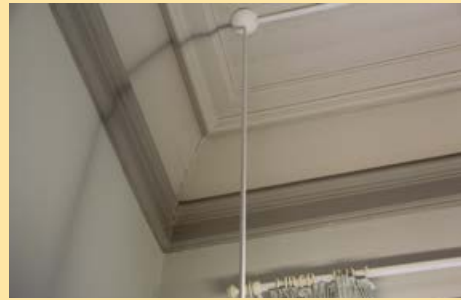
239. Katon ja seinän liittymä työhuoneessa 117
