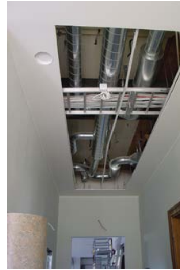
434. Alaslaskettujen kattojen purkaminen edellytti uusien reittien etsimistä lukuisille johdoille ja putkille. Oikealla modernin työhuoneen kattoon tehtyjä asennuksia. KUVA: QVIM
