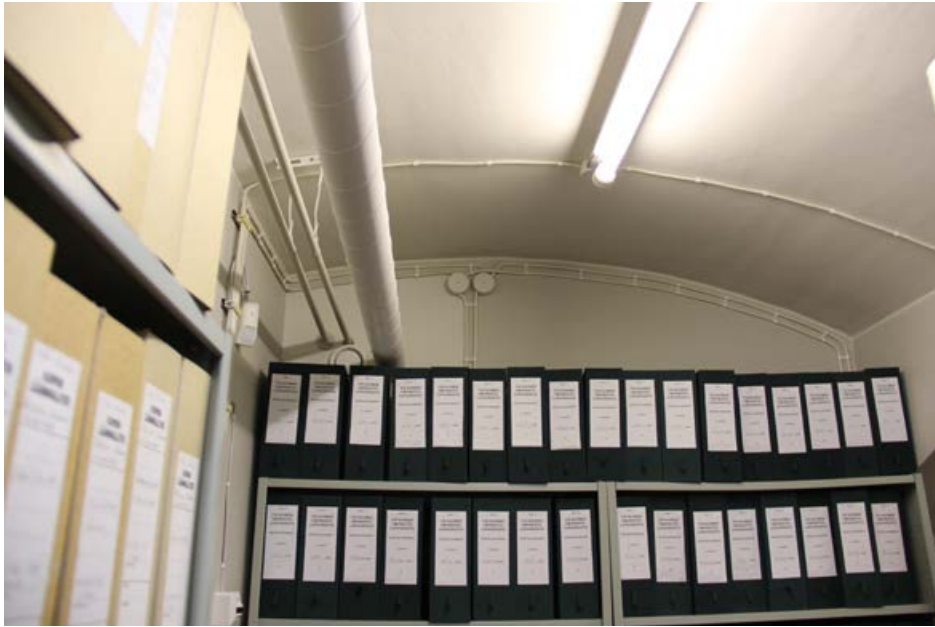
414. Arkistohuone 017 suunniteltiin alun perin lääninkassan holviksi. Sisäportaan asemesta kulku holviin rakennettiin ulkopuolelle. Katto on tehty tynnyriholvin muotoon.
