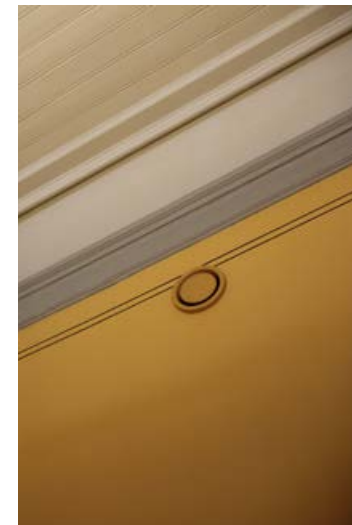
436. Ilmanvaihtventtiilin muoto ja näkyvyys riippuu tilan arvokkuudesta. Ennallistetuissa tiloissa tekniikkaa on pyritty häivyttämään.
