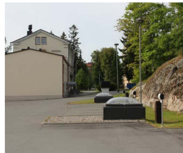
169. Maanalaisen ja maanpäällisen pysäköinnin rakenteita.
