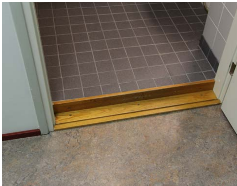
334. Lattiamateriaalina on harmaa kuivapuristelaatta 100x100. Käytävän ja WC:n välillä on tuulettuva kynnyks
