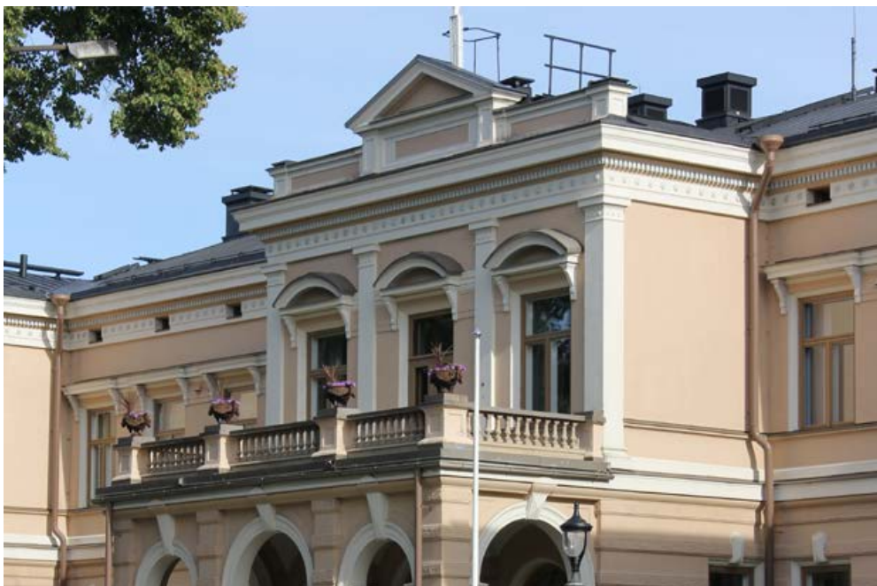
197. Piispanpuistoon avautuva parveke on uusrenessanssille tyypillinen holvikaarten kannattelema altaani.
