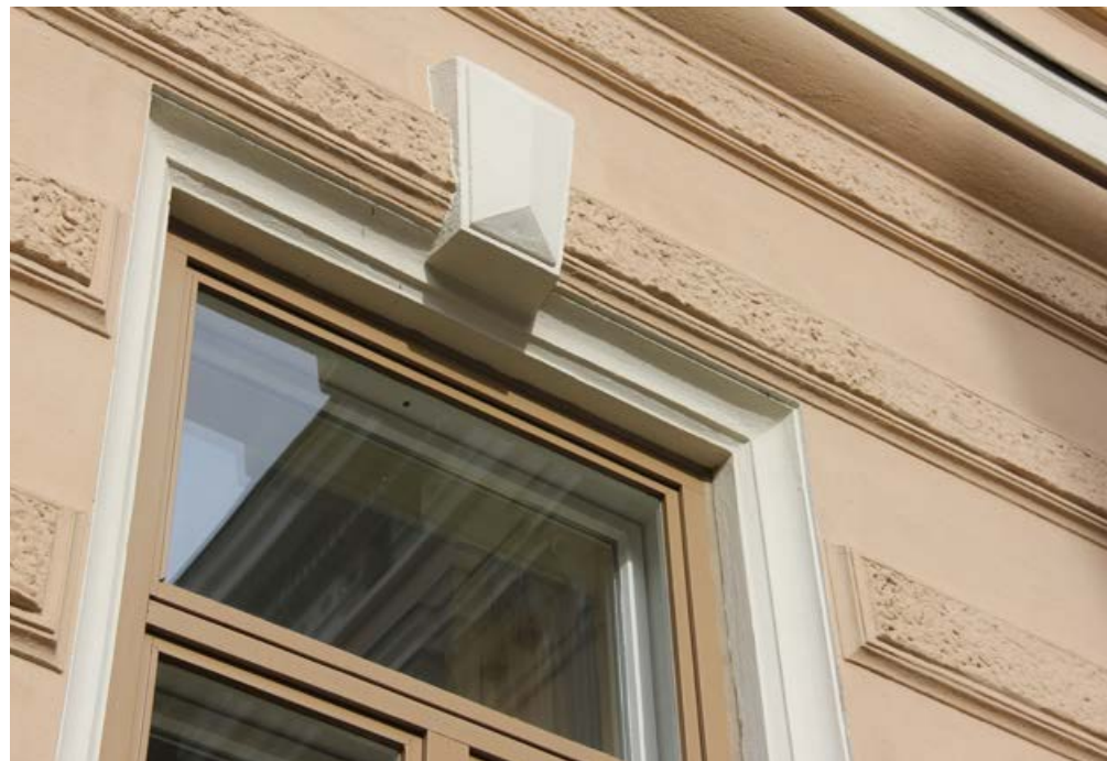
208. Yläsaranoitu yläikkuna avautuu sisäänpäin.
