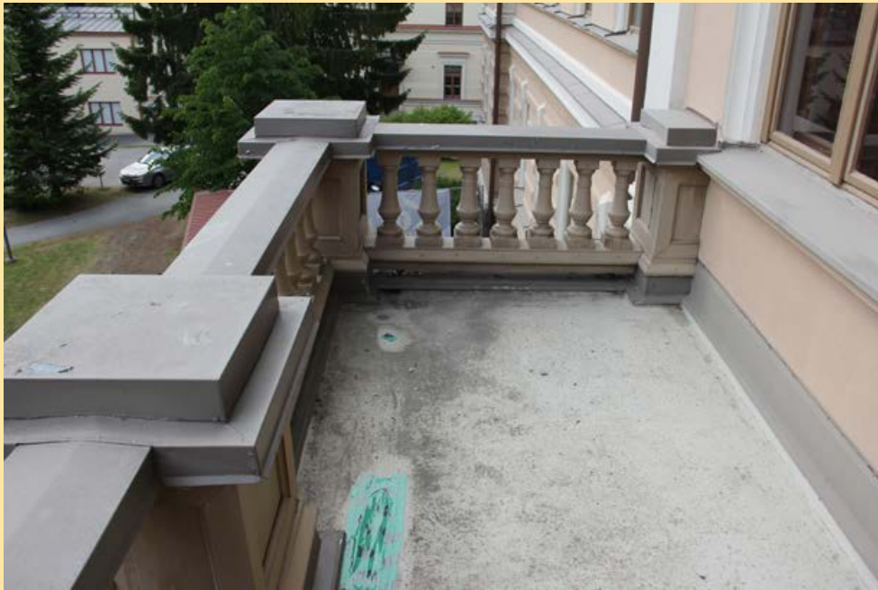
200. Maaherran parveke on uudistettu vuoden 1979 peruskorjauksessa. Parvekkeen teräksiset kannattajat jatkuvat yhtenäisenä maaherran työhuoneesta parvekkeelle asti.
