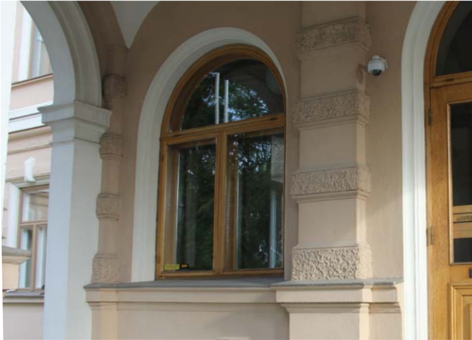
203. Pääsisäänkäynnin kaari-ikkunat on palautettu ulko-ovien paikalle vuonna 1979. Puitteet on tehty tammesta.
