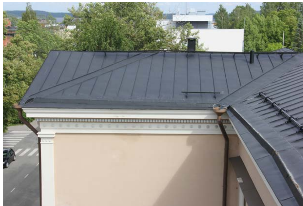
219. Itäisen poikkiharjan kattolapetta. Jiirit on tehty kouruiksi. Vesiä ohjaa myös räystäään tuntumaan asennetut jalkarännit.
