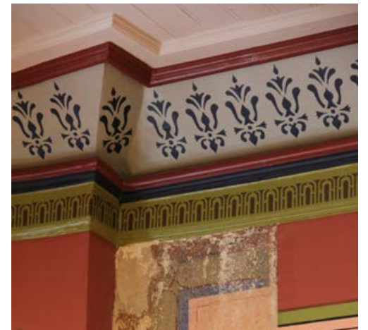
380. Työhuoneessa 216 on jätetty näkyville alkuperäistä koriste-kerrostumaa.
