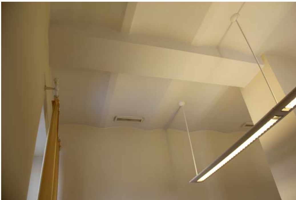
322. Itäpäädyn kolmikerroksisen arkiston välipohja oli rautakiskoilla ja poikkipalkilla tuettu kappaholvi. Poistettujen portaiden tilalle on tehty levykatto. Tila 111.
