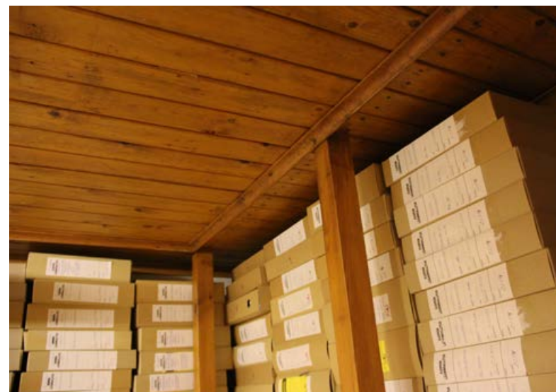
405. Varaston alakatto ja hyllyjen päädyt on tehty petsilakatusta paneelista 1930-luvulla.
