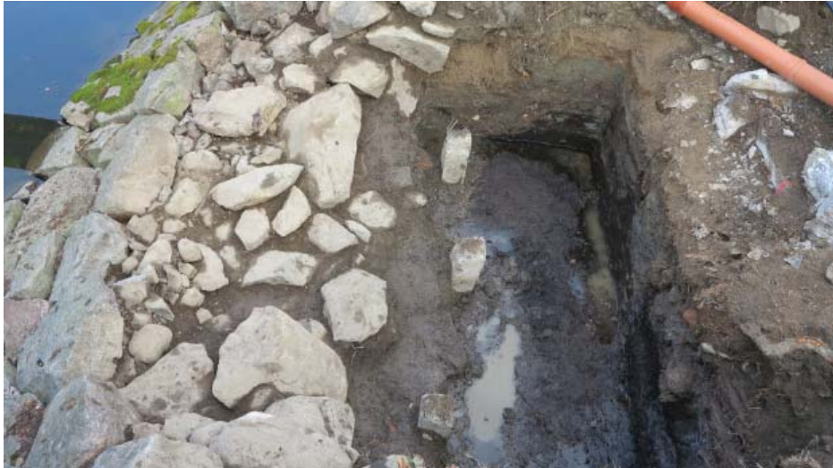
Eskarppimuurin kuorikivien ja kivikerroksen takana oli saveen ladottu kivirakennus. Suo on ulottunut muurin taakse asti. Kivirakenteen takana oleva tumma maa on turvetta. Päivi Hakanpää 2015, Museovirasto AKDG4680:76.
