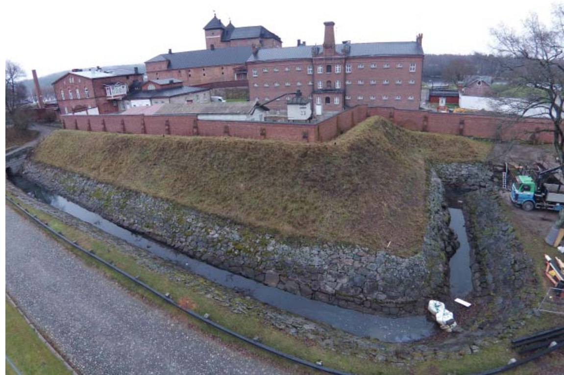
Tenaljin rintamuurin päälle rakennettiin 1800- ja 1900-lukujen vaihteessa vankilan tiilimuuri. Teemu Mynttinen 2015, Senaatti-kiinteistöt.
