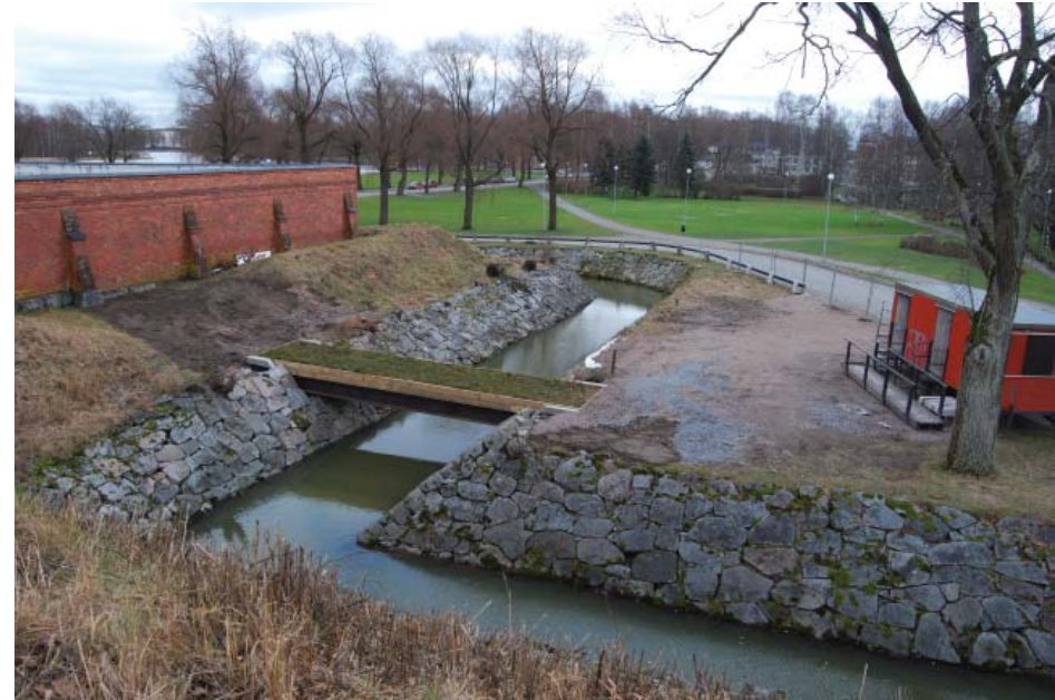
Uusi tekniikkasilta sai viherkannen. Sanna Ihatsu 2016, CasaCo Studio Oy.
