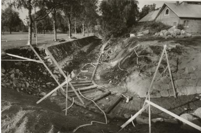
Vuonna 1987 otetussa valokuvassa näkyy 4.puolibastionin kärjen eskarppimuurin alla olevat hirret liitoskohtineen. P. O. Welin 1987, Museovirasto RHOHL8980.
