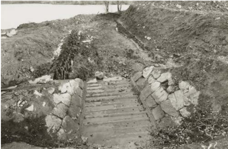
Kuva on itärannan vallihaudan päästä. Kivimuurien takana näkyvät puupaalurivit ovat vallihaudan edustalle rakennetun puupadon rakenteita. P. O. Welin 1982, Museovirasto RHOHL7546.
