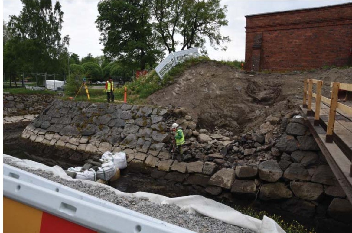
Kesällä 2016 tutkittiin ja korjattiin 3. puolibastionin vasemman siiven rakenteita ja vallihaudan perustuksia. Sanna Ihatsu 17.5.2016, CasaCo Studio Oy.
