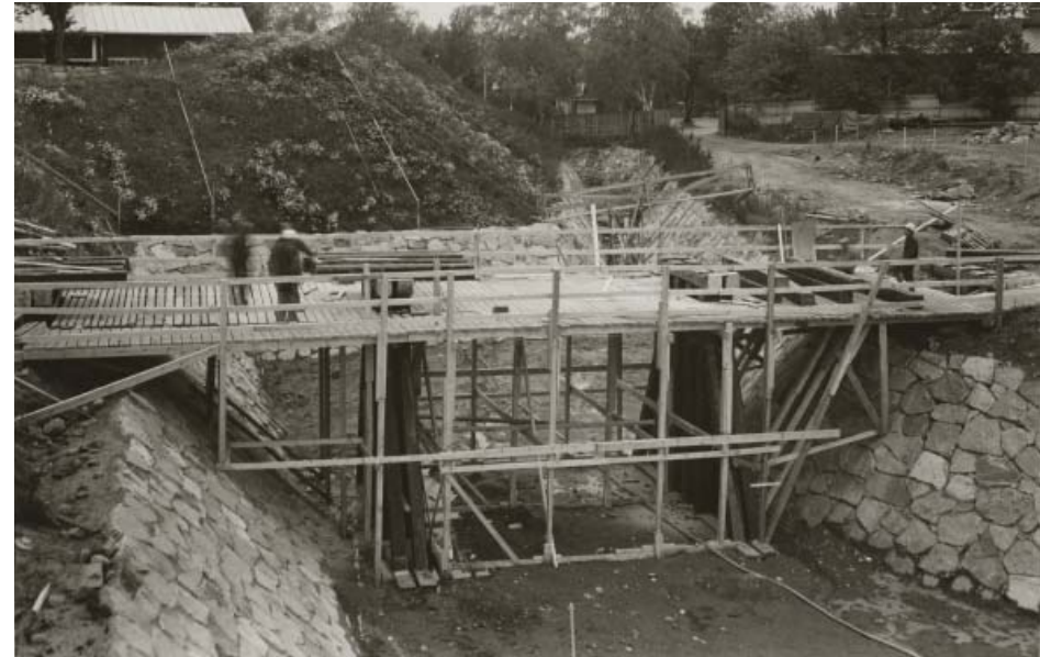
Sillan kansityöt käynnissä. P. O. Welin 1982, Museovirasto RHOHL8539.
