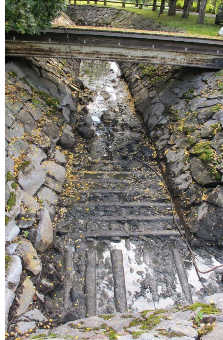
3. puolibastionin ja tenaljin kulmassa säilynyttä hirsiperustusta. Päivi Hakanpää 2013, Museovirasto AKDG4688:37.
