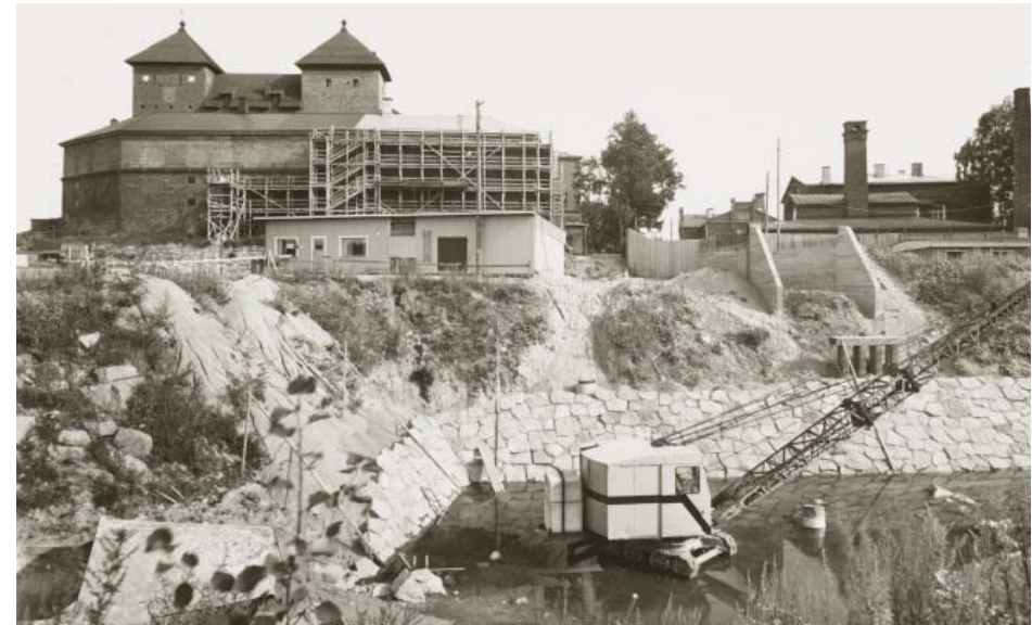
Pohjoisen polygonin vallit ja silta-allas korjaustöiden aikana. P. O. Welin 1981, Mu-seovirasto RHOHL8535.
