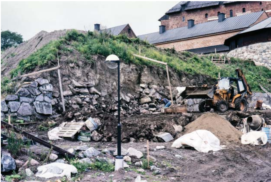
Puolibastionin vasemman siiven eskarppimuuri korjaustöiden aikana 1980-luvulla. Museovirasto RHOHL124810.
