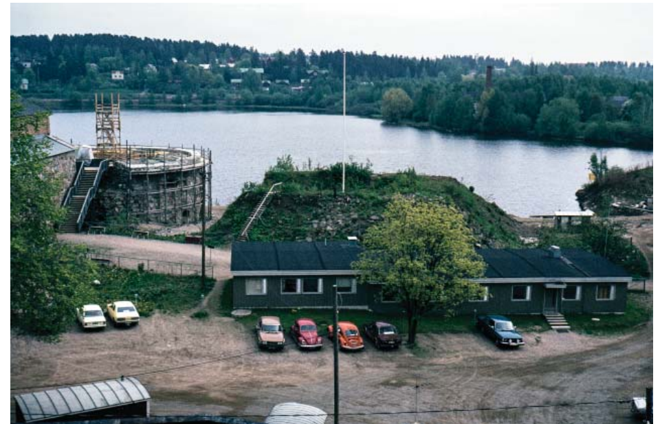
5. puolibastioni rondellin korjaustöiden aikana. P. O. Welin 1983, RHOHL124806.
