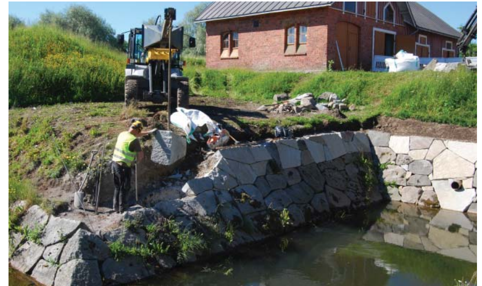
Muurien korotustyöt 4. ja 5. puolibastionien alueella. Sanna Ihatsu 1.7.2015, Casa-Co Studio Oy.
