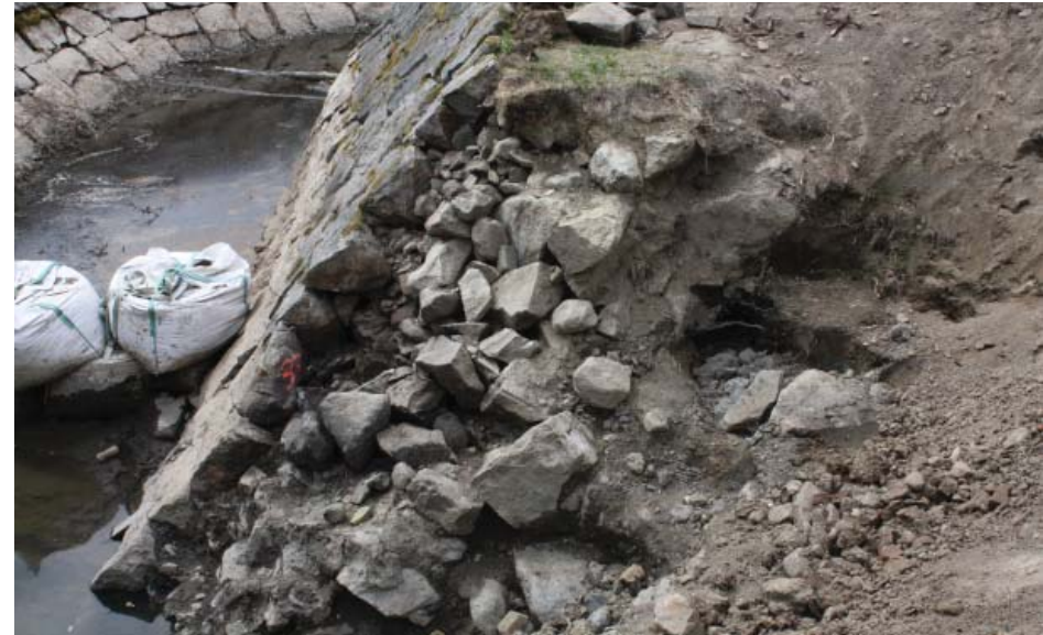
3. puolibastionin vasemman siiven eskarppimuurin rakenne. Katja Vuoristo 2016, Museovirasto AKDG4721:53.
