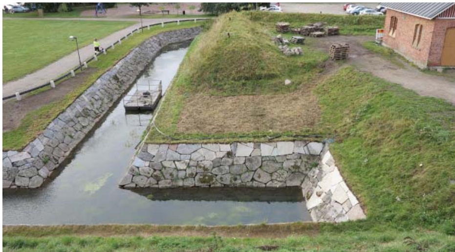
4. puolibastionin vasen siipi ja bastionin kärki rakennettiin uudelleen 1980-luvulla. Puolibastionin kivimuureja korotettiin vuosina 2014-2015. Sanna Ihatsu 2015, CasaCo Studio Oy.
