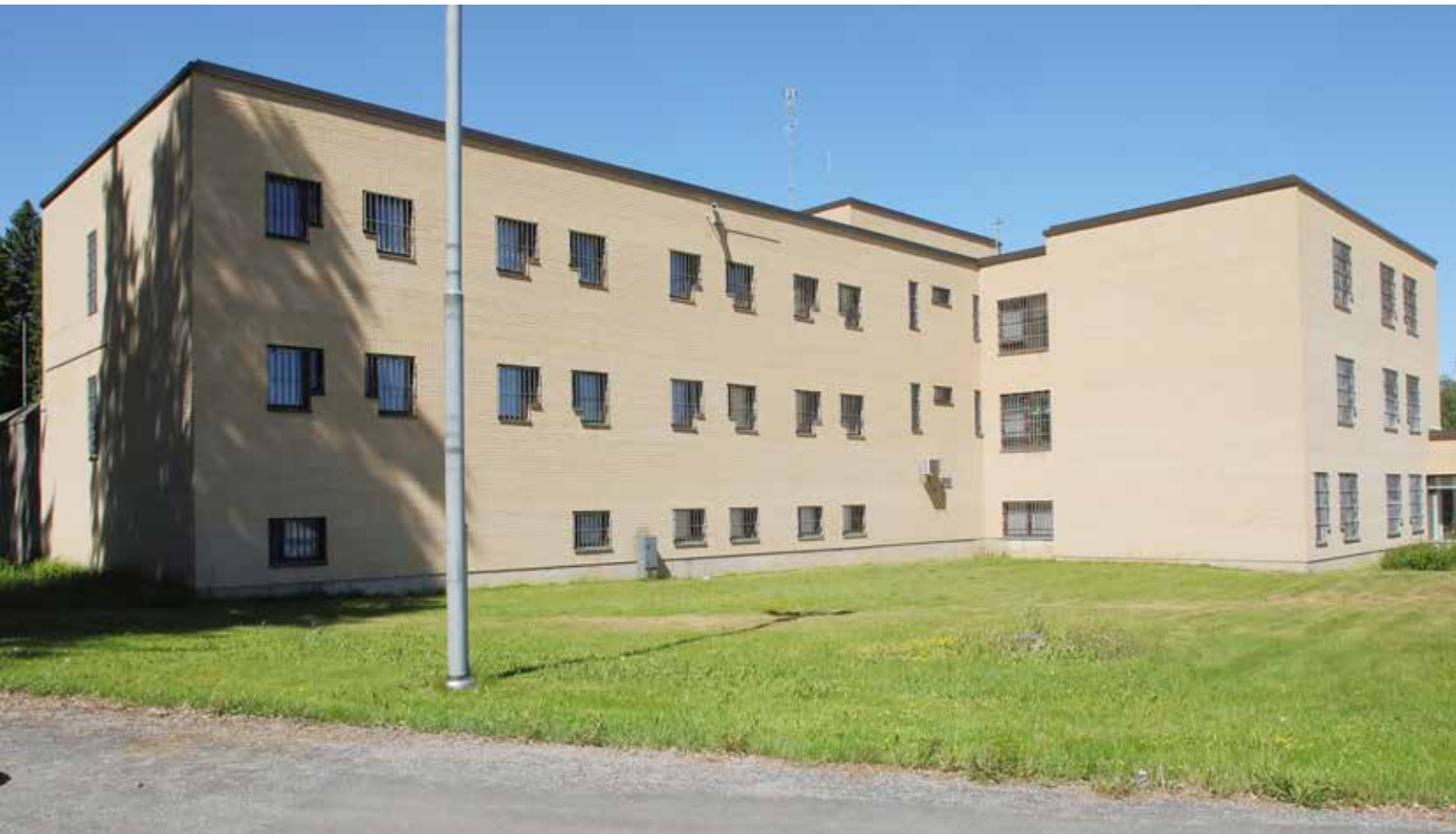
Potilashuoneiden ikkunat on sijoitettu erillisiksi aukoiksi tiilipintaan. Kahden huoneen ikkunat ovat toistensa peilikuvia ja tästä syystä muodostavat pareja. Sokkeli on matala ja siinä on raakabetonipinta.
