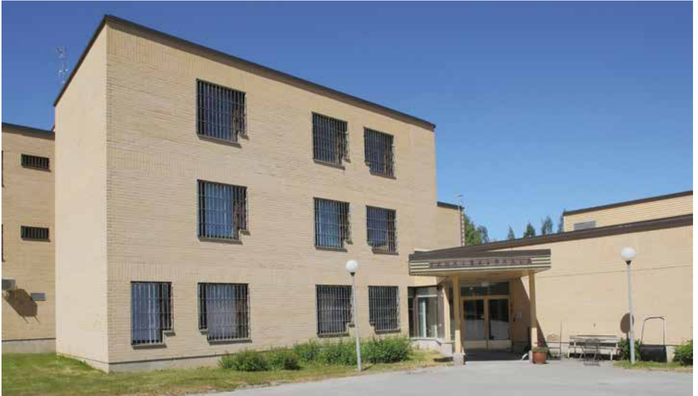
Vankisairaalan pääsisäänkäynti on rakennuksen kaakkoiskulmasta teräsrakenteisen katoksen alta. Tiilijulkisivua elävöittää pystyyn ladottujen tiilien nauhat katonreunan alla ja ikkunoiden päällä.
