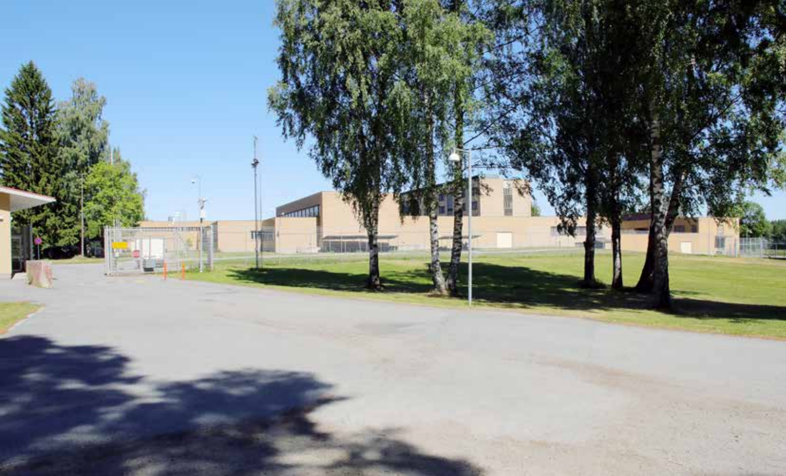
Vankilassa yhdistyvät eri korkuiset rakennusosat ja niitä yhdistävät tiilimuurit. Varsinaista ympärysmuuria ei rakennukseen tullut, nykyinen teräsverkkooita on 2000-luvulta.
