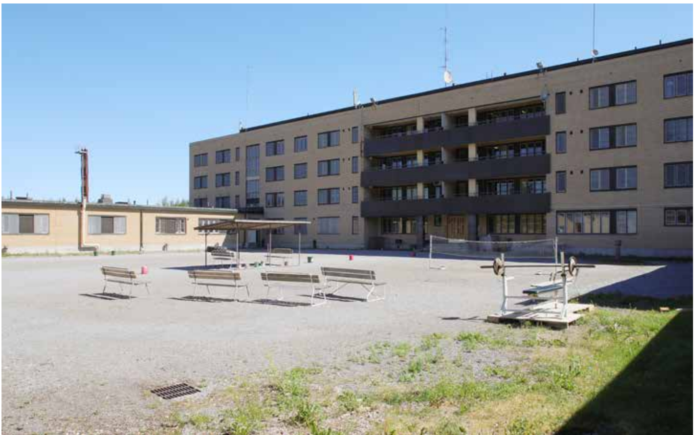
Rakennuskokonaisuuden keskellä oleva pääpiha tuli miesten ulkoilupihaksi. Sitä reunustavassa selliosassa on kullakin osastolla yksi parveke pihalle päin. Kuvan vasemmassa laidassa näkyvässä matalassa osassa toimi miesten tutkintovankiosasto.
