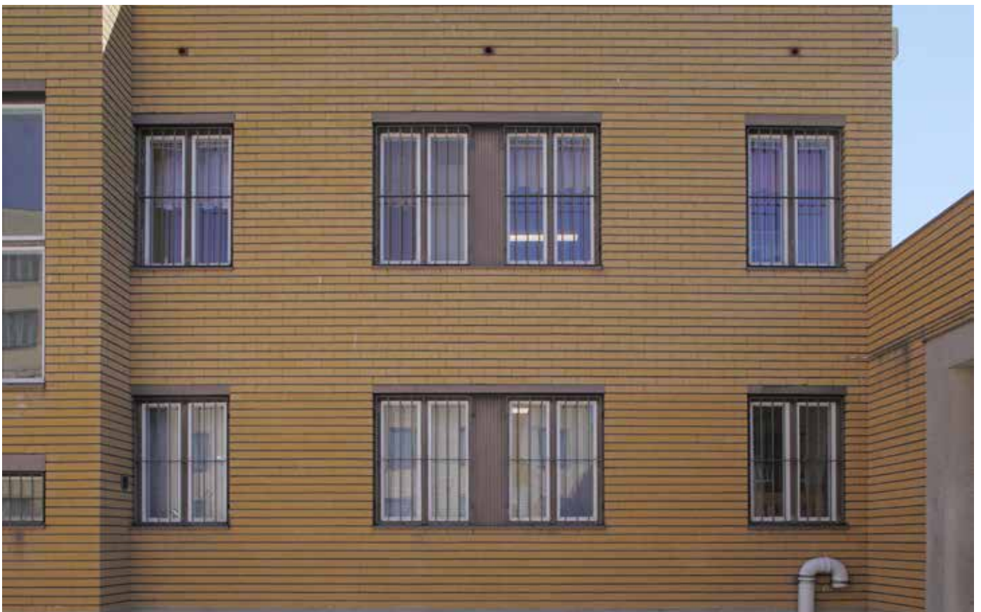
Vankilan selliosaston ikkunat on jäsennetty pareittain. Ikkunoiden puitteet ovat valkoiset ja niiden ulkopuolelle on lisätty tumman ruskeat peitelistat. Ne antavat kontrastia keltaiseen tiilipintaan. Puuikkunoiden väliset osat ovat muotoiltua peltiä.
