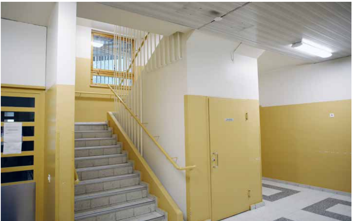
Rakennuksen lounaiskulmassa sijaitseva porrashuone kiertää umpinaista hissikuilua. Se on yhdellä lepotasolla varustettu, askelmat on päällystetty mosaikkibetonilaatoin ja myös jalkalista on mosaikkibetonilaattaa. AS.
