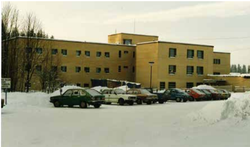
Vasta valmistunut vankisairaala vuoden 1985 lopulla tai vuoden 1986 alussa. Rakennuksen edessä on vielä rakentamisaikaisia esteitä ja suojia. Kuvaaja tuntematon. Vankilan arkisto.
