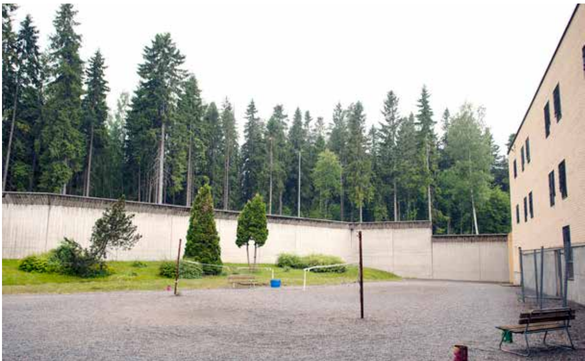
Vankisairaalan ulkolupihää ympäröi kahdelta suunnalta korkea, elementeistä tehty betonimuuri, joka luo vankilan ulkolupihaja vahvemman vaikutelman eristämisestä. Piha on sorapintainen, mikä hankaloittaa liikuntaesteisten potilaiden ulkoilua. Kuvassa oikealla oleva varkkoaita on laitettu esteeksi, jotta ulkolupihalta ei voisi suoraan huutaa tai jutella viereisiin selleihin.
