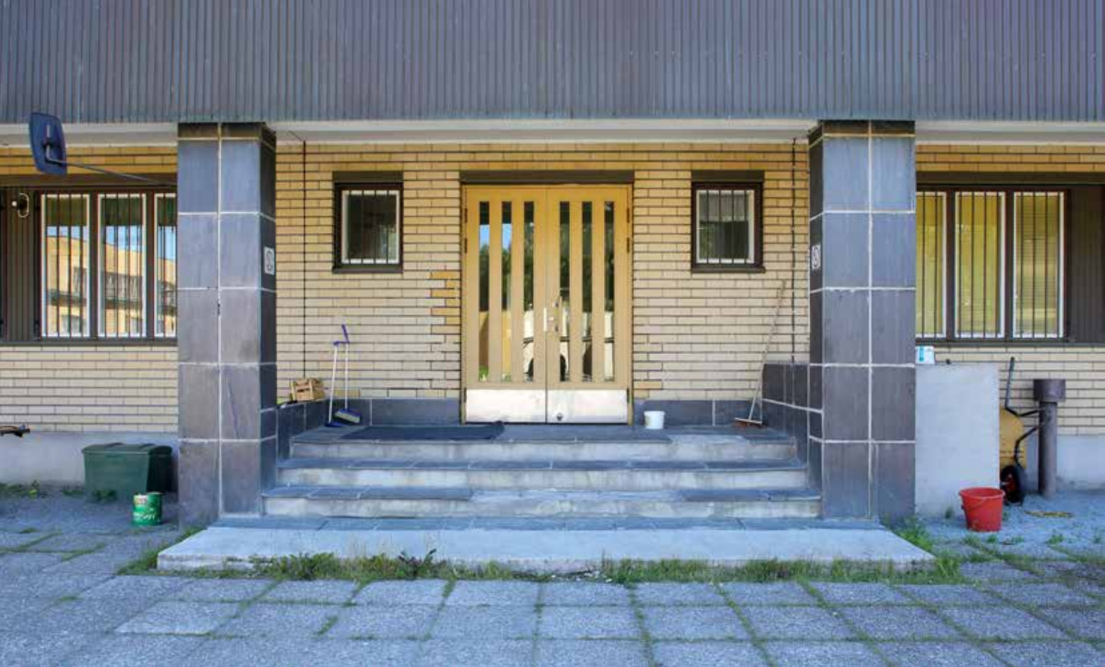
Pääpihan pääsisäänkäynnissä toistuu henkilökunnan pääsisäänkäynnistä tuttu sisennetty jäsentely, liuskekivellä päällystetyt portaat ja kaksilehtinen, kapeilla lasiosilla ja potkupellillä varustettu ovi.
