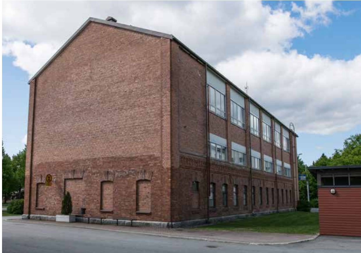
Rakennuksen julkisivusta erottuu hyvin eri aikoina valmistuneet kerrokset. Ensimmäisessä kerroksessa on säästetty alkuperäiset ikkuna-aukot niissäkin kohdissa, joista ikkuna on poistettu. Nurkkapilasterit ja liseenit ovat korotusosan arkkitehtonisia elementtejä, jotka on poimittu rakennuksen ensimmäisestä rakennusvaiheesta.
