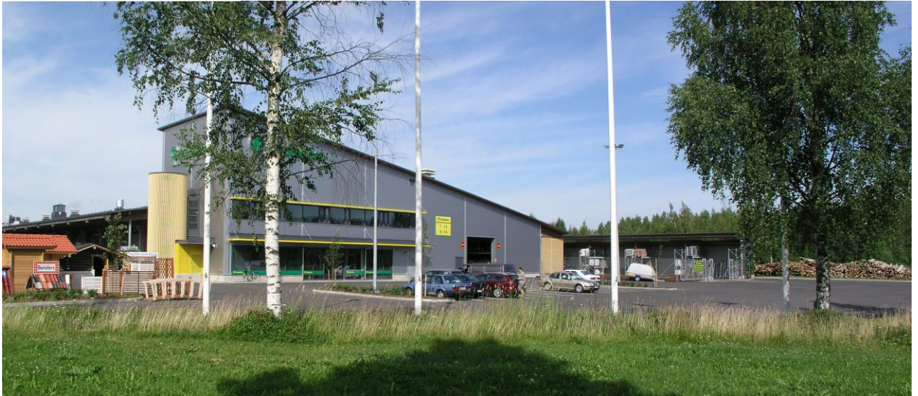
Puukeskuksen myymälä- ja varastorakennus kuvattuna Mukkulankadun suunnalta.
