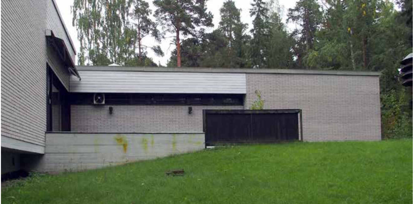
Terassin betonimuuri on alkuperäinen, mutta sen jatkoksi on lisätty puurakenteinen aita.
