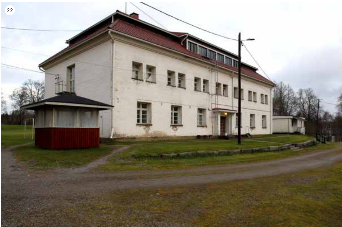
Rakennus lounaasta kuvattuna. Etualan muurirakennelma ja porras ovat alkuperäisiä.
