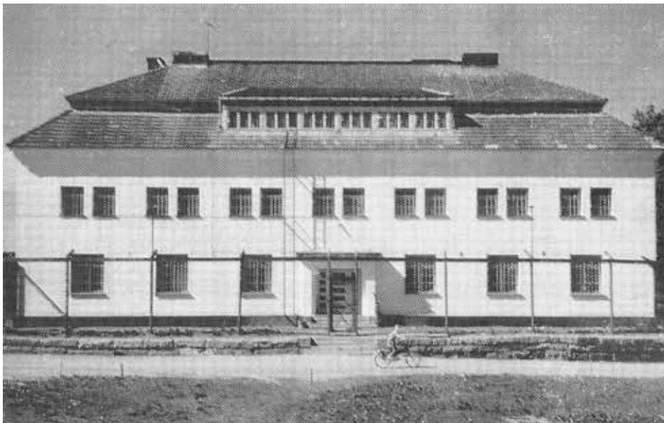
Vankilarakennus etelästä noin vuonna 1968. Valokuvaaja Kauko Tenhovuori.
