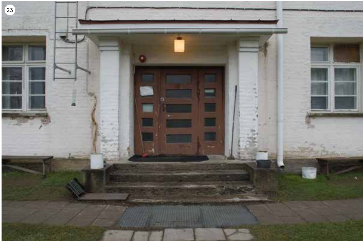
Pääsisäänkäynti sijaitsee eteläjulkisivulla. Ovi, katos sekä porras ovat alkuperäisiä.
