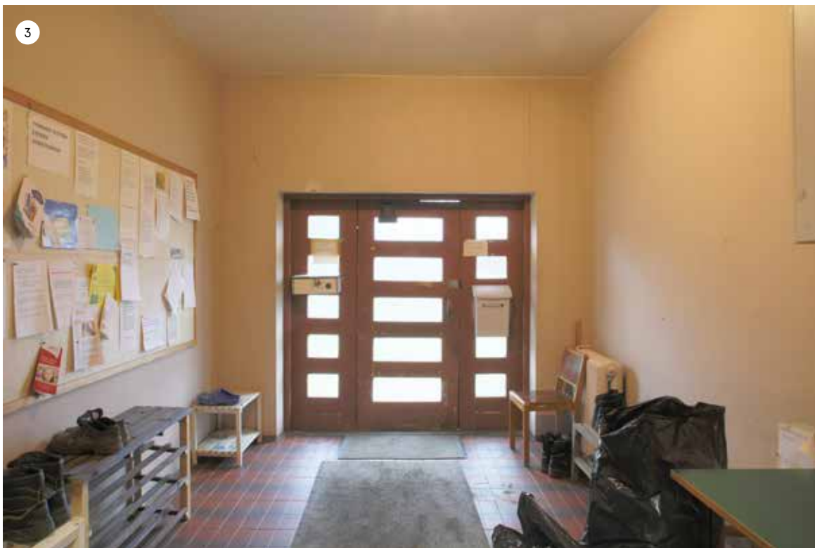
Eteistilassa on säilynyt alkuperäiset ulko-ovet, sekä ovet käytävään. Lattia on uusittu. Oikealla oven vieressä näkyy alkuperäinen lämpöpatteri.
