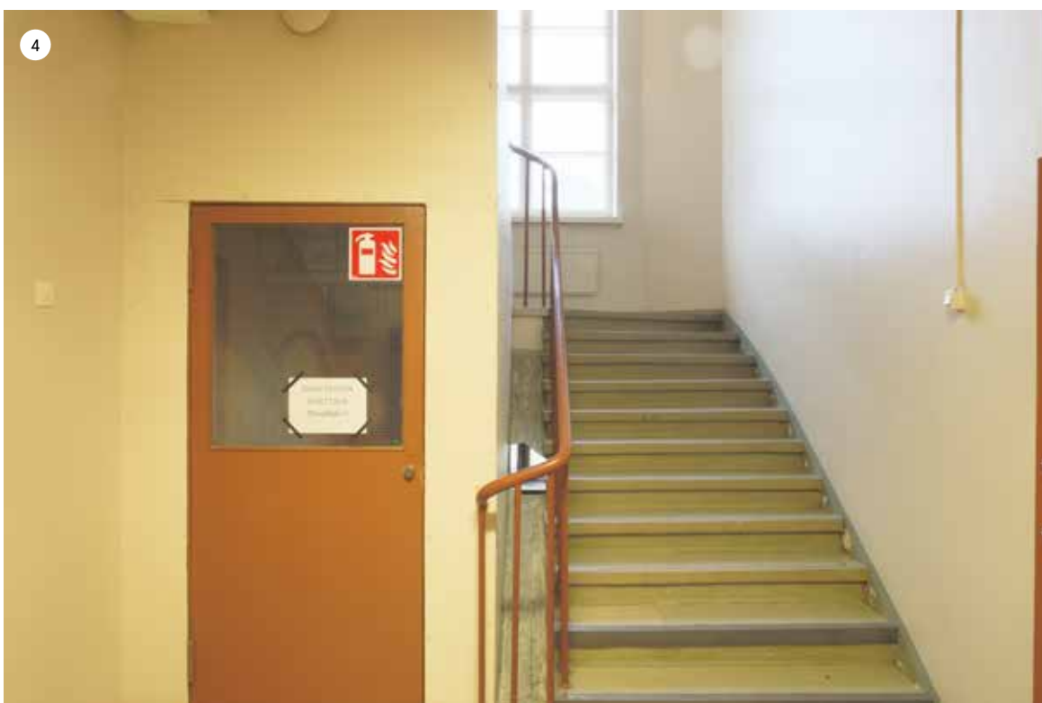
Porras kuvattuna ensimmäisen kerroksen portaan välitilasta. Kellariin johtavan portaatan yläosa on levytetty, ja siihen on lisätty ovi. Portaatan tilahahmo on muuten alkuperäinen.
