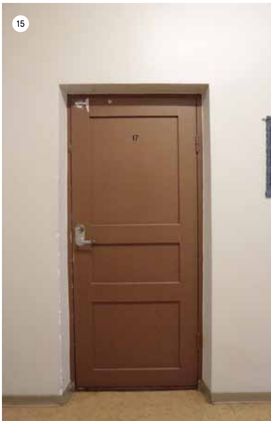
Toisen kerroksen huoneilojen ovet on uusittu 1970-luvulla.
