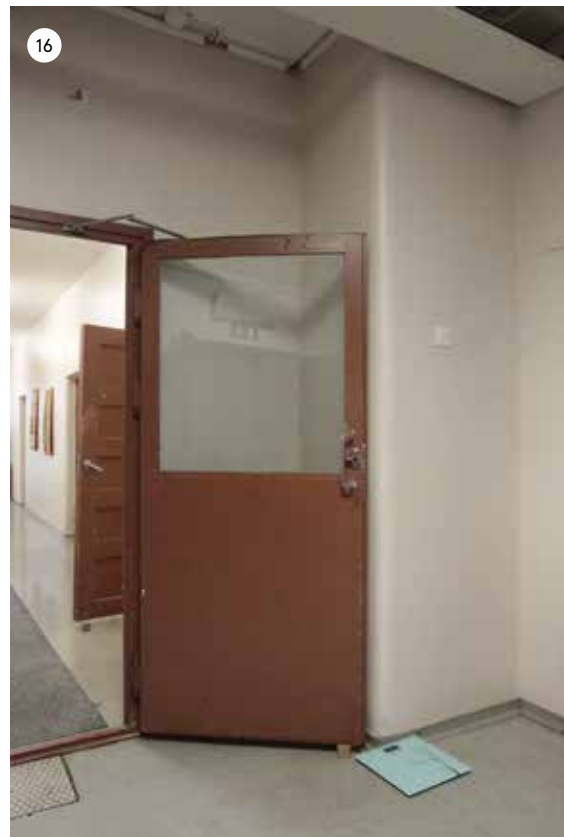
Käytävälle portaan molemmin puolin on lisätty 1970-luvulla osastoivat palo-övet.
