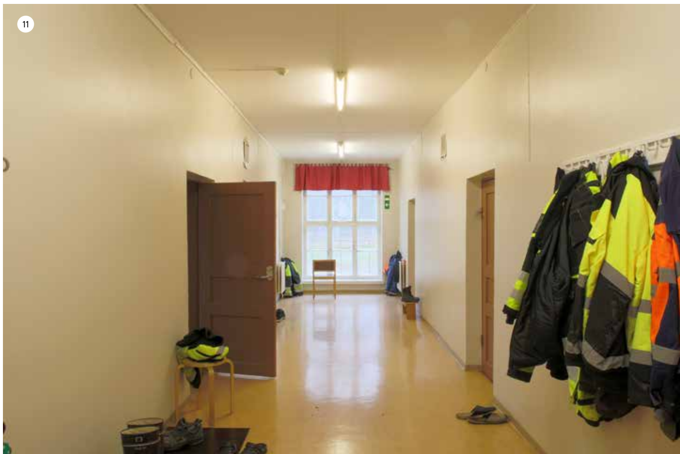
Toisen kerroksen käytävä. Toisessa kerroksessa kaikki ovet on uusittu 1970-luvun korjaustöissä. Lämpöpatterit ovat uusittuja, mutta ikkunat ovat täälläkin alkuperäisiä.
