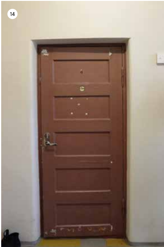
Ovityyppi II A, joita on ensimmäisen kerroksen huoneiloissa. Tarkastusluukku on suljettu umpeen. Painike ja lukko on uusittu, saranat ovat alkuperäisiä. Osa ensimmäisen kerroksen ovista on valmistettu 1970-luvulla muodostettuihin huoneiloihin alkuperäisen mallin mukaan.
