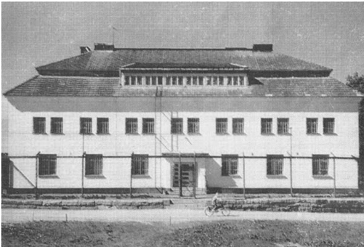
Vankilarakennus etelästä. Vankilarakennusta on ympäröinyt korkea aita ja ikkunoissa on ollut kalterit. Kuva on julkaistu Einar Palmusen kirkassa Ojoisten latokartano ja virkatalo , vuodelta 1968. Valokuvaajana mainitaan Kauko Tenhovuori.
