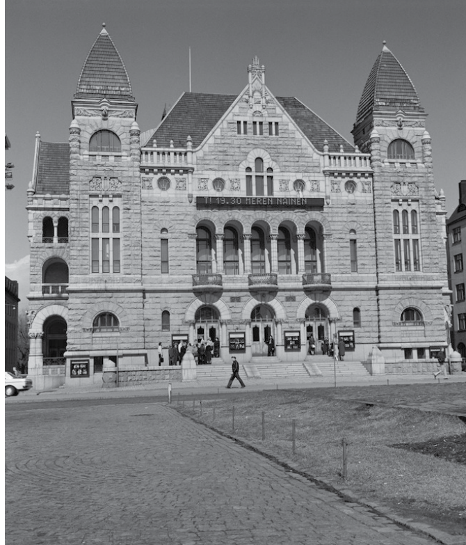
Kansallisteatterin plastiset julkisivut edustavat kansallisromanttista graniittirakentamista. Karkean luonnonkiven käyttö julkisivumateriaalina oli 1890-luvun uutuus ja vuosisadan vaihteen arkkitehtuurin tunnusmerkkejä. Volker von Bonin, 1981. HKM KA.
