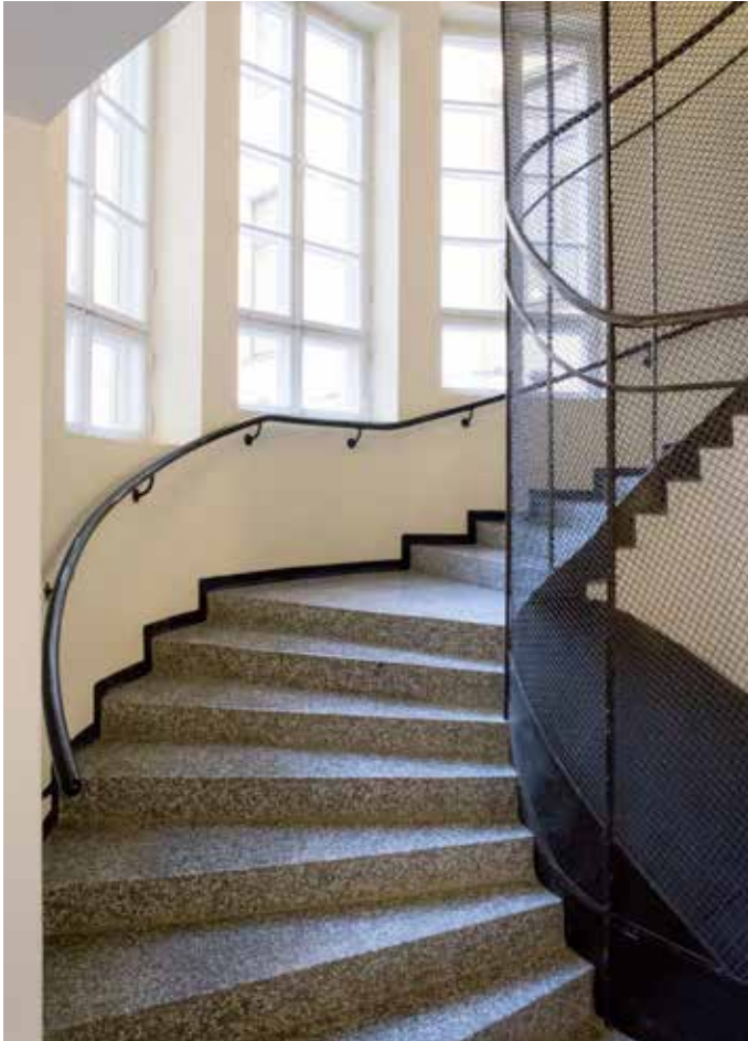
Pääporrashuoneen portaat ovat mosaiikkibetonia ja hissikuilu on erotettu muusta huonetilasta teräsverkolla.
