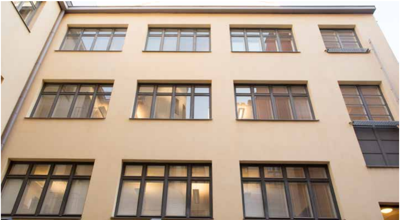
Itäinen pihasiipi korotettiin 1930-luvulla nelikerroksiseksi. Päädyssä sijaitseva porrashuone on katkaistu toisen kerroksen yltä, joten korkea ikkuna on osin peitetty. Porrashuoneen paikalle on ylimmissä kerroksissa sisustettu työhuoneita.
