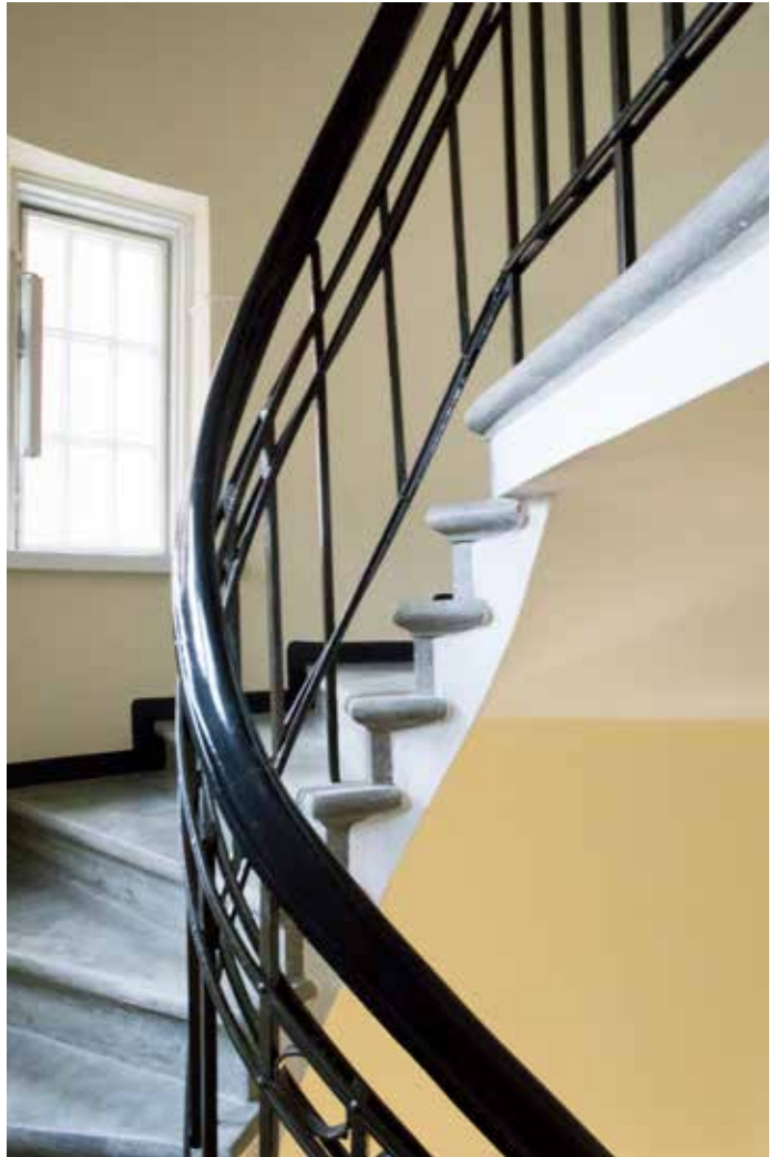
Portaan kaide koostuu siroista pinnoista, jotka on sidottu yhteen lattate-räksin. Puinen käsijohde on puinen ja mustaksi maalattu. Porrashuone on säilynyt alkuperäisenä.
