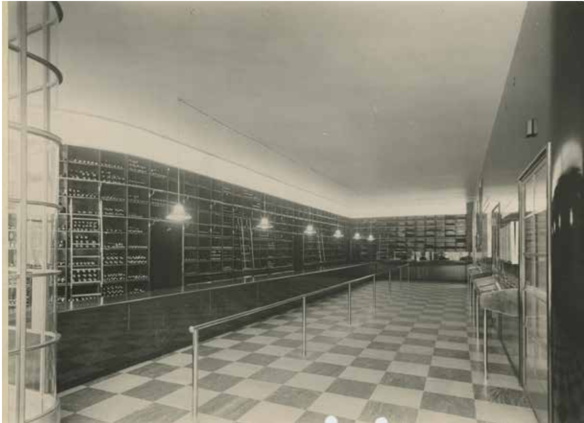
Alkoholiliikkeen tilavaa vähittäismyymälää leimasi lasi, kromiputket, kiiltävät maalipinnat ja koivupintaiset kalusteet. Lattia oli suuriruutuinen. Tila on kuvattu vuonna 1935. H. Iffland, HRM / Alkon kokoelma.
