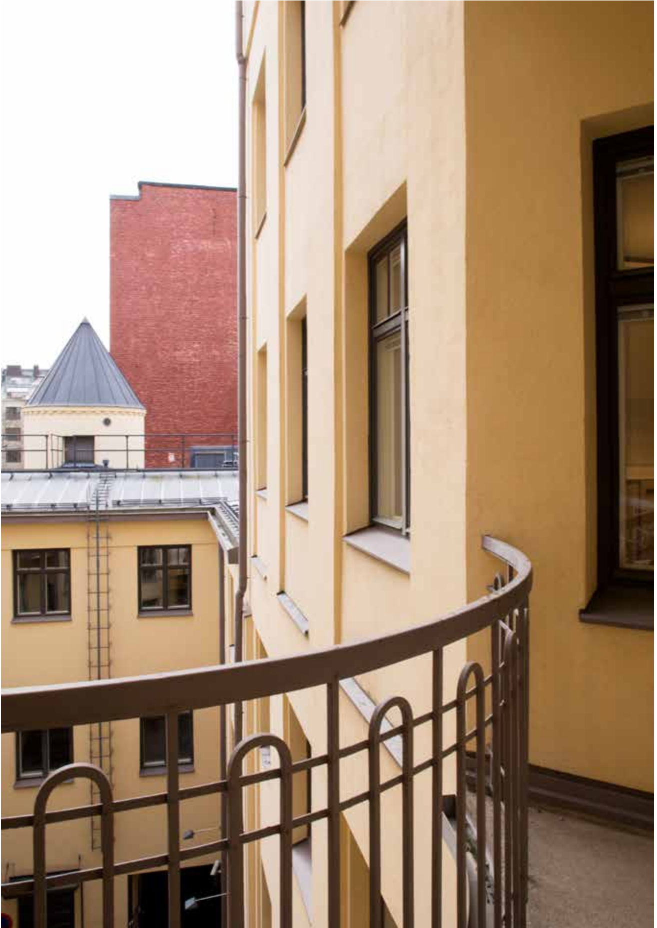
1930-luvulta peräisin olevien parvekkeiden kaiteissa on vanhat, ylösastaan kaartuvat sirot pinnat.
