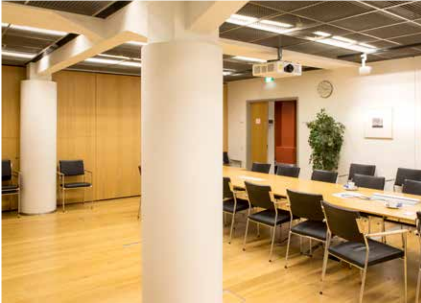
Kellarikerroksen länsiosassa on neuvottelutiloja, joiden keskellä erottuvat alkuperäiset pilarit. Niiden ympärille on tehty valu siten, että pilarien poikkileikkaus on nyt pyöreä. Pilarit kannattelevat konsolipalkkeja. Pilarit ja konsolit ovat paikallavalettuja. Kerroskorkeuden kasvattamiseksi kellarissa on louhittu vuoden 2005 korjaustöiden yhteydessä.
