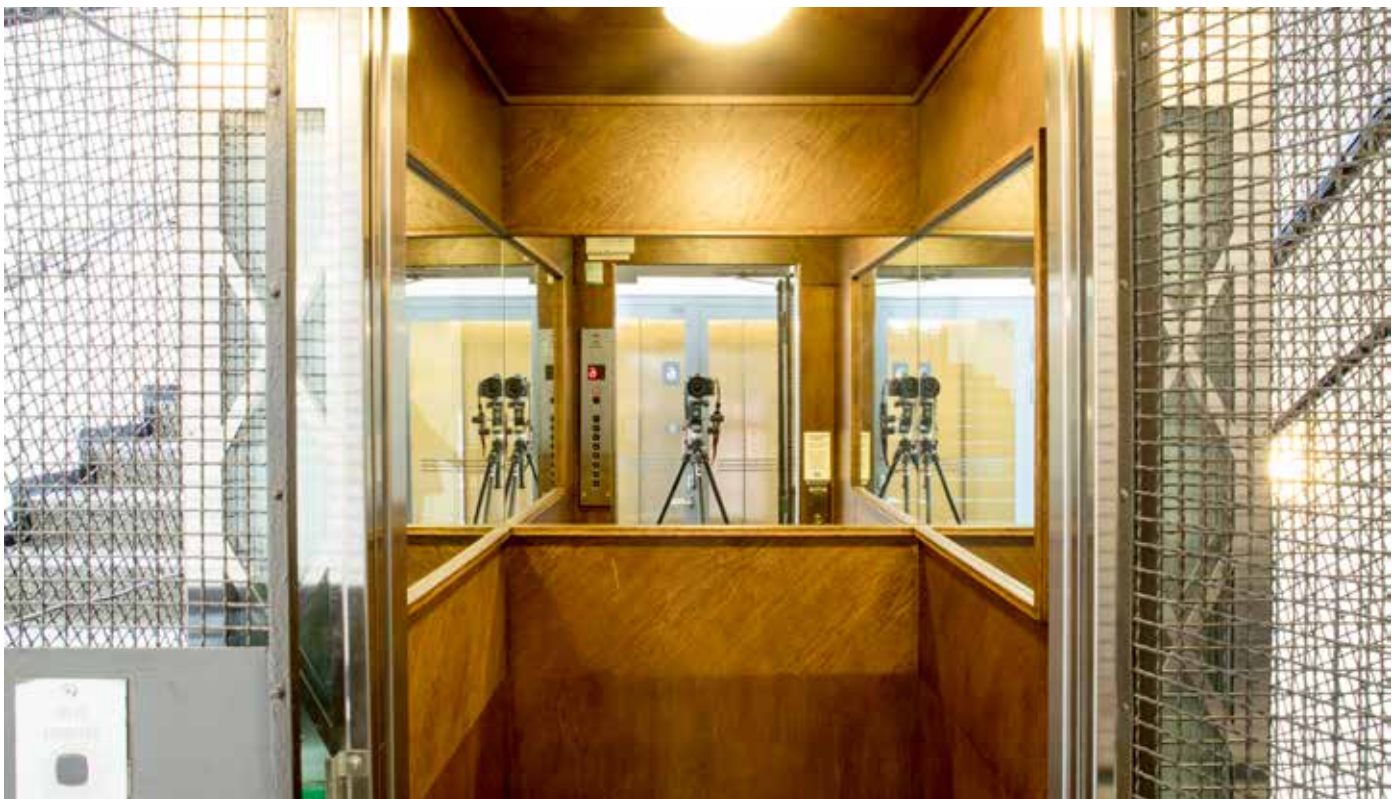
Hissin veräjäovi on uusittu umpinaiseksi liukuoveksi vuonna 2005. Hissin alkuperäiset sisäpinnat ovat viilutettua, tummaksi petsattua puupintaa, joka koostuu kentistä. Osa kenttien puupinnoista on asennettu pystyyn, osa diagonaaliin.
