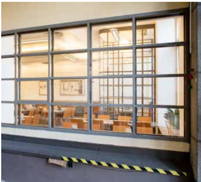
Ruokasalin porttikäytävään avautuva suuri, teräsrakenteinen ikkuna vuodelta 1934 on säilynyt alkuperäisessä asussaan.
