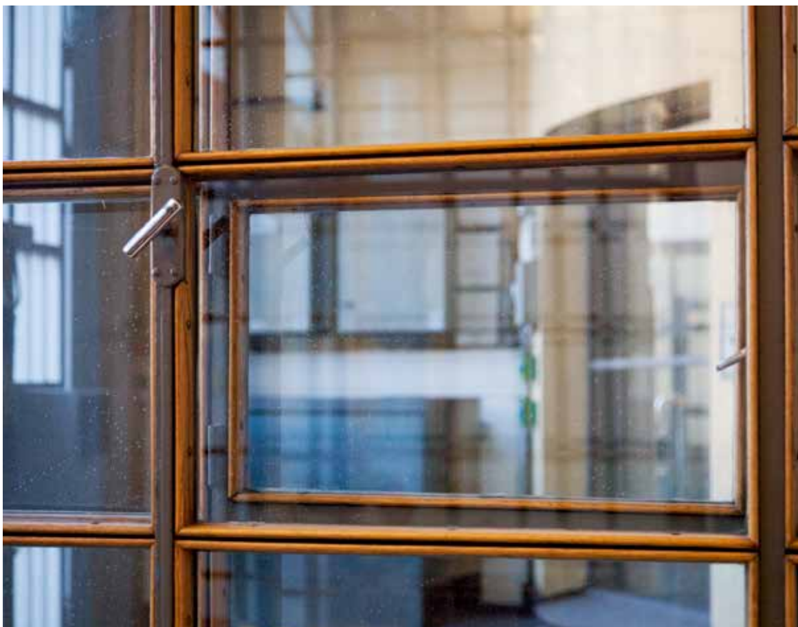
Suuren ikkunan rakenne perustuu tammilistoin päällystetyille hoikille teräsprofileille kuten tuulikaappi. Ikkuna heloineen on säilynyt alkuperäisenä
