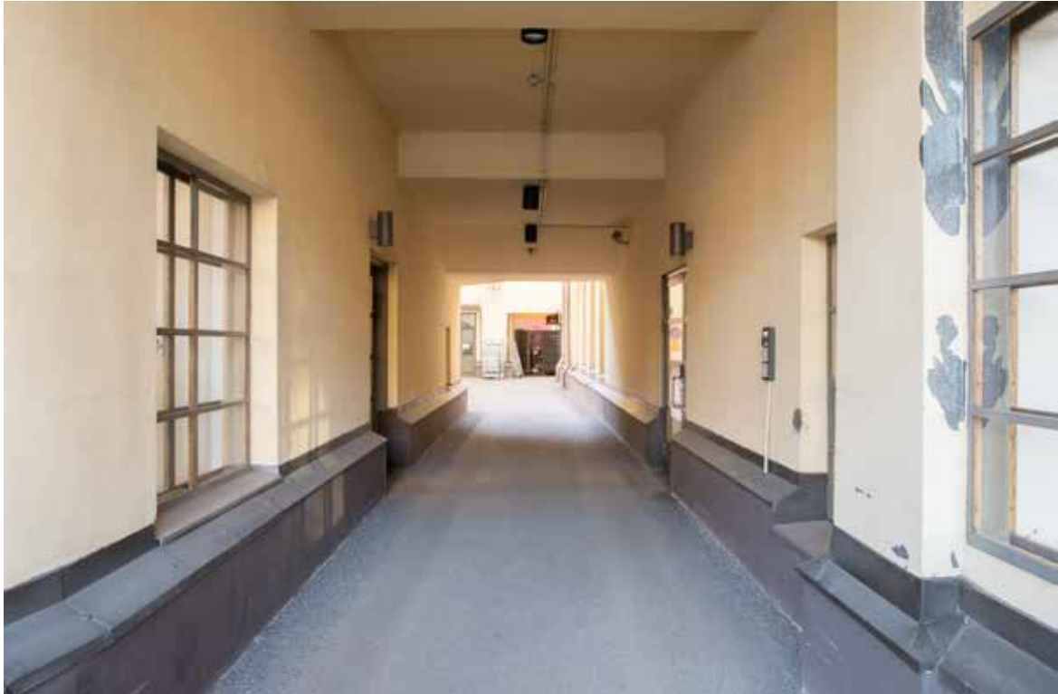
Kulku sisäpihalle tapahtuu porttikäytävän kautta. Käytävälle aukeaa muutama 1930-luvulta peräisin oleva ikkuna aula- ja ruokasalitiloista sekä näitä yhdistävä oviyhteys.
