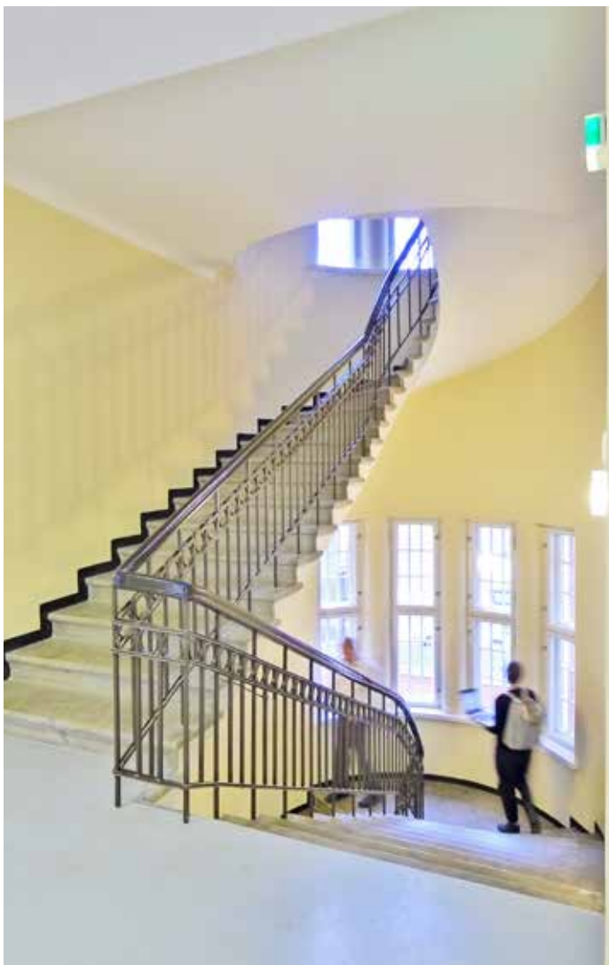
Pihojen poikki kulkevan pihasiiven 1910-luvulta peräisin oleva porrashuone on edustava, joskin pääporrasta pienempi. Aiemmin maalatut porrasspinnat on hiottu alkuperäiselle betonipinnalle.
