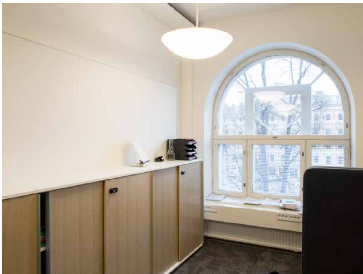
3. kerroksen toimistohuoneiden väliseiniä on purettu suuren avotilan aikaansaamiseksi. Ikkunat on uusittu vanhan mallin mukaan. Ikkunan alle on asennettu IT- ja sähkökouru sekä patteri.
