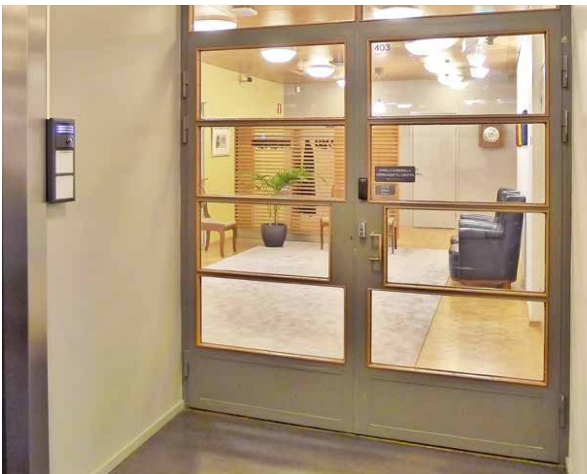
4. kerroksessa hissien välinen tila on erotettu teräs-lasiseinäkein erilliseksi kerrosaulaksi.
