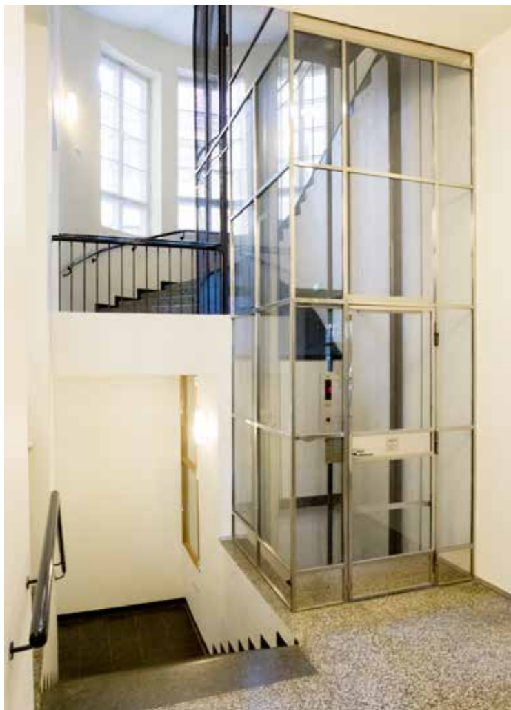
Pääporrashuoneen hissi on peräisin vuodelta 1934. Ensimmäisen kerroksen osalta hissikuilun etuosaa on edustava, teräs-lasiraken-teinen rakenne. Ylemmissä kerroksissa kuilu on kokonaisuudessaan teräsverkkoa.
