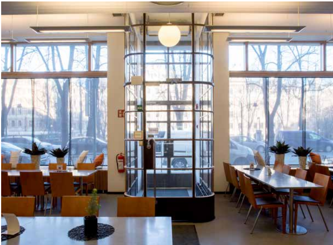
Henkilökuntaravintolaan johtava tuulikaappi on peräisin 1930-luvulta. Vanhan mallin mukaan uusittujen suurten tammipuuteisten ikkunoiden malli on samalta aikakaudelta. Tammiset, hieman särmistään pyöristetyt listat kiertävät tuulikaapin lasiruutuja, jotka lepäävät ohuiden, 25 mm leveiden teräsprofiilien varassa. Sisäovi on alkuperäinen, ulko-ovi on uusittu vanhan mallin mukaan.
