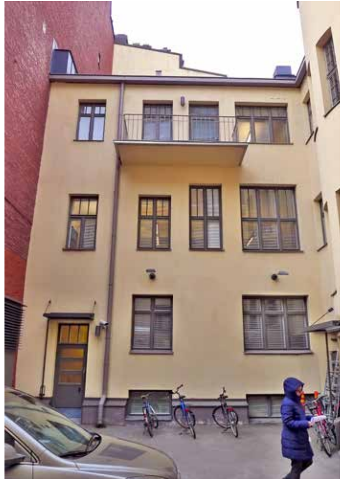
Taaemman sisäpihan läntinen pihasiipi oli jo alun perin kolmikerroksinen ja jakaa seinän viereisen tontin rakennuksen kanssa. Siiven päässä on porrashuone.
