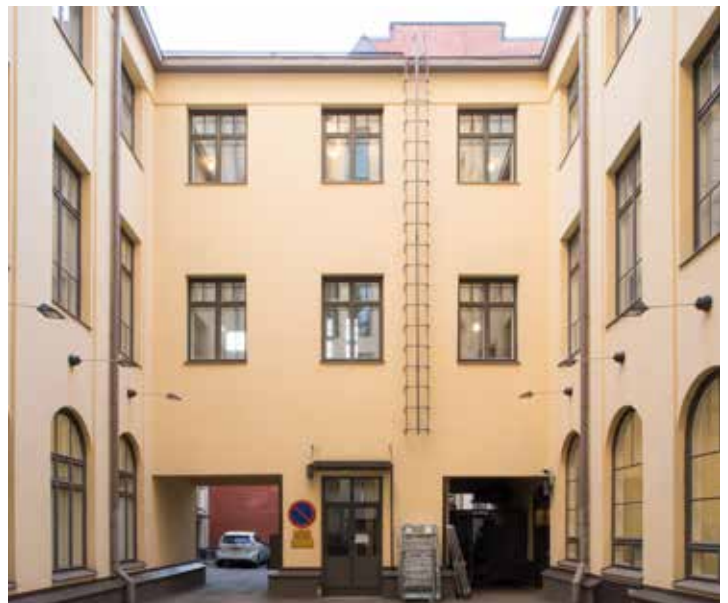
Ensimmäinen sisäpiha, jolta on kulku taaemmalle sisäpihalle vasemmalla näkyvän käytävän välityksellä. Oikealla näkyvä käytävä on muutettu jäteka- tokseksi.
