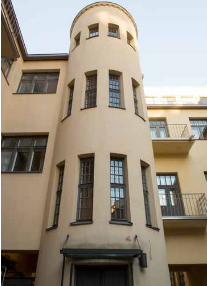
Sisäpihojen poikki kulkevan pihasiiven porrashuone vuodelta 1910 erottuu omana, sylinterinmallisena rakennusmassana. Porrashuoneessa on kapeat, pieniruutuiset alkuperäiset ikkunat.
