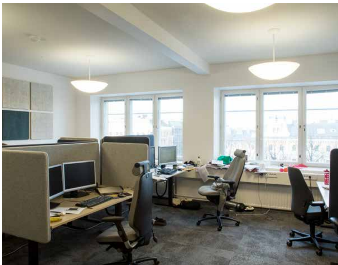
6. kerroksen työtiloissa on purettu toimistohuoneiden väliseiniä ja luotu avointa toimistotilaa. Ikkunat on uusittu vanhan mallin mukaan.
