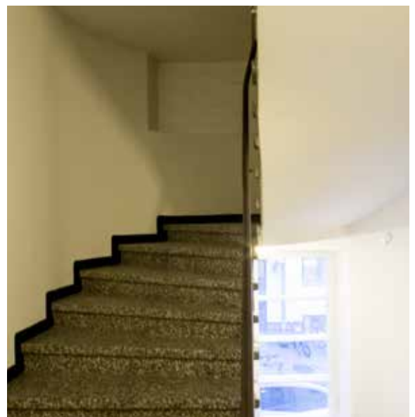
Itäisen pihasiiven päässä sijaitseva, 1930-luvulta peräisin oleva porrashuone on myöhemmin katkaistu siten, että kaksi ylintä kerrosta on muutettu työhuoneiksi. Muutos näkyy myös julkisivussa, sillä porrashuoneen korkea ikkuna on muutoksen johdosta puoliksi muurattu umpeen.
