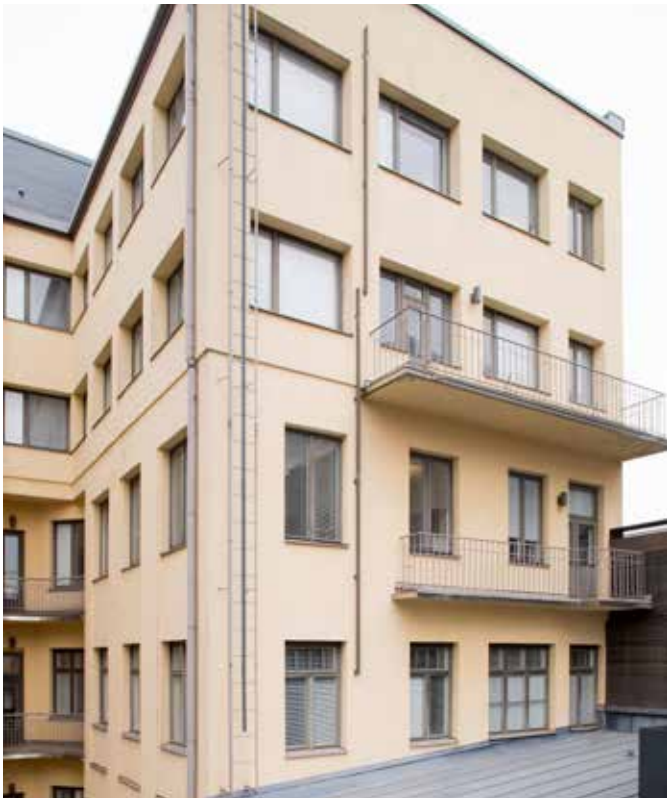
Eri rakennusvaiheiden ikkunatyypit erottuvat pihajulkisivussa.
