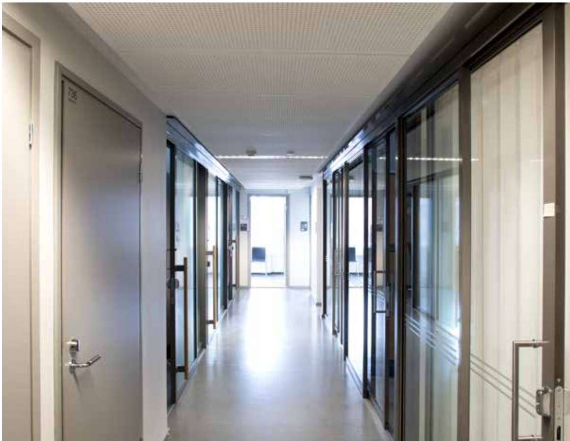
7. kerroksen toimistokäytävät ovat muihin kerroksiin verrattuna matalia. Käytävän katto on alaslaskettu
