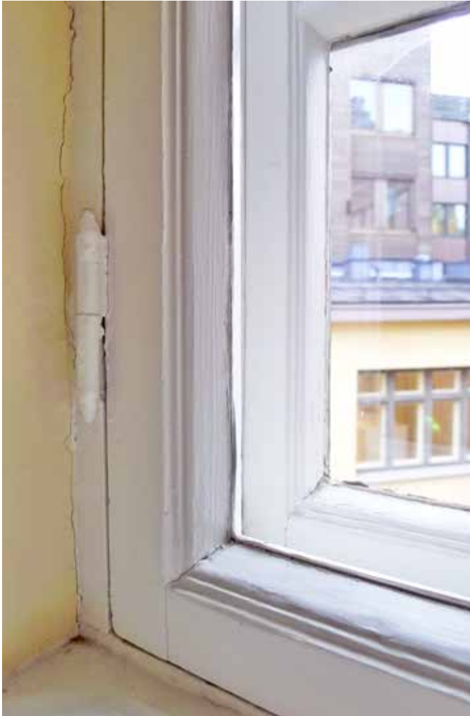
Porrashuoneen ikkunoissa on säilynyt alkuperäiset heloitukset.
