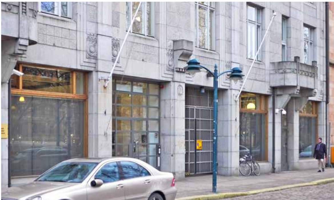
Katutason ikkunat ovat säilyneet pääosin Alkoholiliikkeen aikaisessa asussa, joskin ikkunoita on myöhemmin uusittu vanhan mallin mukaan.
