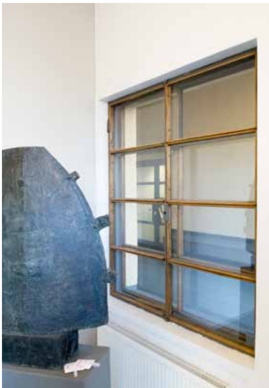
Sisäntuloaulasta aukeaa ikkuna porttikäytävään. Sen puu- listoilla reunustettu metallirakenne on samanlainen kuin ruokasalin tuulikaapissa.
