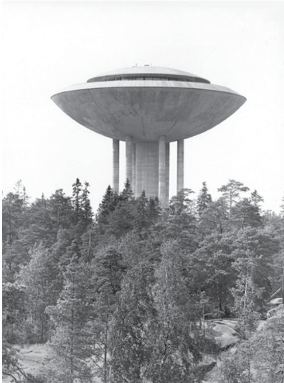
Espoon Haukilahden vesitorni on valmistunut vuonna 1968. MFA.
