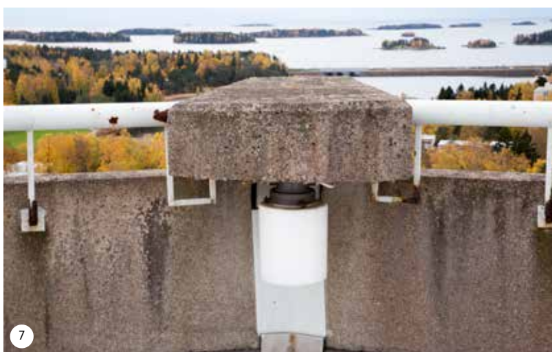
Otaniemen vesitor- ni, kattotasanteen kaiteeseen upotettu valaisin. Arkkitehtitoi- misto Alvar Aalto. 1969. AAS.
