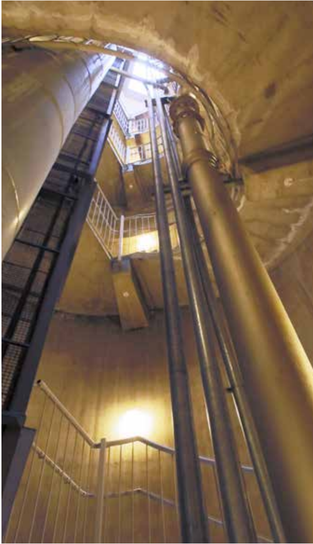
Putkiasennukset on sijoitettu porraskuilun keskiosaan. Vasemmalla vesisäiliön putkistot ja oikealla saniteettitilojen kapeammat putket.
