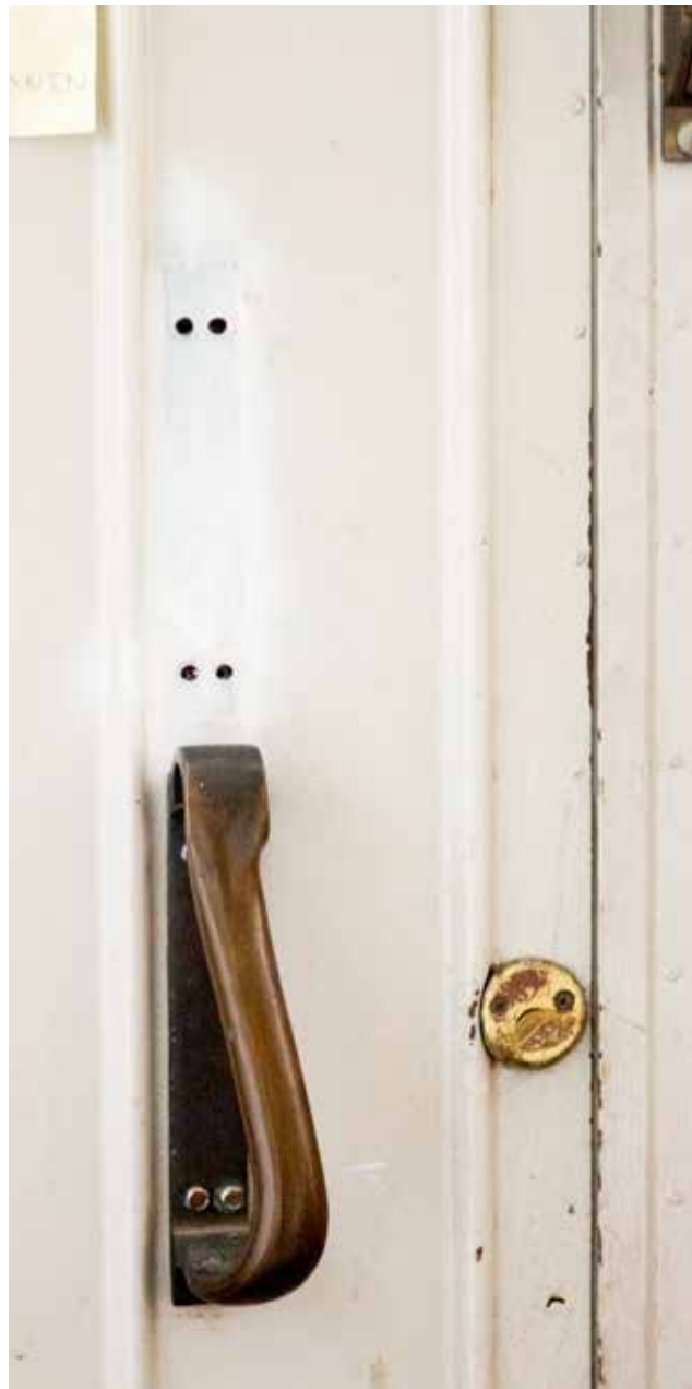
Pääoven pronssivedin. Ylempi vedin on poistettu.
