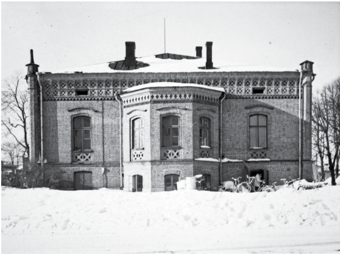
Kuva rakennuksen kaakkaisjulkisivusta vuodelta 1959. Kuvassa esiintyvät ikkunat ja ovet ovat ilmeisesti alkuperäiset, ikkunat uusittiin vuosien 1959–1960 korjaustöissä. Mikko Karjanoja, Museovirasto.
