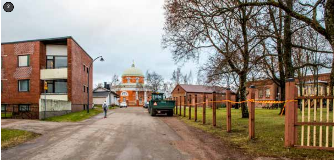
Tonttia rajaavan lauta-aidan maalipinta on rapistunut ja tontin lounaisreunan aita on pääosin purettu, vain runkona toimivat pylväät ovat jäljellä.
