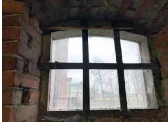
Vaunuvaraston ikkunan edessä huoneen puolella on metallinen ristikko ja yläpuitteessa nimikirjaimet. HY.
