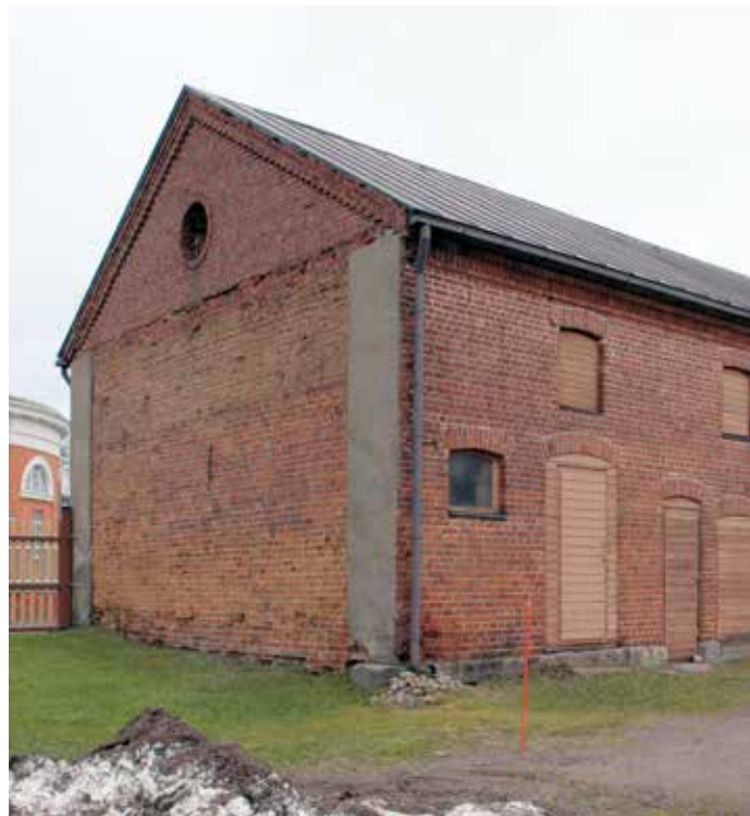
Rakennuksen lounaisjulkisivusta on purettu sinne rakennettu talvipuutarha. Purkuajankohdasta ei ole tietoa. Talvipuutarharakenne ulottui betonivahvisteisten nurkkien korkeudelle. Kaakkoisjulkisivussa olevat ovet, ikkunat ja luukut ovat alkuperäisillä paikoillaan, ovilehdet ja luukut on uusittu.
