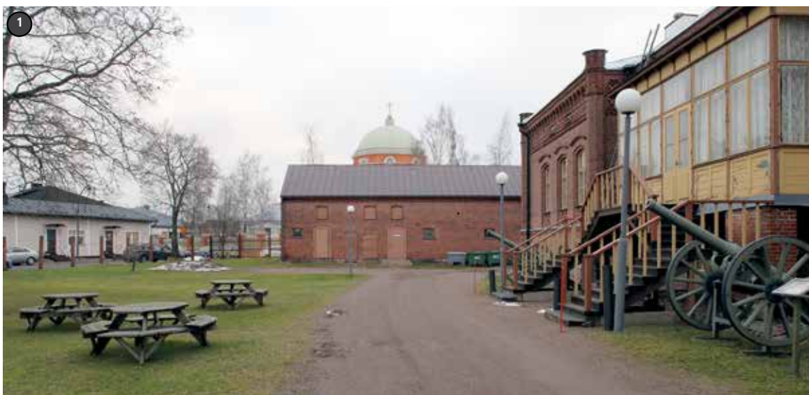
Varuskuntakerhon tontin takaosa on puistomaista. Piharakennuksen takaa pilkistää viereisen kirkon kupoli ja vasemmassa laidassa länsipuolen korttelin matala puurakennus, joita on useita samantyyppisiä Hämeen keskusta-alueella.
