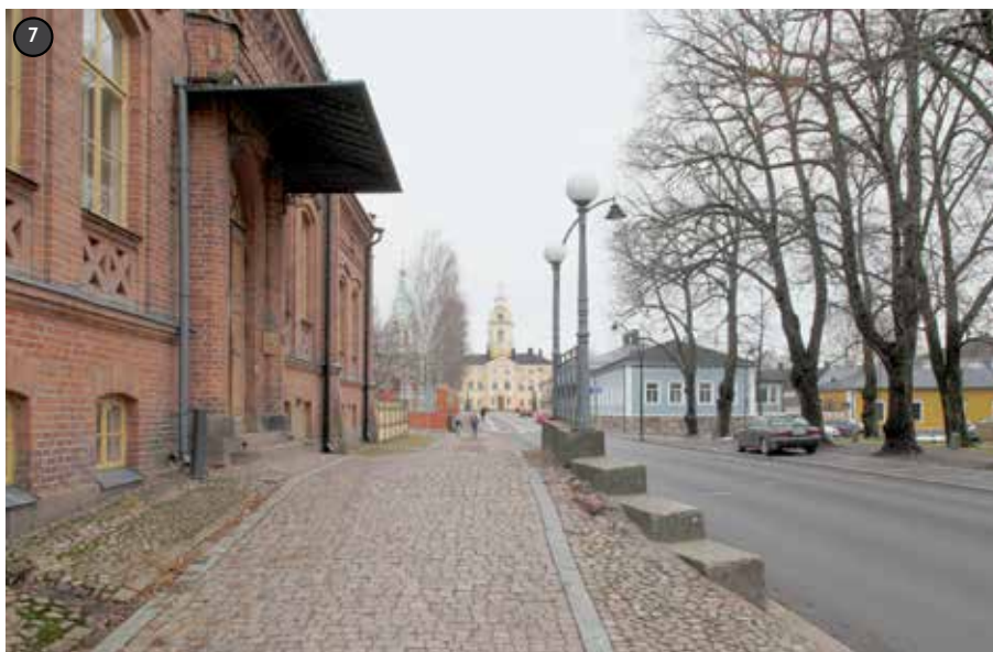
Rakennuksen pääsisäänkäynnin edustalla oleva ajoliuska on kivetty, kun muu jalkakäytävä on laatoitettu.
