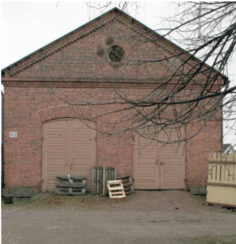
Piharakennuksen koillisjulkisivussa on kaksi kaksilehtistä ovea entiseen vaunuvarastoon ja niiden yllä pyöreä ikkuna rakennuksen ylisille.
