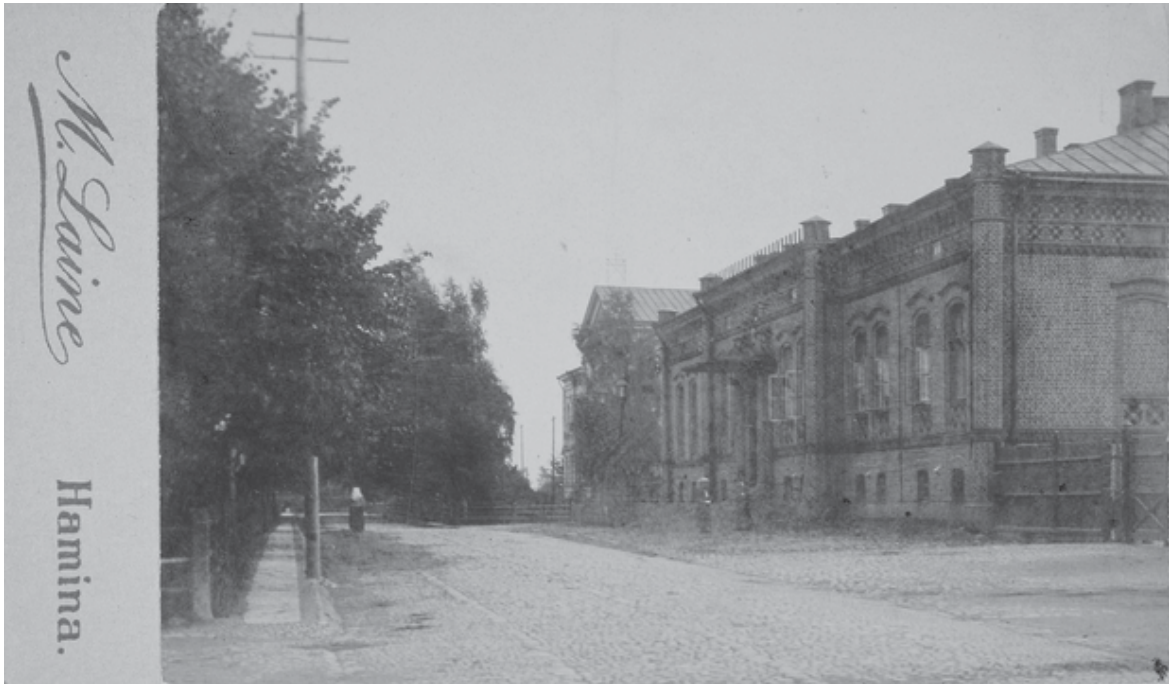
Kesäinen kuva Kadettikoulunkadusta ja kadettikoulun johtajan asuinrakennuksesta kuvattuna pohjoisesta vuosien 1890–1899 välillä. Pääkerroksen ikkunat ovat auki tuuletusta varten, luoteisjulkisivun ikkuna on muurattu umpeen. Rakennuksen edustalla ja ajorampissa on mukulakiveys kuten Kadettikoulunkadullakin, joka tunnettiin Nikolainkatuna. Tonttia kiertää puusäleitä, jossa on samaa ristikkokuviointia kuin asuinrakennuksessa. Ympäristö on puistomainen. M. Laine, Museovirasto.
