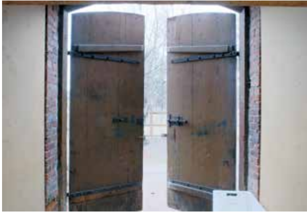
Vaunuvaraston kaksilehtisissä, korkeissa ovissa on taotut saranalehdet.
