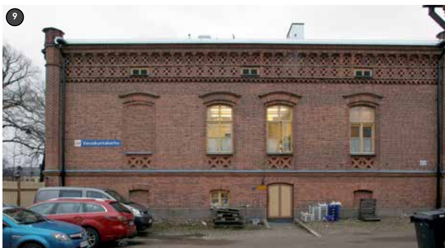
Rakennuksen koillisjulkisivusta on ummistettu yksi ikkuna pääkerroksen tasalta ja kaksi ikkunaa pohjakerroksesta.
