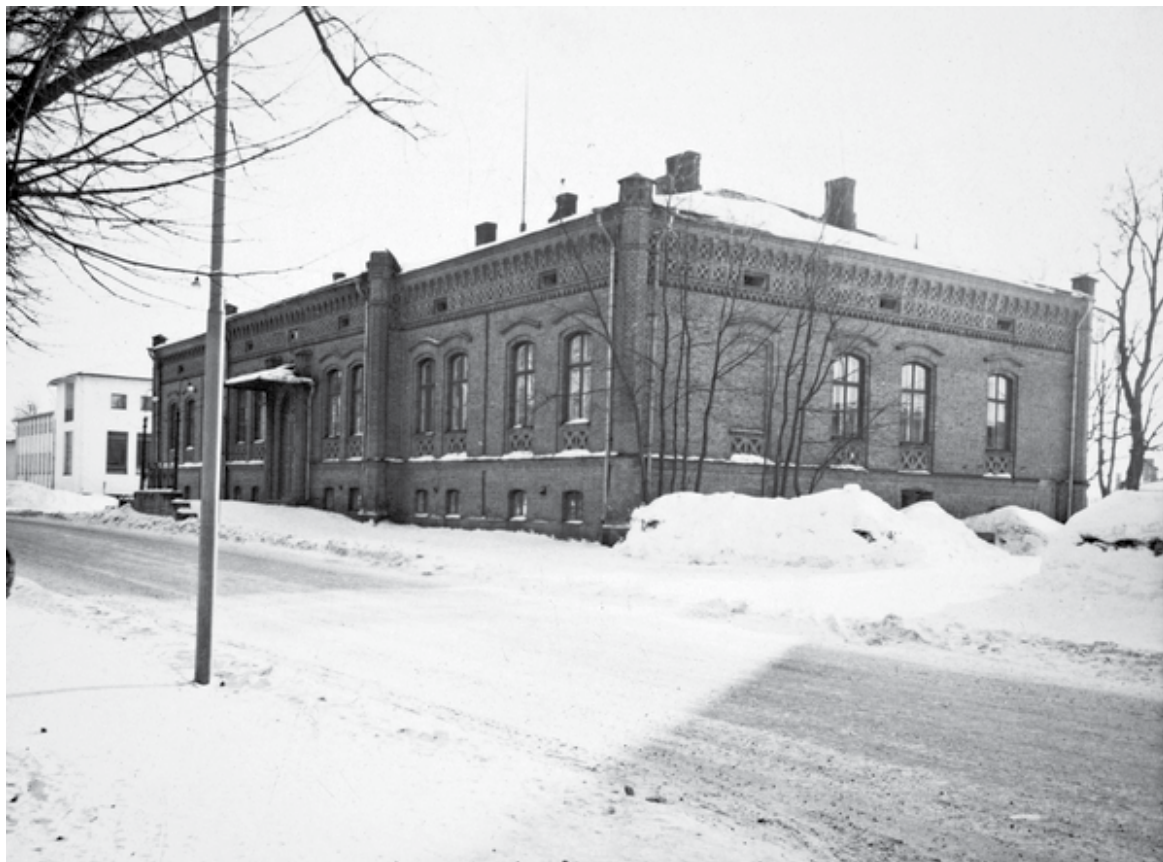
Kuva upseerikerhona toimineen rakennuksen koillis- ja luoteisjulkisivuista vuodelta 1959, jolloin siellä suoritettiin ensimmäinen peruskorjaus. Takana kadettikoulun hallintorakennuksen korvannut, vuonna 1955 valmistunut rapattu sotilaskotirakennus. Tässä vaiheessa ei pääjulkisivun keskirisaliitin ylle noussutta sahalaitakuviota enää ollut. Mikko Karjanoja, Museovirasto.
