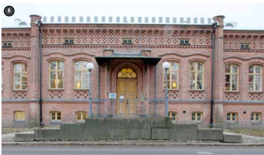
Rakennuksen pääjulkisivu on koillisjulkisivu. Keskirisaliitin ylle nousevat levyt ovat vesikaton uusimisen yhteydessä tehty rekonstruktio. Vastaavanlainen sahalaitakuvio oli rakennuksessa sen valmistuessa, mutta se poistettiin ilmeisesti 1900-luvun alussa.
