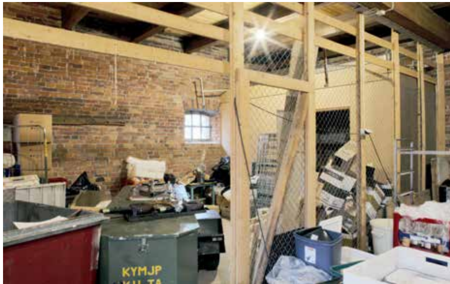
Rakennuksen koillispuolella oleva, vaunuvarastona palvellut tila on nyt jaettu kevyin väliseinän ja se toimii ravintolan varastohuoneena.
