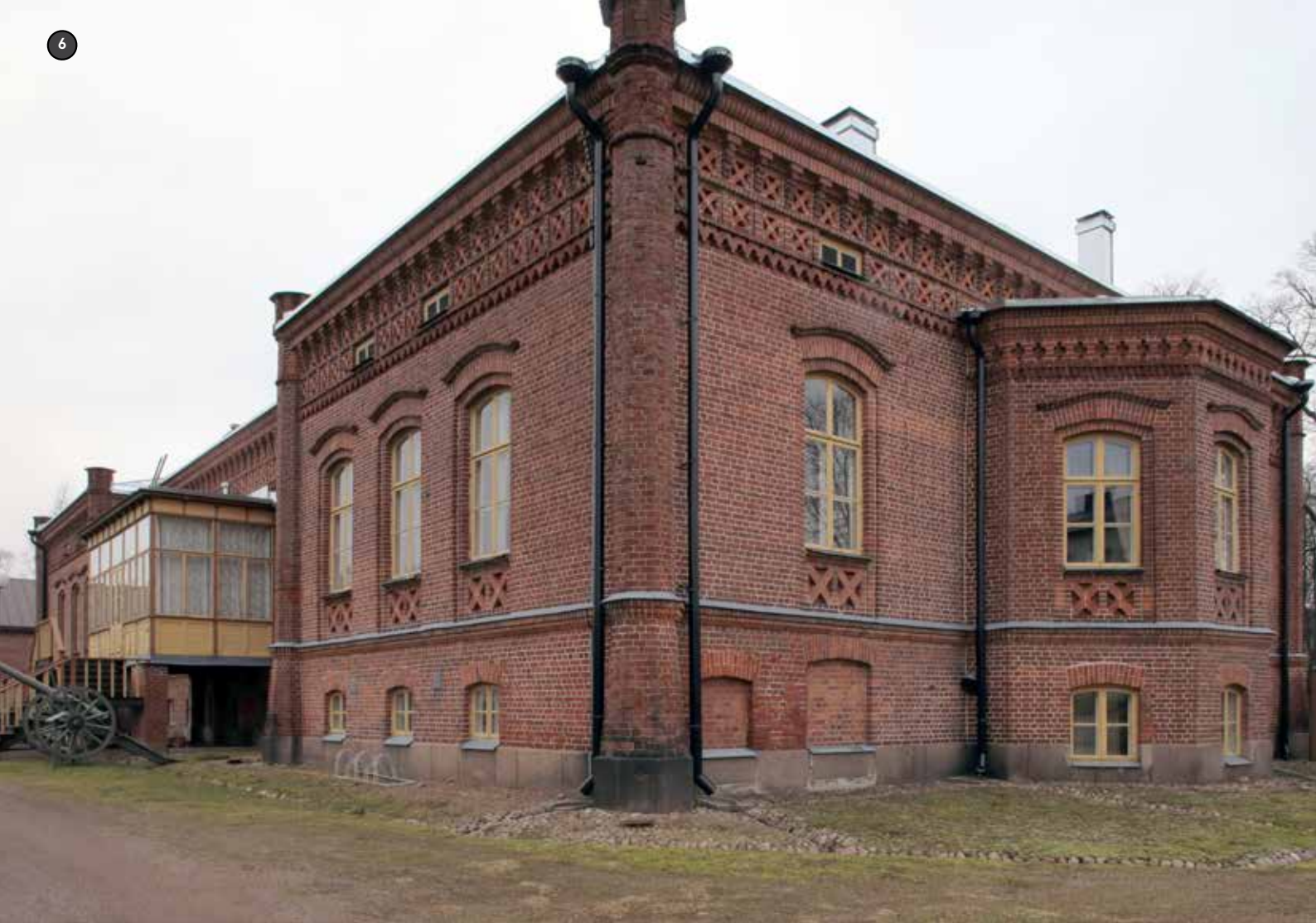
Rakennuksen eteläkulma. Kaakkoisjulkisivusta on suljettu kaksi pohjakerrokseen johtanutta ovea.
