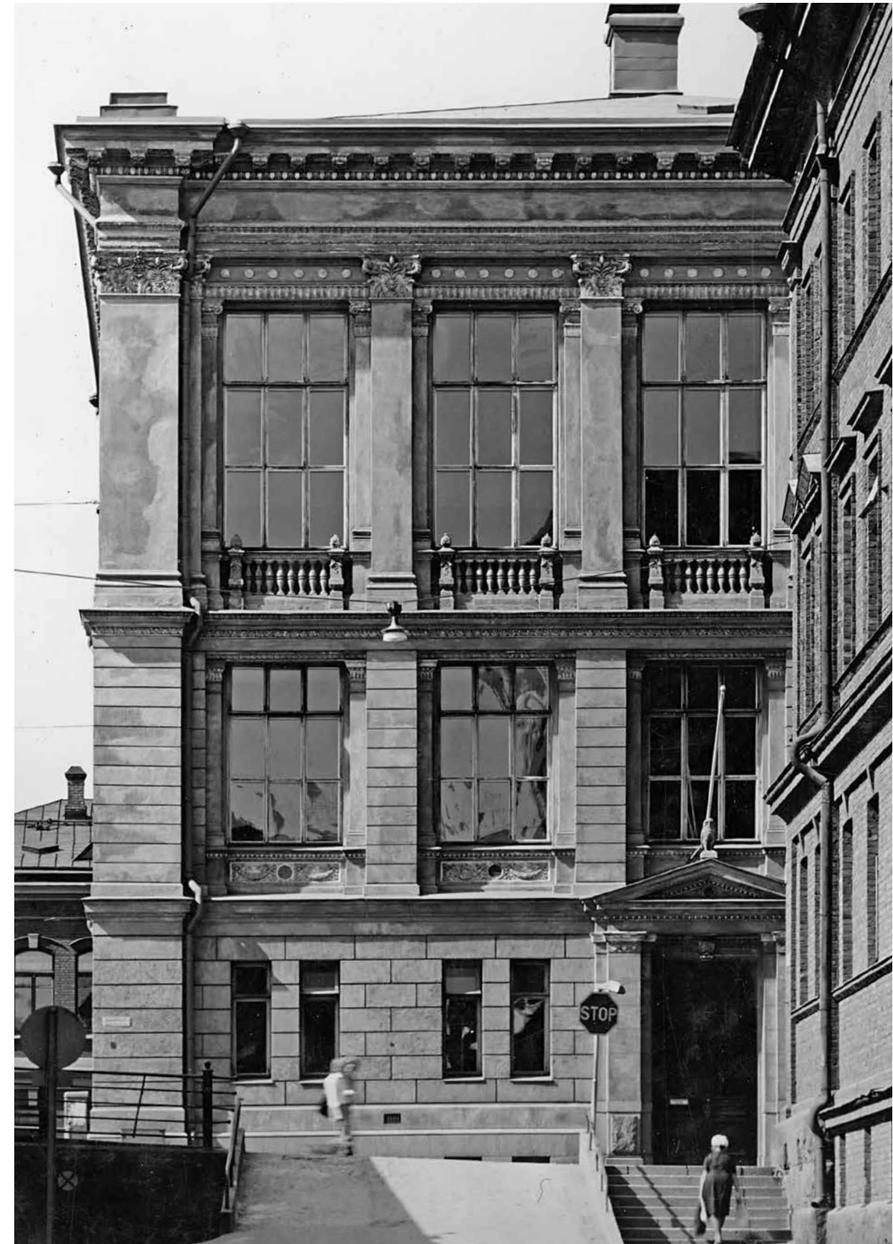
↑ Tieteellisten seurain talon julkisivu ennen muutosta rakennustaitteen museoksi vuonna 1975. Julkisivujen heikko kunto välittyi mustavalkovalokuvastakin. AMA
