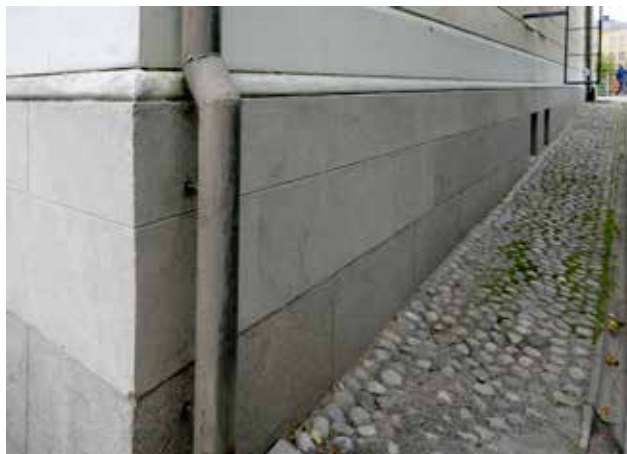
↑ Eteläjulkisivulla aidot graniittikivet ja granitoitu kvaaderointi porrastuvat. Granitoitu laastikvaaderointi erottuu tässä pilvisellä säällä otetussa kuvassa vaaleampana. amoy 2017
