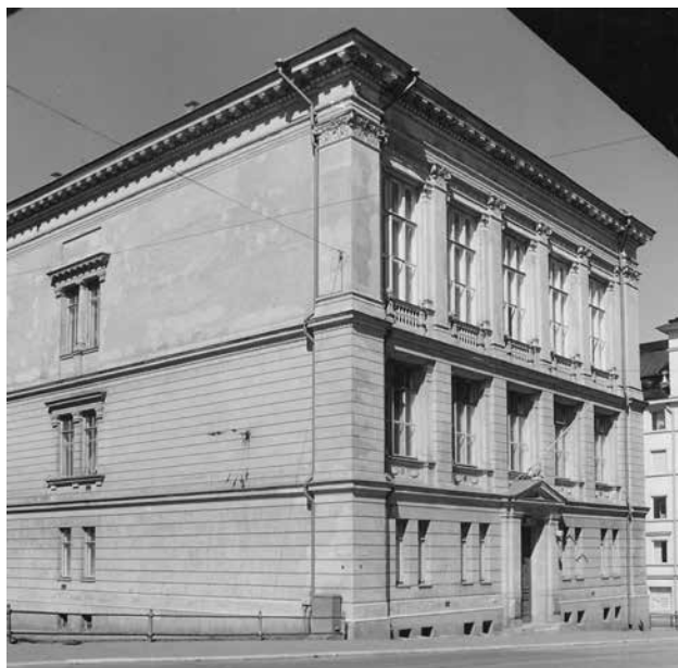
↓ Rakennus ennen korjausta 1970- ja 1980-lukujen taitteessa. AMA
