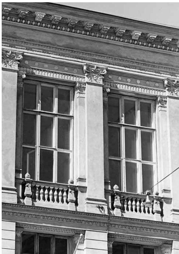
↑ Kasarmikadun puolella kolmannen kerroksen ikkunoiden edessä on balustradit ja ikkunoiden välissä kaksinkertainen pilasteriaihe. AMA
