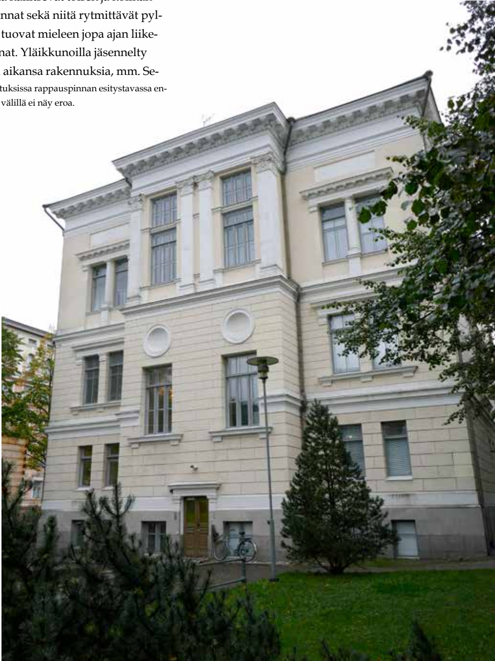
→ Pihajulkisivu kuvattuna loka-kuussa 2017. Porrashuoneen muodostaman keskirisaliitin julkisivun käsittelyssä korostuu kahden alimman kerroksen asema ylimmän kerroksen jalustana. Päätyjulkisivuissa ensimmäisen ja toisen kerroksen välillä selkeästi erilaiset laastiharkoitukset (kvaaderointi) on sovitettu yhtenäisessä seinäpinnassa liittymään toisiinsa saumattomasti. amoy 2017
